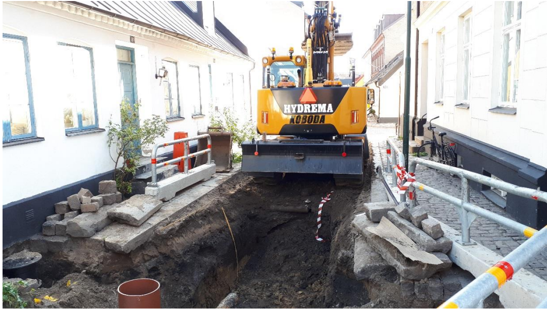
Figur 2. Arbetet var bitvis komplicerat, även logistiskt och utrymmesmässigt, på den relativt smala gatan som också är en återvändsgränd. Fotografi taget från väster.
