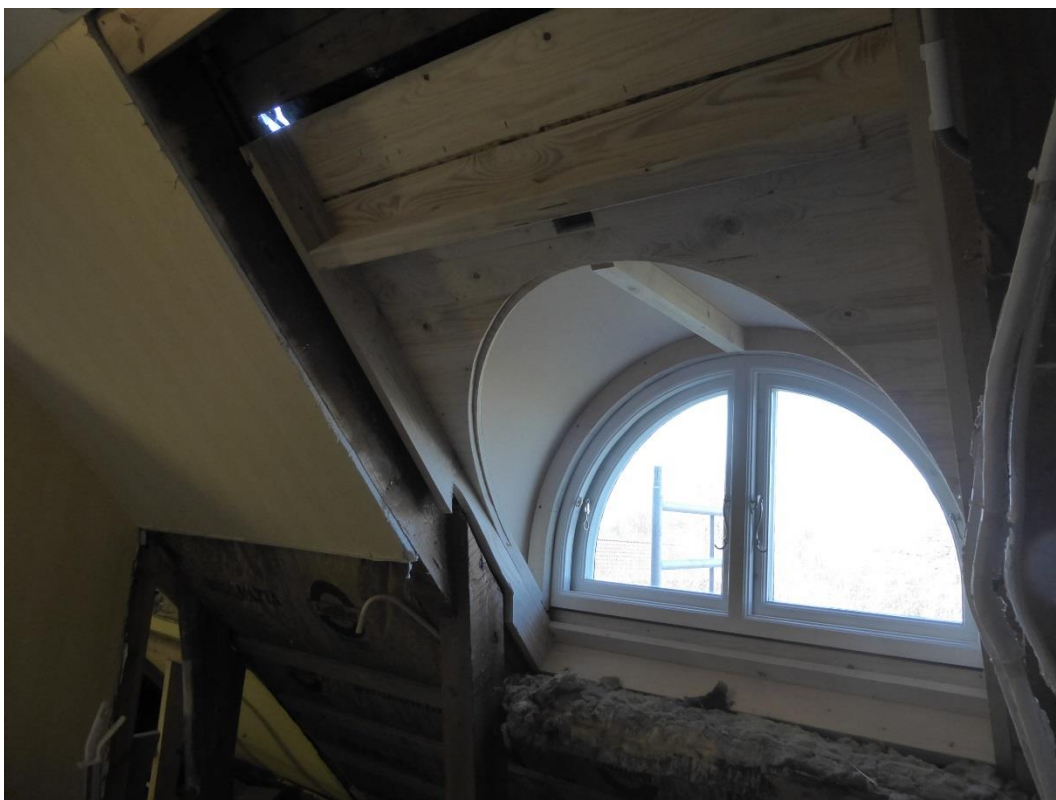
Under arbetets gång.
