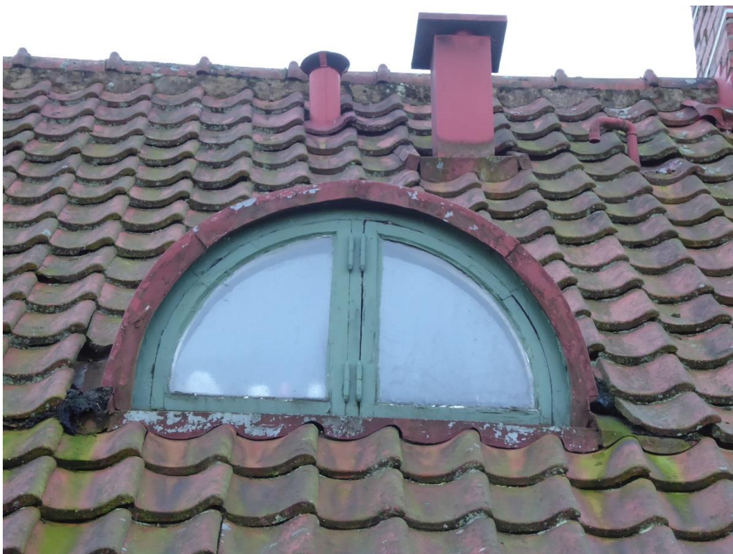
Före åtgärder befintlig takkupa.
