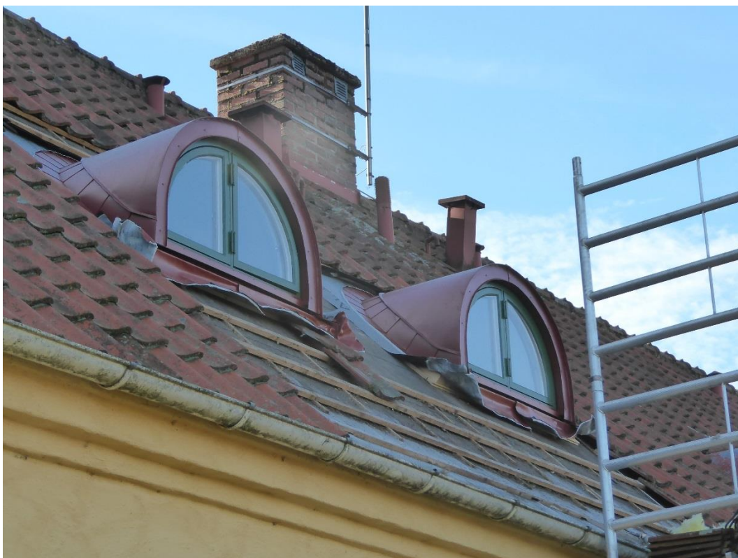
Under arbetets gång.
