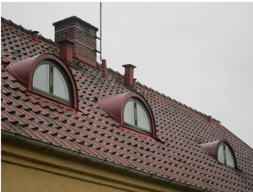
Efter åtgärder. De två nya takkuporna till vänster i bild. Till höger grannlägenhetens äldre takkupa.
