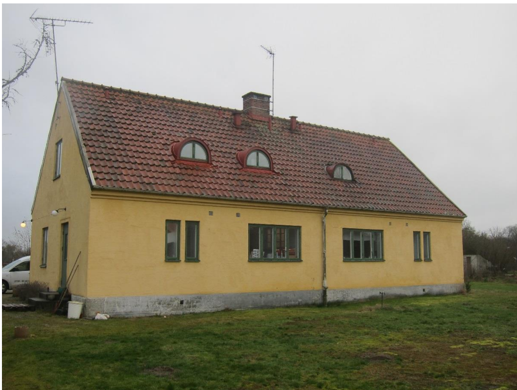
Efter åtgärder. De två nya takkuporna till vänster i bild.
