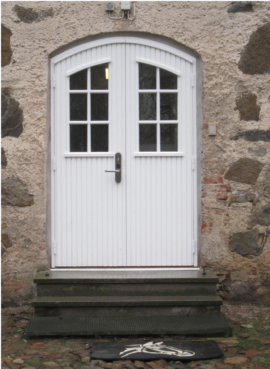
Efter åtgärder, norra dörren.
