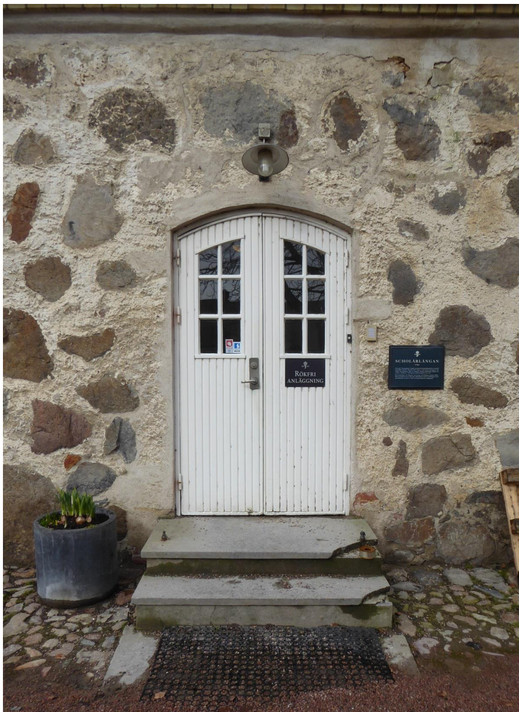
Före åtgärder. Östra entrén.
