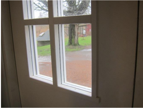
Efter åtgärder. Glas och spröjs sett från insidan respektive utsidan.
