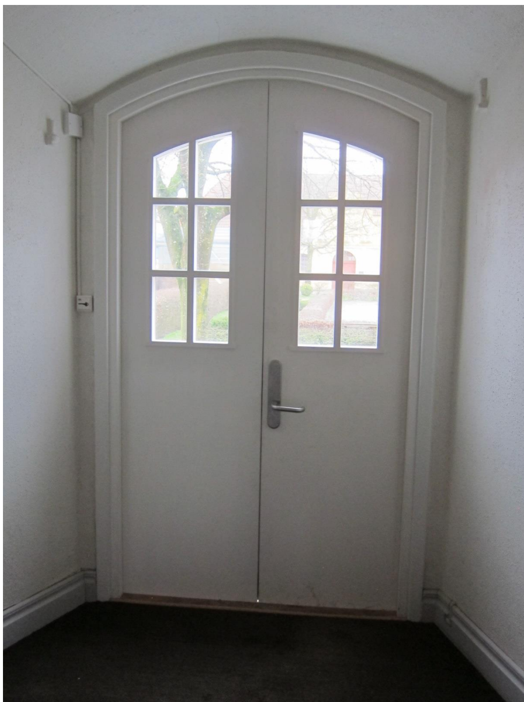
Efter åtgärder, östra dörren.
