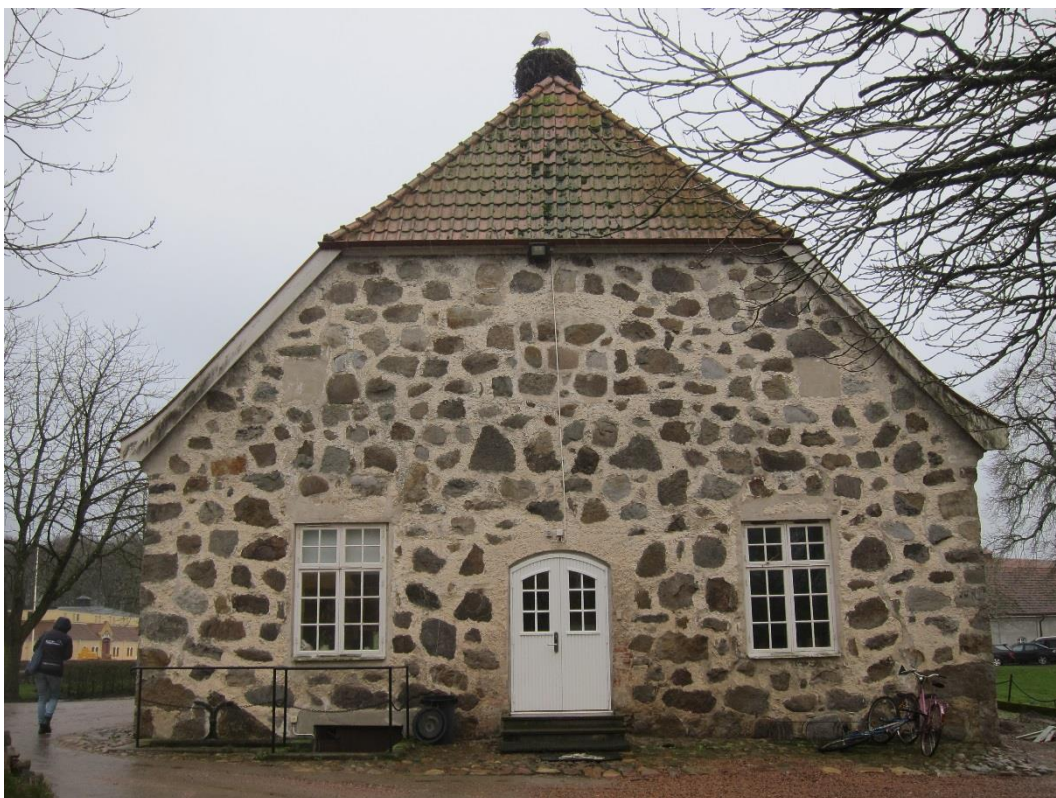
Scholärlängan, östra fasaden och norra gavelfasaden efter åtgärderna.
