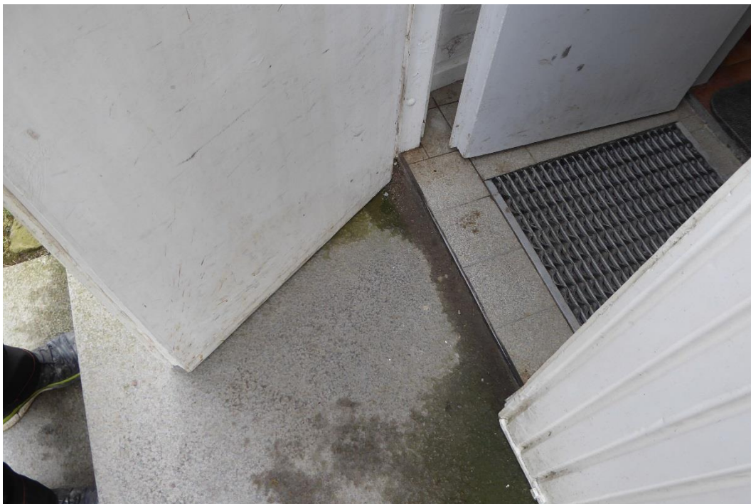
Före åtgärder. Östra entrén.
