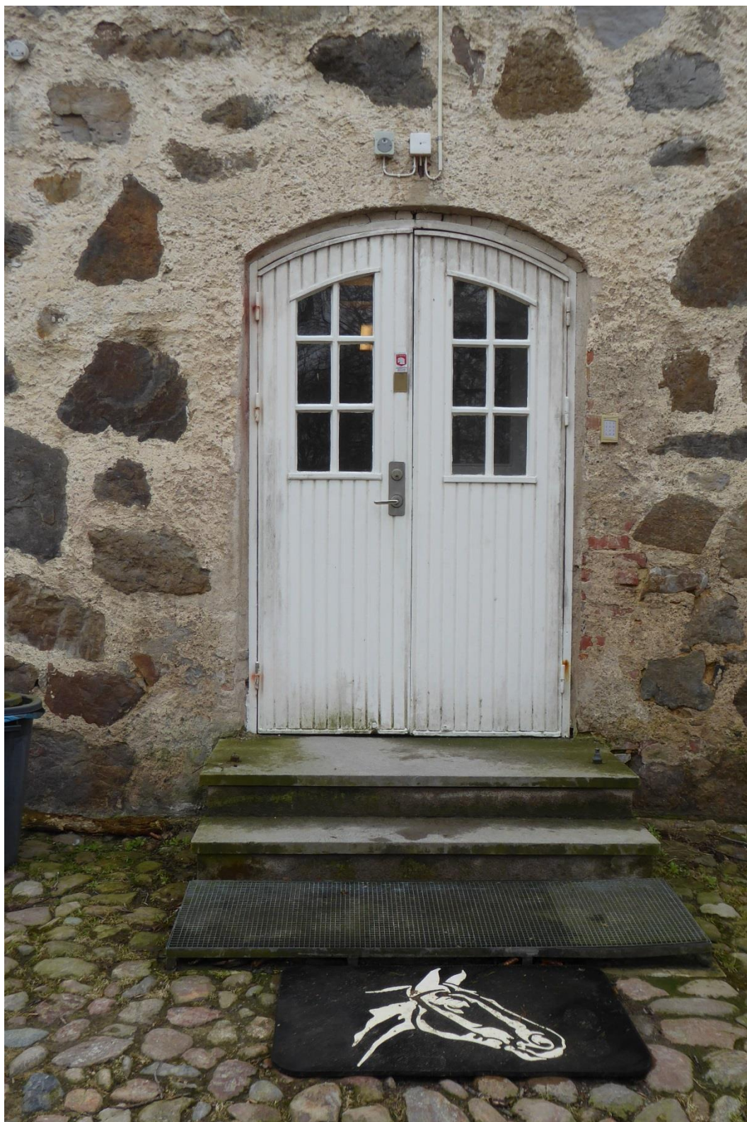
Före åtgärder. Norra entrén.
