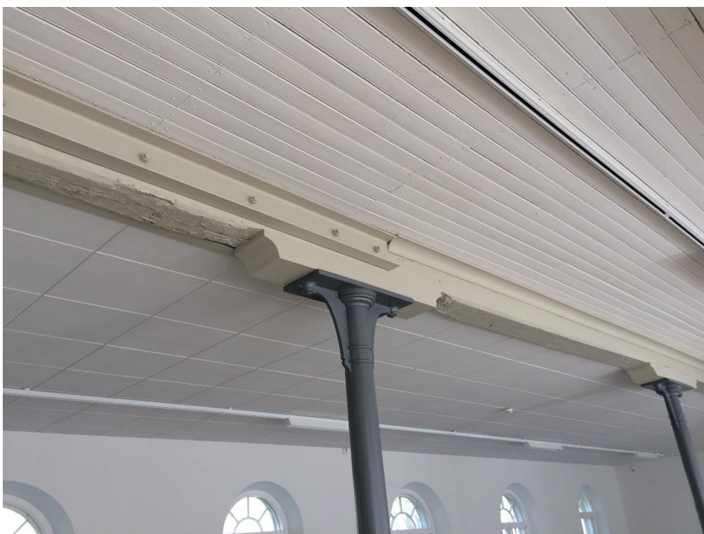
Nyttillverkad pelare t v, nyttillverkad trä mellanlägg samt bärlina förstärkt med U-balk, ny hålkälslist i trä. Äldre pärlspontpanel målad
