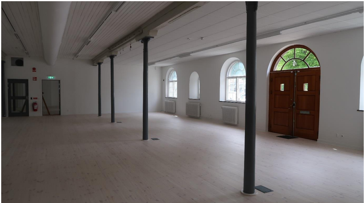
Bottenvåning Tyghuset efter åtgärd med kompletterade pelare, delvis frilagt innertak och nytt brädgolv.
