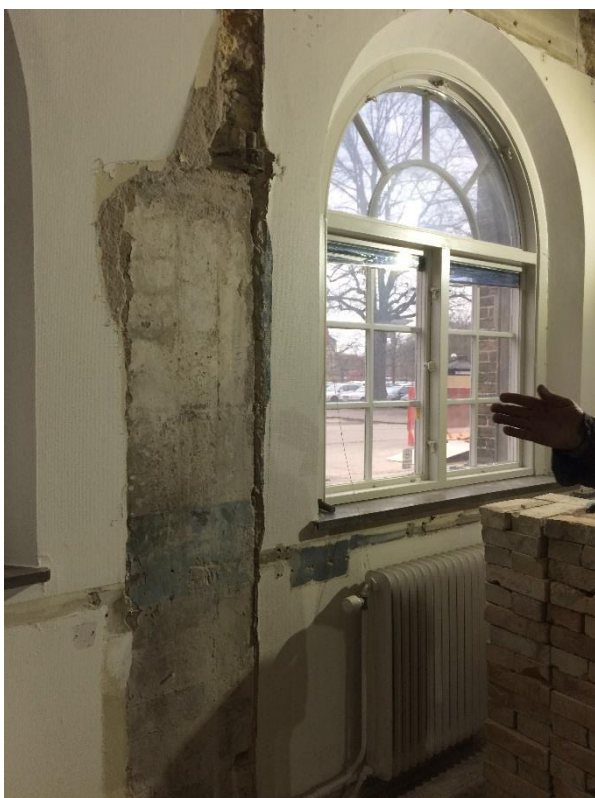
Boasering som kompletterats, tv före åtgärd, t h efter.
