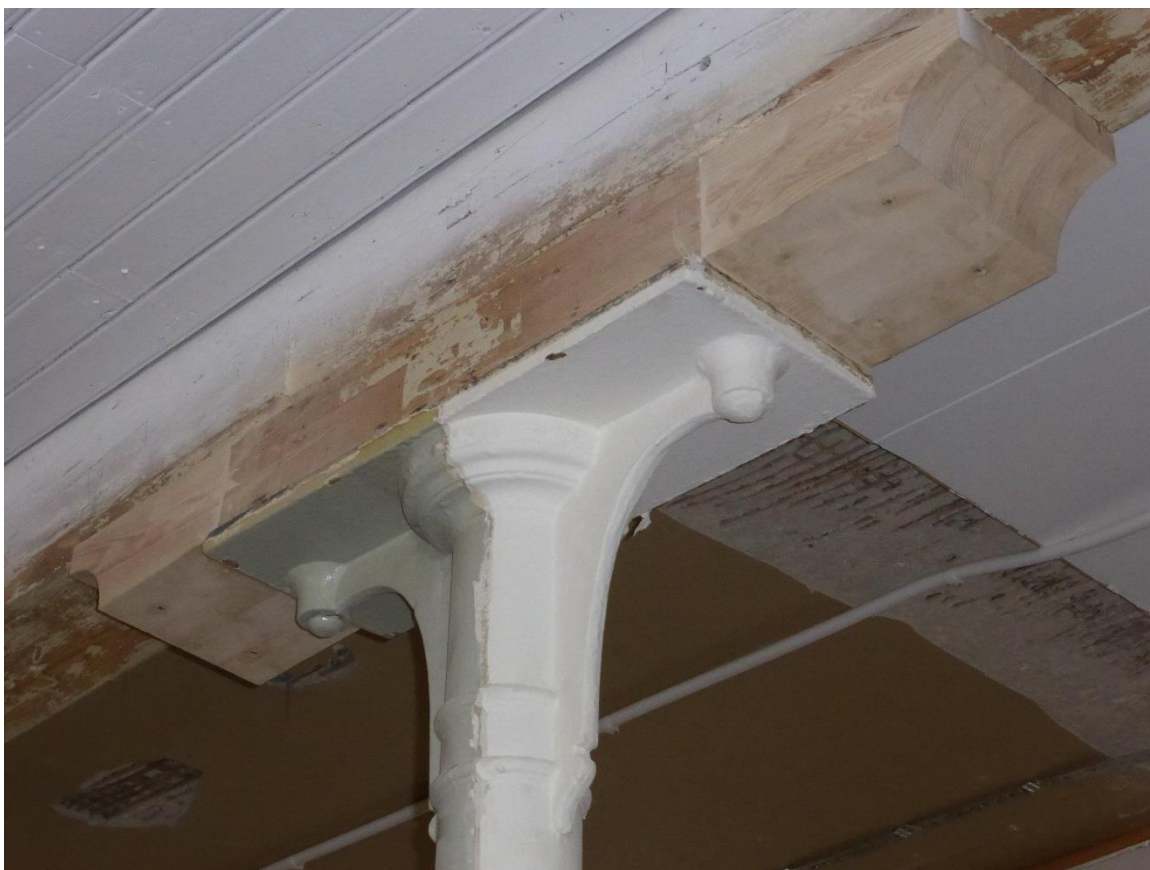
Träparti mellan pelare och bärlina kompletterat (ljusare trä med hålkälsform).
