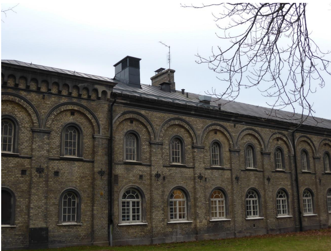
Ny ventilationshuv i svart plåt öster om den äldre tegelskorstenen.
