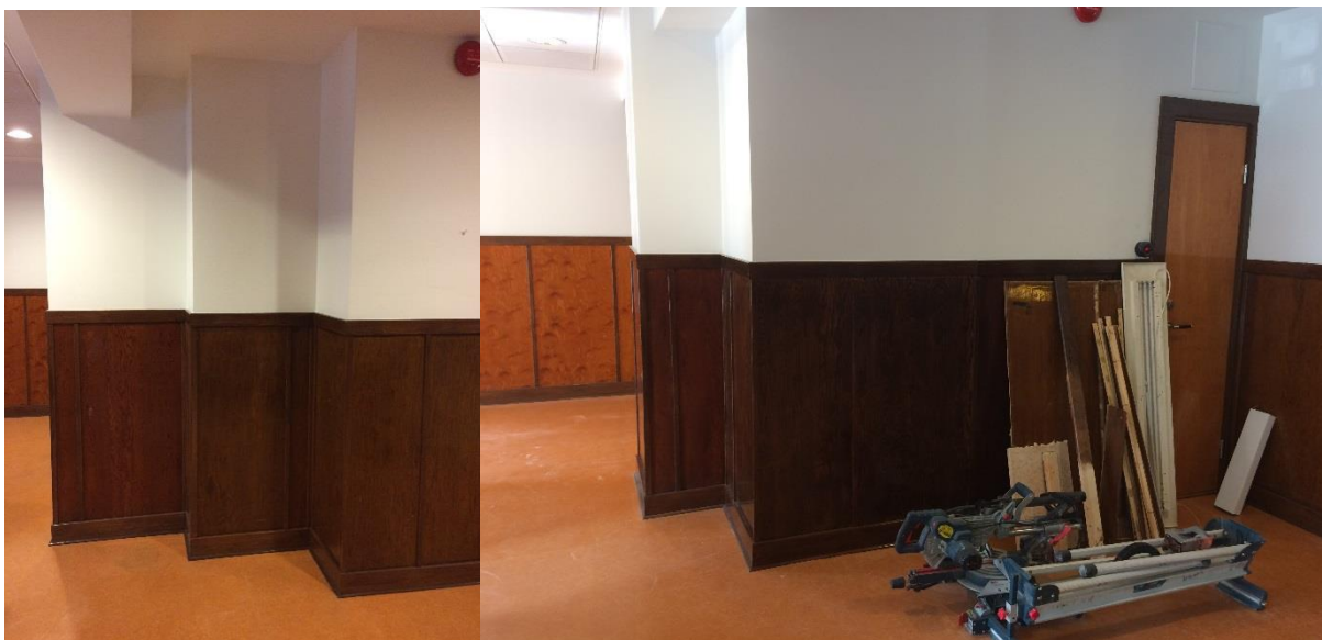
Boasering som kompletterats, tv före åtgärd, t h efter.
