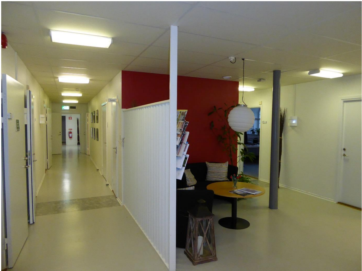
Bottenvåning Tyghuset före åtgärd, sentida innertak som döljer pelarnas kapital.
