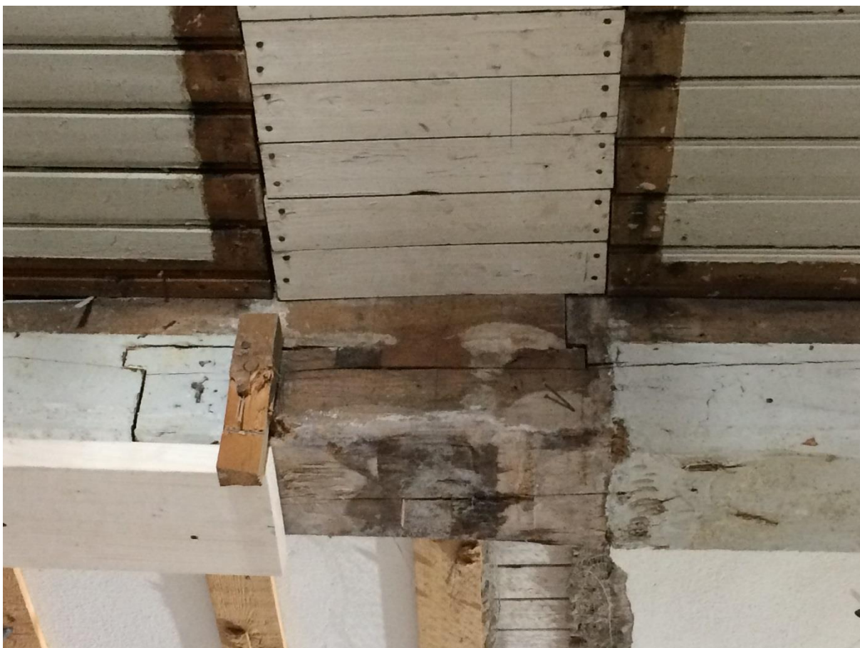
Rest efter riven tvärgående mellanvägg, ilagat med råspont, troligen borttagen vid 1940-talets ombyggnad. På bilden syns även skarven med kil (mörkare ändträ i bildens mitt)
