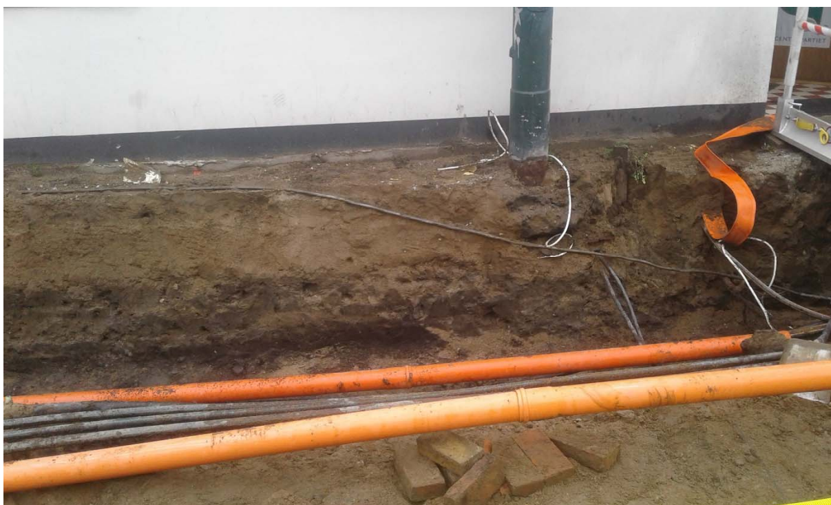
Figur 43. Schakt 28 norra delen (kvarteret Murgrönan 1). Den östra schaktväggen.
