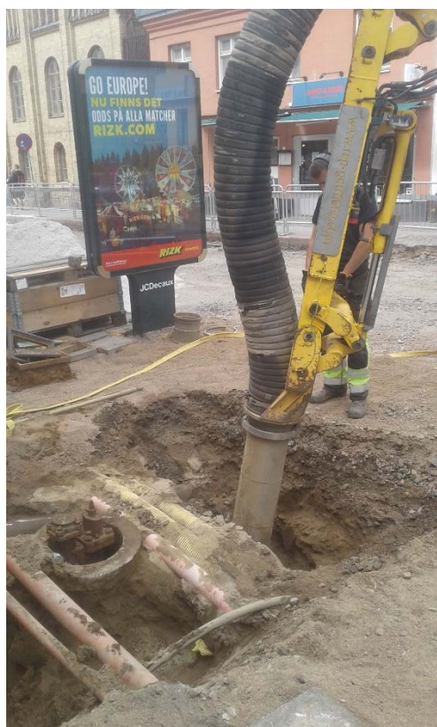
Figur 4. Munstycket till den s k jordsugen, vilken fungerade bra för att avlägsna moderna återfyllningsmaterial i en miljö med stora mängder ledningar och kablar.
