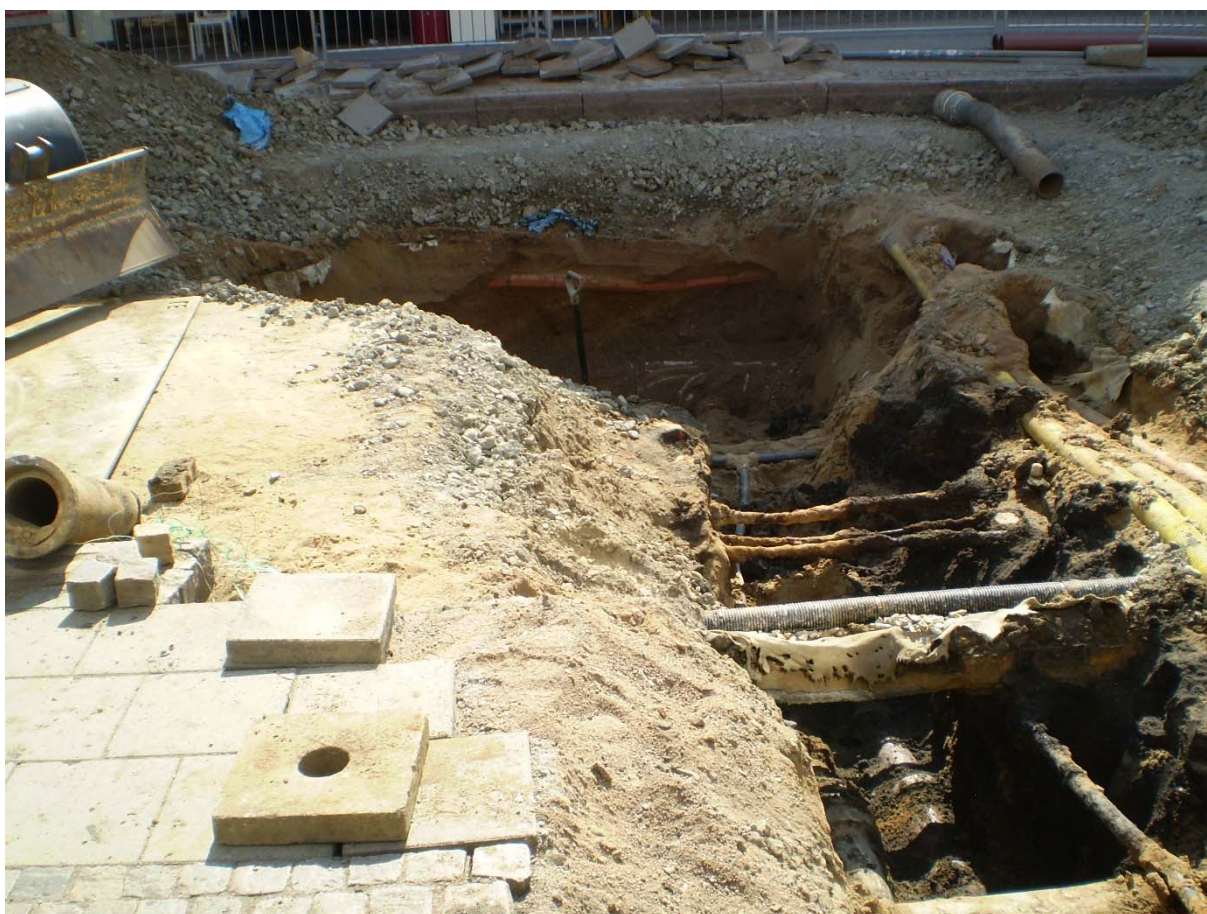
Figur 40. Schakt 25. Översikt från väster.
