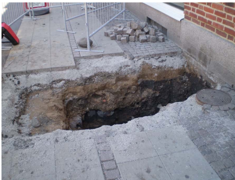
Figur 34. Schakt 5. Foto från syd.
