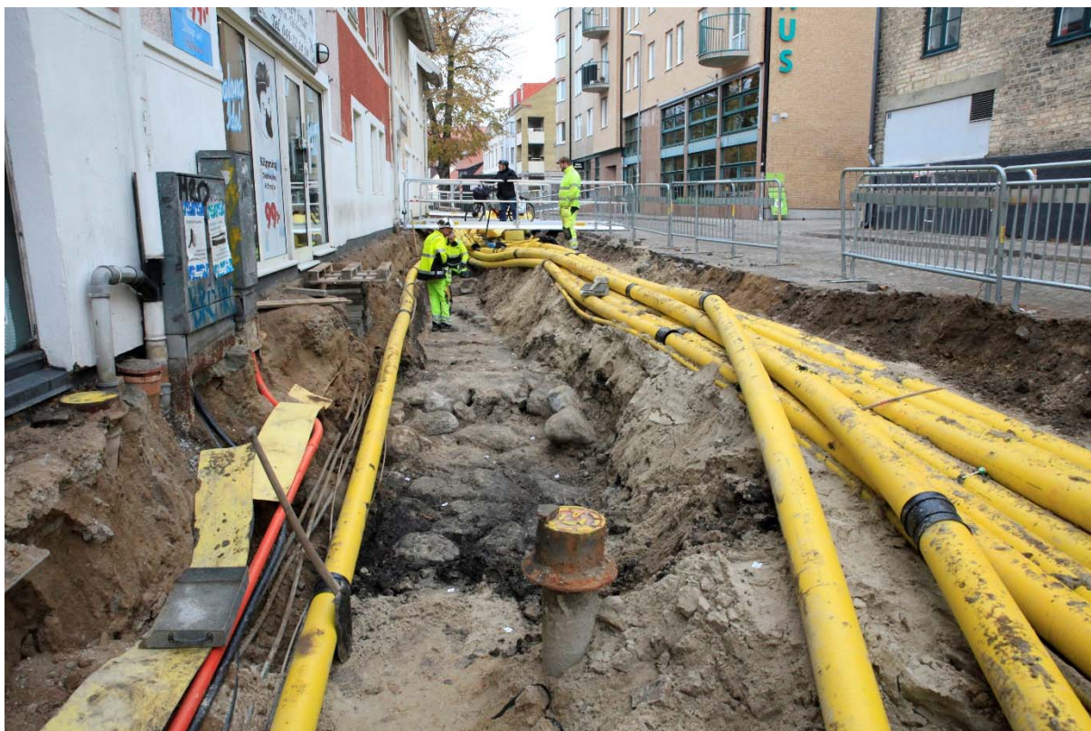
Figur 46. Översiktsbild över Schakt 35, taget från öster. Vid tillfället var den ena gångbron bortlyft och den östligaste delen av schaktet delvis återfyllt.
