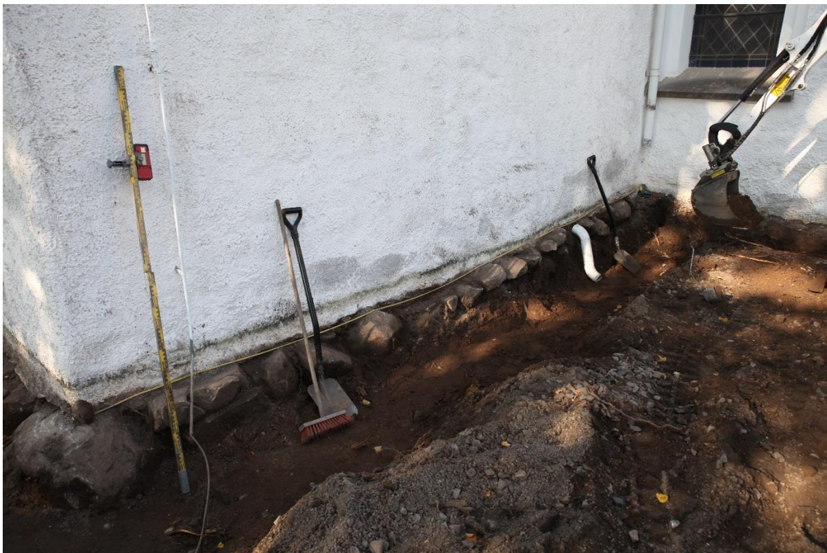
Figur 2. Foto av vapenhusets östra fasad och de framgrävda grundstenarna.
