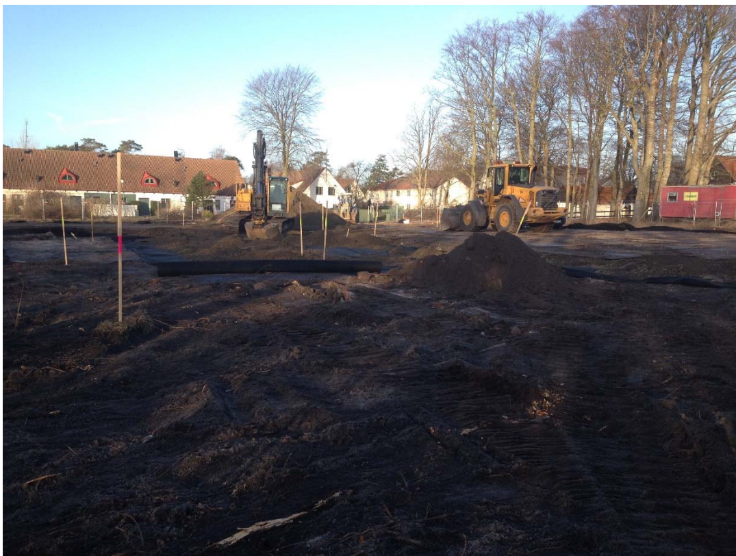
Figur 2. Markarbeten på den södra delen av fastigheten. Efter avslutad schaktning täcktes schaktbotten med geotextil innan bärlager lades ut. Till höger i bild ses delar av transportleden som täcktes med körplåtar som skydd mot belastningsskador. Vart efter som de inledande markarbetena färdigställdes täcktes även dessa med körplåtar.
