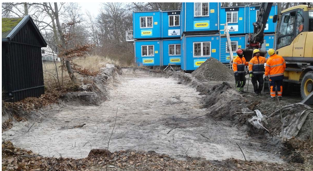
Figur 6. Den första delen av schaktningen för parkering och miljöhus är avslutad.
