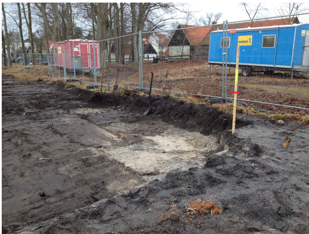
Figur 3. Den nordöstra delen av byggnad C under schaktning. Kulturlagren påträffades ytligare på den norra delen av fastigheten. Här fanns även flera moderna gropar med avfall i samt den gamla igenfyllda källaren från strandhotellet. I den ljusa flygsanden kan den lilla provgropen som användes för att i god tid upptäcka kulturlager under flygsanden ses.
