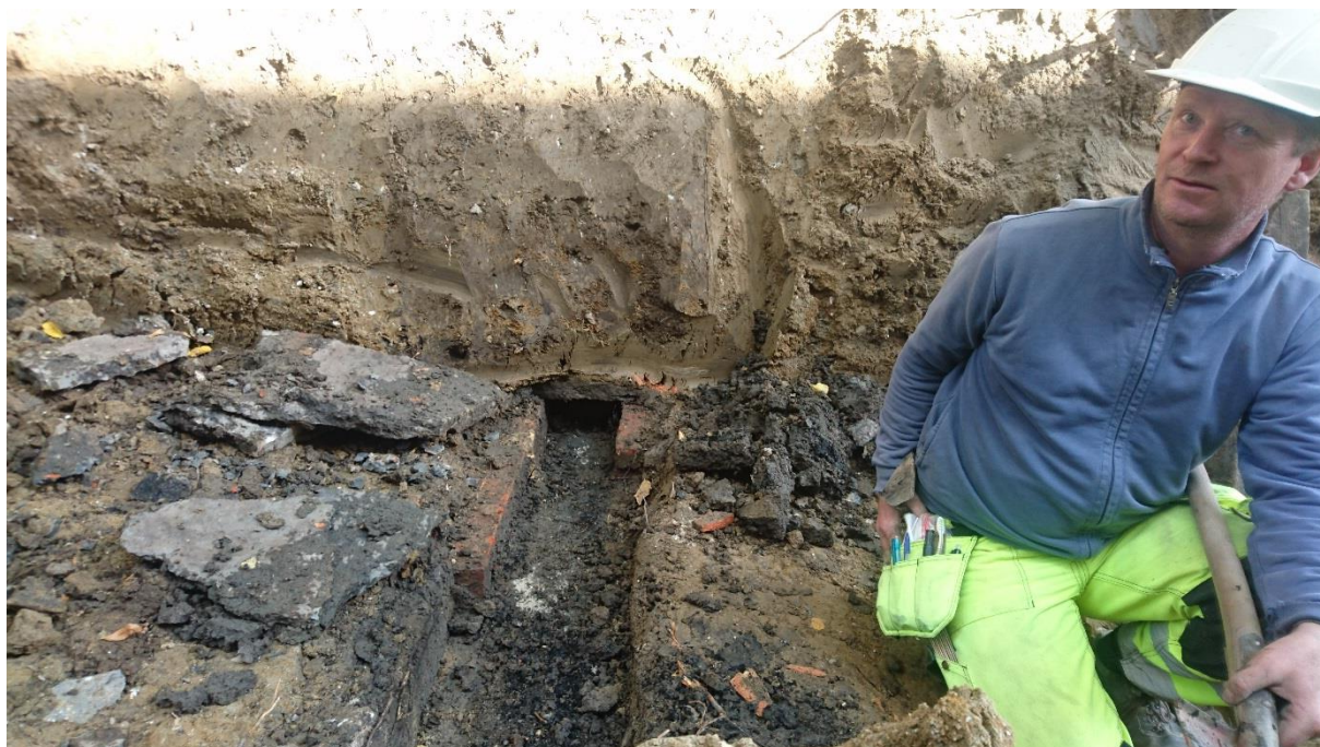
Figur 2. Vattenledning av tegel och kalksten som korsade Östra Vallgatan i södra delen av undersökningsområdet.
