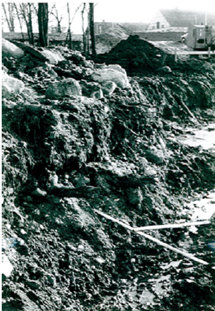
Figur 4. Fotografi från år 1957 tagit i samband med om- och nybyggnation av bron över Höje å. I de schaktade åbankarna framträder på fotografi större stenkonstruktioner, troliga kulturlager och träkonstruktioner (Kulturens LA-arkiv).
