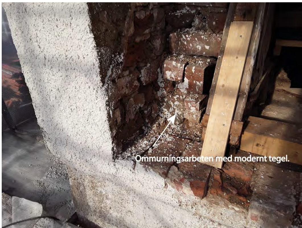
Figur 28. Gavelröstena har murats om i sen tid och då har man använt ett maskinslaget modernt tegel.
