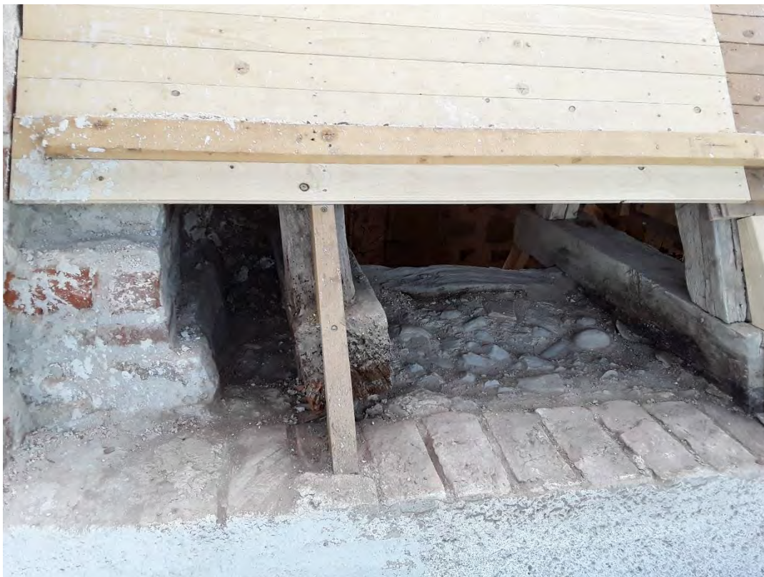
Figur 24. Efter den arkeologiska städningen kunde man tydligt se murkärnan bestående av småsten och bruk. Den yttre profilen är murad med storstenstegel.
