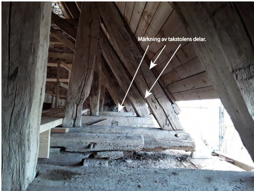
Figur 23. Takstolen har delar av återanvänt material som i flera fall har en märkning.
