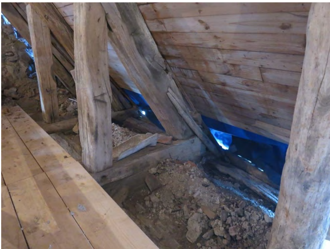
Figur 11. Före den arkeologiska städningen var murkrönet täckt av diverse organiskt material.
