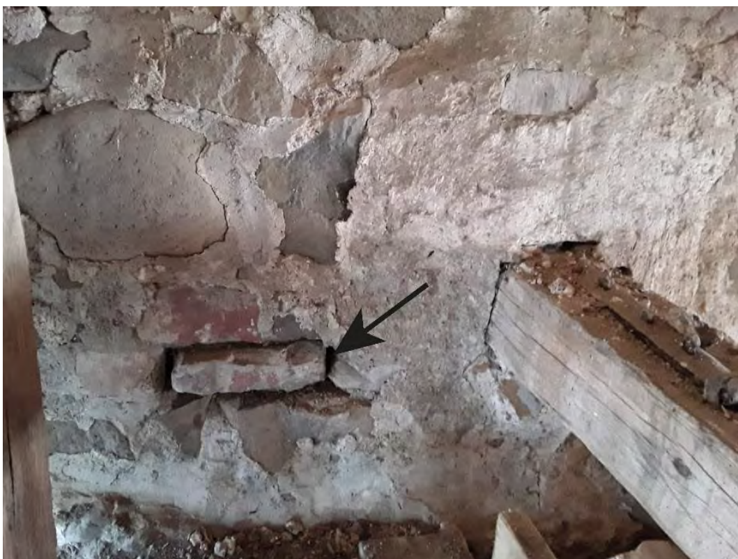
Figur 32. Hål där tidigare träkonstruktion suttit eller infästning för den byggnadsställning av trä som använts när tornet byggdes på 1400-talet.
