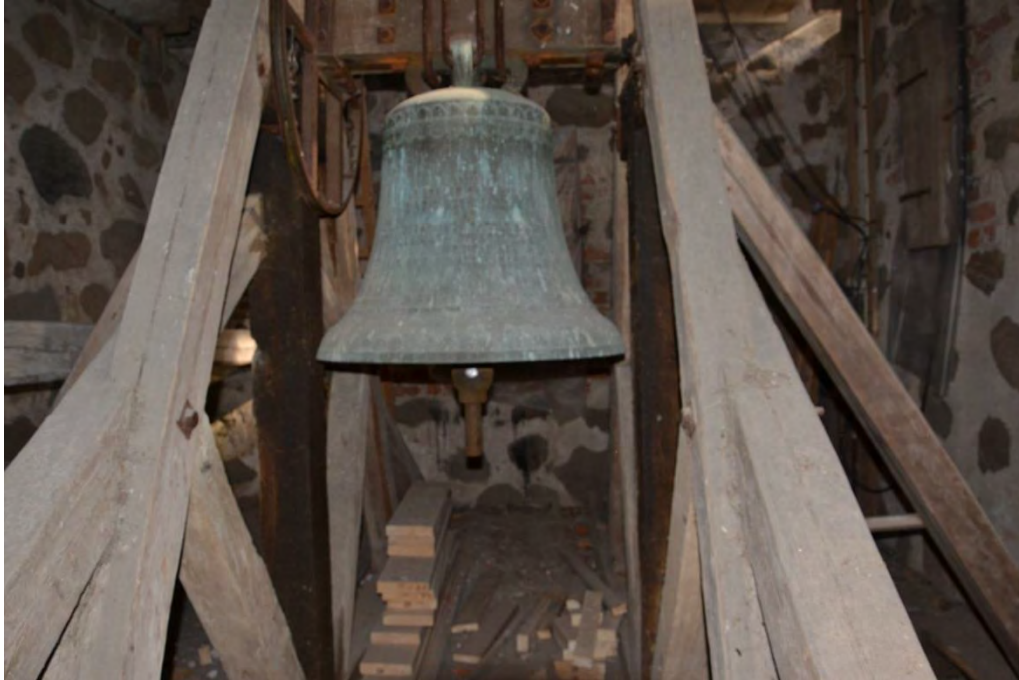
Figur 35. Klockan i tornrummet.
