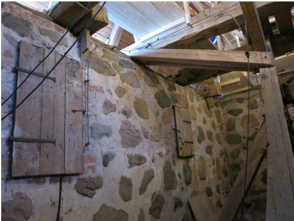
Figur 36. Luckorna som täcker ljudöppningarna för klockringningen.
