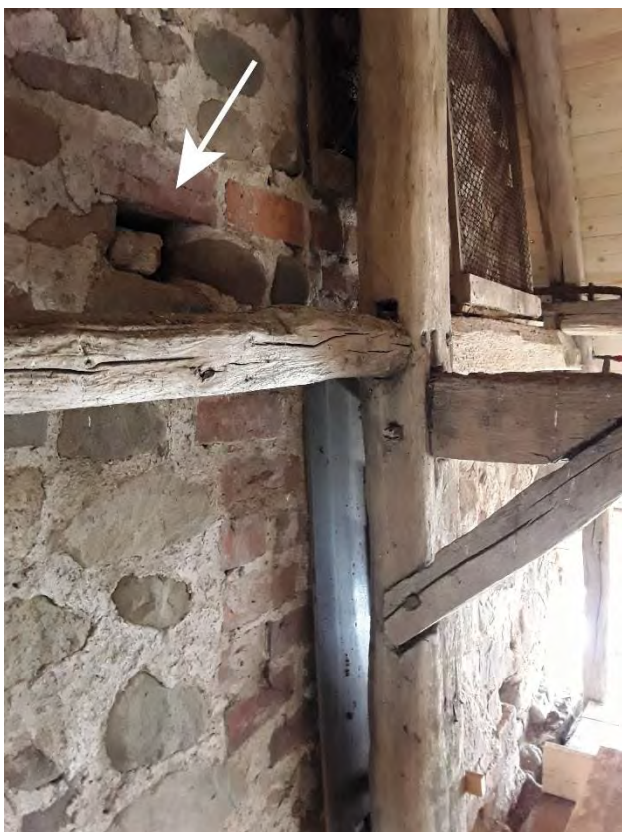
Figur 33. Hål där tidigare träkonstruktion suttit eller infästning för den byggnadsställning av trä som använts när tornet byggdes på 1400-talet.
