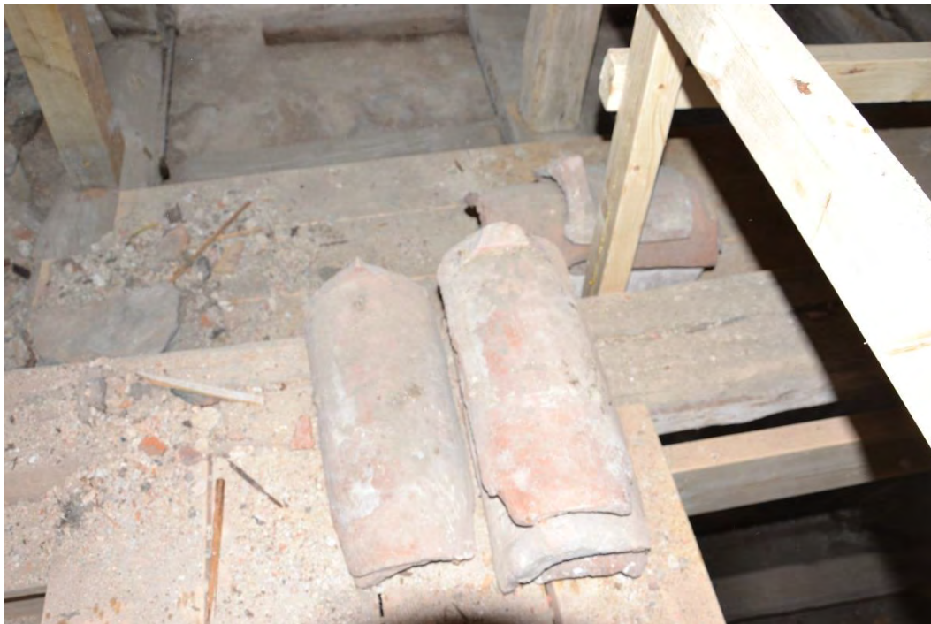
Figur 25. I tornet förvaras ett antal hela handslagna medeltida nunnetegel.
