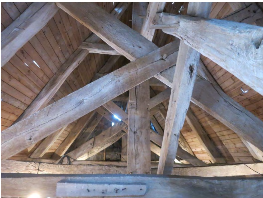
Figur 21. Taklaget i tornet består av återanvända delar från en äldre konstruktion.
