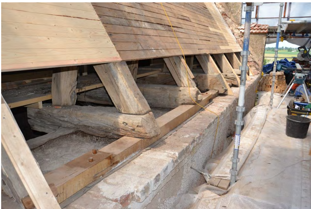
Figur 31. Östra murkrönet sett från sydost med lagning av remstycket. Foto Jan Kockum.
