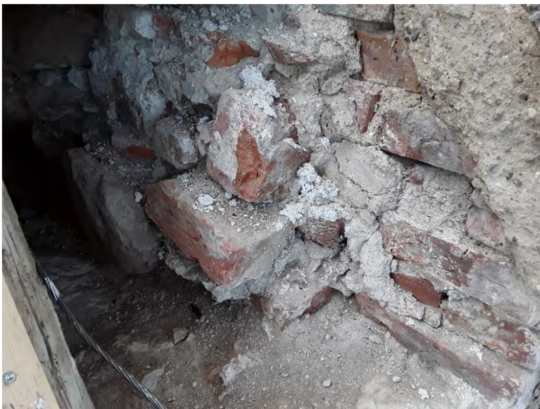
Figur 29. Gavelröset mot söder, där man kan se att man murat med modernare tegel mot de medeltida handslagna teglen, som också har en större dimension.
