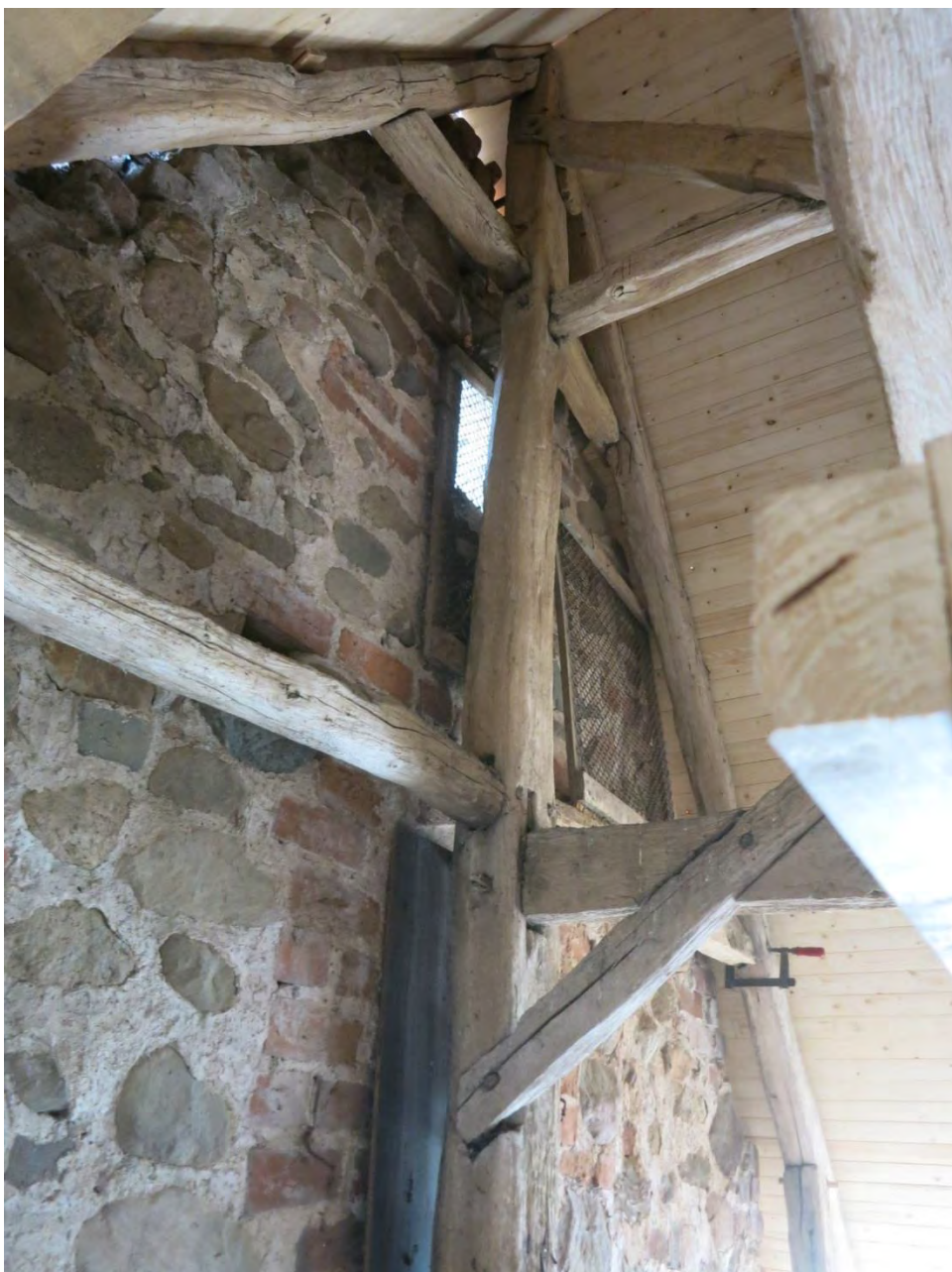
Figur 22. Murverket är uppfört i natursten med omfattningar runt öppningar i tegel.
