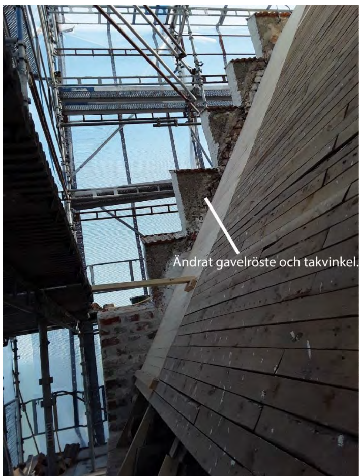
Figur 26. Takvinkeln har ändrats vid något tillfälle, vilket syns som avtryck i bruket.
