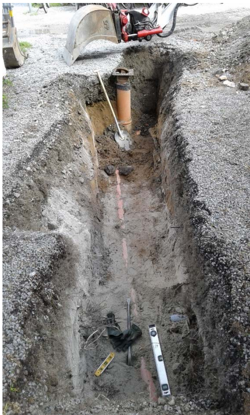
Figur 3. Del av schaktet i söder, med befintlig spolbrunn och befintlig ledning (jfr. bilaga).
