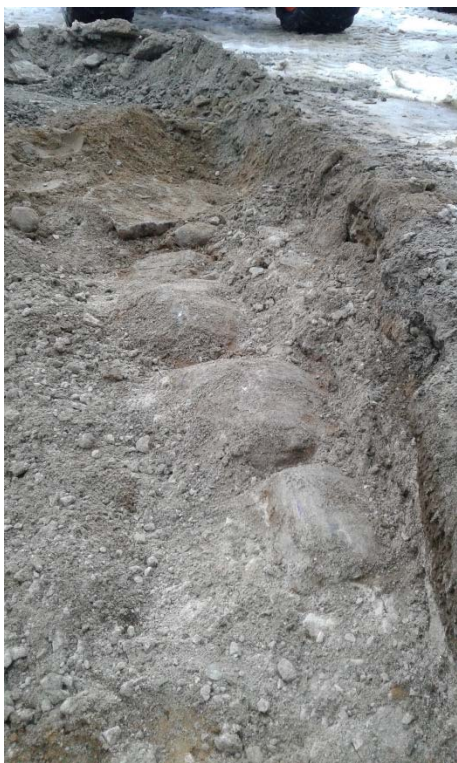
Figur 5. Grundmur till byggnad 2 i schakt 4.
