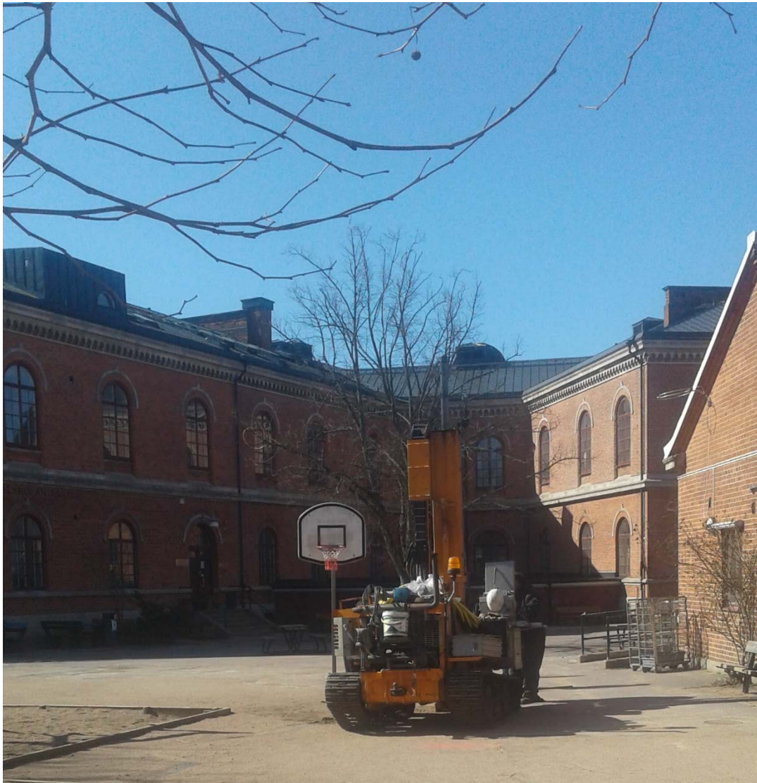
Figur 4. Borrpunkt 18T02 i färd med att borras. Fotografiet taget från norr.
