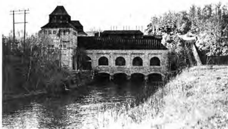
4. Hemsjö Övre kraftverk togs i drift vid årsskiftet 1907-1908. Kraftstationen från avloppskanalen. Foto Sydkrafts arkiv.
