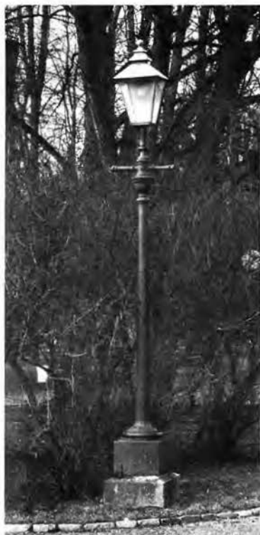
2. En av de fyra gaslyktorna på Tegnérplatsen med den fyrkantiga armaturen som efter några år ersatte den ursprungliga sexkantiga.
