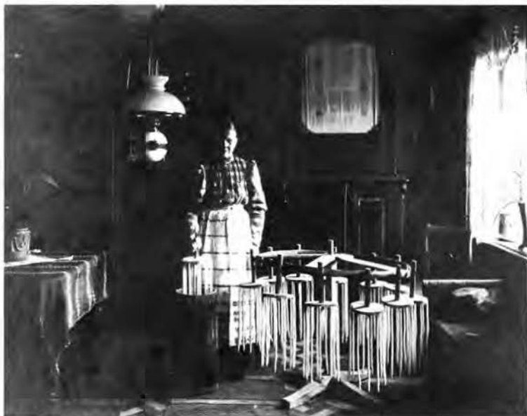
4. Ljustöpning med hjälp av "stöphjul" eller "stöpbord". Starby sn, Skåne. Foto Nordiska museet.
