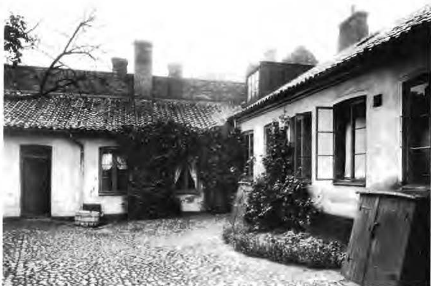
4. Gårdsparti från Wallengrenska huset Tomegapsgatan 24, där Strindberg hade en tvårummare från början av april 1898 till nyår 1899. T.h. syns källartaket, där han ställde ut "guld" till torkning.
