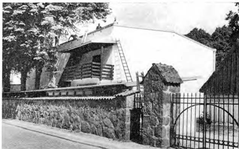
Nordiska textilhallens fasad mot St. Algatan. Bakom muren »tvätthuset» och vädringsgården.
