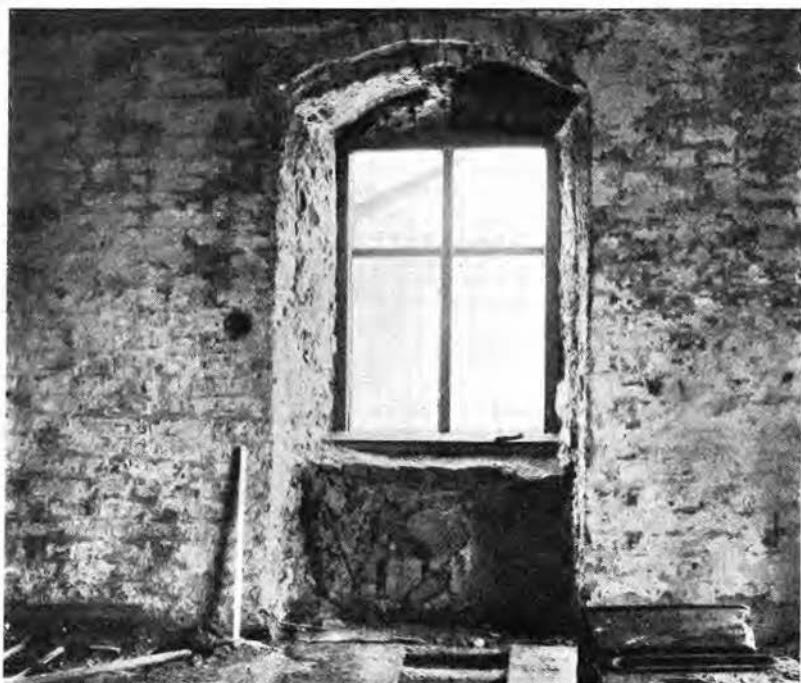
Bild 18. Fönstret i norra väggen i tornets andra våning, D 2 , sett inifrån vid rivningen 1908.
