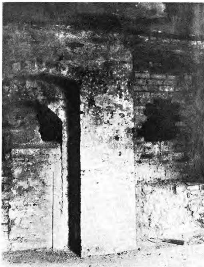
Bild 15. Den ursprungliga ingången till första våningen D 1 i tornet stod igenmurad 1908. Den ses här t.v. inifrån rummet D 1 . T.h. en sekundärt upphuggen men senare igenmurad fönsteröppning.
