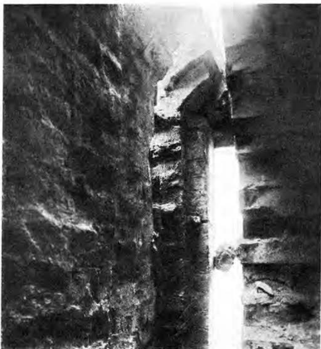
Bild 20. På västra sidan av tornet D fanns vid andra våningen brottytor efter en mur samt ett stycke av en stickbåge. Efter dessa rester har det nuv. »väktarrummet» rekonstruerats. Muren t. h. tillhör det 1856 uppförda magasinet.
