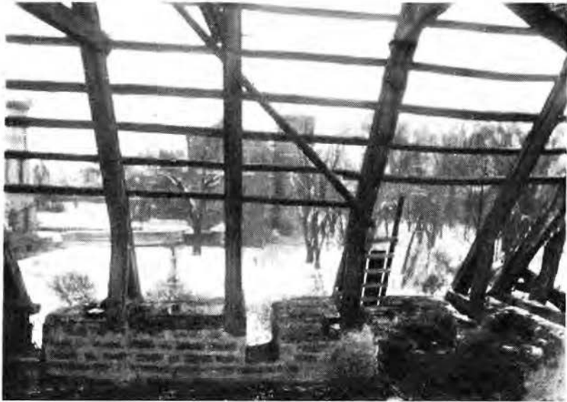
Bild 23. Tornet D har vid murarnas krön åtta skyttegluggar, av vilka de båda i östra muren ses på ovan återgivna foto från rivningen 1908.
