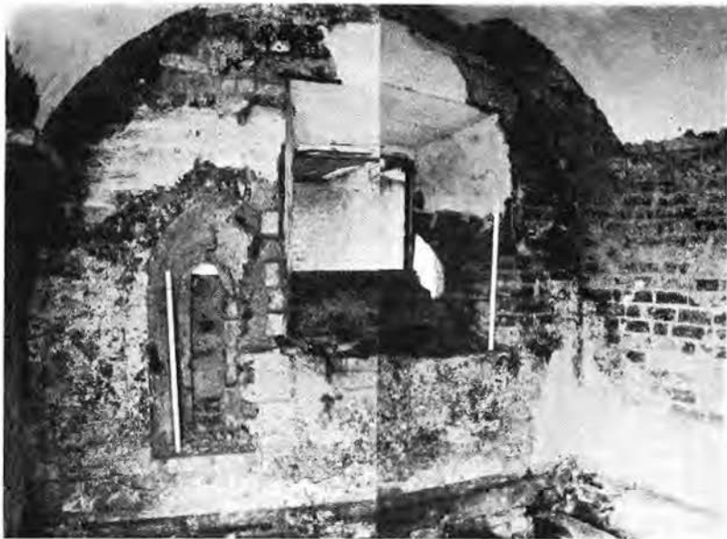
Bild 14. Väggen med de båda spetsbågiga fönstren (se föreg. bild) sedd inifrån rummet C'. Lägg märke till rummets tunnvalv.
