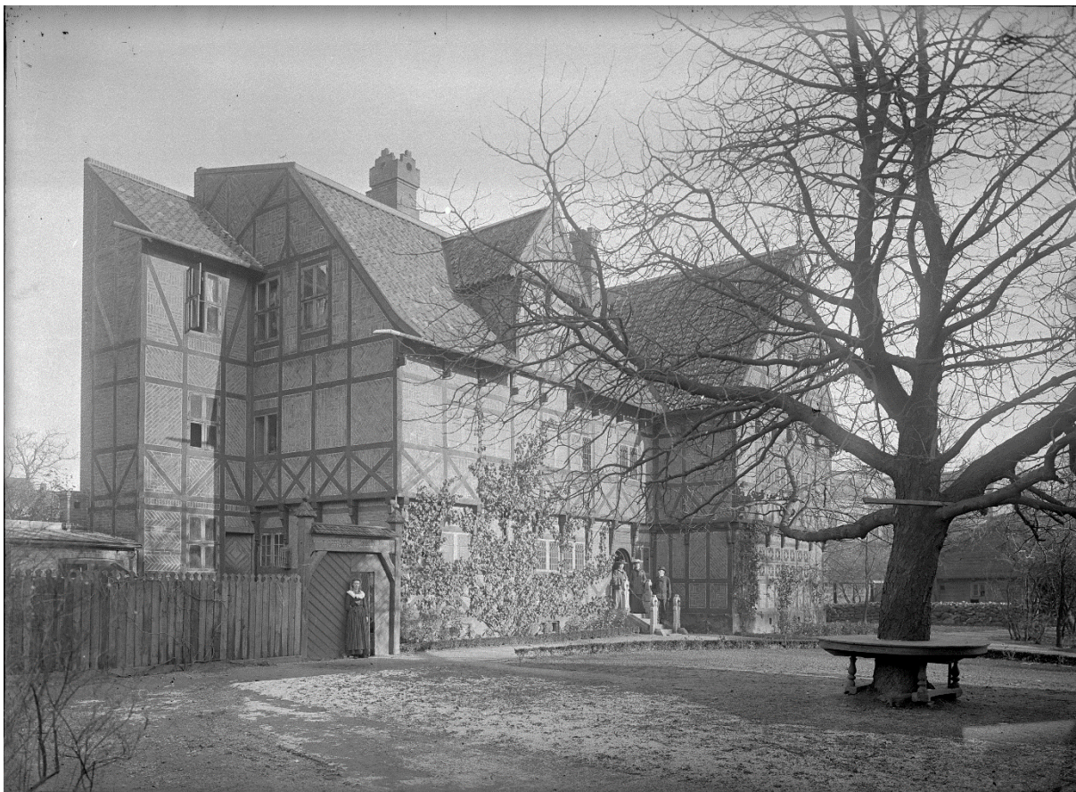
Borgarhuset eller "Malmöhuset" som det kallades ursprungligen. På fotot syns att byggnaden ursprungligen haft nockar av plåt, och inte tegelpannor som idag. Istället för stuprör stack hängränorna ut en bit från fasaden. Portalen till vänster står idag framför rustmästarbostaden. Foto ur Kulturens arkiv.
