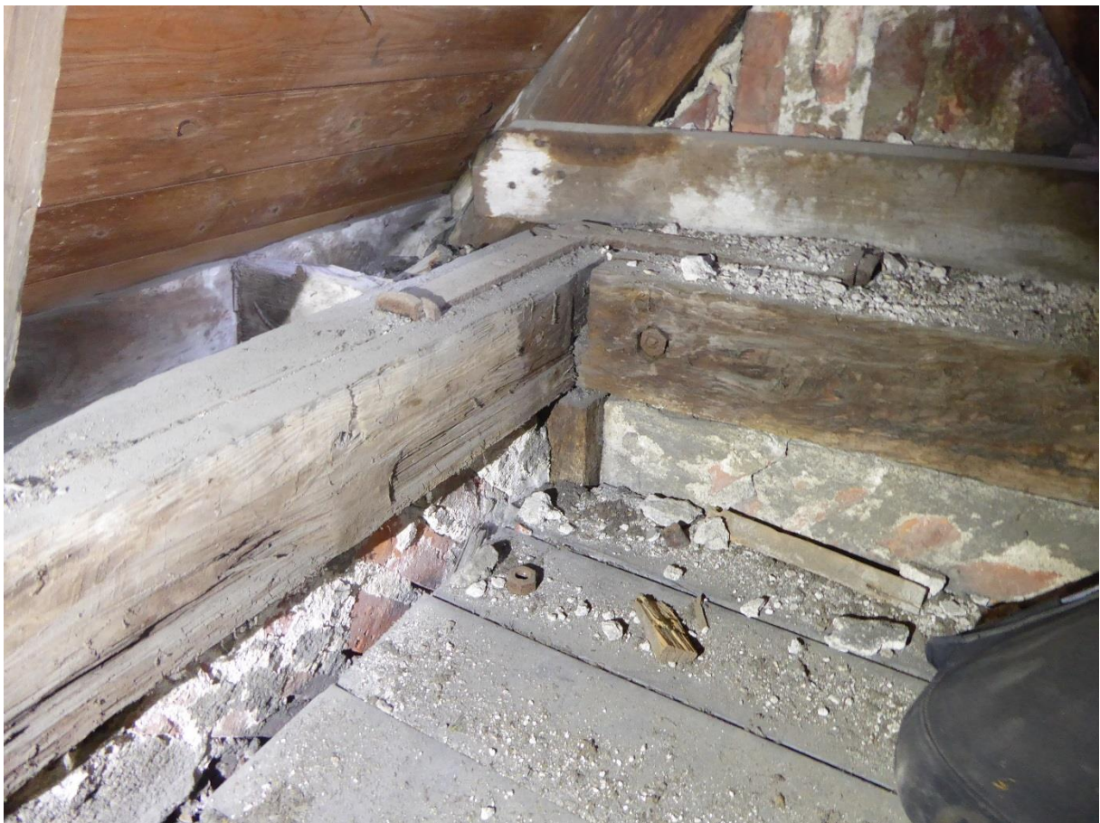
Remstycke vid mötet med gaveln (byggnadens sydöstra hörn, krypvinden.)
