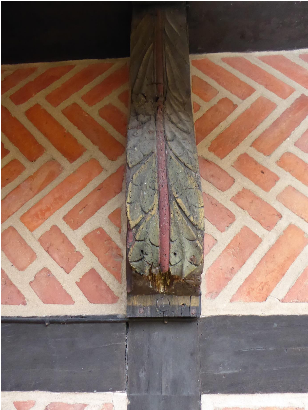
Röta i underkant på knekt (takfoten på den åt söder utstickande delens västra sida).
