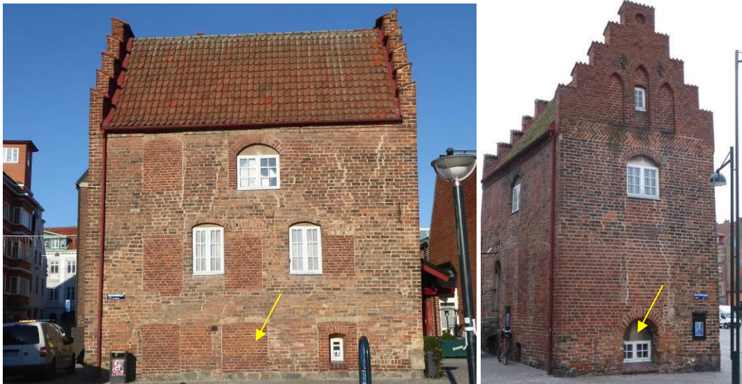
Figur 4. Pilarna markerar samma dörrar som på bilderna ovan. Vänster: södra fasaden. Höger: västra fasaden.
