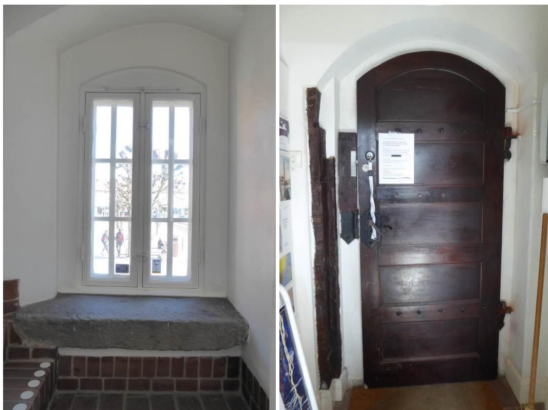
Figur 8. Vänster: Bottenvåningen, fönster med stenbänk. Höger: träbjälke invid ytterdörren.
