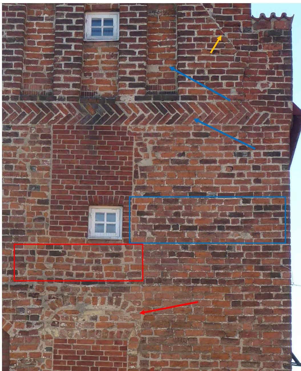
Figur 13. Östra gavelfasaden med exempel på murningar från fas III (blått), fas IV gult och eftermedeltida fas (rött).
