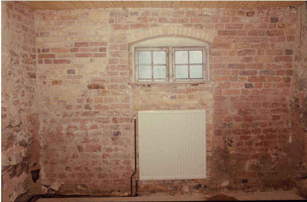
Figur 5. Västra källarväggen 1973. Murningar från flera olika faser. På bilden ser man även brädtaket i källaren vilket i dag döljs under skivor. Foto Claes Wahlöö och Nils Ove Nilsson. Källa: Kulturen LA33305.
