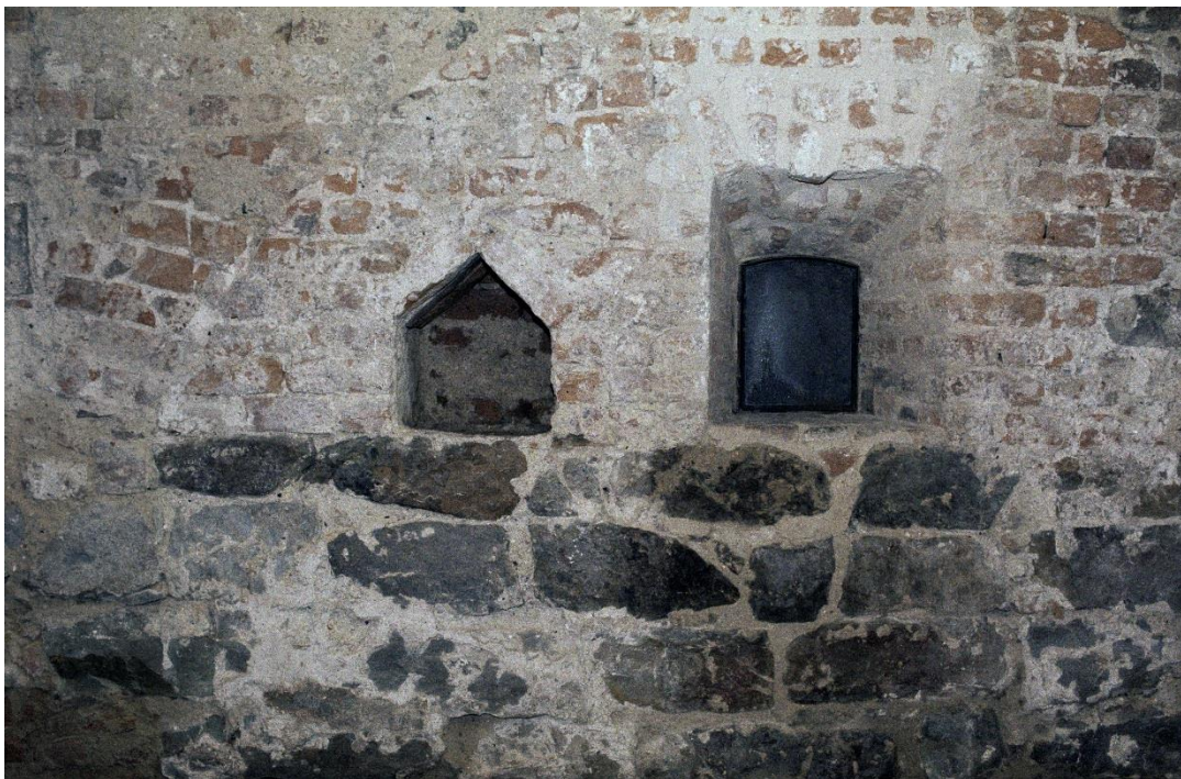
Figur 6. Norra källarväggen 1973. Här kan man ana spår efter valvslagning kring väggnischerna. Foto Claes Wahlöö och Nils Ove Nilsson. Källa: Kulturen LA3302.
