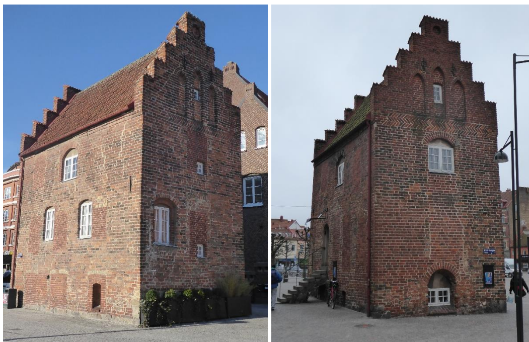
Figur 1. Vänster: Södra och östra fasaderna. Höger. Norra och västra fasaderna.
