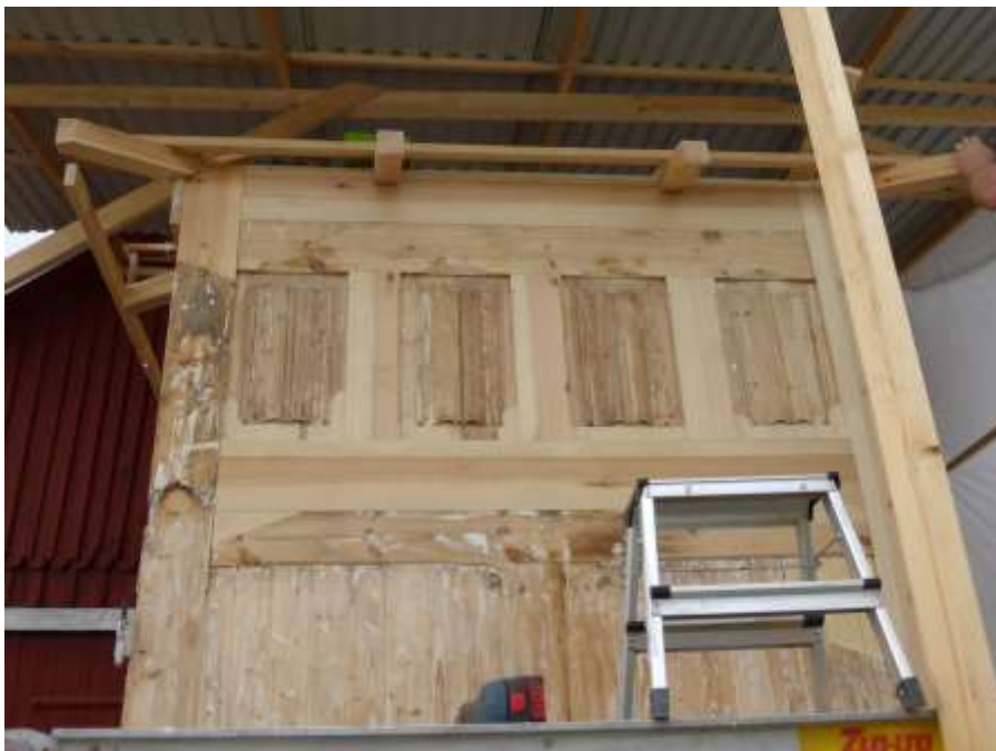
7 Spegarna lagade och ramverken till stor del nyttillverkade. Ny takstol monterad. Rötskadade delar i den bärande stommen byttes i flera omgångar för att inte påverka stabiliteten och att byggnaden inte skulle behöva demonteras mer än nödvändigt. Skadan ovan gångjärnet till vänster är här inte lagad ännu.
