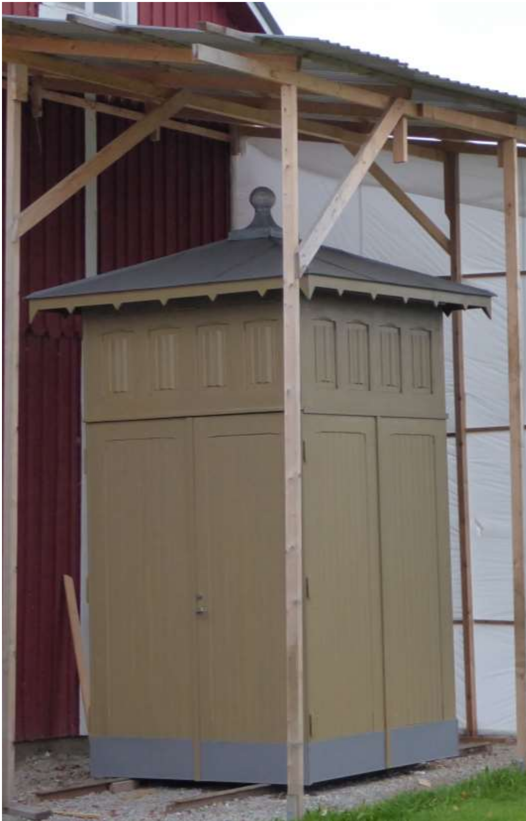
7 Byggnaden då trä- och plåtarbeten är färdigställda. Byggnaden grundmålad med samma kulör som tidigare (S5020-Y10R).
