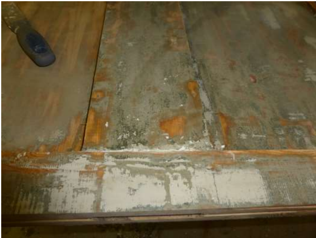
4 Borttagning av färg på speglarna. Underst fanns spår av tjocka lager av den mörka umbrakulören.
