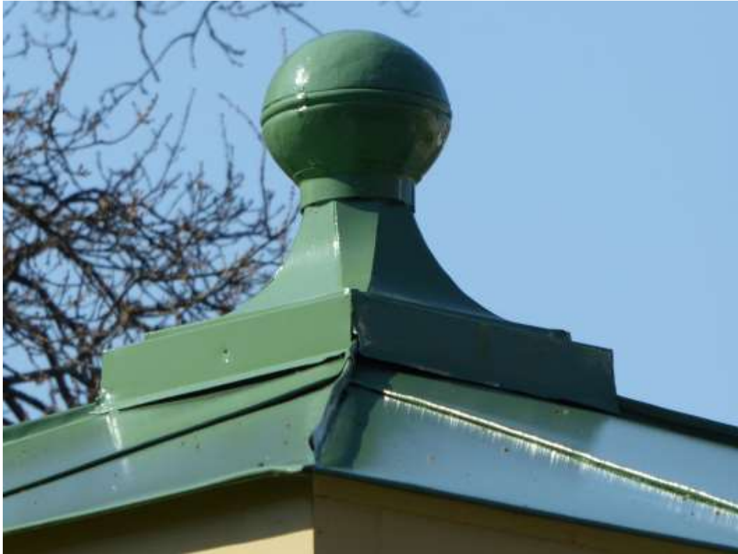
12 Detalj av takspiran och ståndfalsar/ hakfalsar i takläggningen.
