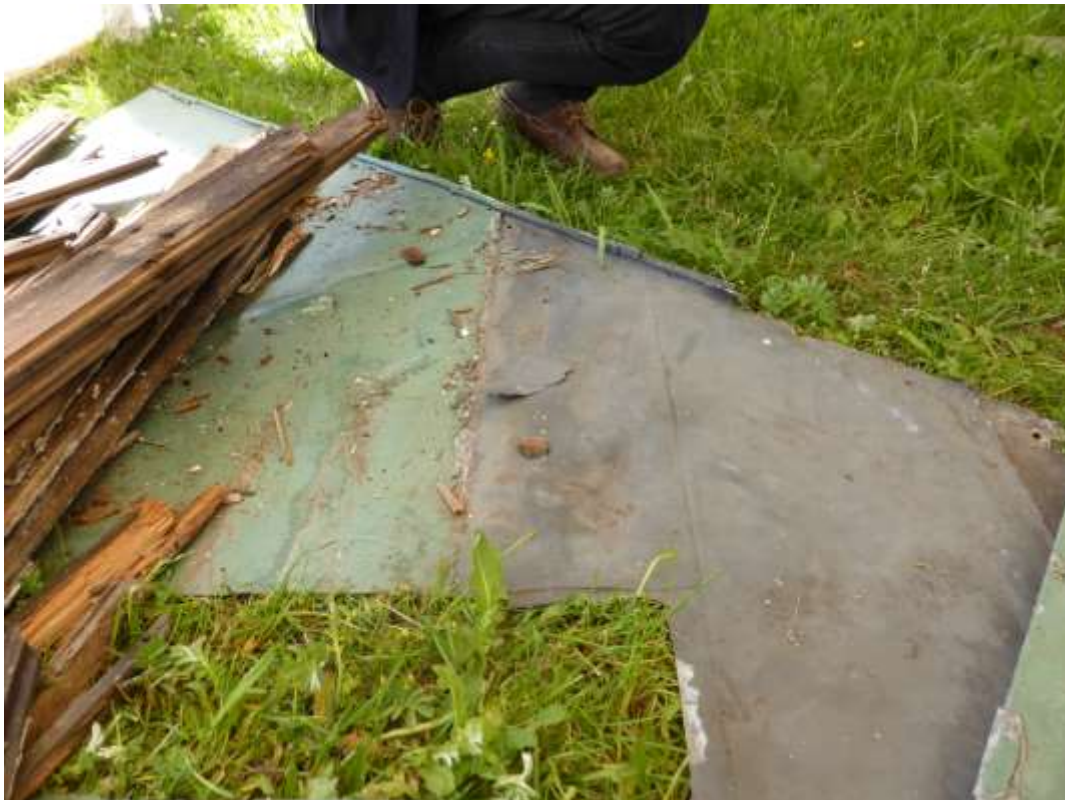
8 Takplåtarna med lödade skarvar. Den grå delen av plåten, som är omålad, var övertäckt med en lagningsplåt. Taket kan alltså ursprungligen varit omålat.
