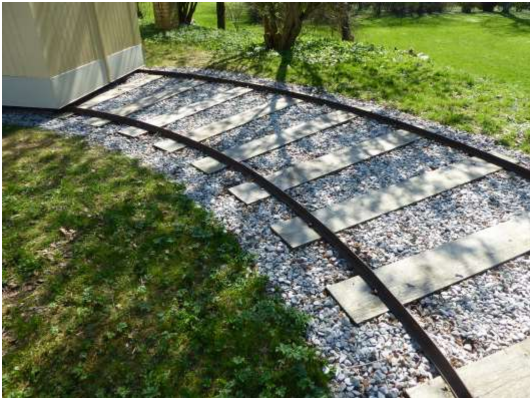
14 Rälsen med nytt bärlager och nya ekslipers. Rälsen fäst med räлsspik.
