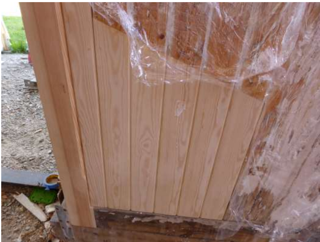
9 Panel utbytt. Färg togs bort med hjälp av färgborttagningsmedel.
