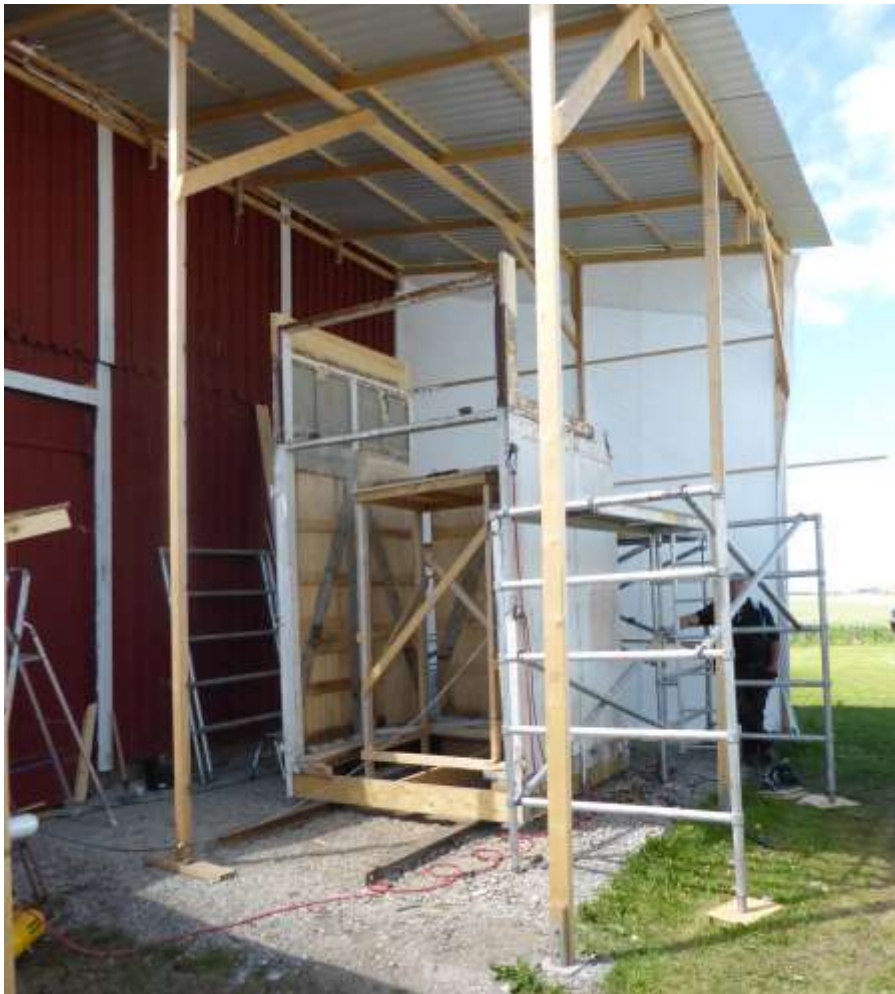
6 Byggnaden då portarna och speglarna monterats bort och taket och övrigt rötangripet trä avlägsnats.
