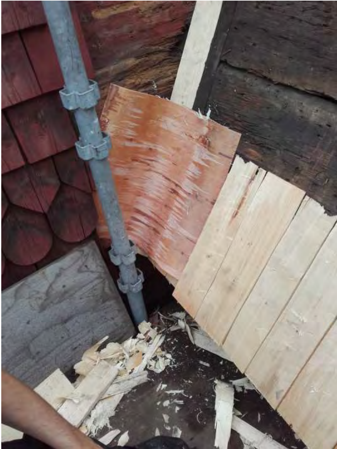
12. I skarv mellan kor och långhus har ett kilformat läkt lagts under spånen för att skapa fall ut ifrån gaveln. Skarven har också försetts med näver i tre lager.
