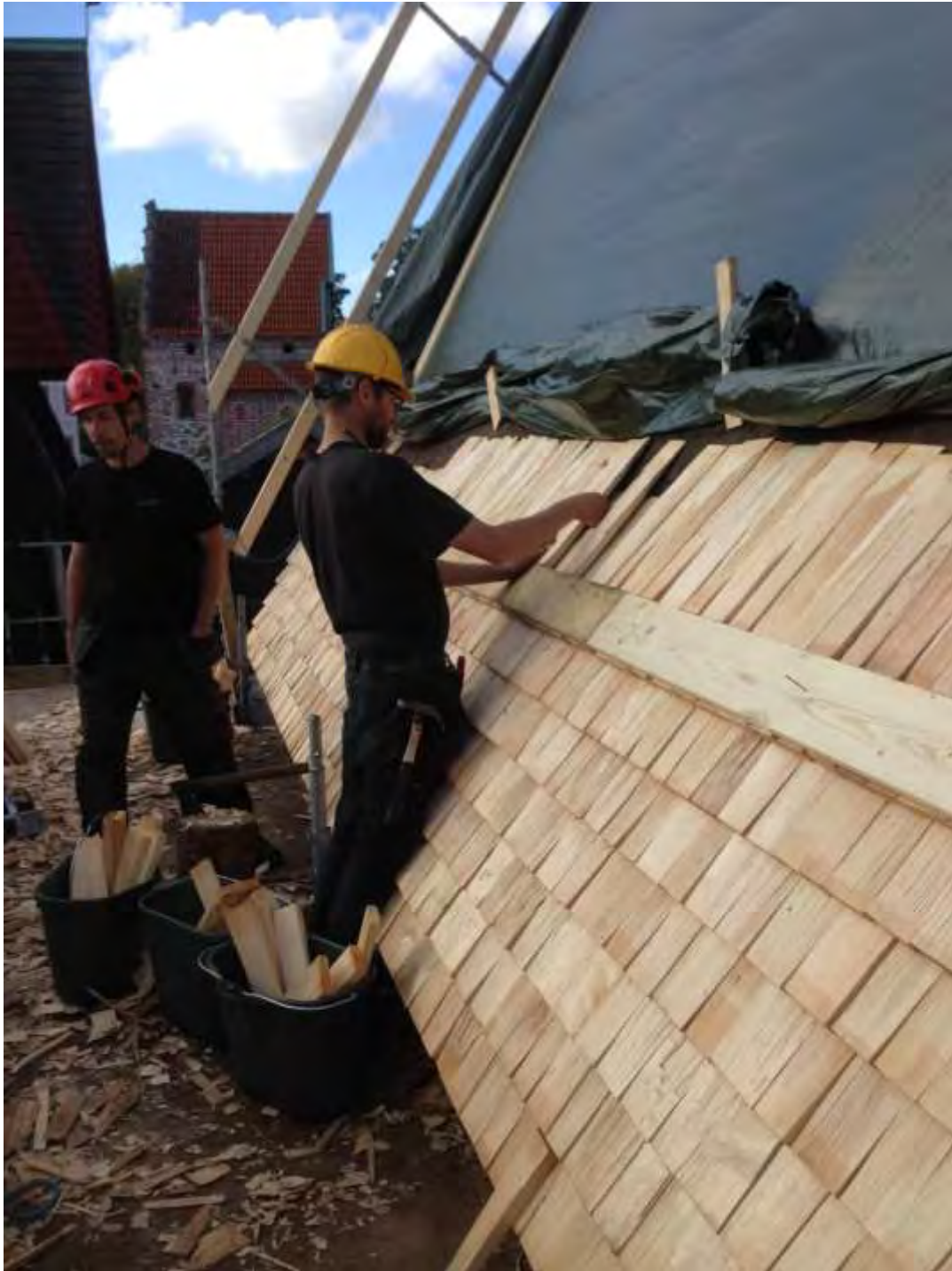
11. Läggnig av taket med spån med fallande bredd. Spånen lagda med överlapp om 1/3 i längdriktning och minst en tum i sidled.
