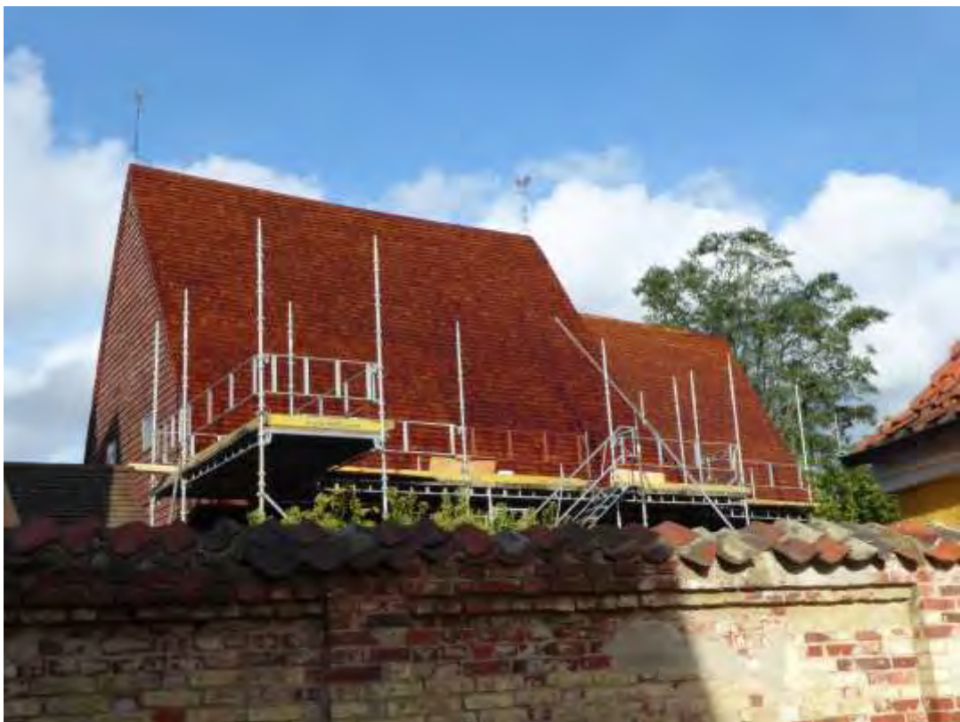
3. Södra takfallen efter utfört arbete.
