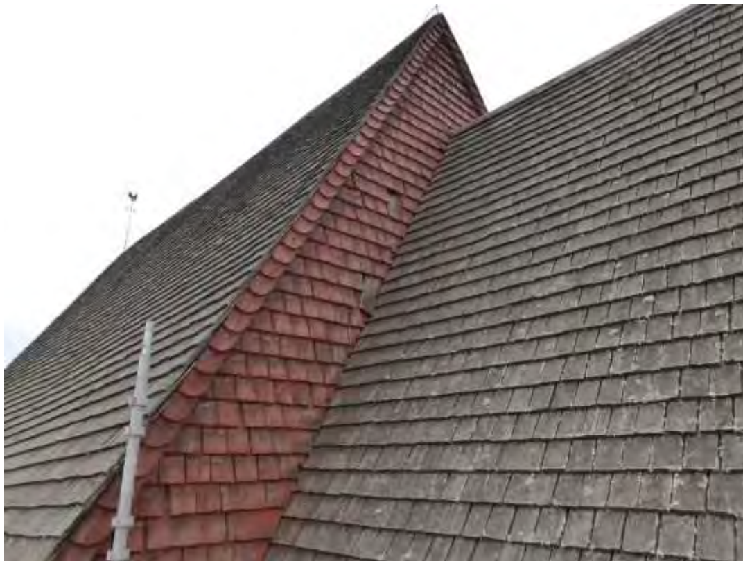
1. Södra takfallen före nyläggning långhus och kor.
