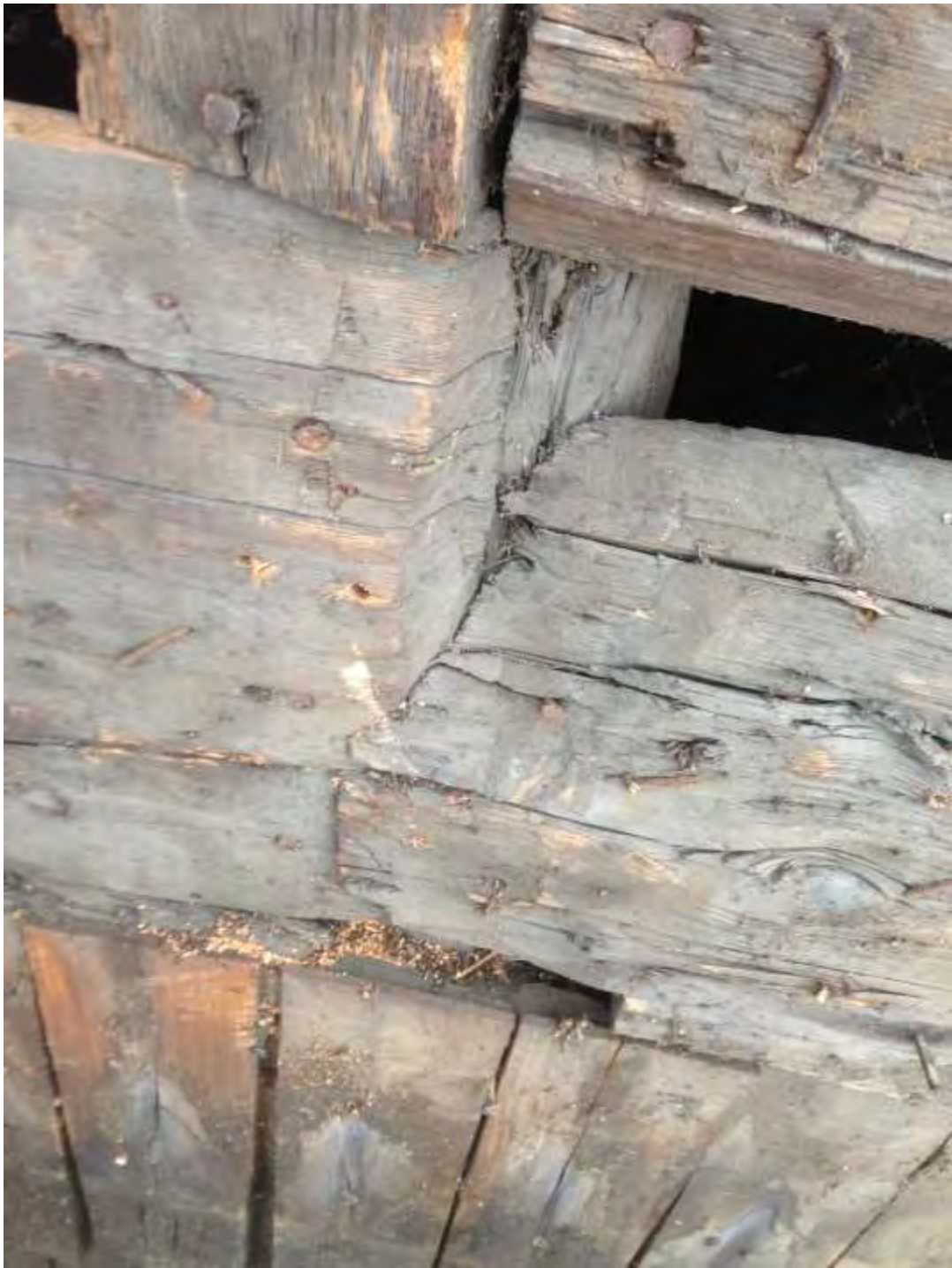
14. Skarvar över takstol i taktron.
