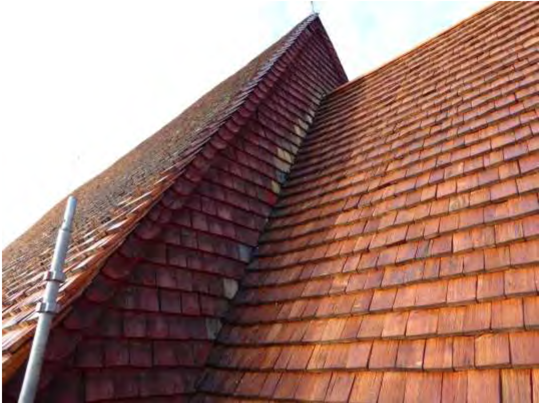
2. Södra takfallen efter utfört arbete.
