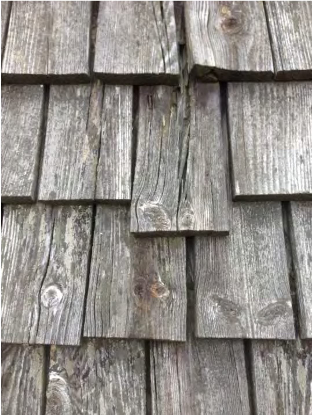
4. Gamla takspånen med kvistar sågade ur sidobrädor med tangentiella årsringar. De var utlagda ömsom med kärnsidan uppåt, ömsom neråt.
