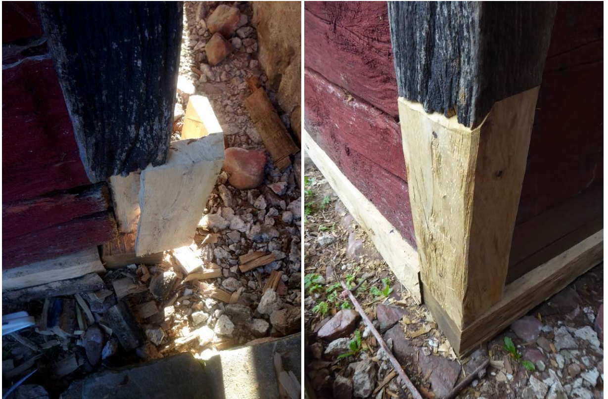
Figur 12-13. Under arbete. Nordöstra hörnet. Vänster: Hörnstolpen lagas halvt i halvt. Höger: samma hörn sett från norr. Stolpens lagning är spikad med nyttillverkad smidd spik. Mötet mellan gammal stolpe och lagning är avfasad sluttande neråt. Järnet som på bilden ligger på marken är inte återmonterade men sparas för att senare kunna återmonteras om det skulle visa sig att byggnaden rör på sig.
