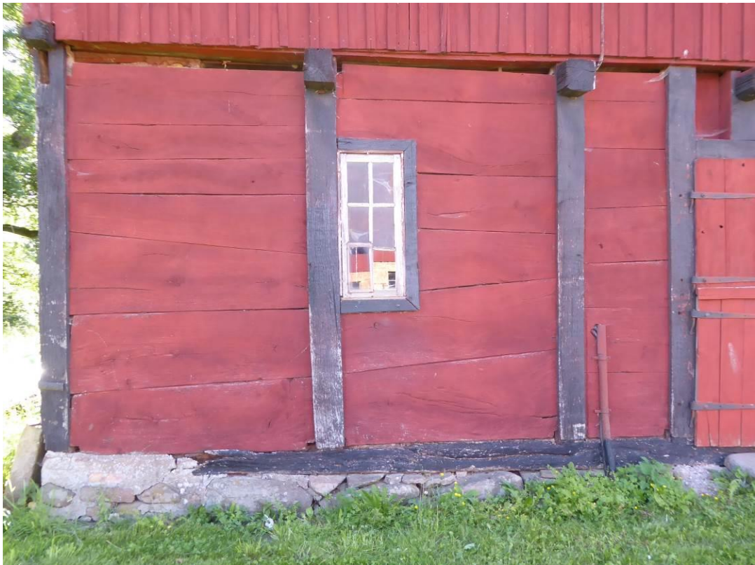
Figur 5. Före åtgärder. Fasad mot gården, sydöstra hörnet.
