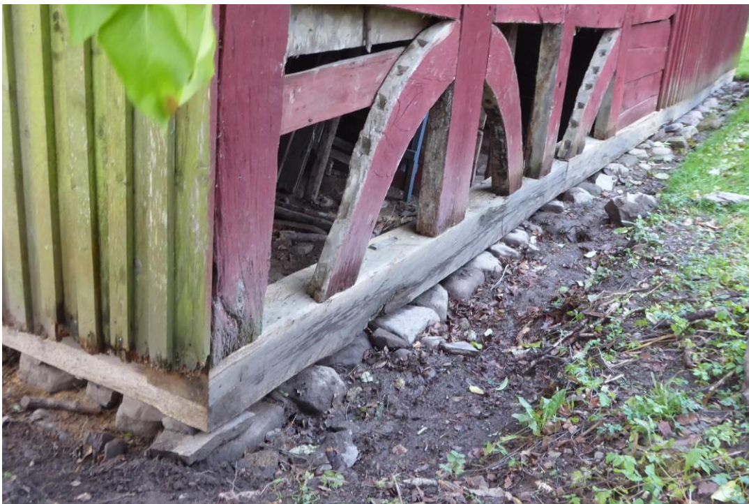
Figur 39. Efter åtgärder. Nordvästra hörnet med bytt syll.
