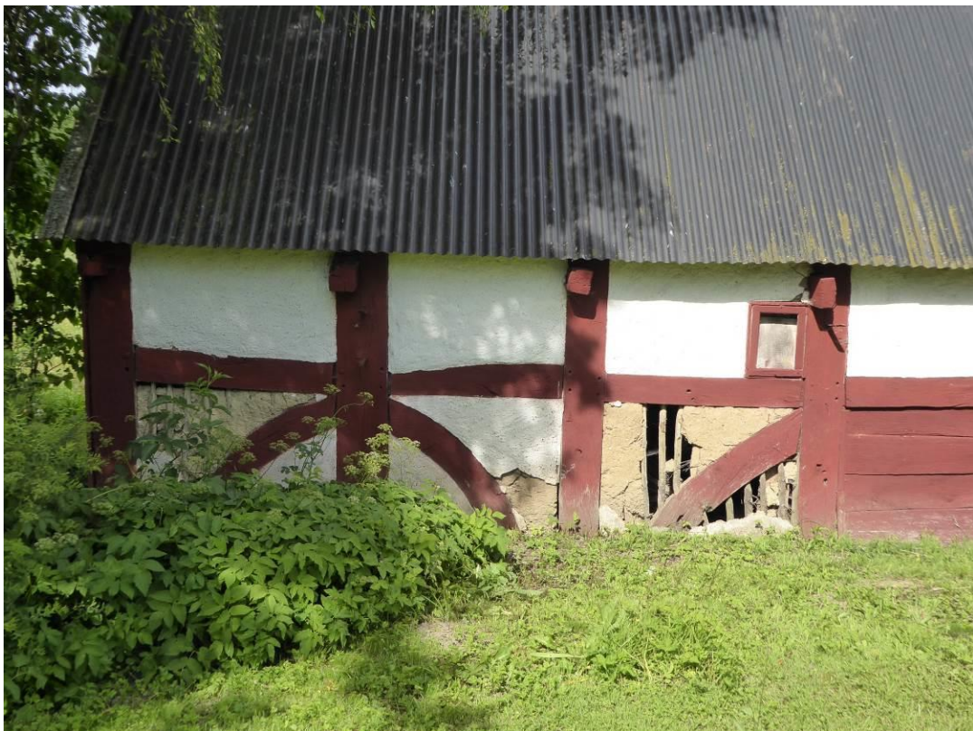
Figur 26. Före åtgärder. Västra långsidan, sidan mot bostadshuset.
