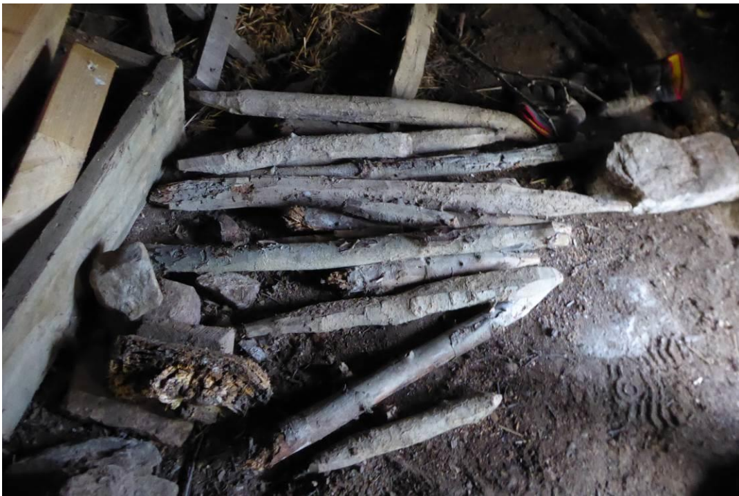
Figur 46. Nermonterade lerstakar i smedjan.
