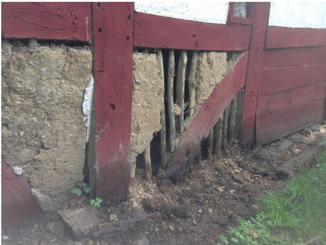
Figur 44. Smedjan, lerklinefack på västra långsidan monterades ner.
