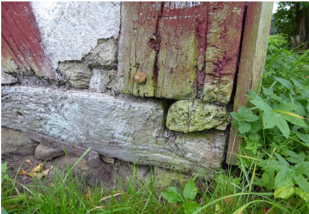
Figur 33. I det motstående hörnet på smedjan kunde man studera hur syllar och stolpar är sammanfogade, den del som bilden visar har inte bytts utan visar endast den konstruktionstyp som kopierades till det skadade nordvästra hörnet.
