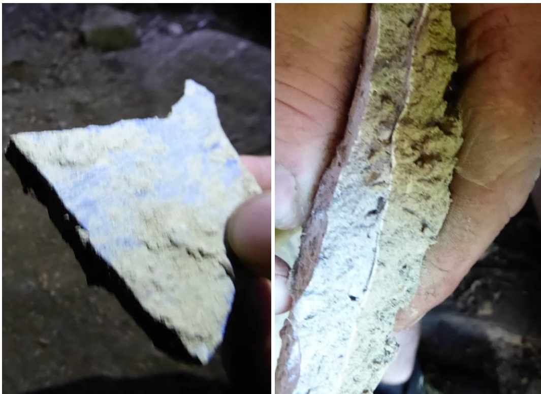
Figur 35. Vänster: Invändigt hittades fragment av blåaktig färg på kline. Bitar sparades och vissa bitar kommer att låta följa med i den nya lerblandningen. Höger: Till vänster i bild ett sentida puts-lager av något hårdare puts som kalkats. Till vänster i bild lerputs och det mellanliggande vita lagret är vit kalk struken direkt på leran.
