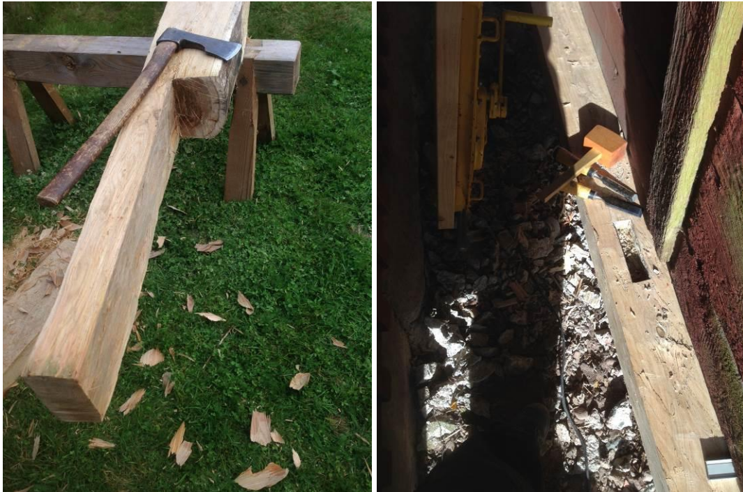
Figur 20. Under arbete. Vänster: Den nya syllen med skarv som ska ifogas halvt i halvt med dubb. Höger hål för stolpens tapp.
