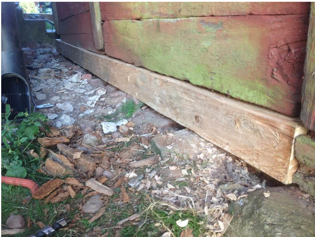
Figur 21. Efter åtgärder. Syllen är ersatt, en dubb som fäster skarven som är utförd halvt i halvt syns som ett lite mörkare runt fält.
