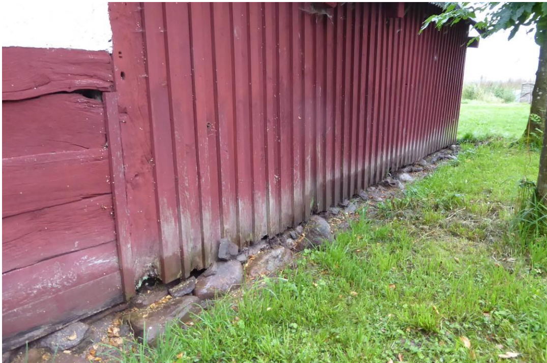
Figur 34. Under arbete. Jord som dolde syll och grundstenar är borttagen.
