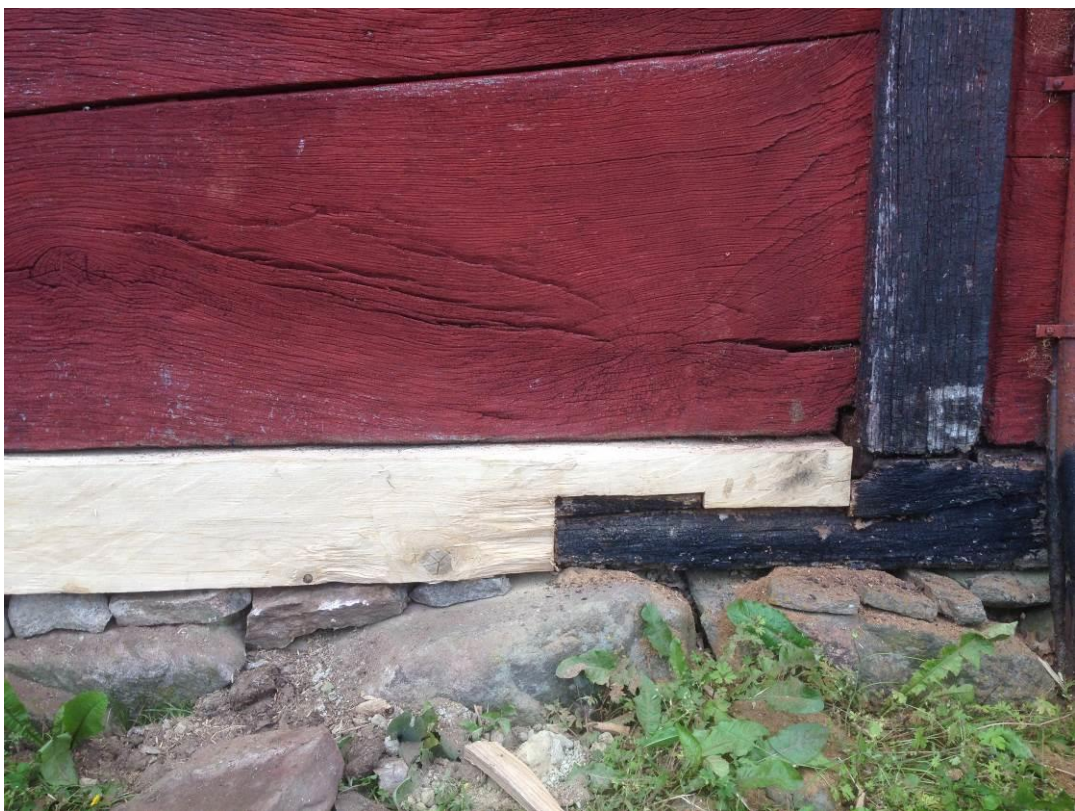
Figur 11. Efter åtgärder. Ny skarv är utförda lika befintliga äldre, sydöstra delen.
