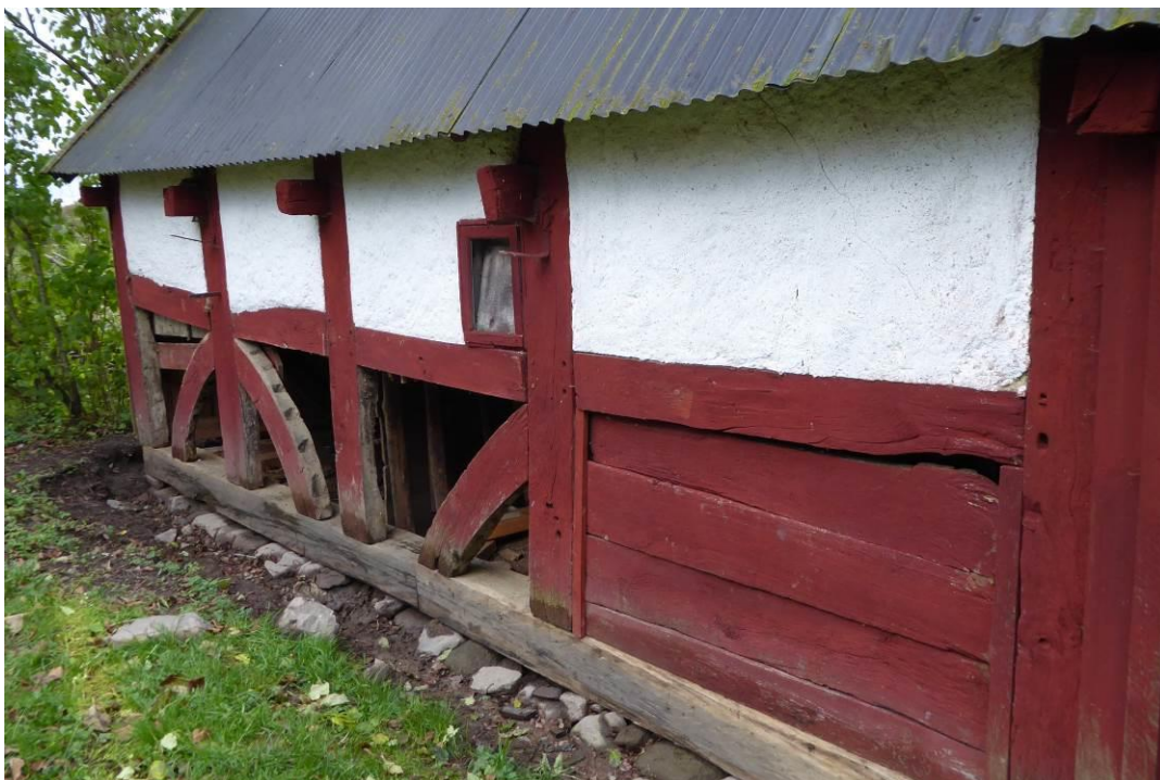
Figur 36. Efter åtgärder. Västra långsidan med bytt syll.
