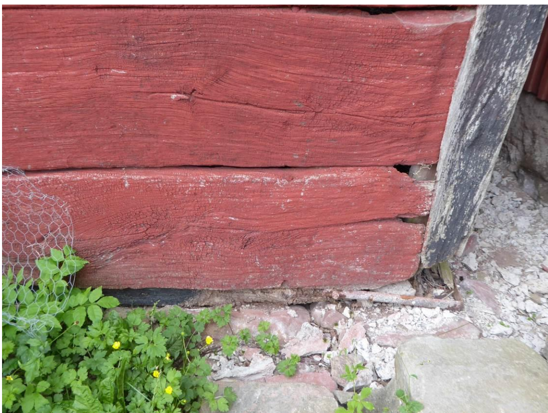
Figur 6. Före åtgärder. Nordöstra hörnet och hörnstolpen som ansluter mot norra gavelfasaden.
