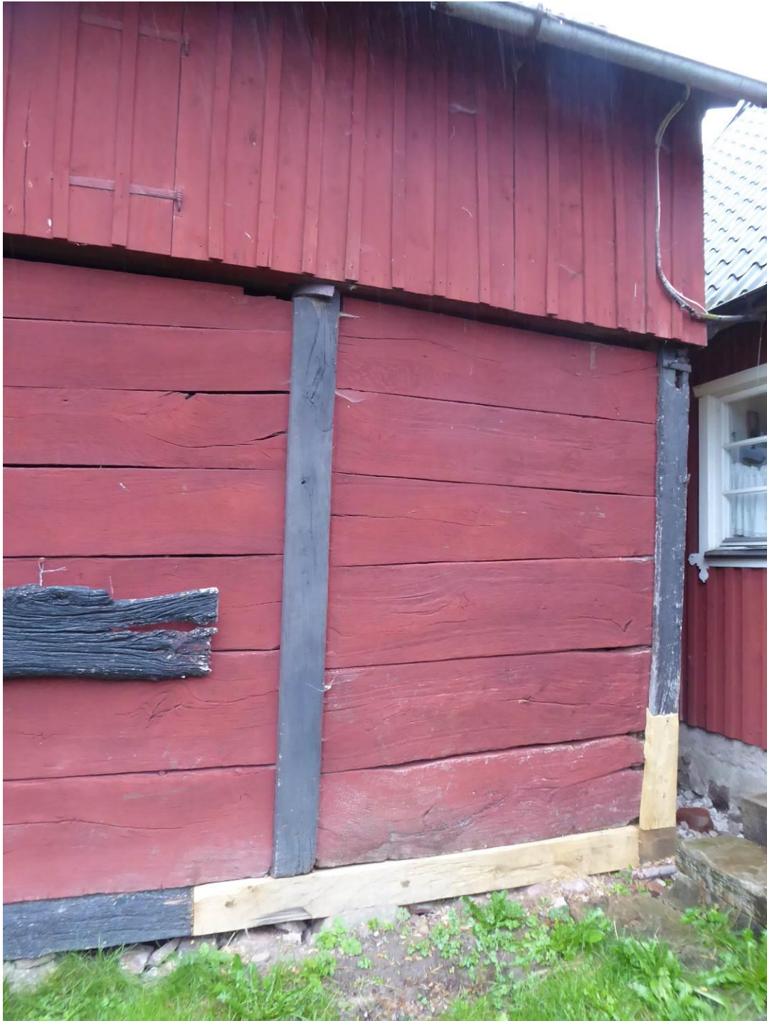
Figur 15. Efter åtgärder. Nordöstra hörnet. Syllen är lagad halvt i halvt och fäst med snett uppåt infästa dymlingar vilka syns som något mörkare små runda fält.
