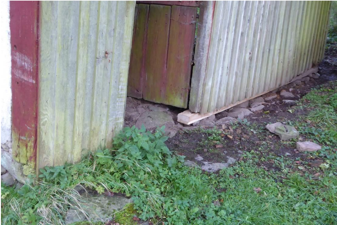
Figur 38. Efter åtgärder. Norra gavelfasaden med bytt syll.
