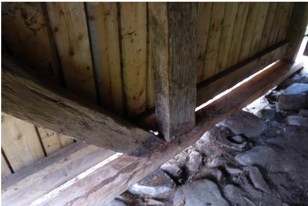
Figur 41-42. Efter åtgärder. Invändigt i smedjan efter syllbyte. Västra långsidan och norra gavelfasaden.
