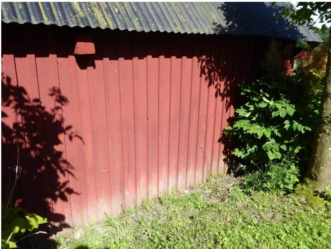
Figur 28. Före åtgärder. Västra långsidan, sidan mot bostadshuset.
