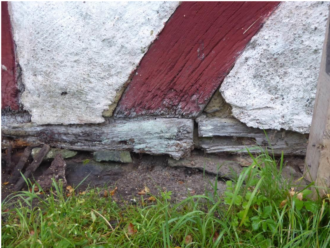
Figur 32. På motstående långsida, östra fasaden, kunde man se hur syllar i långsidan är sammanfogade, med not och tapp. Den del som bilden visar har inte bytts utan visar endast den konstruktionstyp som kopierades till den aktuella västra fasaden.
