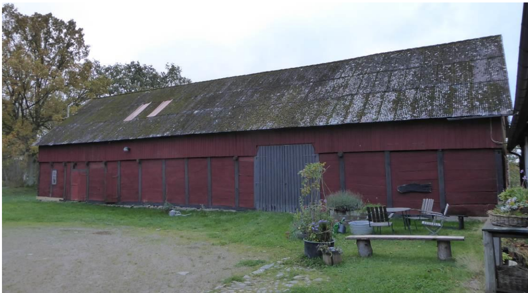
Figur 17. Ladugården efter åtgärder.
