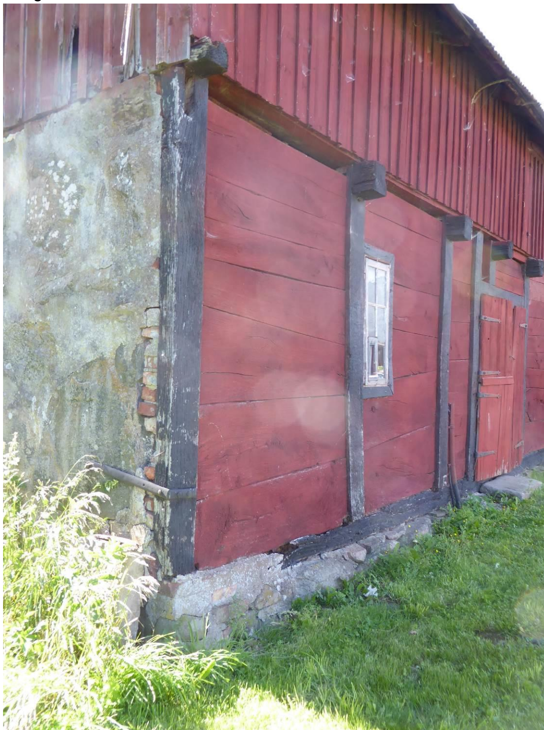
Figur 4. Före åtgärder. Fasad mot gården, sydöstra hörnet.
