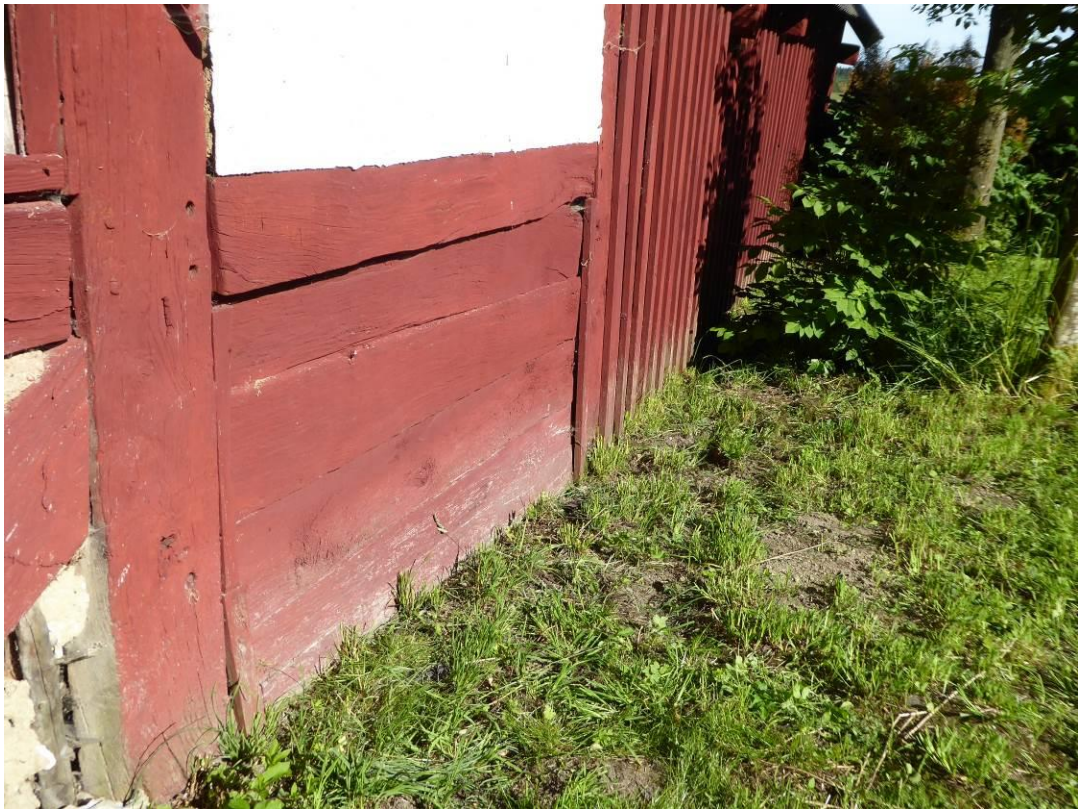
Figur 27. Före åtgärder. Västra långsidan, sidan mot bostadshuset.
