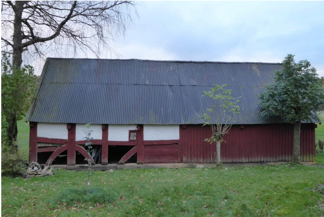
Figur 40. Efter åtgärder, västra fasaden.
