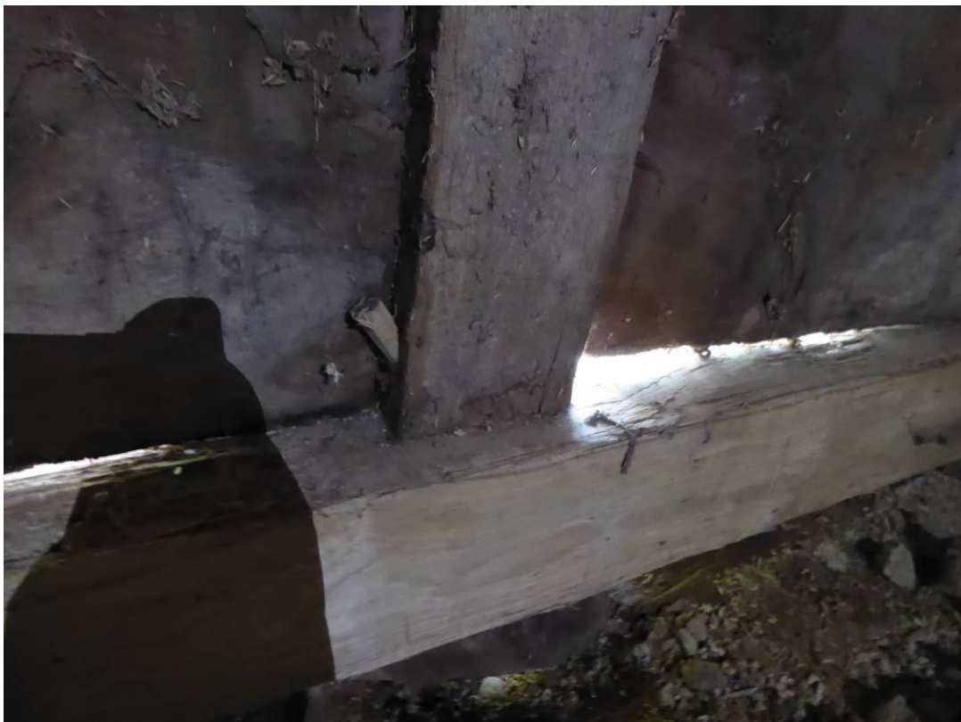
Figur 9. Efter åtgärder. Stolparna är på insidan fäst med dymling i syllen.
