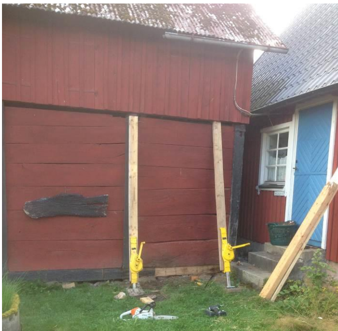
Figur 14. Under arbete. Yttre delen av syllen är borttagen för att lagas halvt i halvt.
