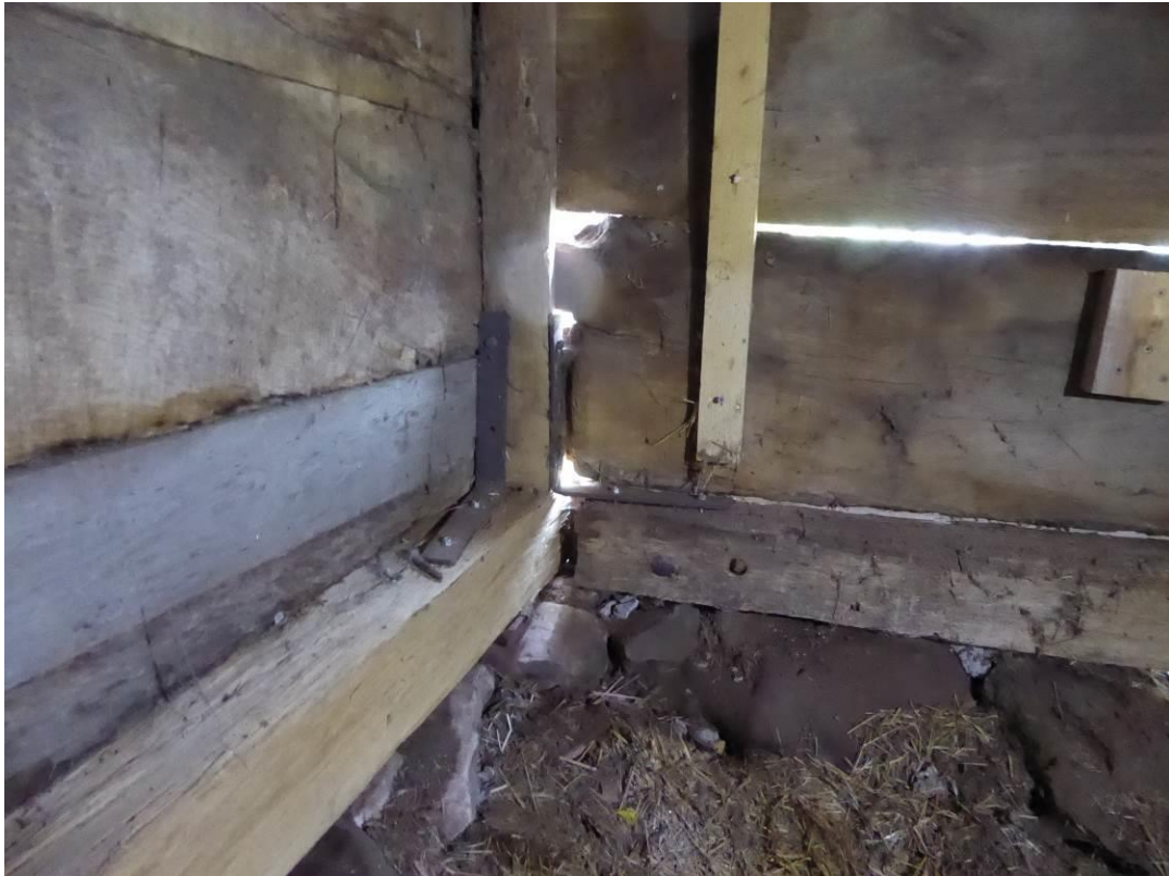
Figur 16. Efter åtgärder. Till vänster i bild gavelfasaden med ny syll. Till höger i bild längsidans syll som är lagad halvt i halvt. Hörnstolpen var före åtgärderna förankrad med järn, järnen har behållits.
