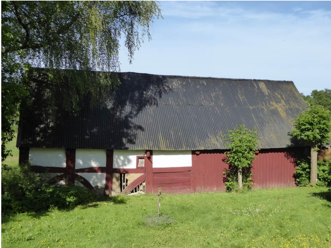
Figur 25. Före åtgärder. Västra långsidan, sidan mot bostadshuset.
