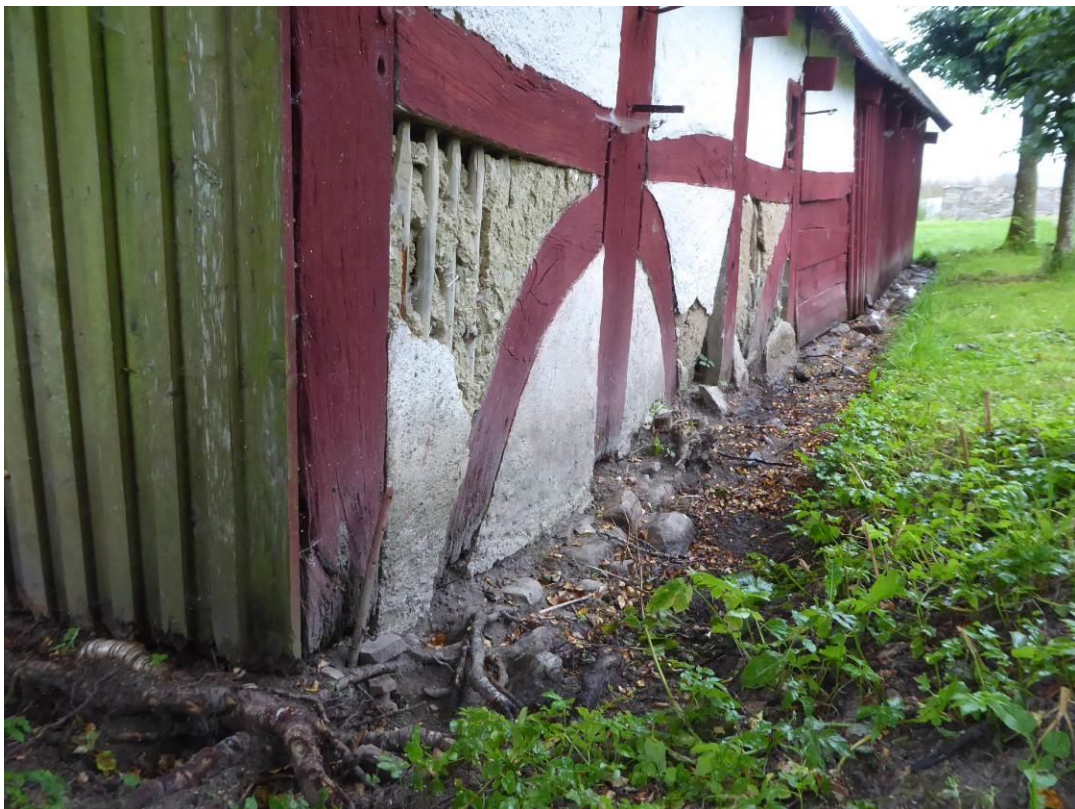
Figur 31. Under arbete. Jord som dolde syll och grundstenar är borttagen.
