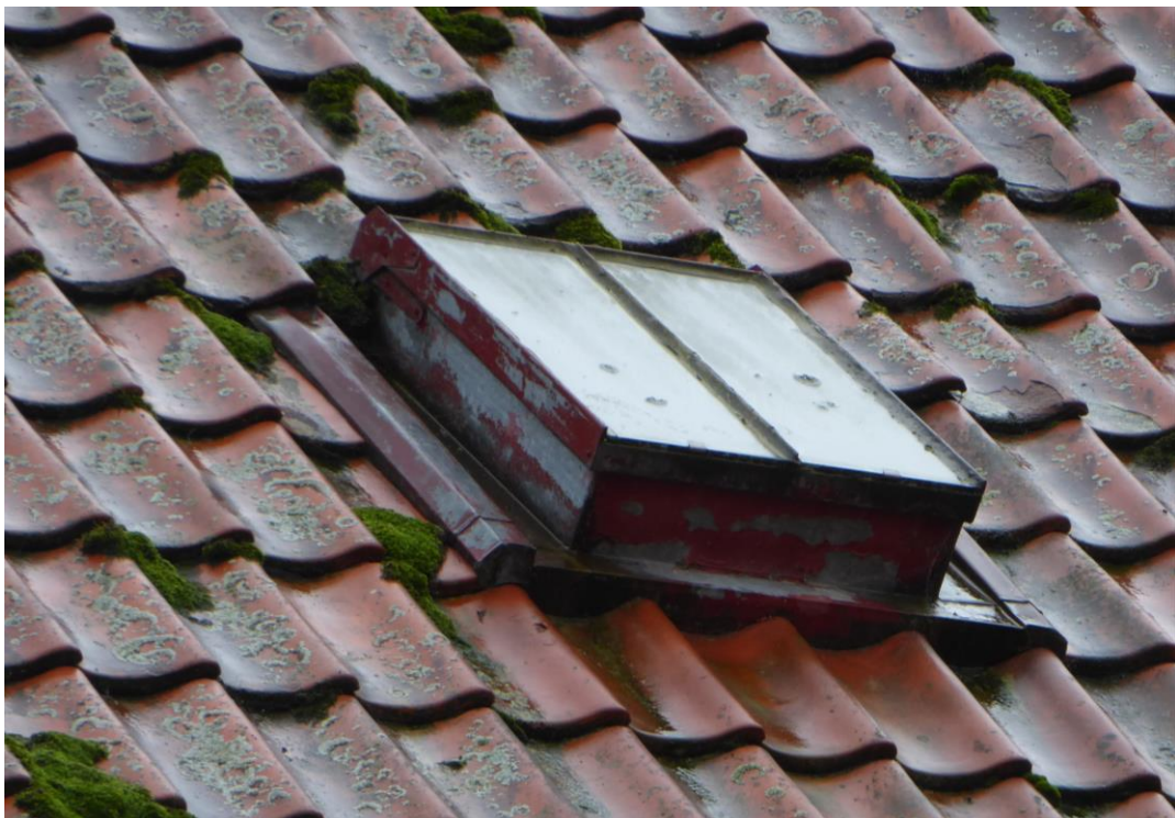
Före åtgärder. Plåtfönster.
