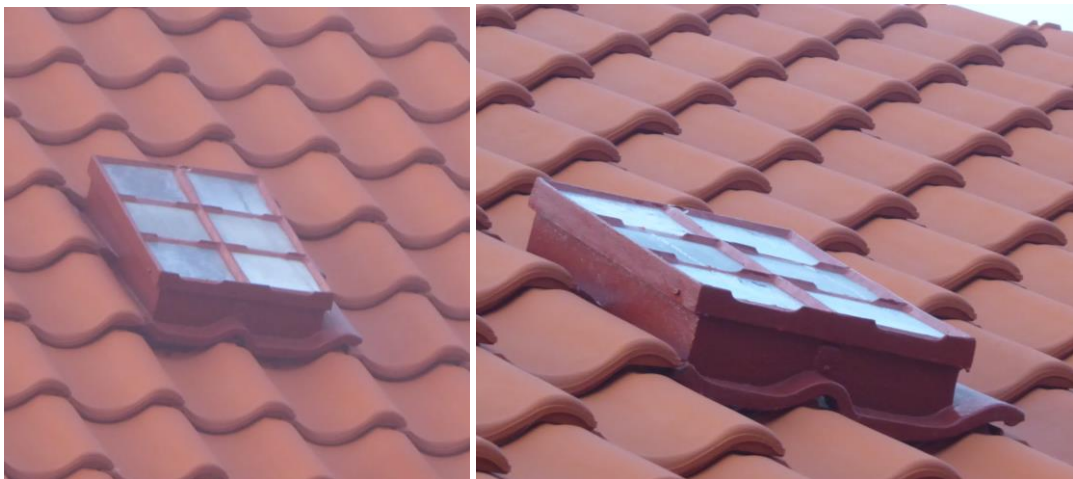
Takfönster efter åtgärder, återmonterade på taket.
