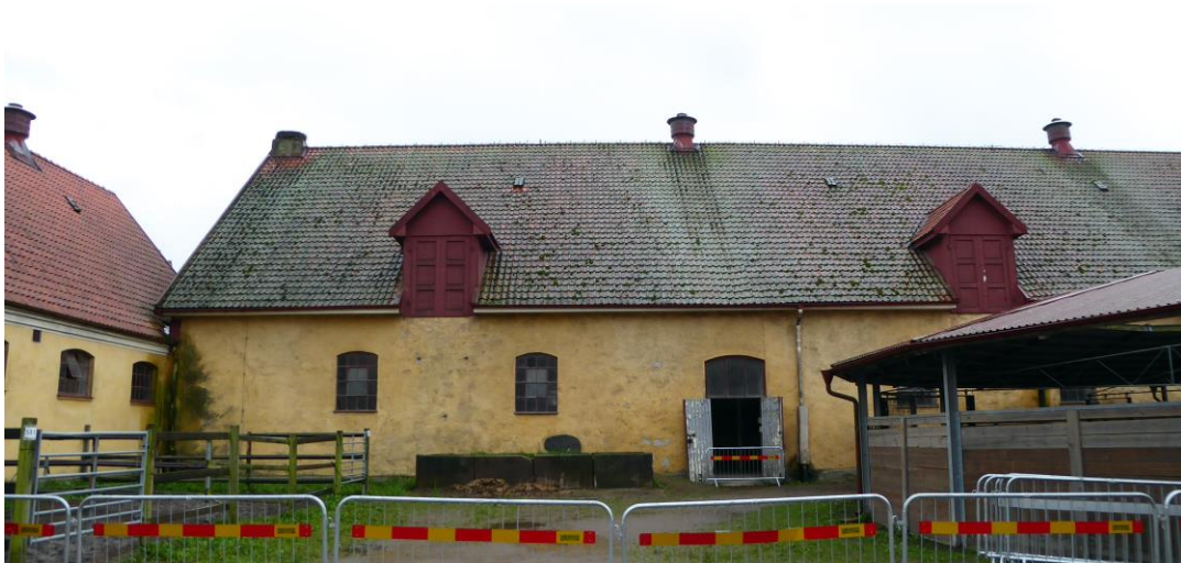
Före åtgärder. Östra delen av det aktuella takfallet.
