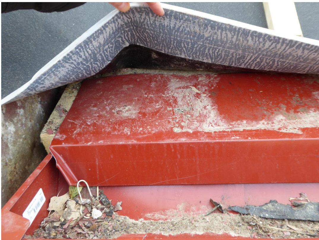
Under arbete. Lagad panel, ny papp, fotplåt och hängränna.
