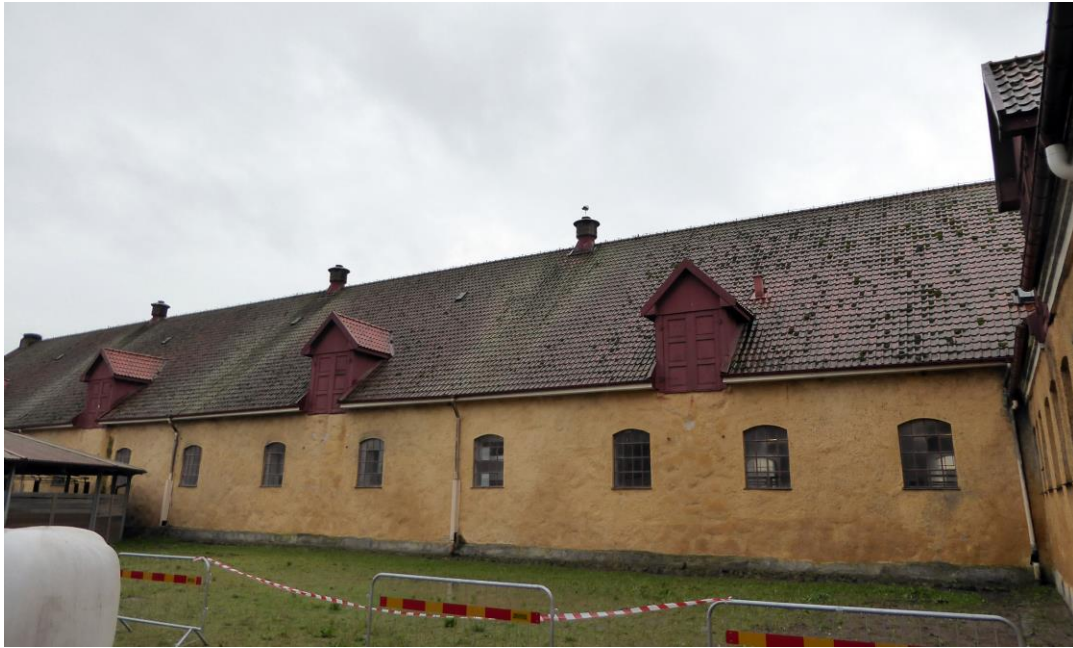
Före åtgärder. Västra delen av det aktuella takfallet.
