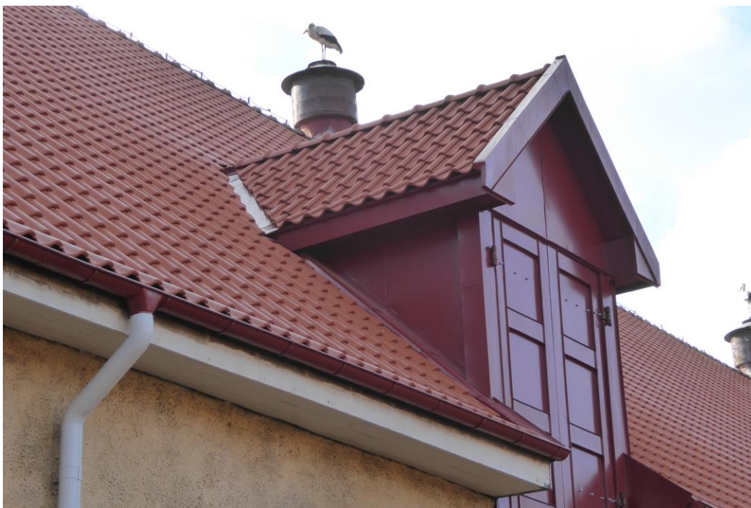
Efter åtgärder. Takluckor. Återstår att måla bultarna i samma färgnyans som plåten när temperaturen tillåter.
