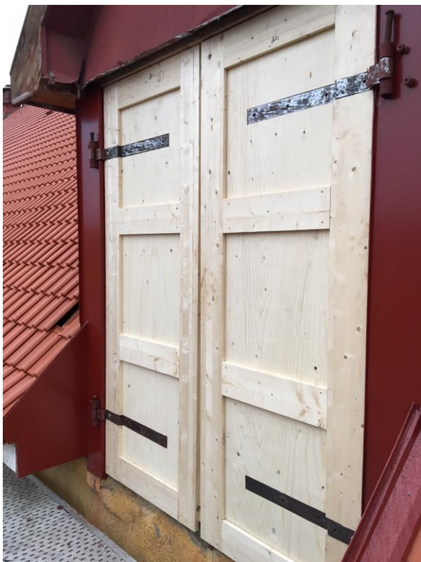
Under arbete. En av två nytillverkade portar med återanvända bandgångjärn.
