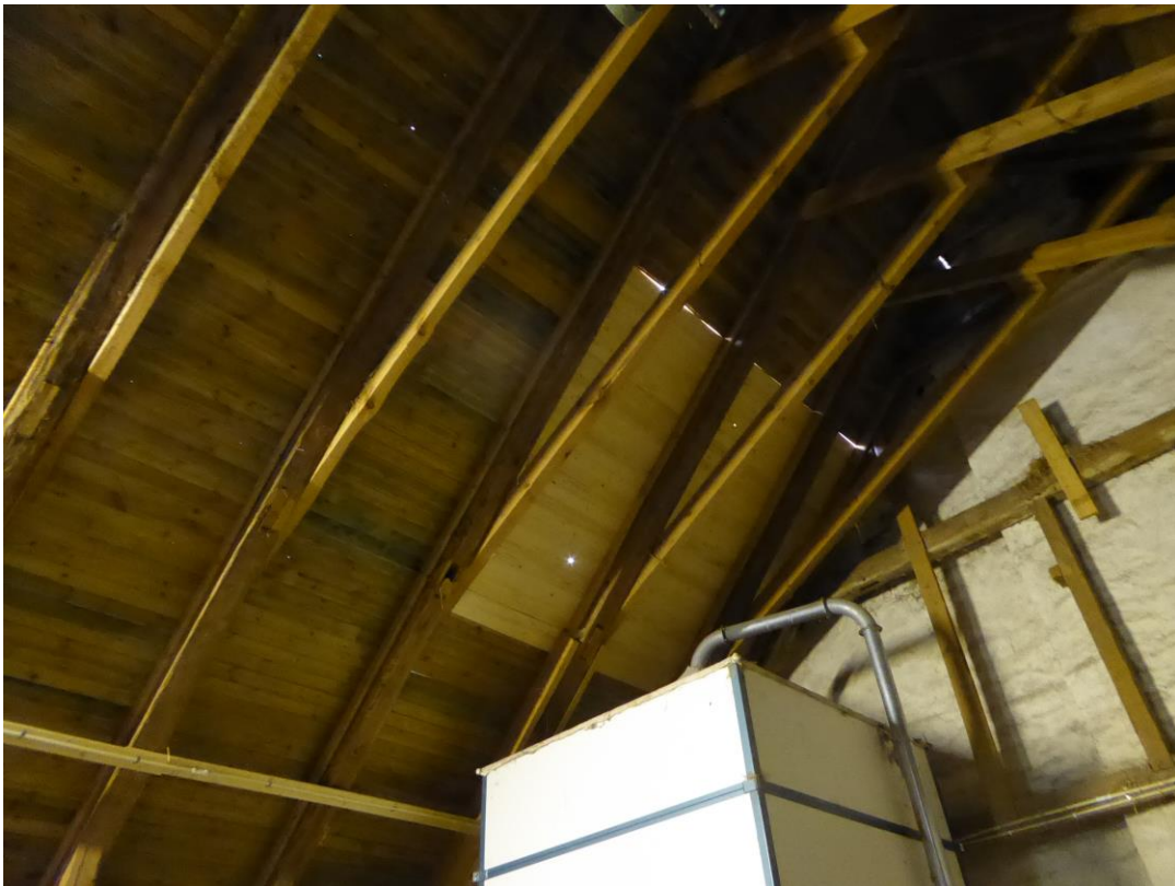
Panelen är lagad (det ljusare fältet av panelen är ny) på en något större yta längst i öster.
