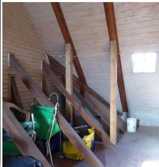
Vänster före åtgärder: Takstolar i väster vars stödben vid tidigare tillfälle hade tagits bort. Höger efter åtgärder: Två takstolar i väster har förstärkts med nytt stödben.
