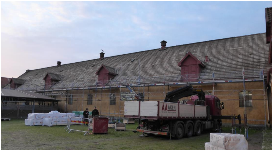
Under arbete. Takpannor och storkbo är nertaget.
