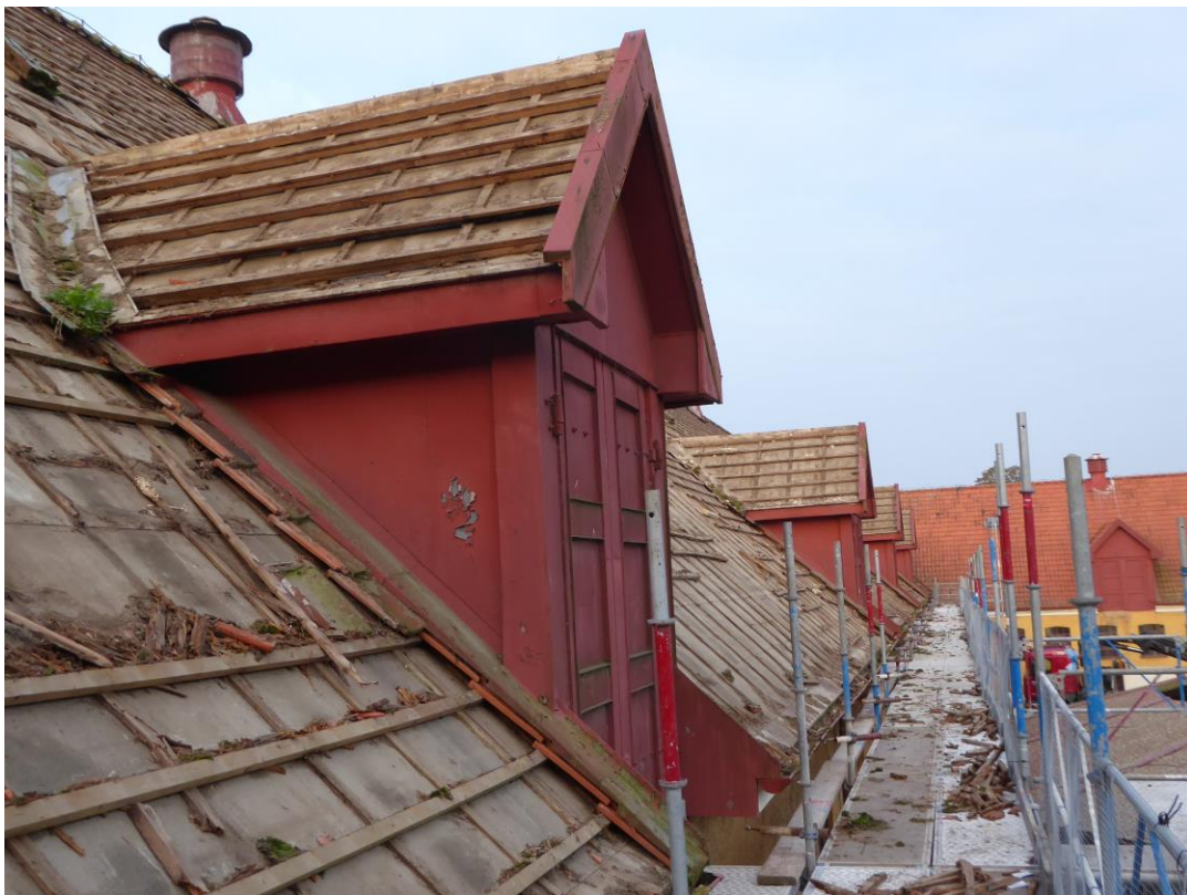
Under arbete. Takpannor är borttagna. På bilden ser man den gamla pappen, läkten och plåten på takkupor och ventilationskuporna.
