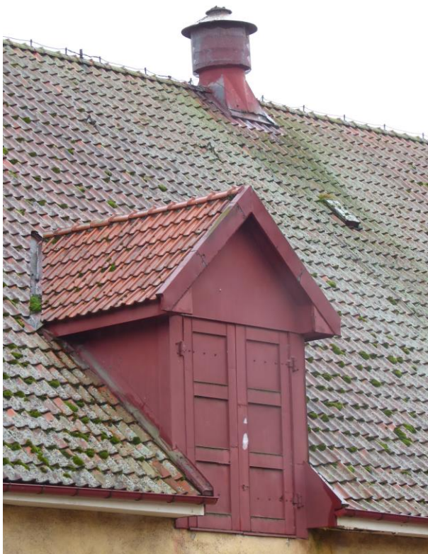
Före åtgärder. Vänster: En av takluckorna och ett av fem takfönster i gjutjärn med sex glasrutor samt en ventilationshuv inock. Höger: Port i lucka sett från insidan.
