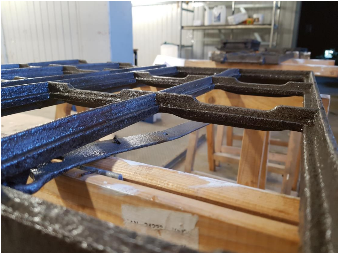
Takfönster under arbete. Nedmonterade och efter blästring och grundning.
