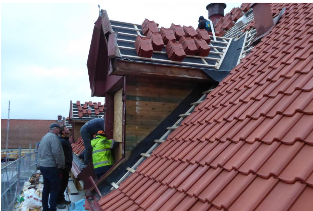
Under arbete. Plåt på luckorna och portarna är nermonterade.
