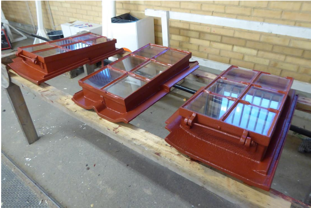
Takfönster efter åtgärder.
