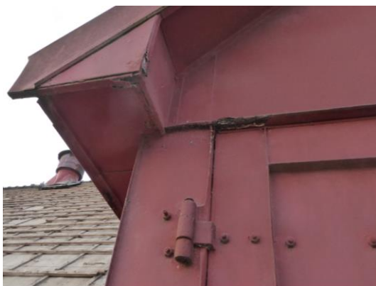
Under arbete. Exempel på kraftiga skador i plåten på takkuporna.
