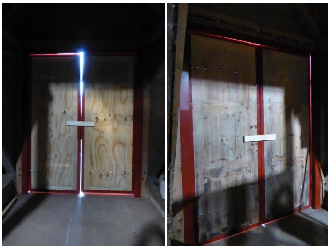
Efter åtgärder. Vänster: en av de två nytillverkade portarna. Höger: en av två bevarade äldre träportar.
