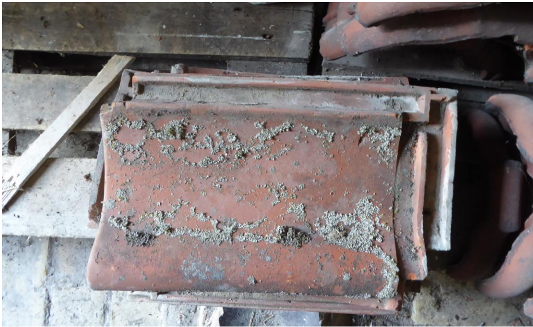
Takpannetyperna som monterades ner och inte återmonterades.
