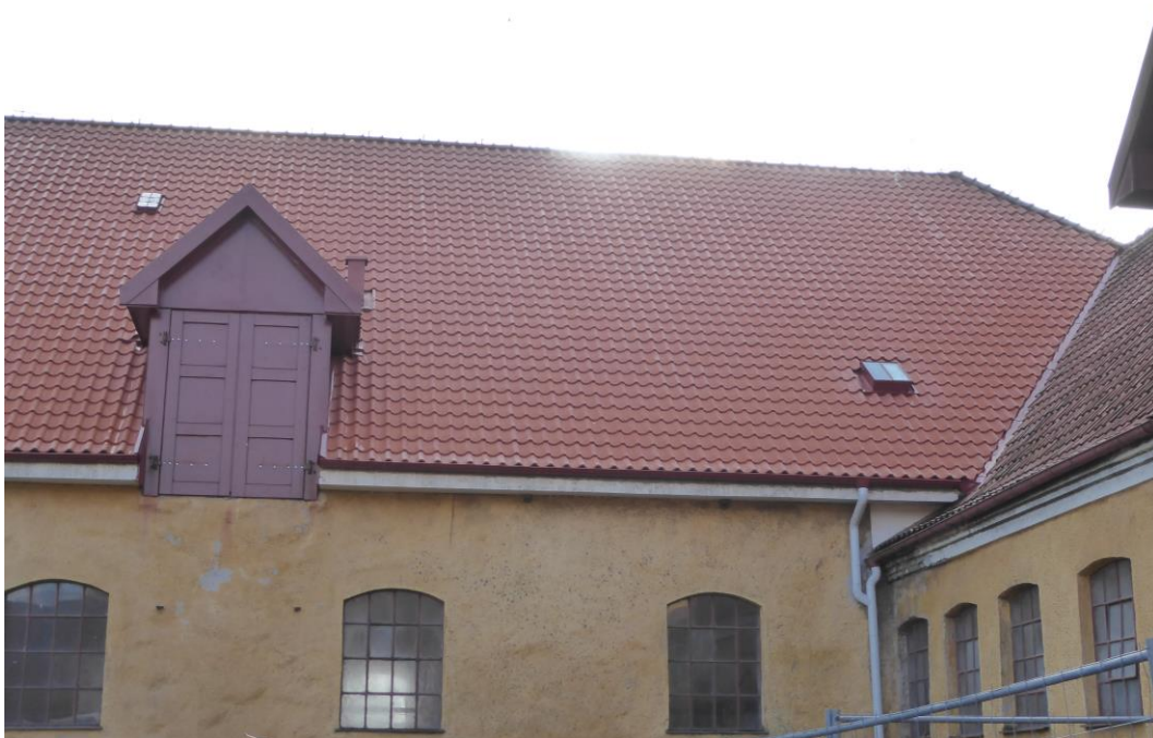
Efter åtgärder. Västra delen av takfallet med ett gjutjärnsfönster till vänster i bild och plåtfönster till höger i bild på takfallet.
