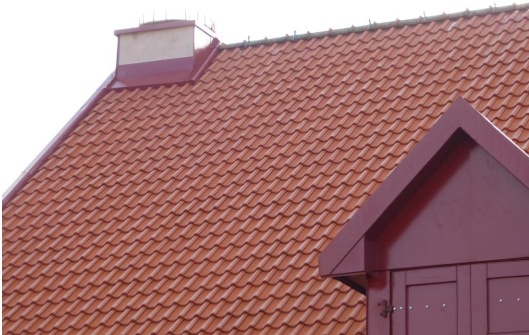
Efter åtgärder. Östra delen av takfallet med storkbo.
