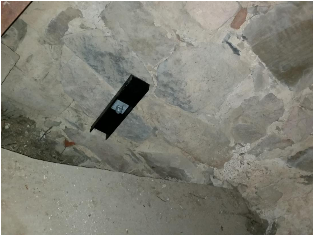
Efter åtgärder. Infästning genom tornet, här invändigt i tornet.
