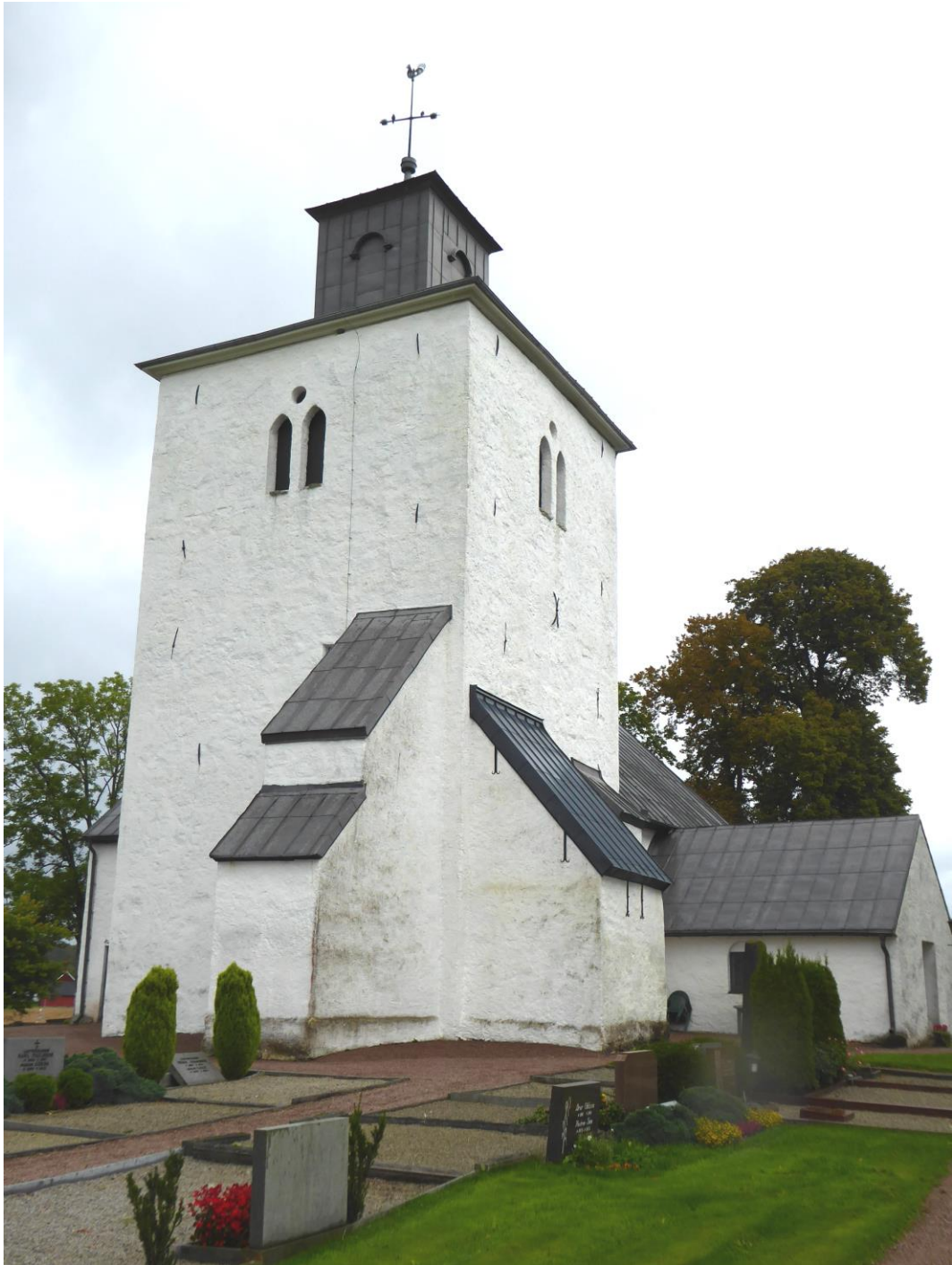
Efter åtgärder. Hallaröds kyrka sedd från sydväst.
