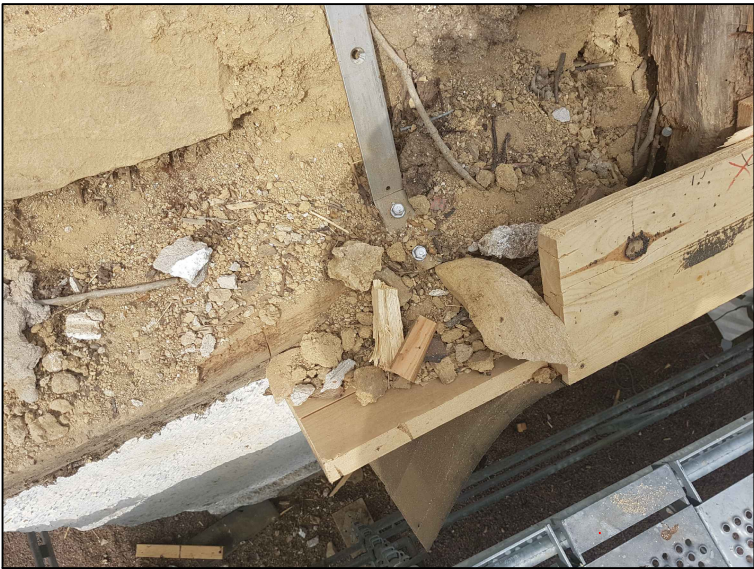
Infästning rostfria järn - vid takfot
