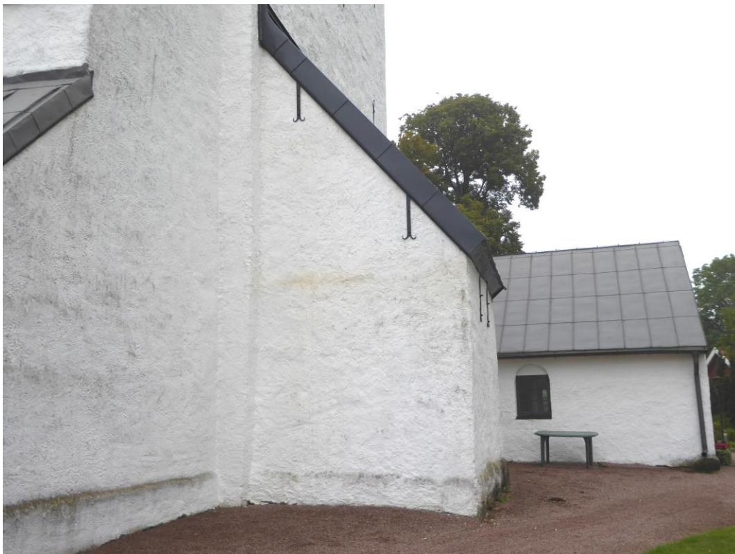
Efter åtgärder. Aktuell strävpelare sedd från sydväst.
