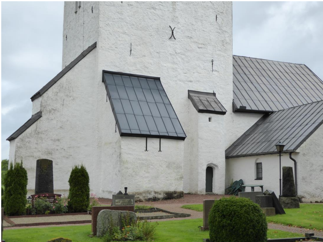
Efter åtgärder. Aktuell strävpelare sedd från söder.
