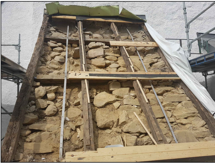
Rostfria järn - takfot till topp
