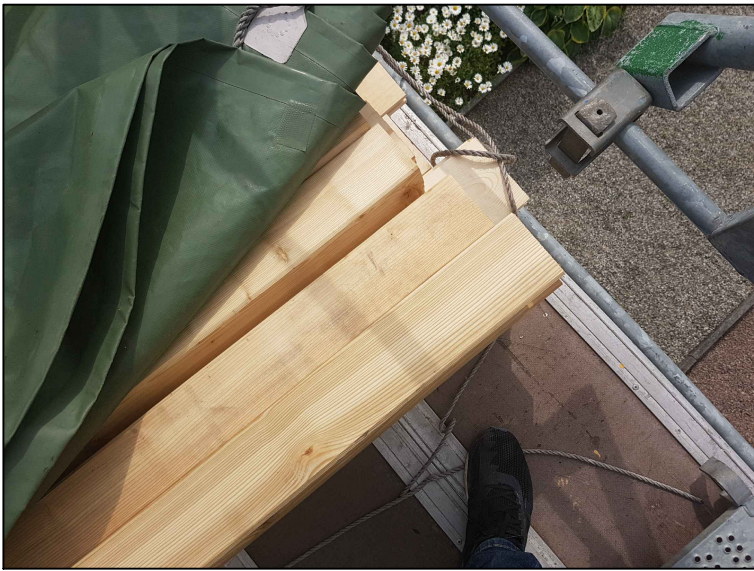
195x95 lärkstolpar, läggs vardera sida om högben. Skruvas ihopa för samverkan
