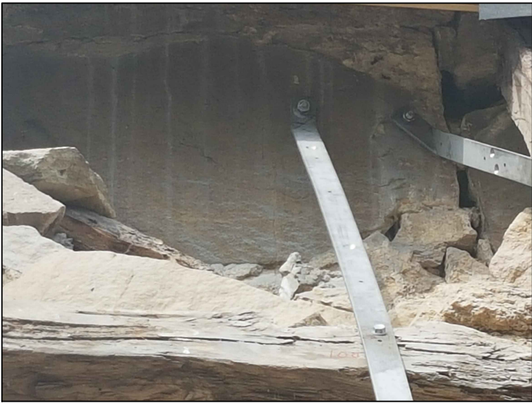
Infästning rostfria järn i kyrkmur - toppen
