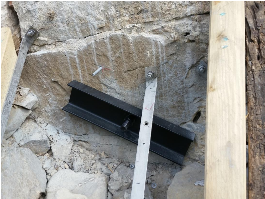
Under arbete. Infästning genom tornet, utsida döljs in strävpelaren.
