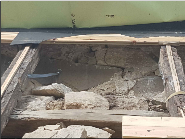
Infästning rostfria järn i kyrkmur - toppen
