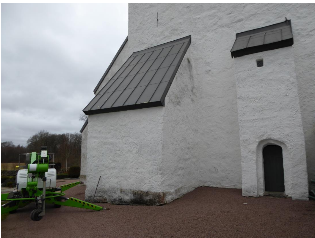
Före åtgärder. Aktuell strävpelare (den vänstra i bild) sedd från söder.
