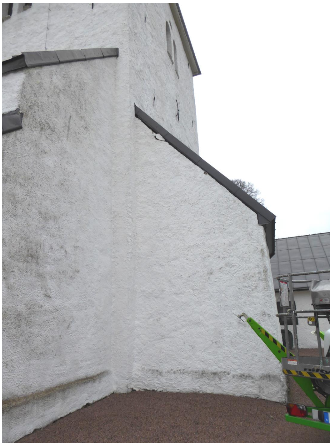
Före åtgärder. Aktuell strävpelare sedd från sydväst.
