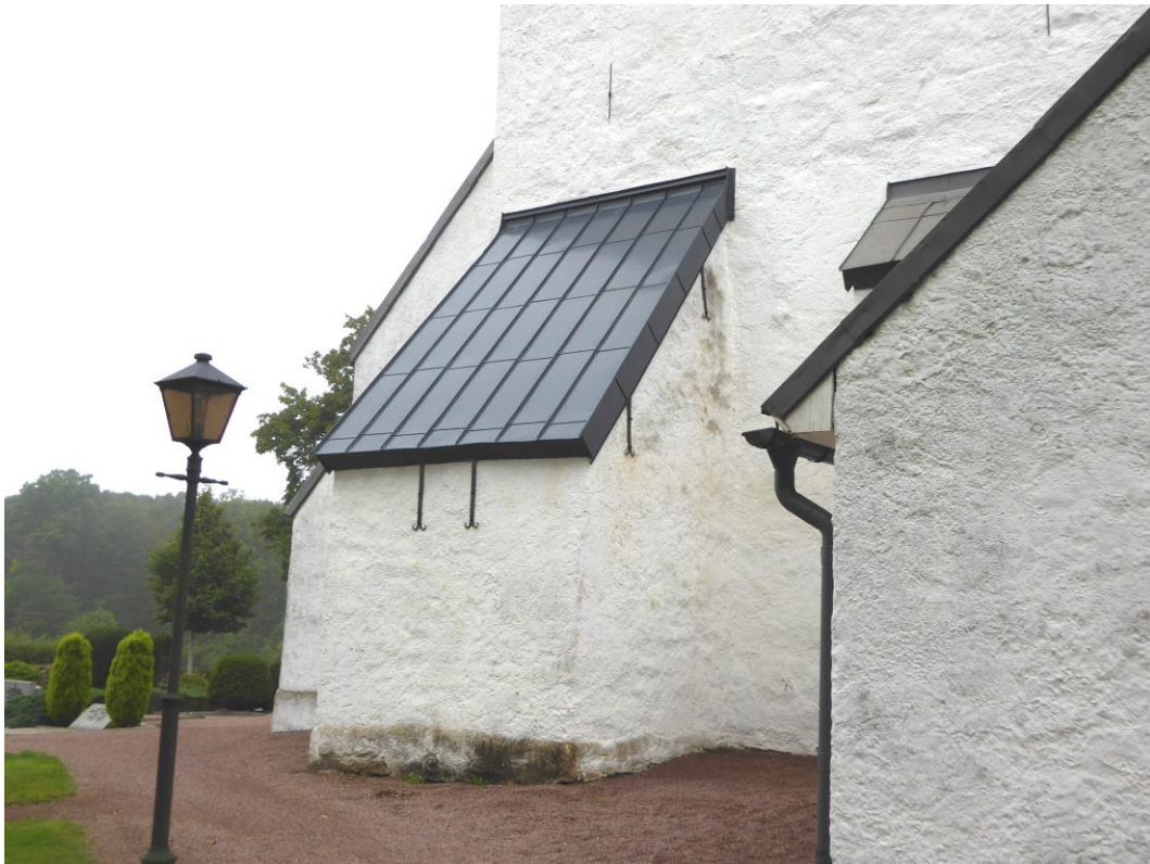
Efter åtgärder. Aktuell strävpelare sedd från söder.
