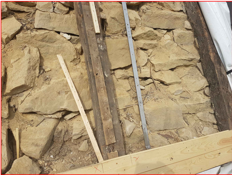
Infästning rostfria järn - vid takfot
