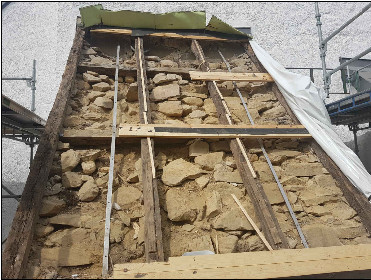
Rostfria järn - takfot till topp
