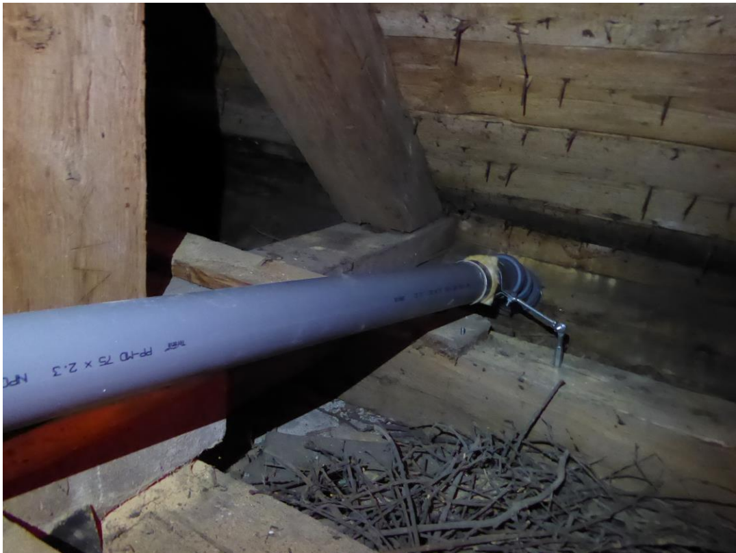
Figur 10. Efter åtgärder. Genomförning i takfot mot väster.
