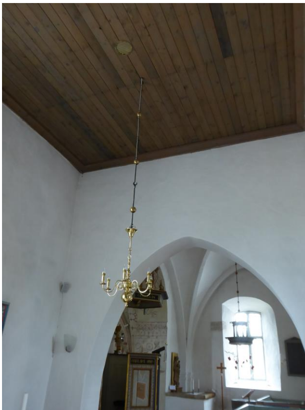
Figur 7. Efter åtgärder. Vy från nykyrkan mot långhuset. Det nya gallret i taket.
