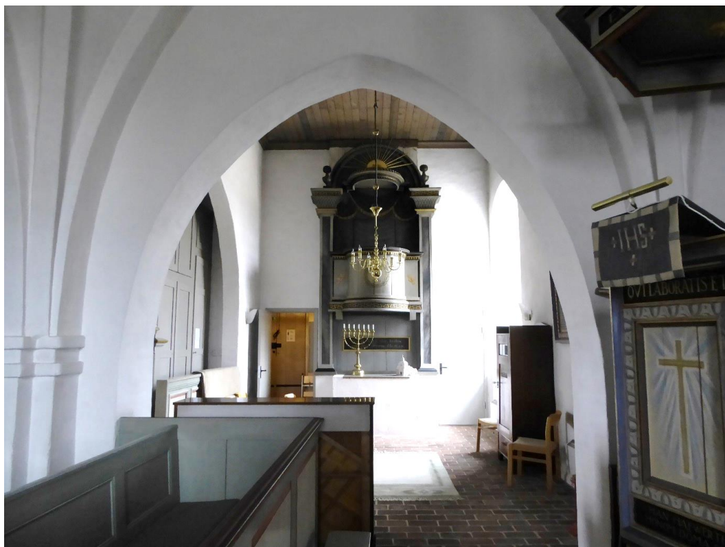
Figur 1. Före åtgärder. Vy från långhuset mot nykyrkan.
