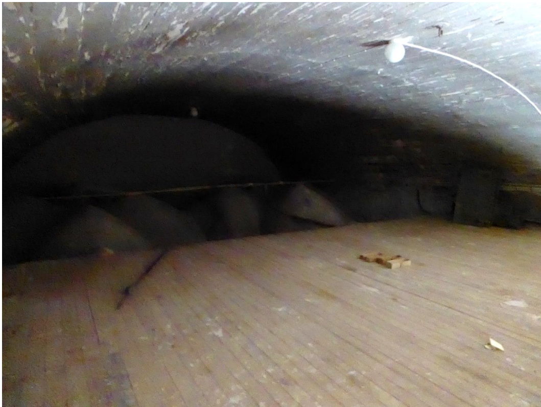
Figur 4. Före åtgärder. Tunnvalv på vinden ovan nykyrkan.
