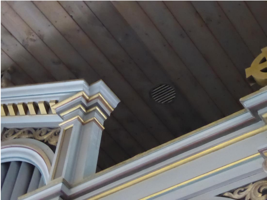
Figur 8. Efter åtgärder. Gallret i taket ovan/bakom orgeln. Gallret är inte synligt från kyrksalen.
