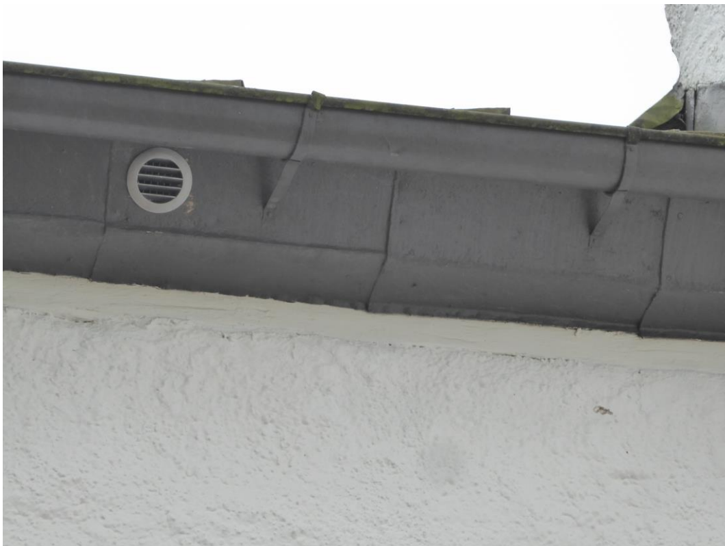
Figur 11. Efter åtgärder. Nykyrkans takfot åt väster (gallret ska målas in i takfotens färgnyans).
