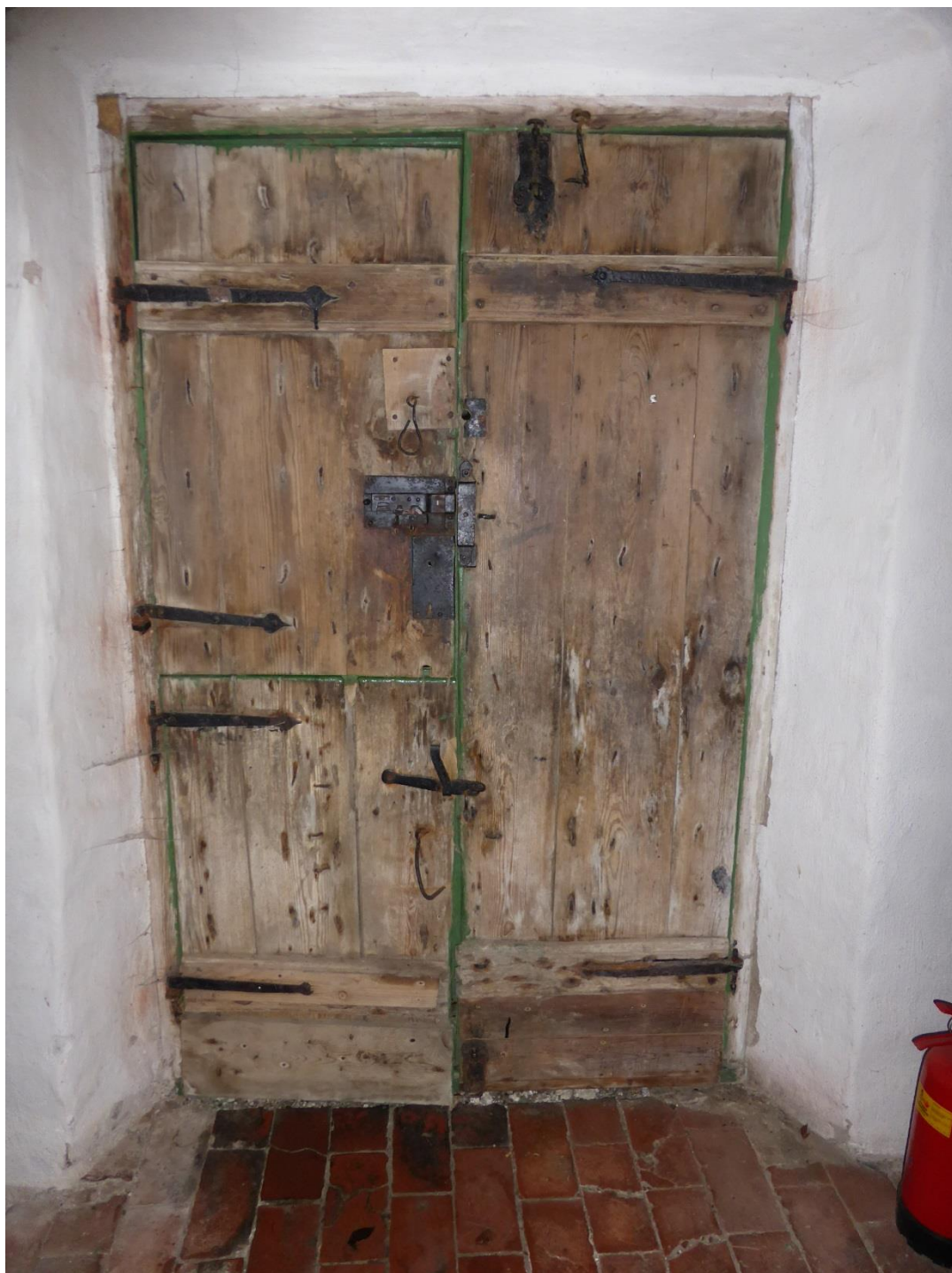
Entrédörr från insida, troligen ursprunglig, inför åtgärd.
