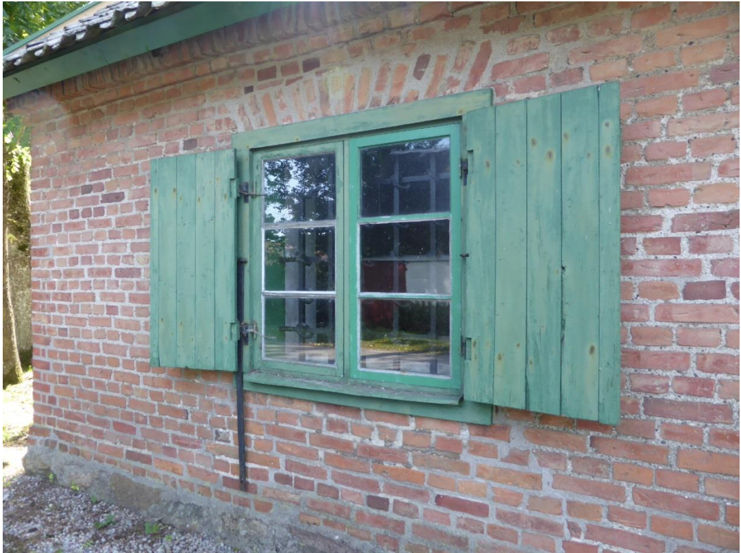
F1 norra sidans östra fönster, inför åtgärd.
