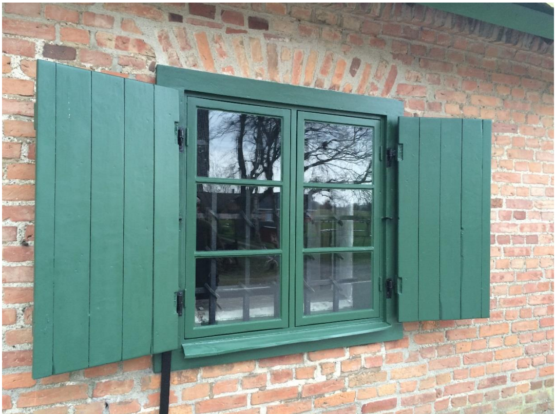
Samma fönster efter åtgärd.
