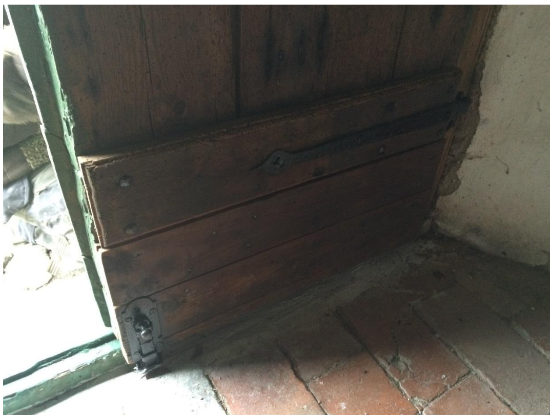
Entrédörr från insida med nytillverkat handsmitt bandgångjärn med lökformad avslutning.
