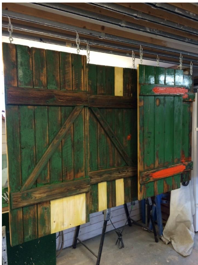
Snickerilagning av fönsterluckorna på plats i Fönsterateljén i Skåne, Hjärup.
