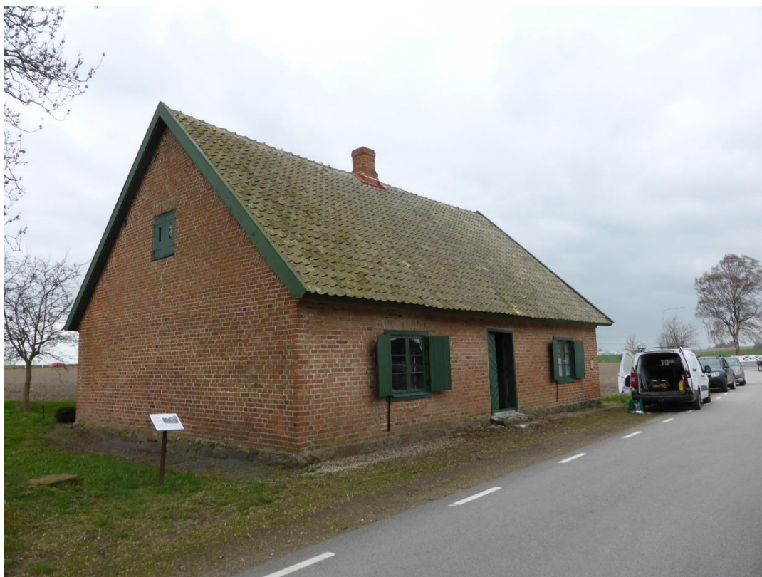
Klörups häradshäkte med nyligen restaurerat tak, dörrar och fönster.
