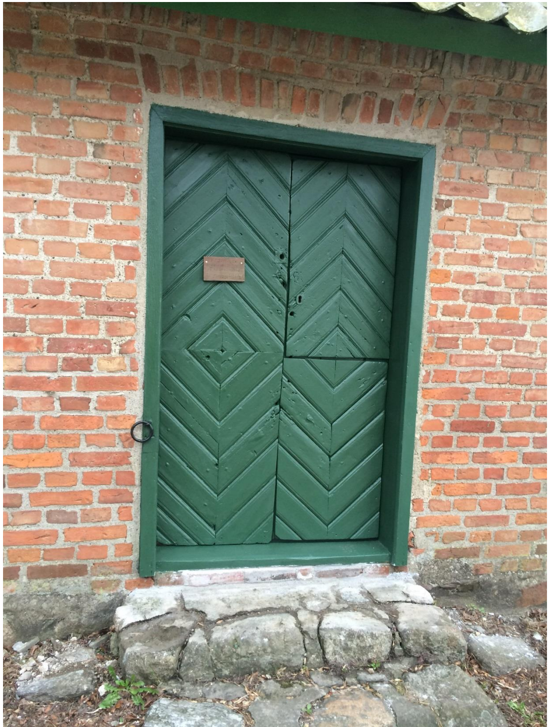
Entrédörr från utsida, efter åtgärd.
