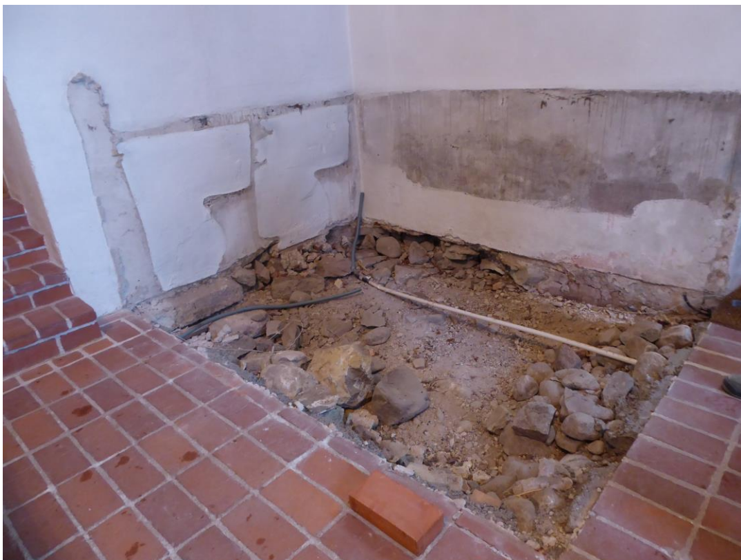
Figur 6. Under arbete, bänkar och trägolv är bortmonterat.
