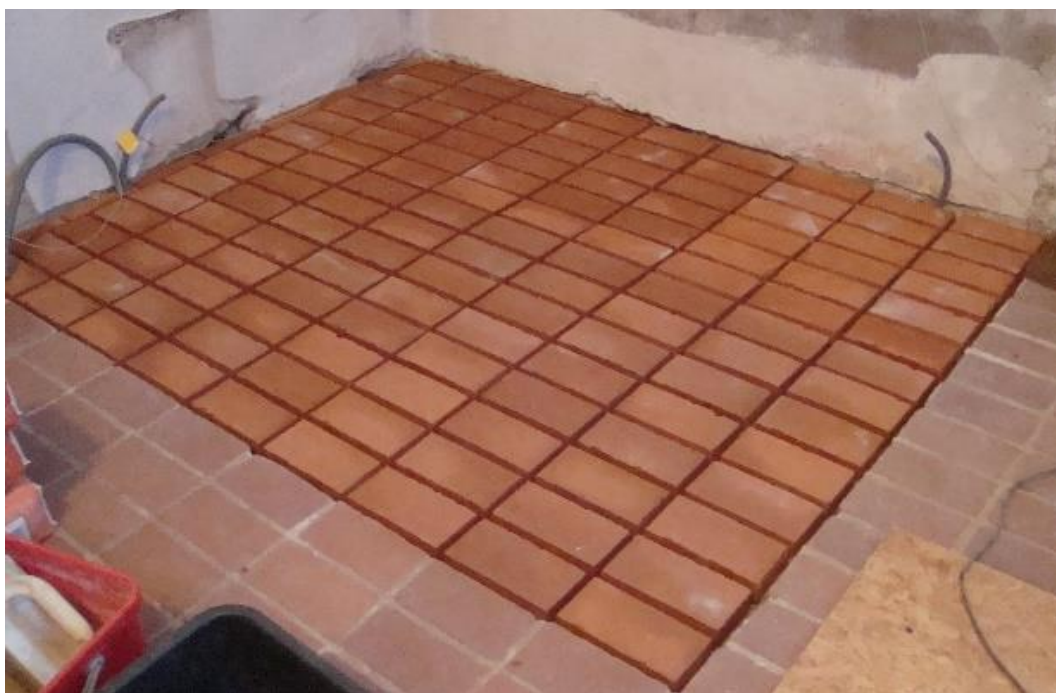
Figur 9. Under arbete. Teglet är ett marktegel som i utseende var snarlikt det befintliga golvet i kyrkan. På vänstersida sticker lagda rör för el till uppvärmning av förvaringen och eluttag för lucklyftningsanordningen. Foto: Björklidens byggnadsvård AB.
