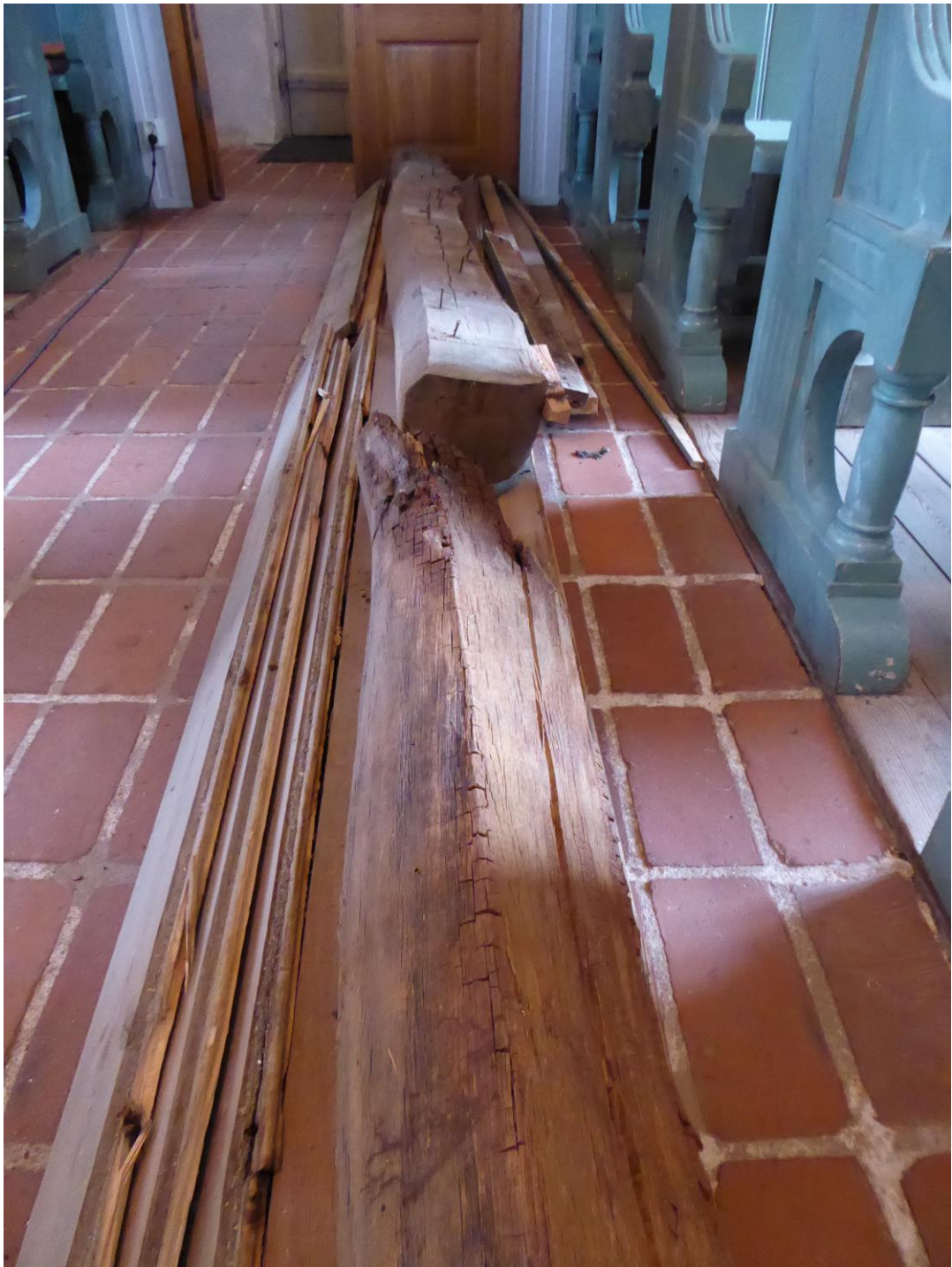
Figur 10. Under arbete. Två bortmonterade golvsjälkar och brädgolv.
