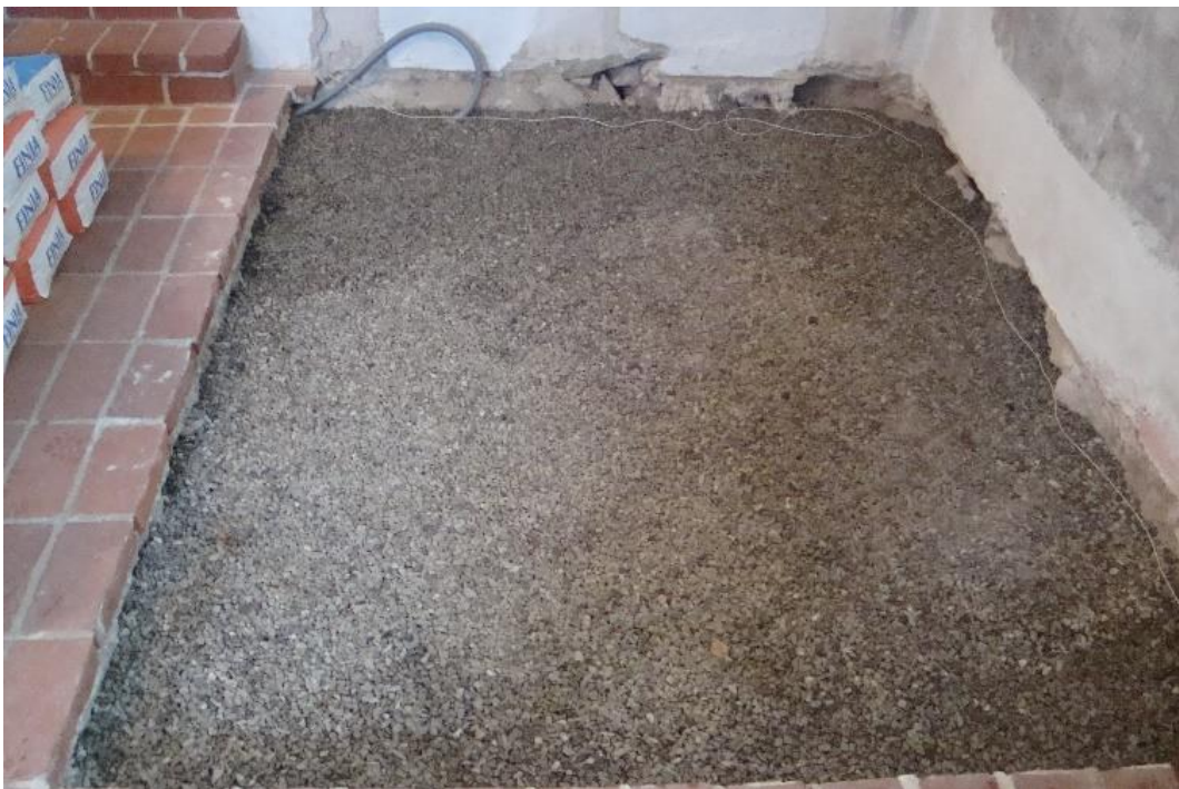
Figur 8. Under arbete. Markduk och makadam. Foto: Björklidens byggnadsvård AB.
