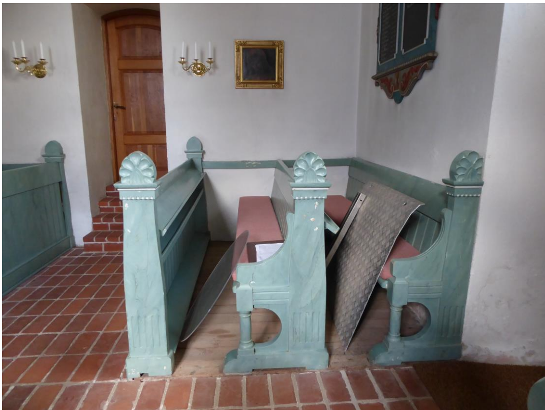
Figur 4. Före åtgärder. De berörda bänkraderna och trägolv.
