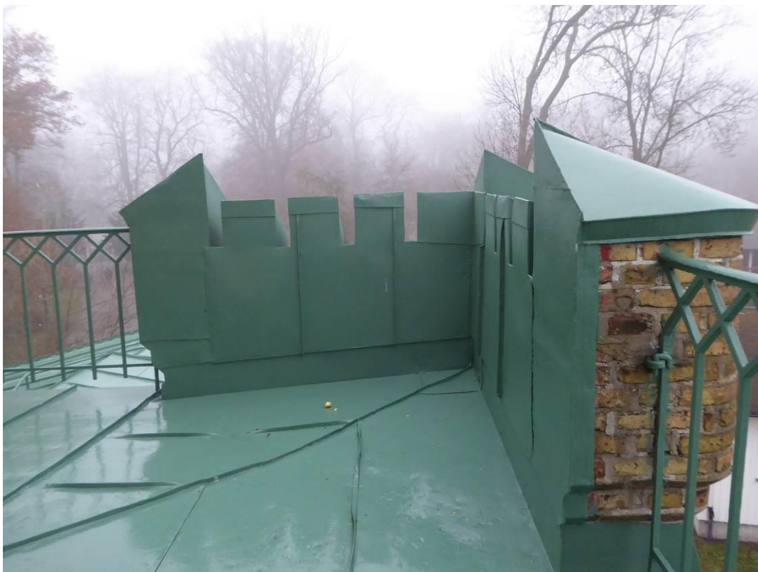
Figur 17. Efter åtgärder. Målad plåt och räcken.
