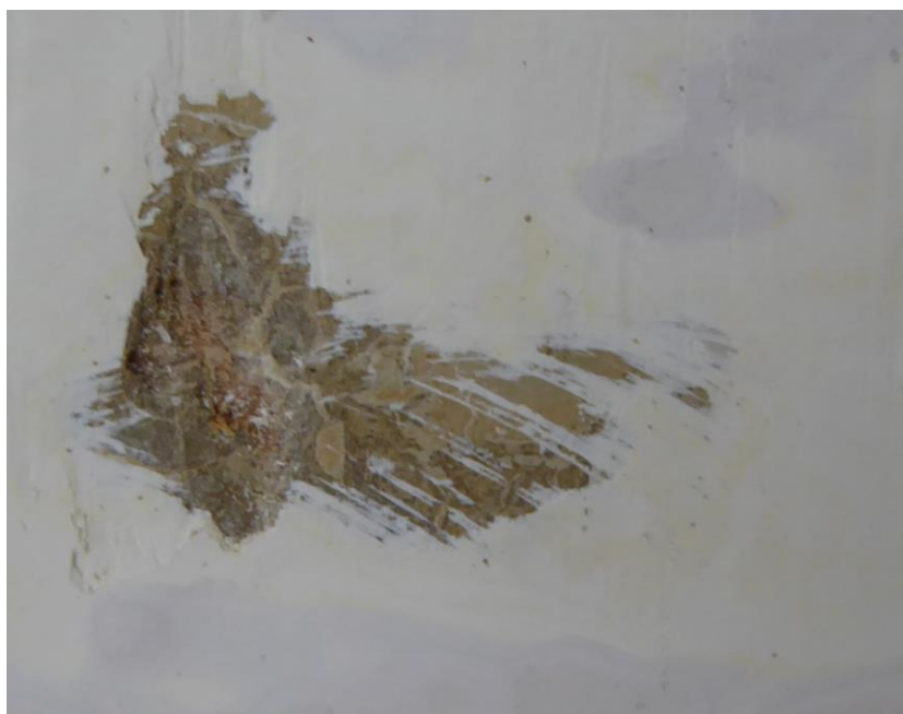
Gavelröstet äldre panel med färglager.
