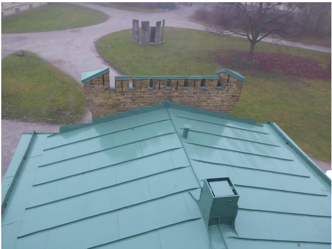
Figur 16. Efter åtgärder. Taket och detaljer är målade. Vy mot norr.
