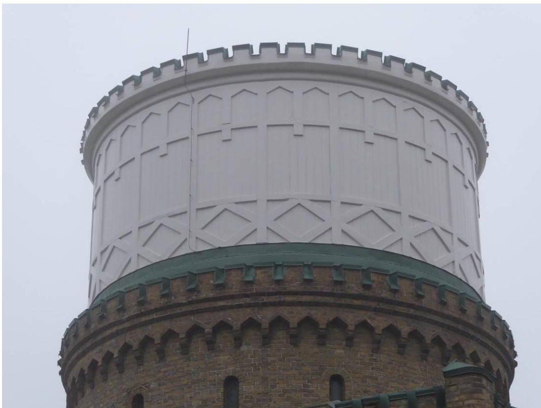
Figur 21. Tornets översta trädel mot söder med ersatta trädelar i takfot och fris.
