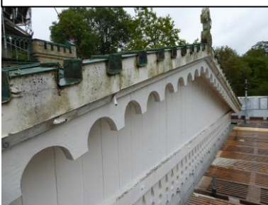
Gavelröstet äldre panel med färglager.
