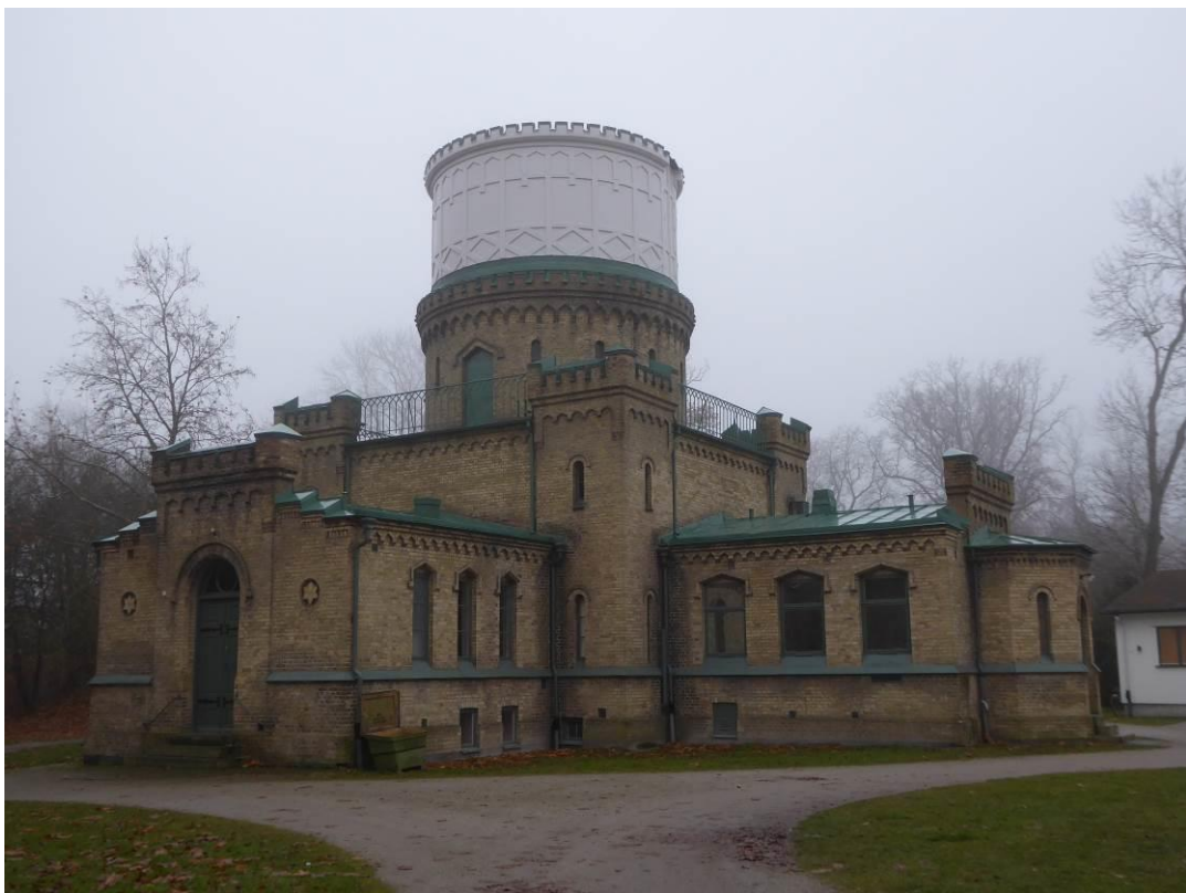
Figur 20. Efter åtgärder. Nordöstra hörnet.
