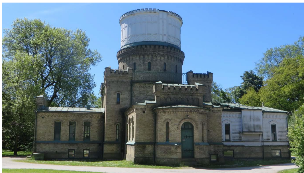
Figur 2. Före åtgärder, vy från norr.
