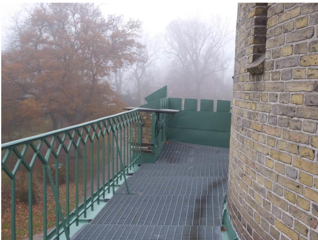
Figur 18. Efter åtgärder. Målade takdetaljer och återmonterat durkgaller.
