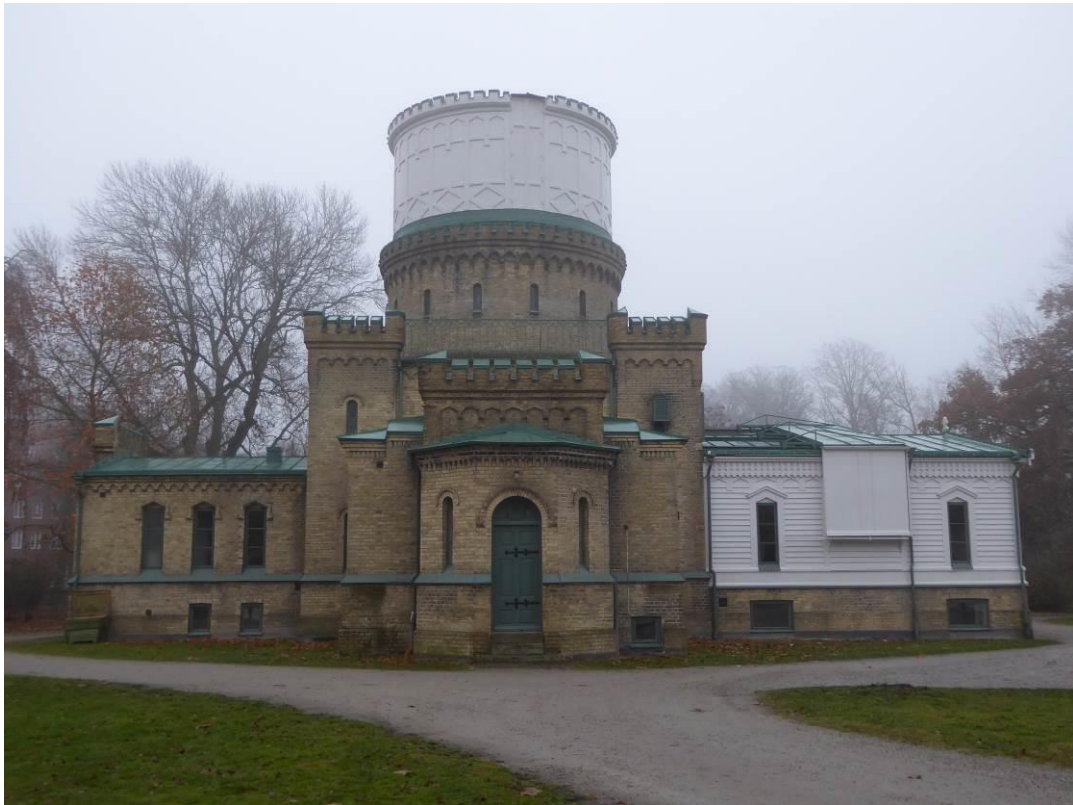
Figur 19. Efter åtgärder. Norra fasaderna.
