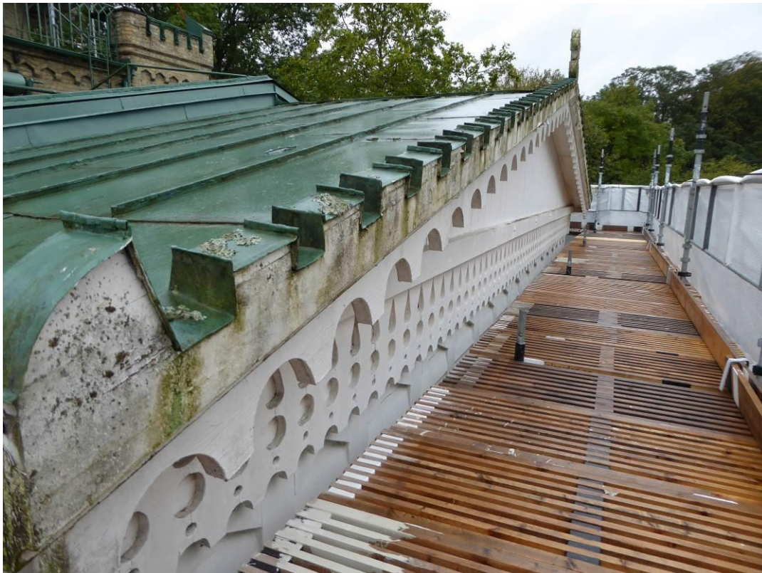
Figur 4. Före åtgärder. Västra flygelns gavelröste och takfris. I gavelröstet finns flera underliggande äldre färgskikt, dessa bevarades.
