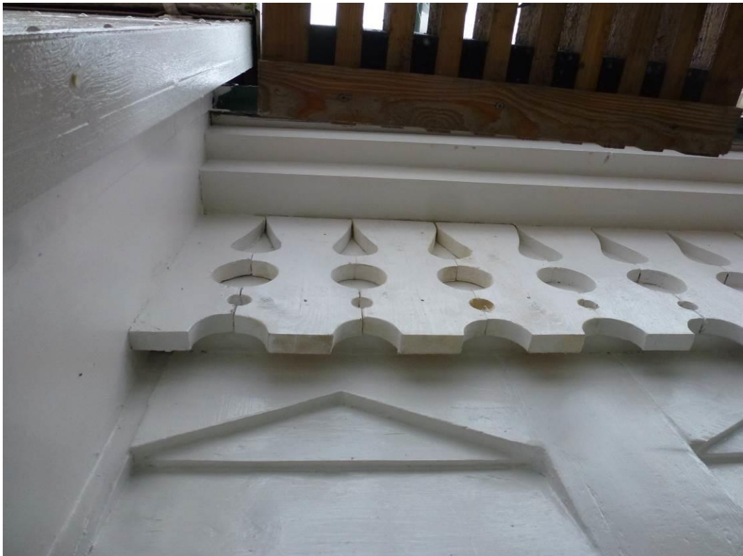
Figur 15. Under arbete. Tre dekorativa panelbrädor är ersatta och grundmålade. Södra sidan av västra flygeln.
