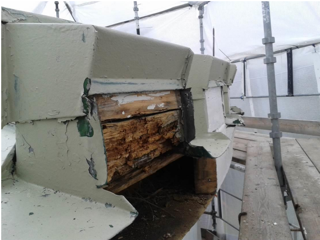
Figur 11 . Under arbetet. Rötskadad del på tornets tandsnittsfris och takfot åt söder. Plåten är här delvis grundmålad.
