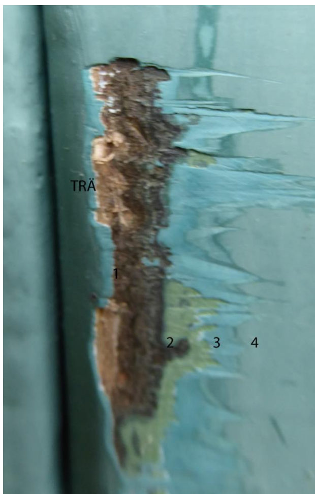
Tornets nordöstra fönster. Mörkbrunt är sannolikt oljeimpregnerat trä och grönt således understa färglager.
