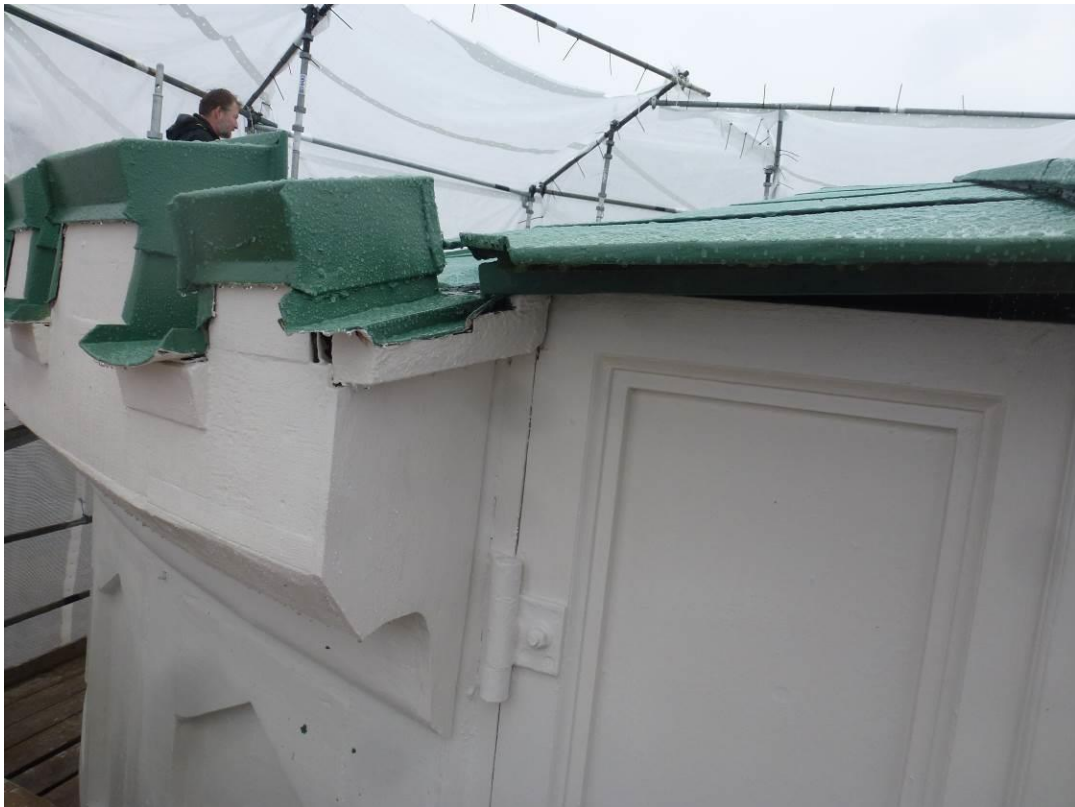
Figur 13. Efter åtgärder. Trälagning i frisen på tornet invid spaltöppningen åt norr.
