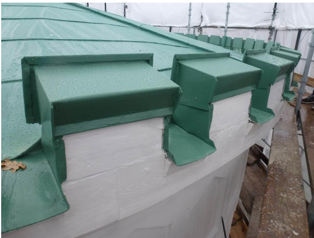
Figur 14. Efter åtgärder. Trälagningar i takfot och fris åt söder samt målat tak. En tandsnittsfris har halvsulats, takfoten är lagad med nytt trä och trekantsklossarna är ersatta.
