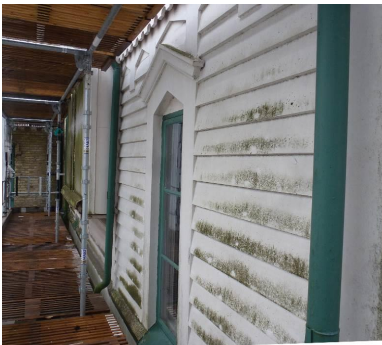
Figur 5. Före åtgärder. Fasad och fönster mot norr.
