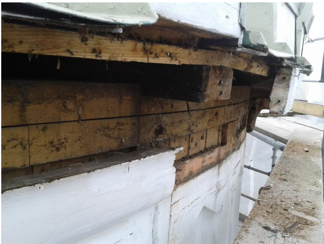
Figur 10. Under arbetet. Rötskadad del på tornets översta del har tagits bort. Södra delen. Takplåten är här endast grundmålad.
