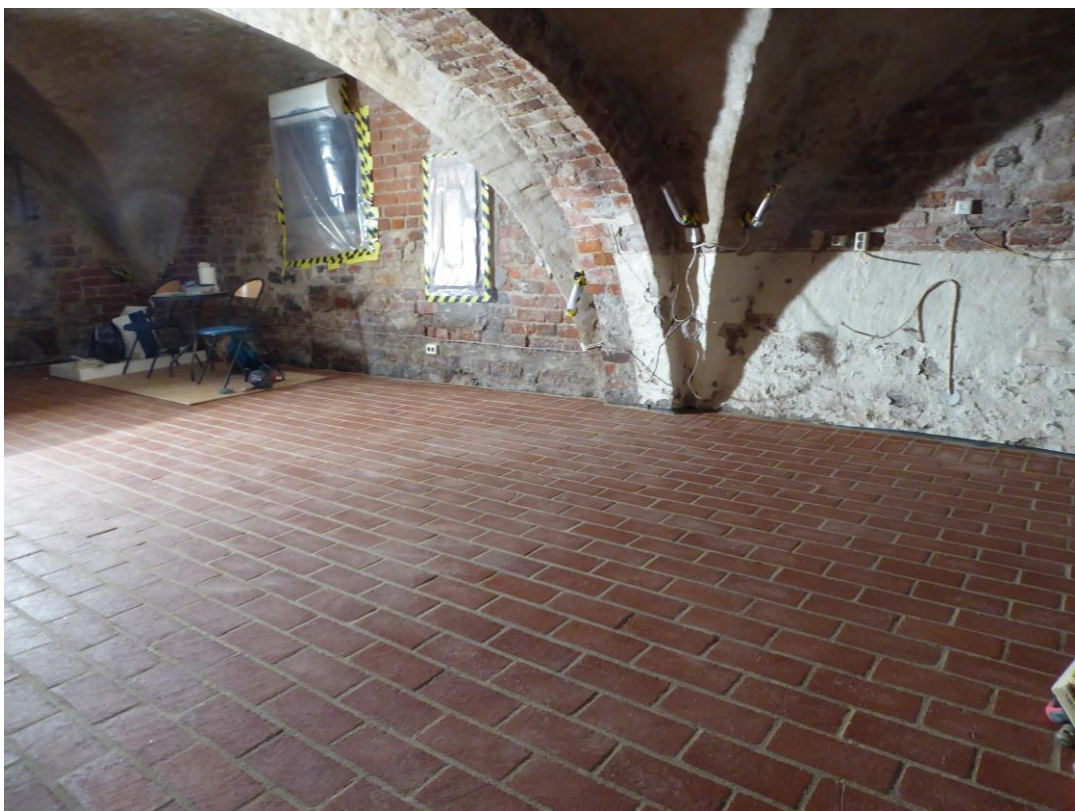
2016. Det nya tegelgolvet är lagt och fogat.
