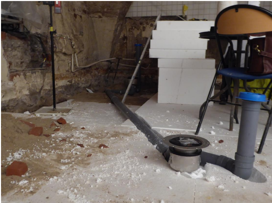
2016. Nya vatten- och avloppsrör i plats drogs från det befintliga i sydvästra hörnet. Det nya avloppet finns i anslutning till bardisken.
