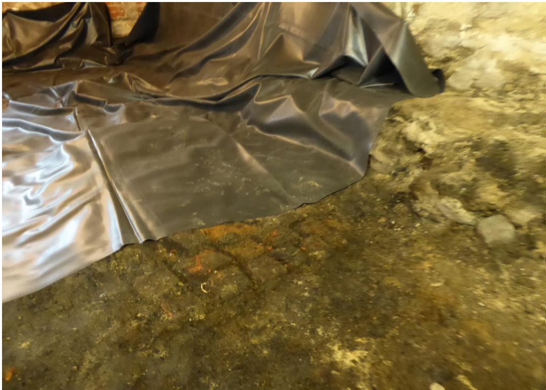
2017. Geomembran läggs ut efter att underliggande lager grävts bort under arkeologisk schaktövervakning.
