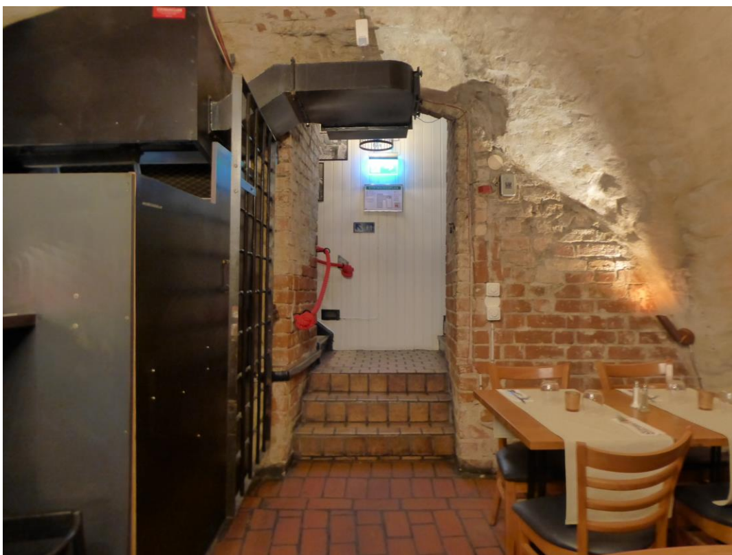
Före åtgärder. Golvet som lades in på 1950-talet.
