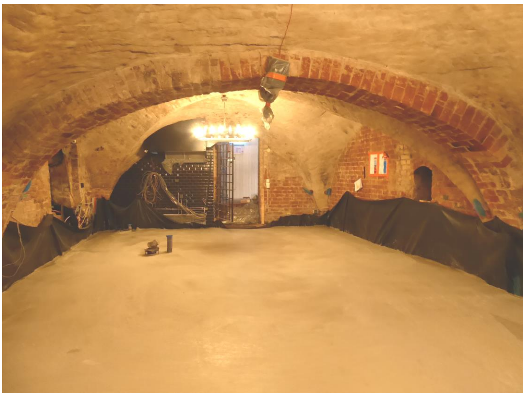
2017. Betongplattan är gjuten, vy mot väster.
