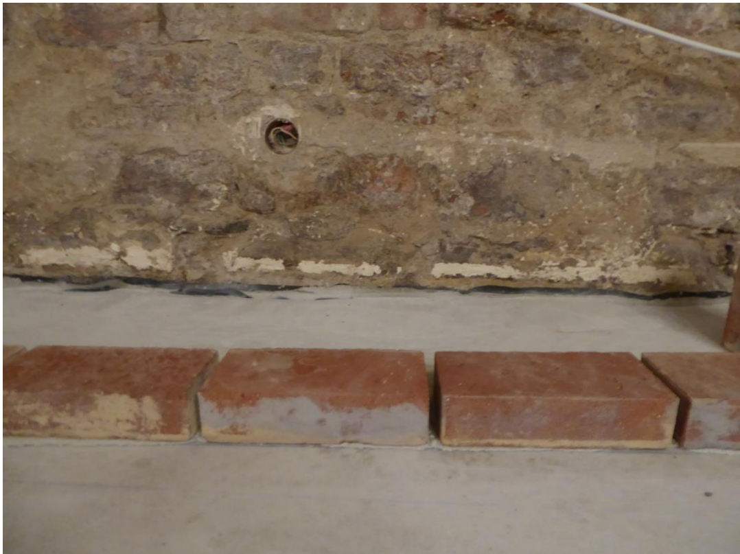
2017. Golvteglet läggs i fix.
