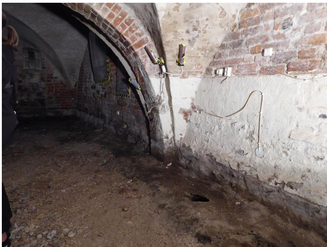
2016. Södra väggen med sentida vit målfärg och diverse el. Färg och el togs bort senare under arbetet.
