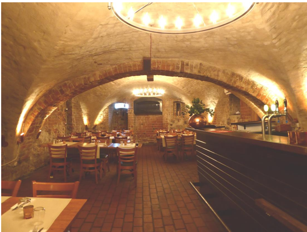
Före åtgärder. Övre källarplan med golvet som lades in på 1950-talet.
