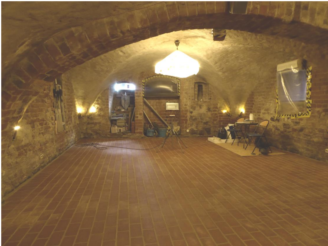
2016. Det nya tegelgolvet är lagt och fogat.
