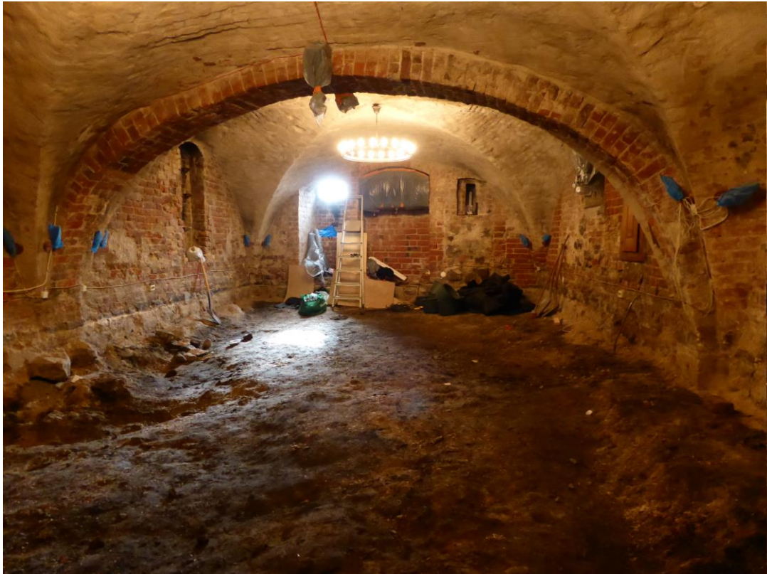
2017. Golvet från 2016 och underliggande betongkross har tagits bort. Vy mot öster.
