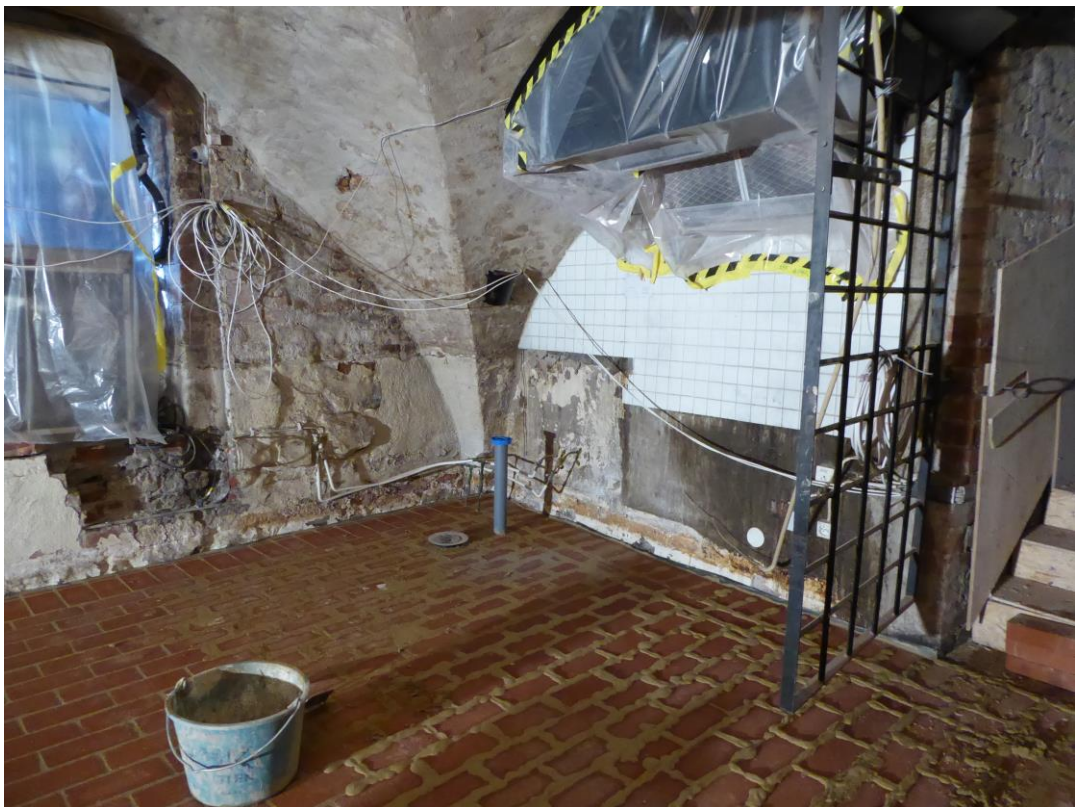
2016. Det nya golvet fogas med hydrauliskt kalkbruk.
