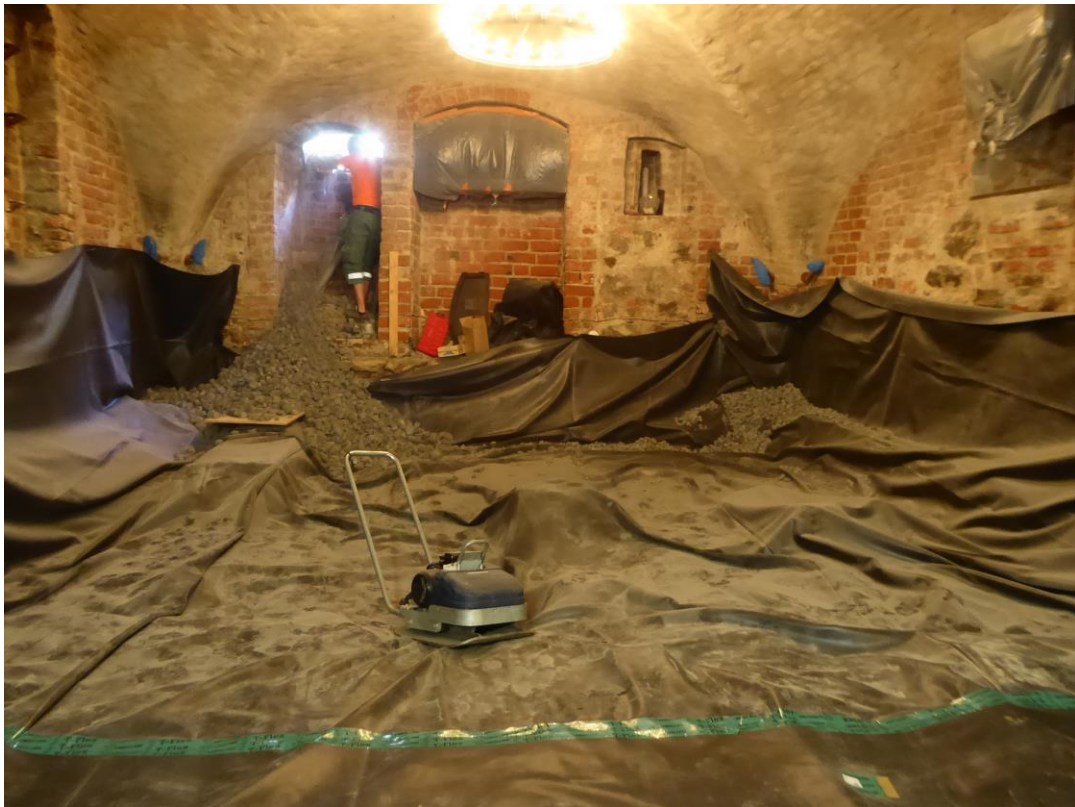
2017. Geomembran har lagts ut och Hasopor skumglas tas in genom fönsteröppning mot Stora Södergatan.
