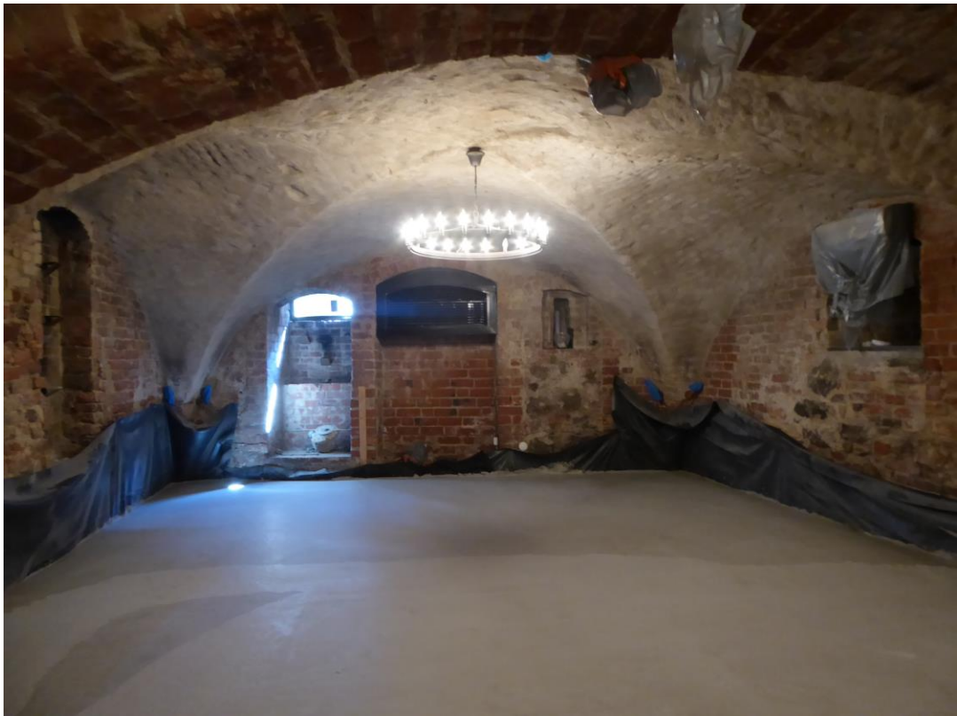
2017. Betongplattan är gjuten, vy mot öster.
