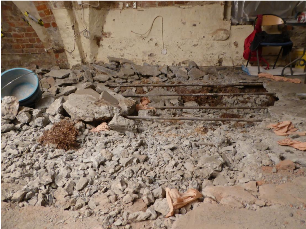
2016. Under arbete. Tegelgolvet är bortbilat och underliggande betongplattan bilas här bort. Under betongplattan fanns järnrör och betongkross. Här mot söder hade ett hålrum bildats under betongplattan på grund av sättningar. På bilden ser man även muren vitmålad med sentida färgmaterial.
