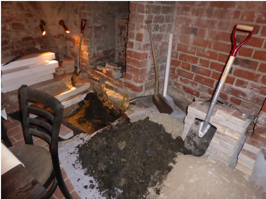
2017. Geoteknisk undersökning och provgropar.
