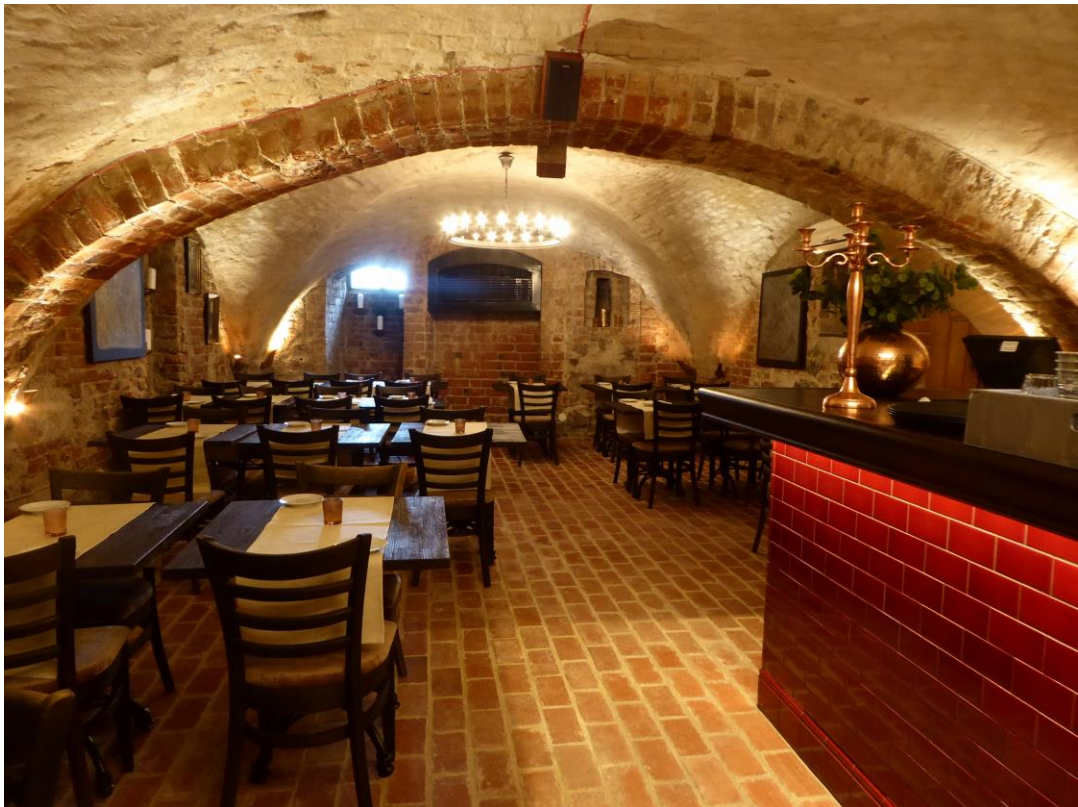
2017. Efter åtgärder. Vy mot öster.
