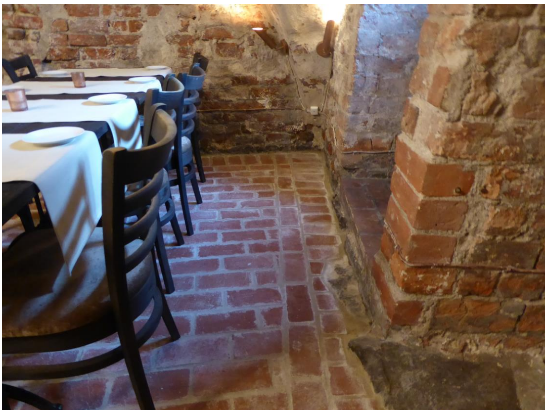
2017. Efter åtgärder. Nordöstra hörnet.
