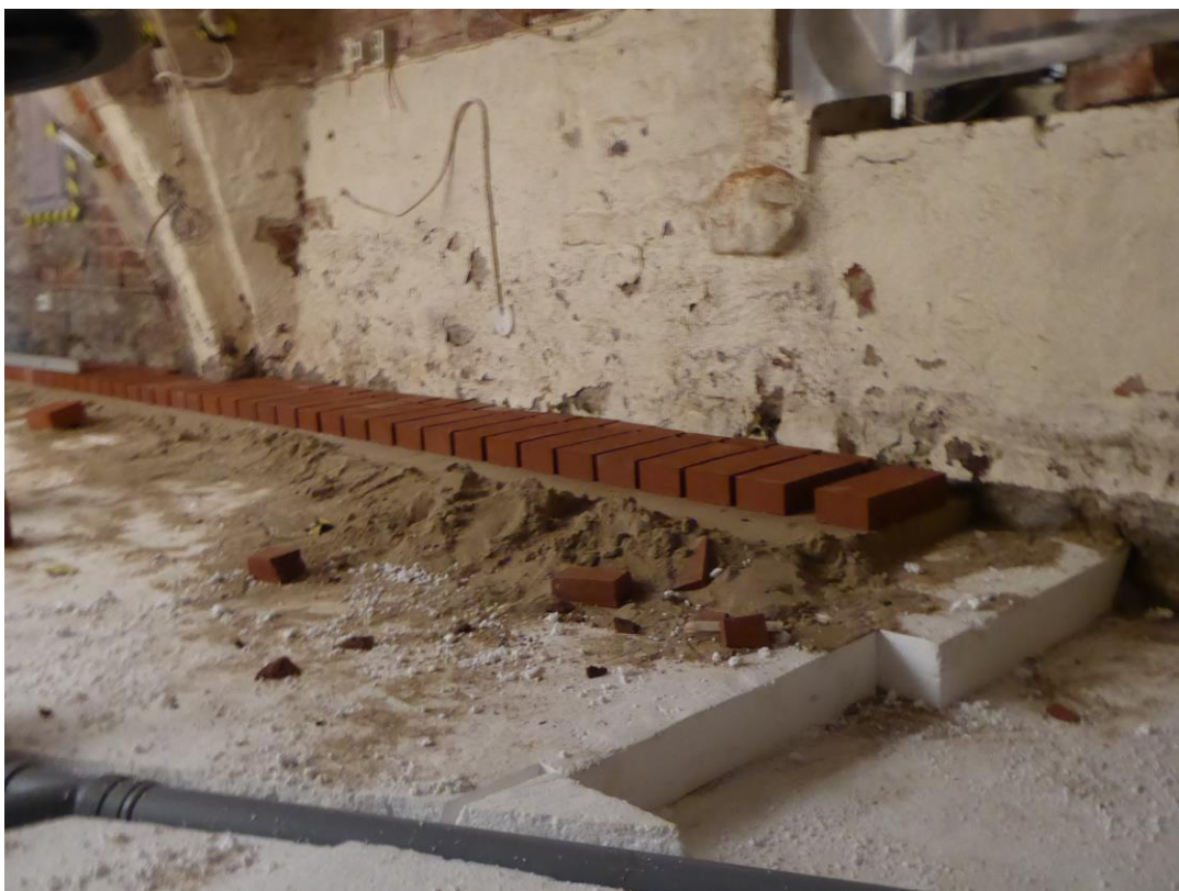
2016. Det nya tegelgolvet läggs på frigolit och sättsand.
