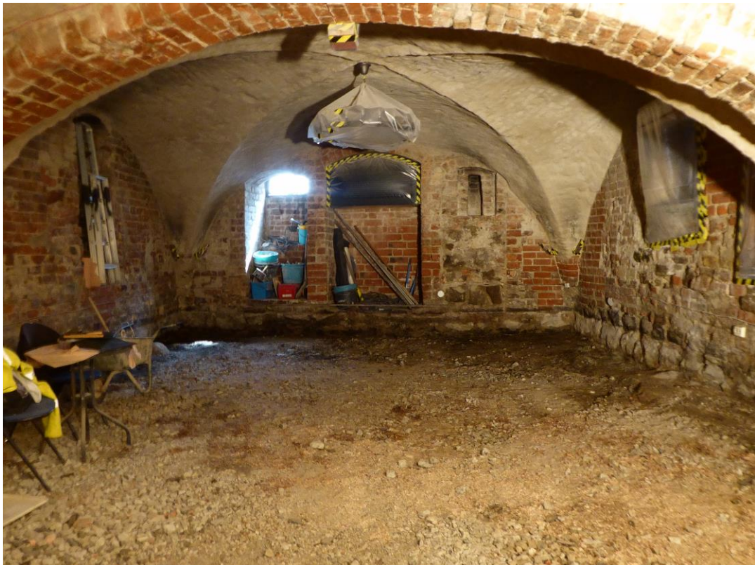
2016. Under arbete. Betongplattan är bortbilad och järnrören borttagna, betongkrossen lämnades kvar och golvet är förberett för att jämnas till med makadam. Tegelgolvet låg ungefär i nivå med den svarta linjen som anas ovan grundens fältstenar.
