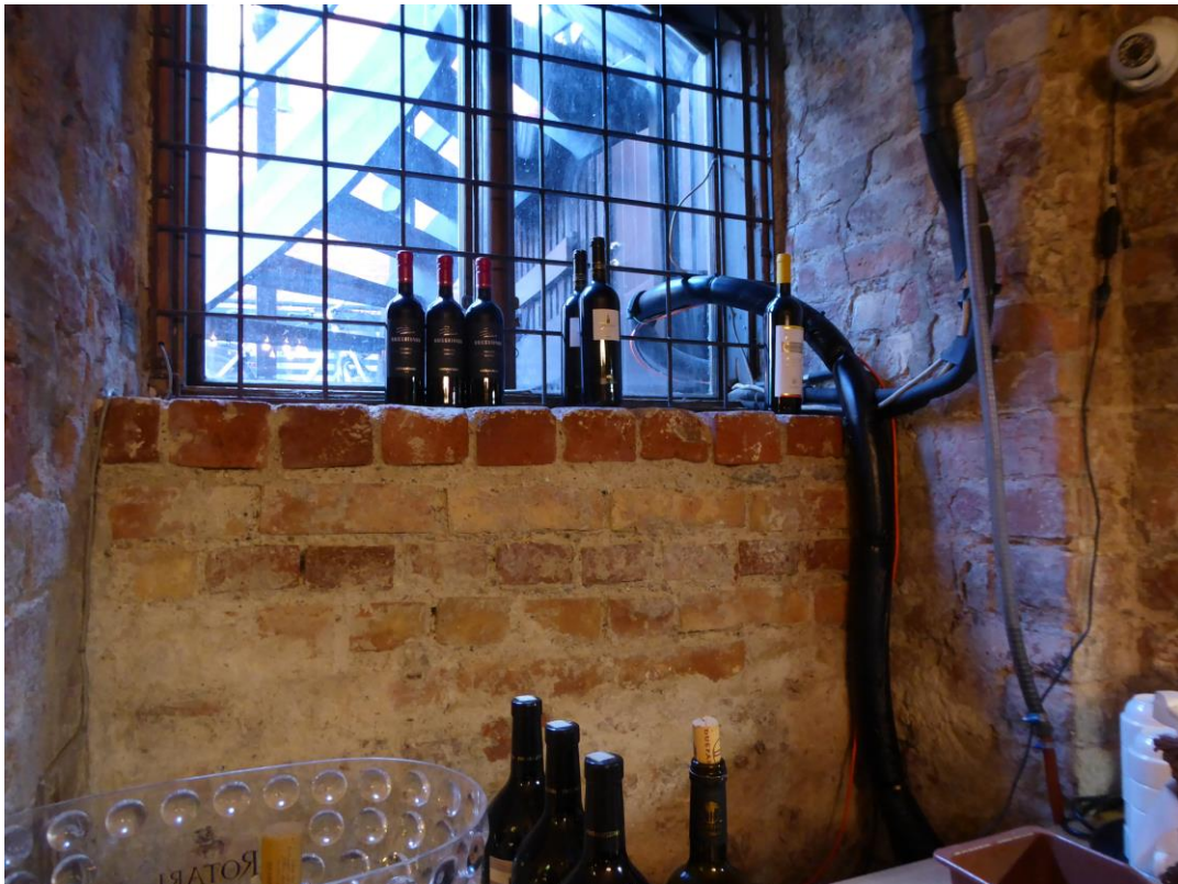
2016. Efter åtgärder. Sentida färglager på väggen är borttaget. Ett hål har tagits i fönstret för att dra in ny öltapp till baren.
