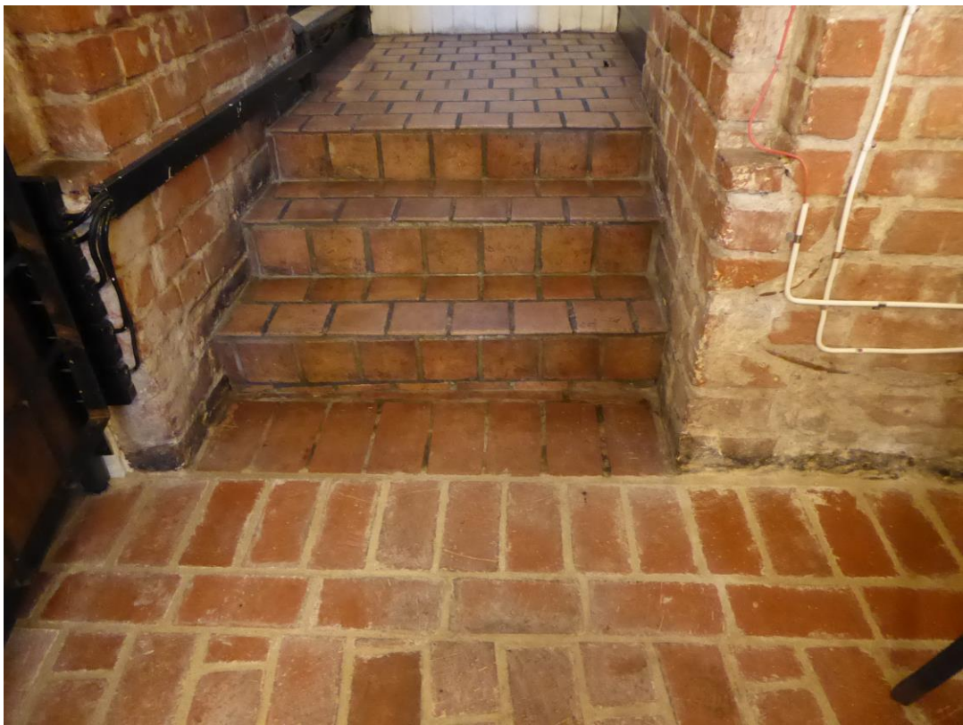
2017. Efter åtgärder. Vid västra väggen.
