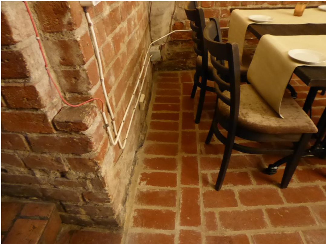
2017. Efter åtgärder. Vid västra väggen.
