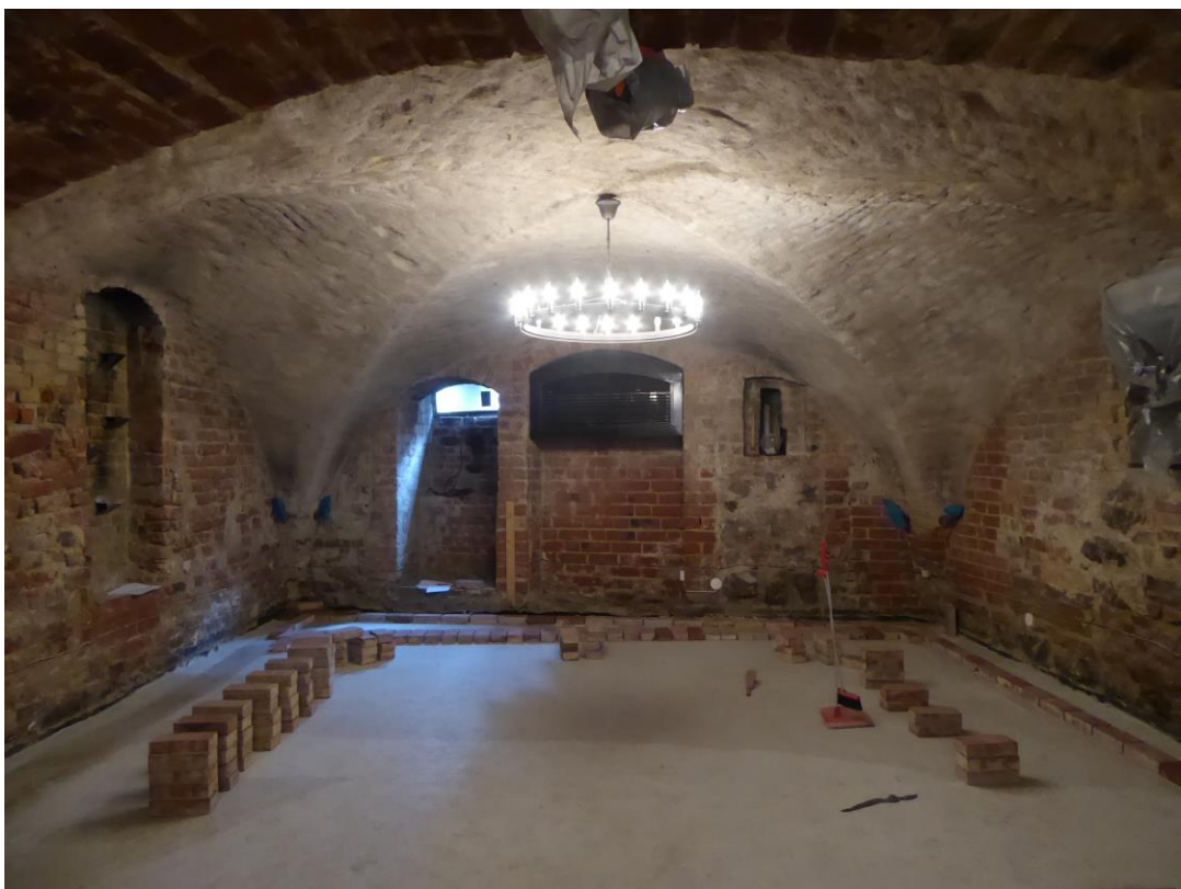
2017. Golvteglet läggs i fix.
