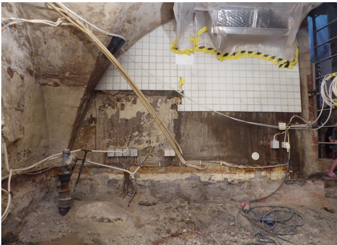
2016. Under arbete, sydvästra hörnet. Västra väggen är tunt putsad och till en del kaklad med vitt kakel 10 x 10 cm. I sydvästra hörnet finns vattenrör och avloppsrör i järn.
