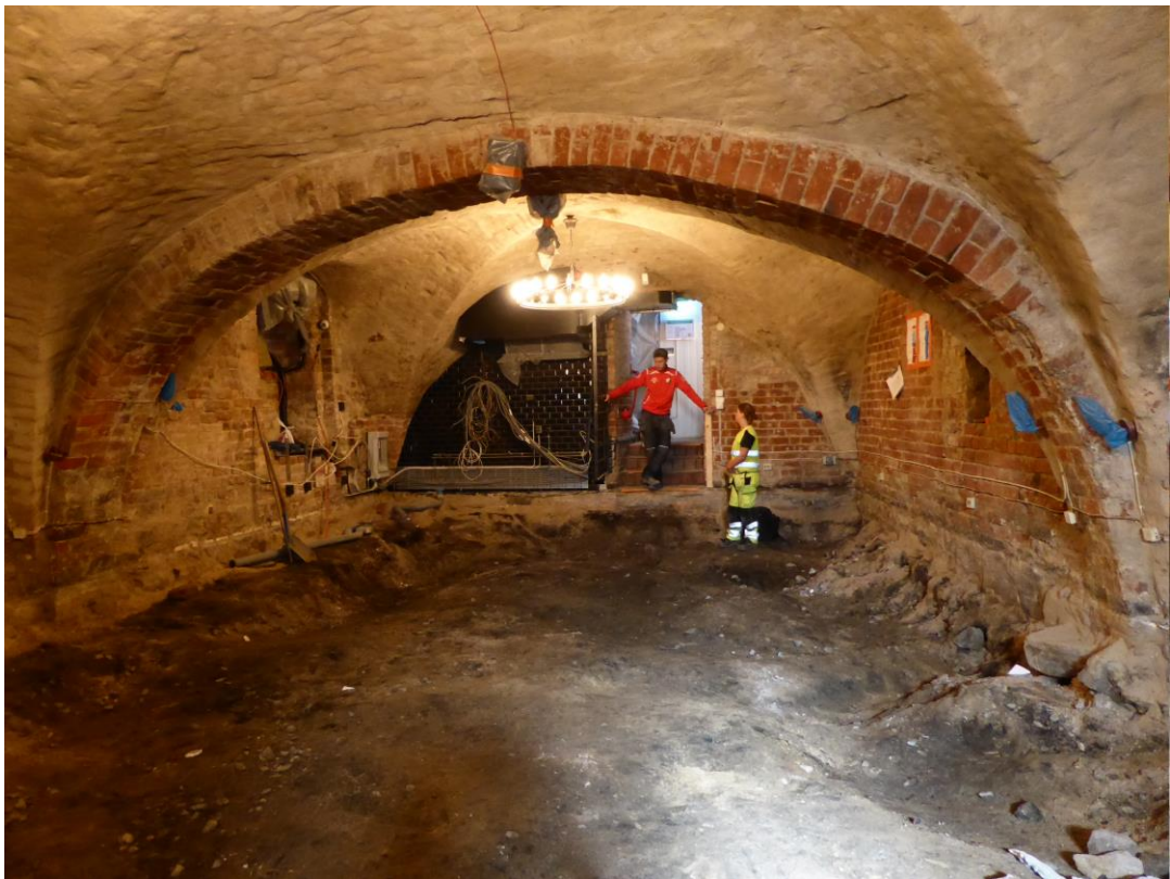
2017. Golvet från 2016 och underliggande betongkross har tagits bort. Vy mot väster.
