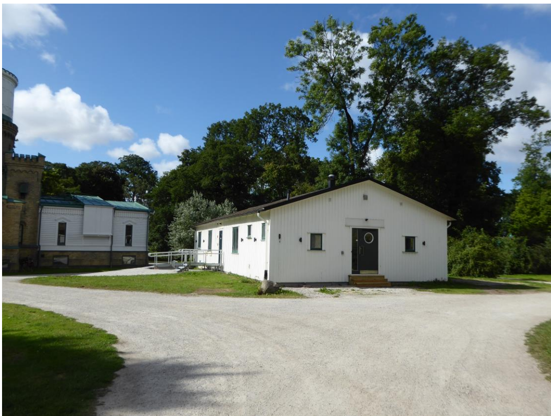
Efter åtgärder. Norra kortsidan med bevarad dörr och ny trappa. Östra långsidan med ny entré.
