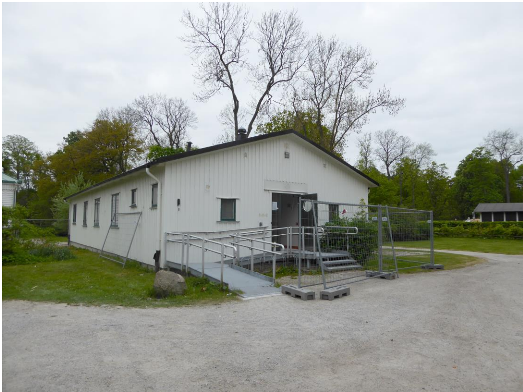
Före åtgärder, maj 2016.
