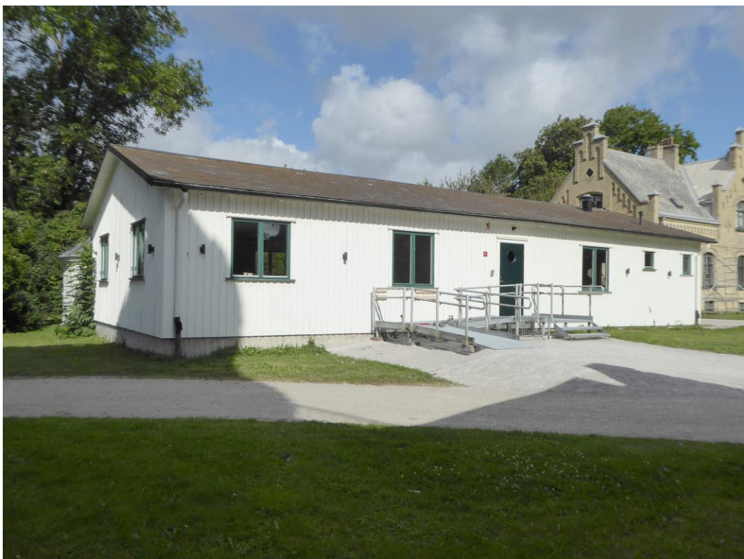
Efter åtgärder. Östra långsidan.
