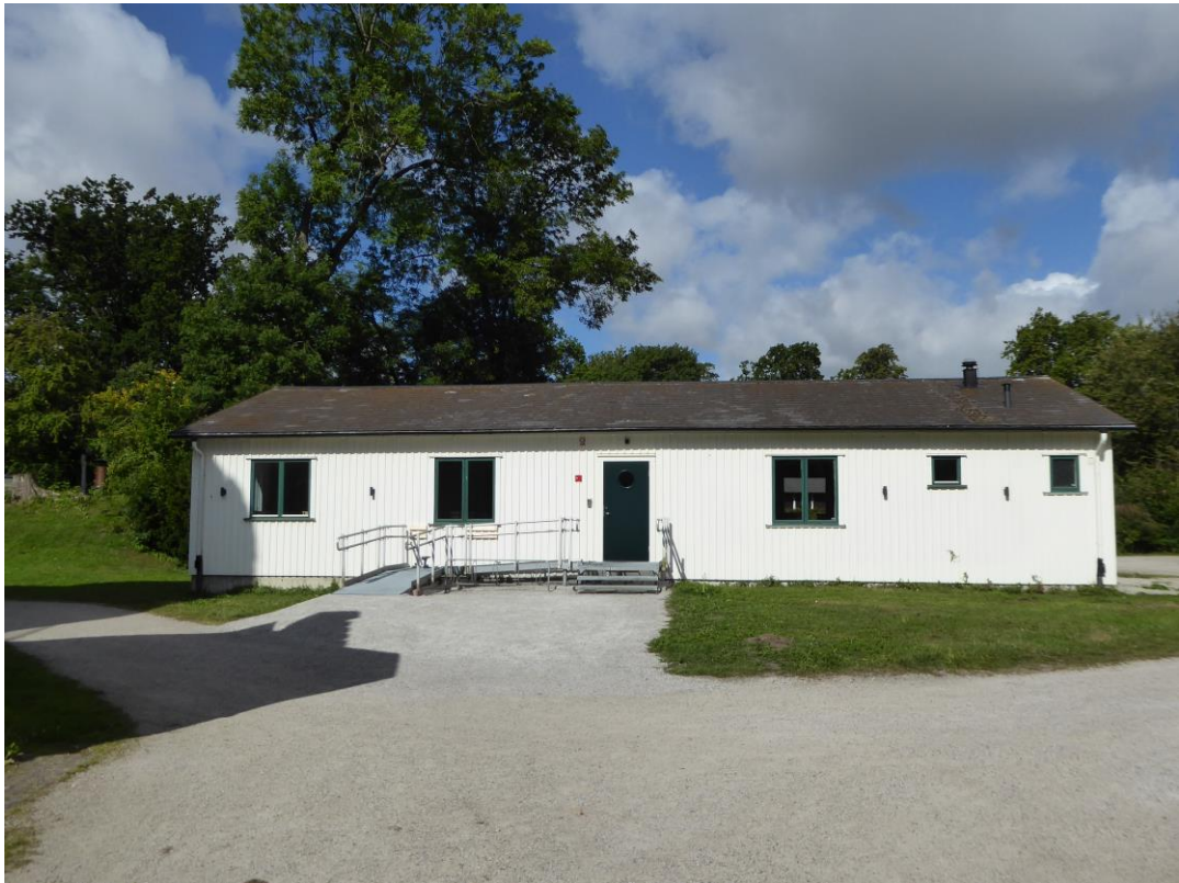
Efter åtgärder. Östra långsidan. Ny dörr och flyttad tillgänglighetsramp. De av gräsmattan har ersatts med grus.
