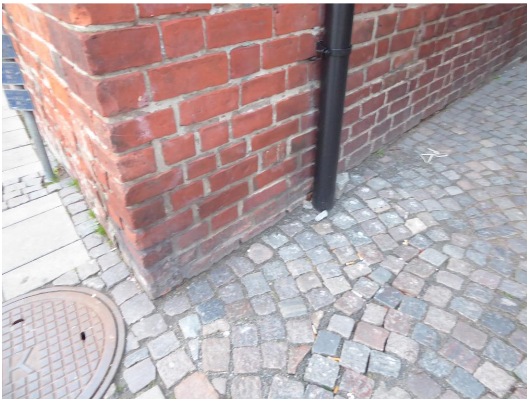
Figur 25. Ersatt vandlrör och återplacerad gatsten. Nordöstra hörnet.
