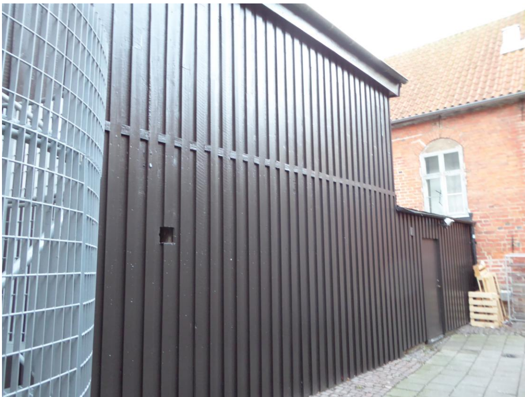
Figur 27. Efter åtgärder. Sentida förråd västra fasaden.
