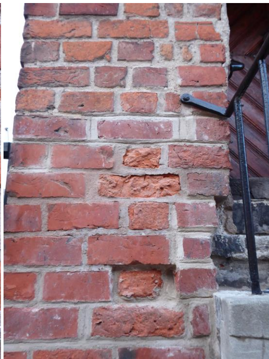
Figur 20 och 21. Efter åtgärder. Exempel på ankarjärn. Höger: Omfogning utförd. Tegelstenarna som var murade på trappstegen har kapats och en av dessa har flyttats upp vid räcket infäste, ytterligare en tegelsten har ersatts. Ny förlängd infästning av räcket.
