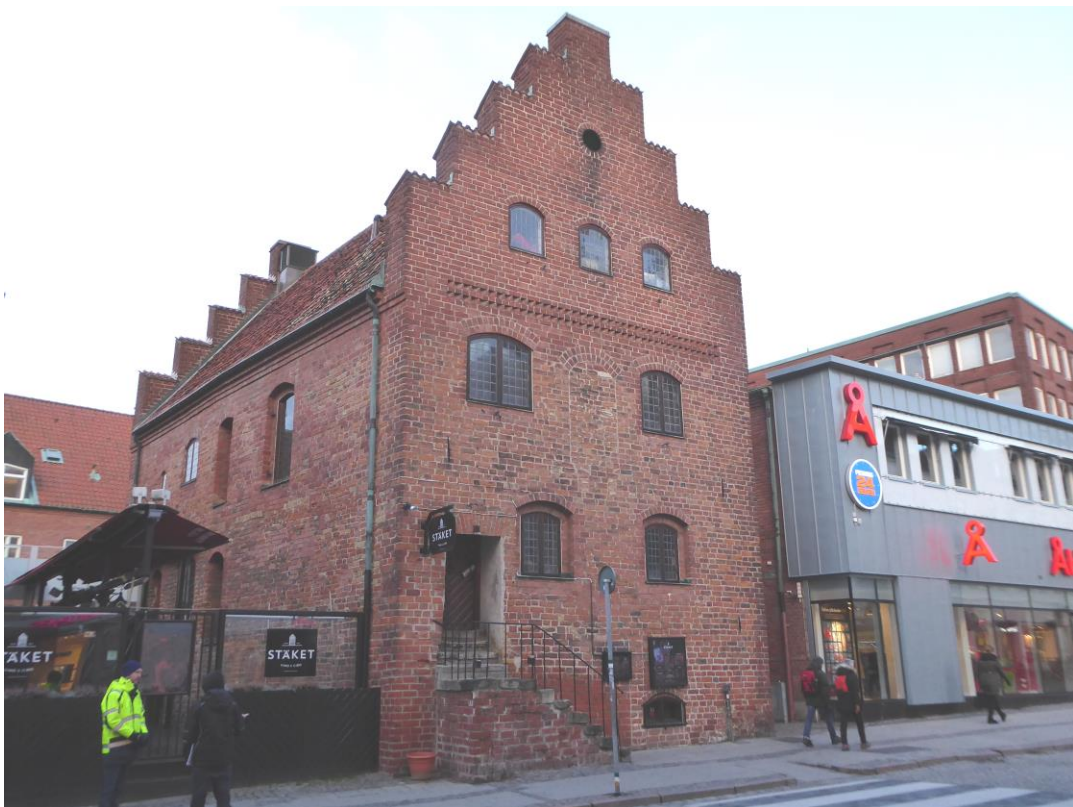
Figur 17. Efter åtgärder. Södra och östra fasaderna.
