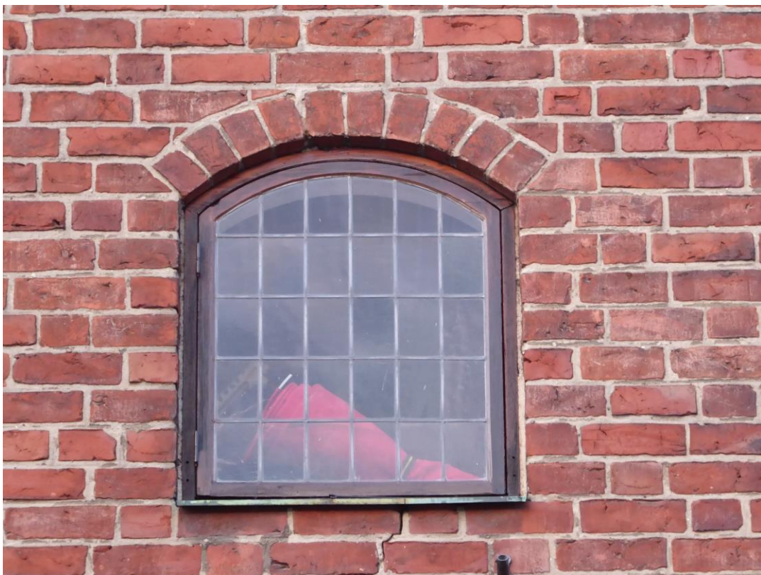
Figur 23. Efter åtgärder. Nya blyspröjs i ett fönster på östra gavelfasaden.
