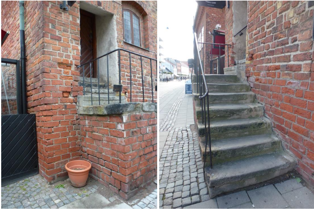
Figur 5 och 6. Före åtgärder, trappa och dörr vid entrén åt öster.
