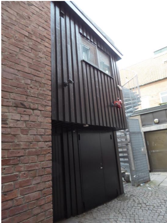
Figur 26. Efter åtgärder. Sentida förråd nordvästra hörnet. Målad fasad och ny dörr.
