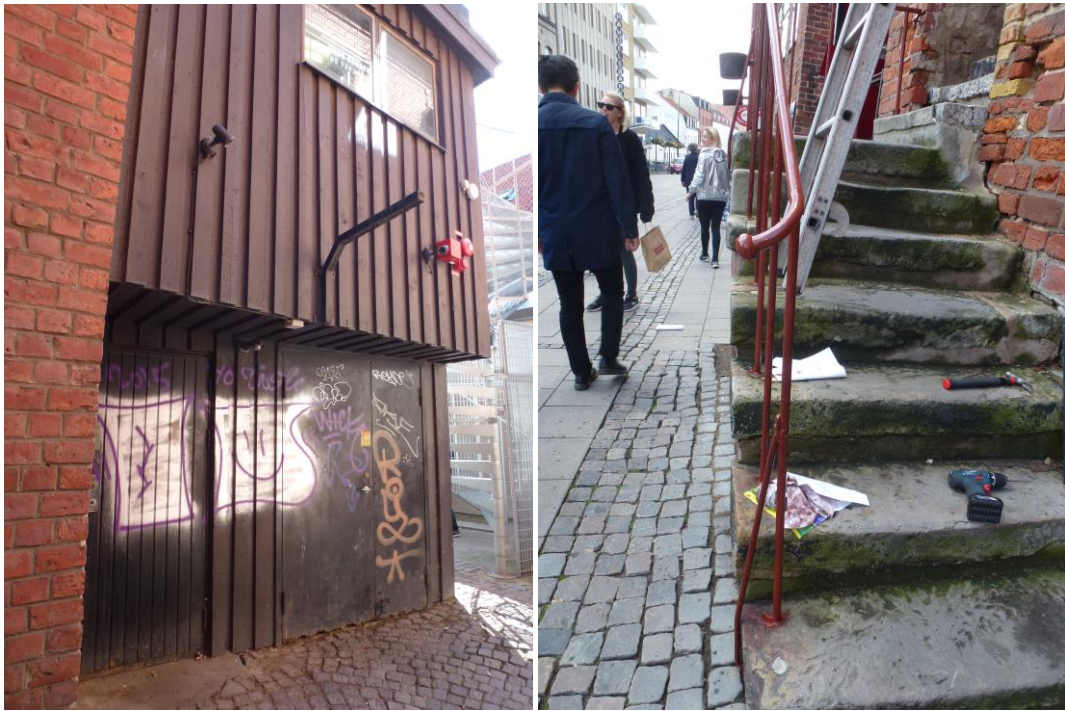
Figur 16 och 16. Vänster: Sentida förråd, nordvästra hörnet. Höger: Under arbete. Järnräcket var så kallt i september att järnmönjan rann.
