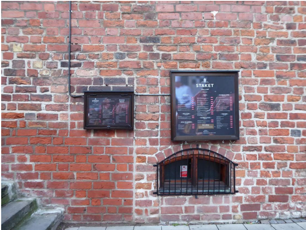
Figur 22. Efter åtgärder. Justerade och målade skyltar och galler samt omfogning under källarfönster.
