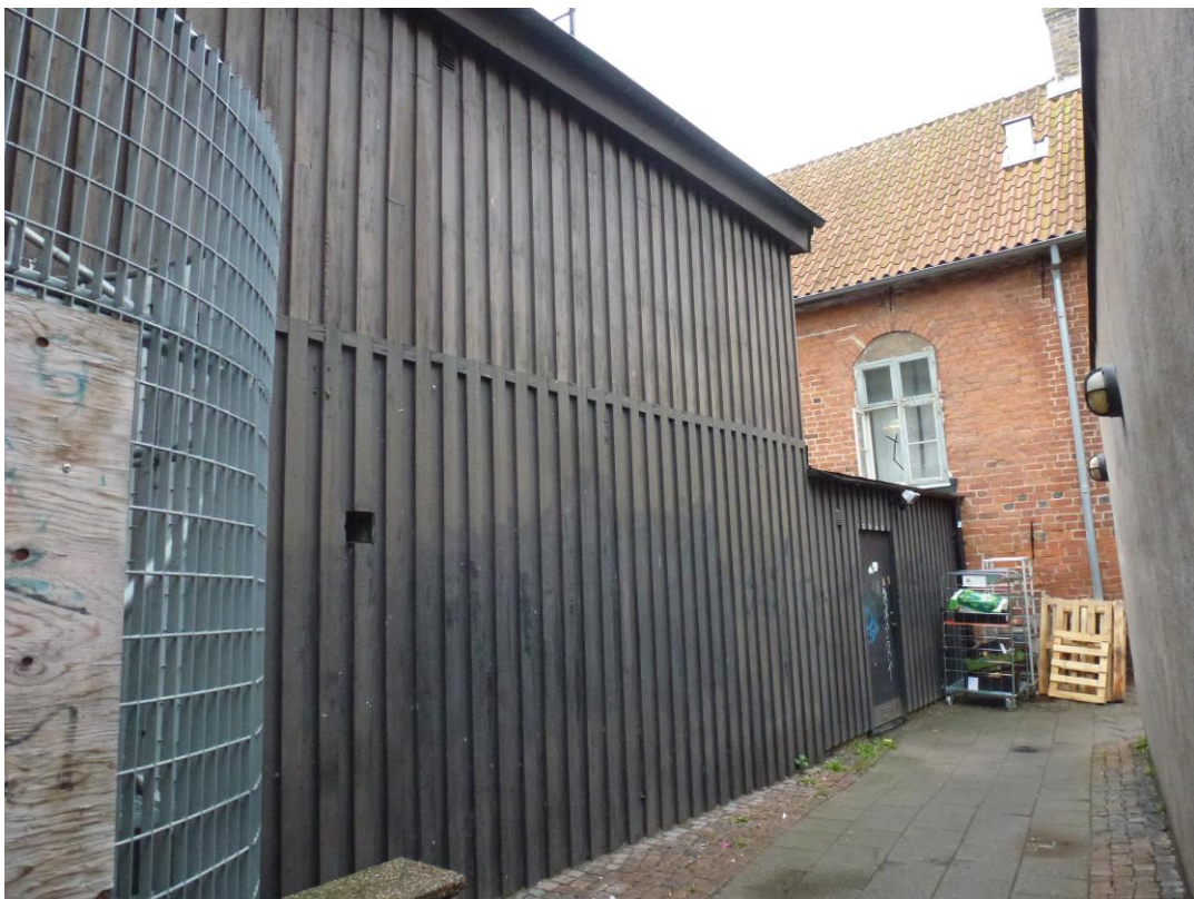
Figur 13. Före åtgärder. Sentida förråd åt gården i väster.
