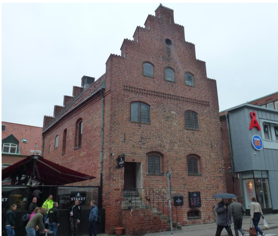
Figur 4. Före åtgärder, södra fasaden och östra gavelfasaden.
