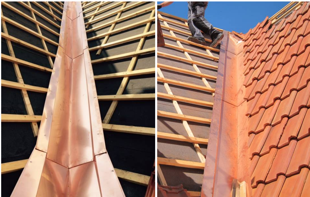
Figur 12. Vänster: ny vinkelränna i koppar. Höger: takpannorna återmonteras och skärs intill vinkelrännorna.
