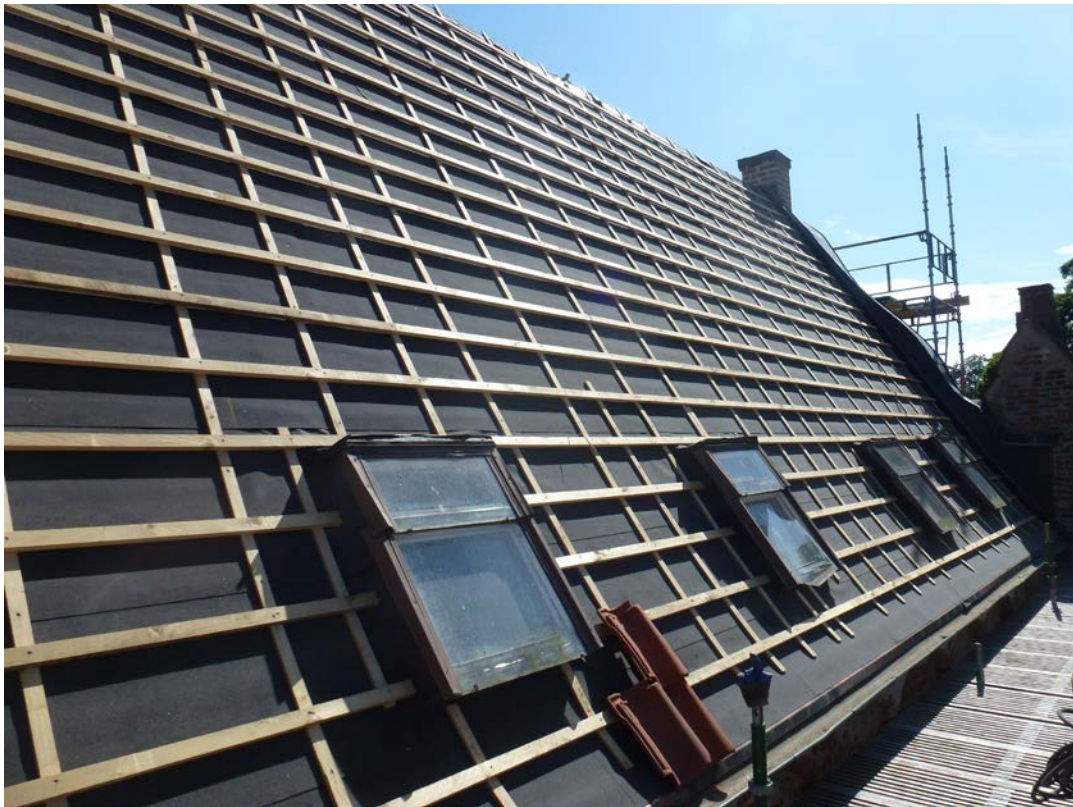
Figur 20. Under arbetet. Ny papp och läkt har monterats.
