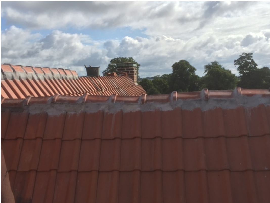
Figur 13. Pågående nockmurning.
