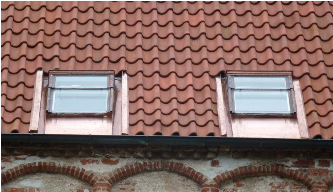
Figur 22. Ny kopparplåt kring takfönster, väl rengjorda takpannor. Återstår att måla nittarna på takfönstren i samma färg som bågarna.
