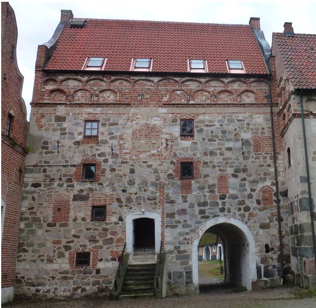
Figur 23. Efter åtgärder. Norra fasaden, takfall C.
