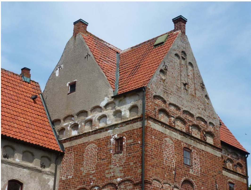
Figur 7. Före åtgärder. Södra fasaderna. Takfall A.
