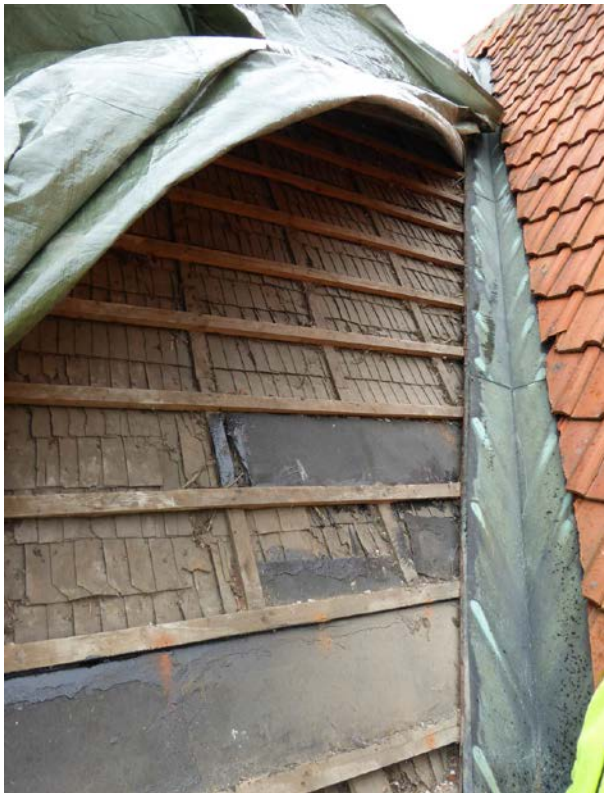
Figur 9. Under arbete. Takfall med stickespån och vinkelrännan mot sydväst efter att takpannorna tagits ner.
