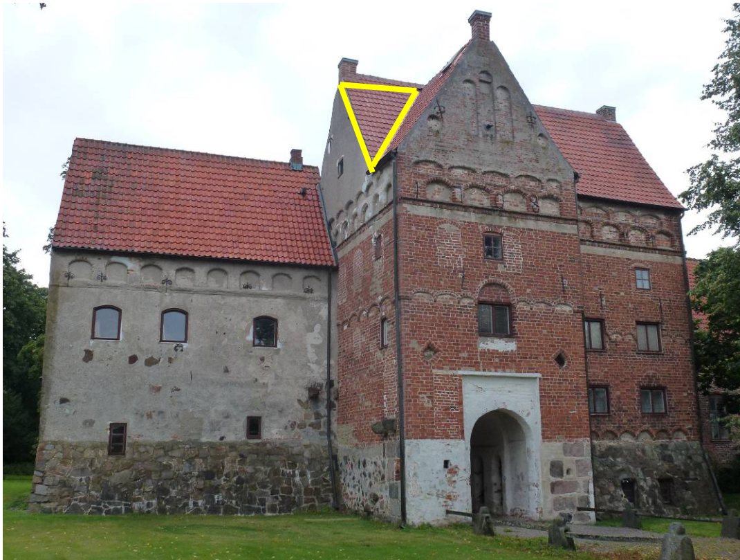
Figur 16. På markerad del av takfall A har ersättningstegel Heisterholz 74 98 lagts. På övriga delar lades det befintliga takteglet Heby pannor.
