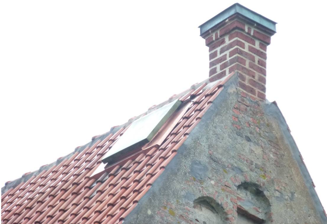
Figur 15. Efter åtgärder. Taklucka och skorsten, murning mellan takpannor och gavelspets.
