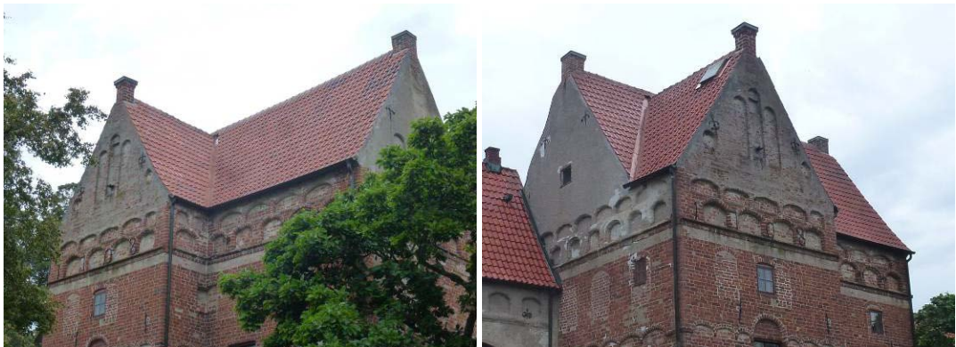
Figur 18. Efter åtgärder. Södra fasaden, takfall A.
