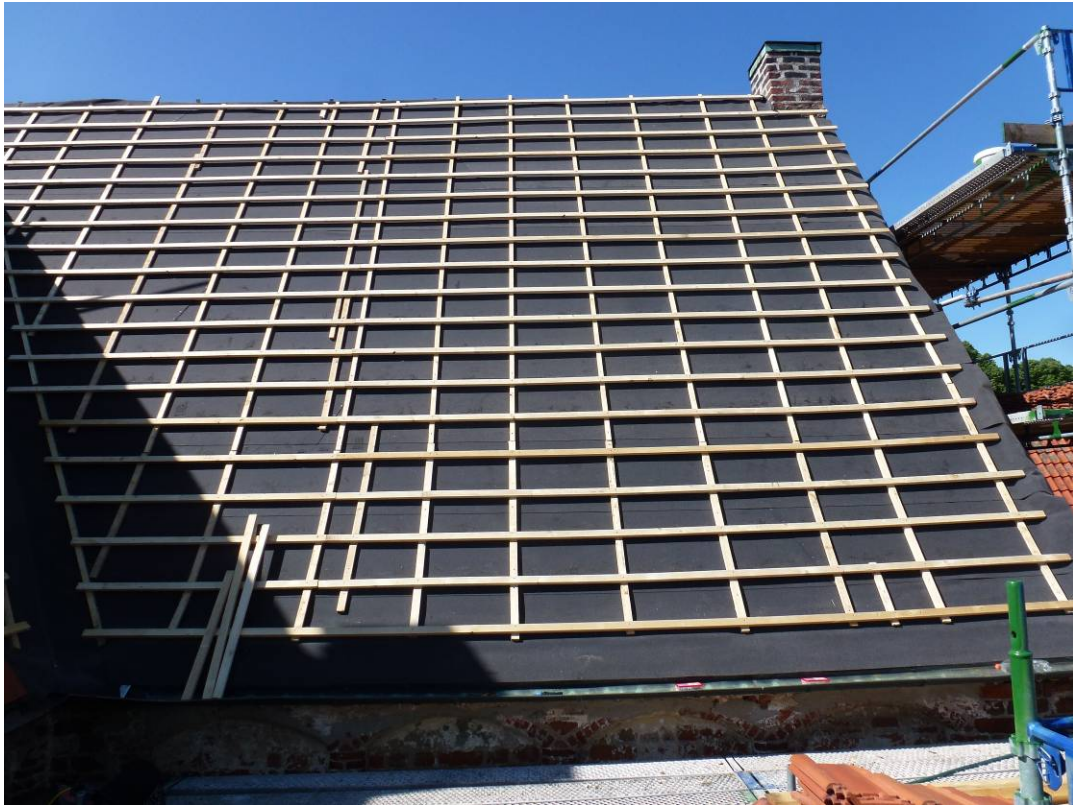
Figur 11. Under arbetet. Ny takboard, takpapp och läkt har lagts.
