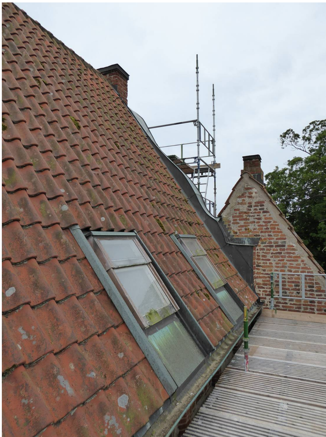
Figur 19. Före åtgärder. Norra takfallet, takfall C.
