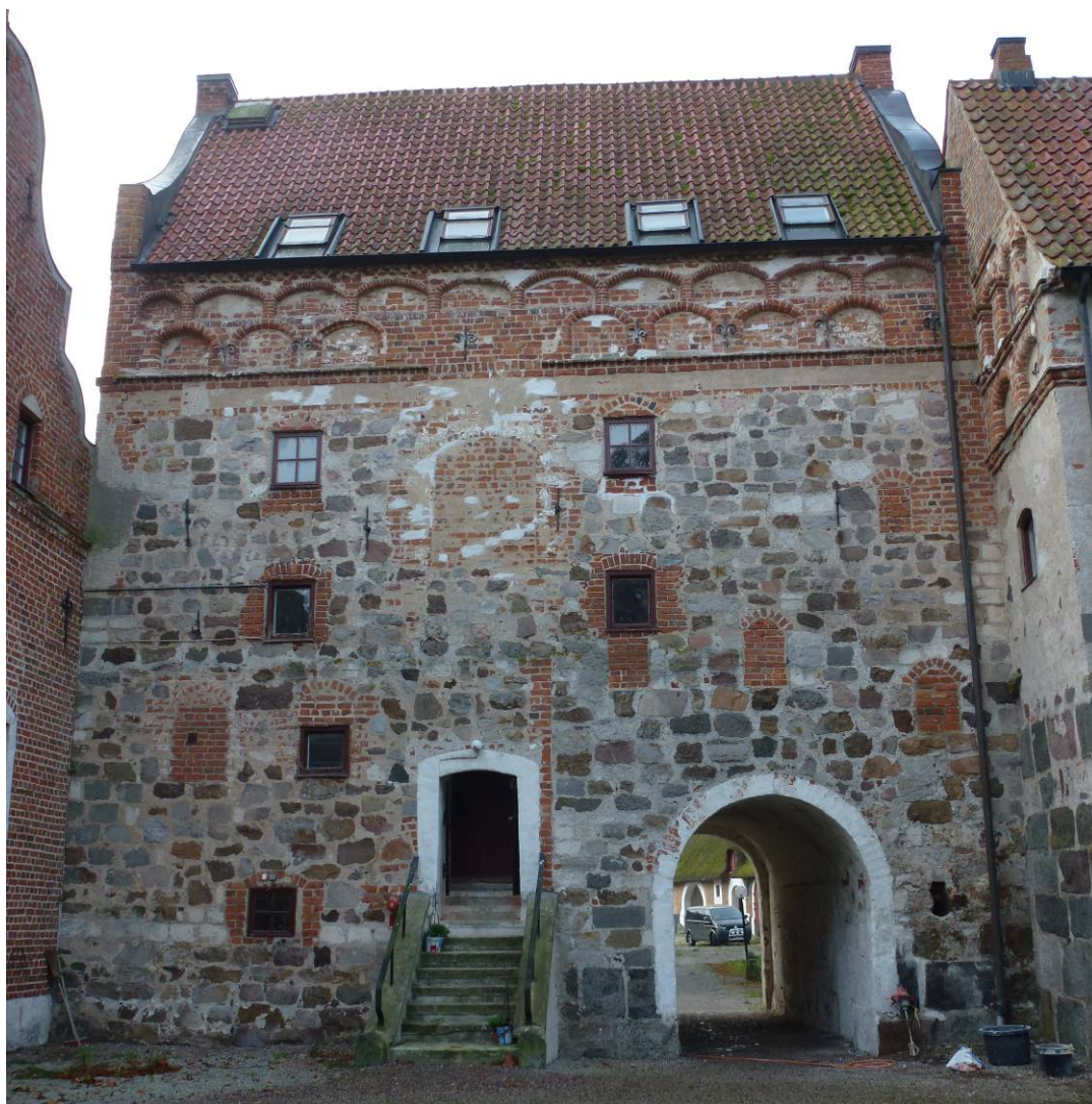
Figur 4. Före åtgärder. Norra fasaden takfall C.
