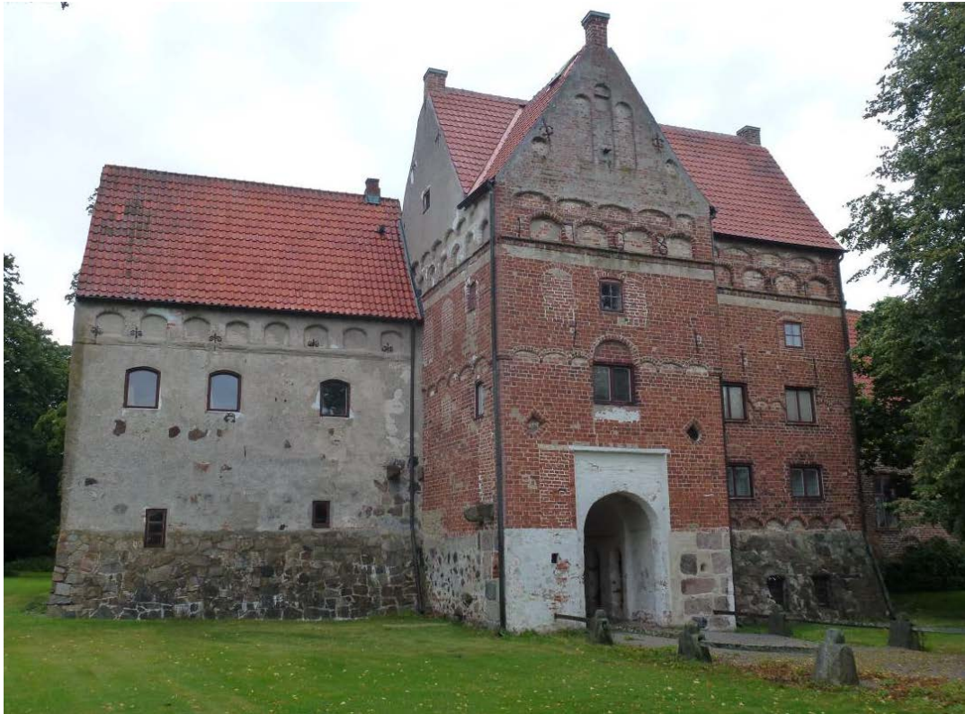
Figur 17. Efter åtgärder. Södra fasaden, takfall A.
