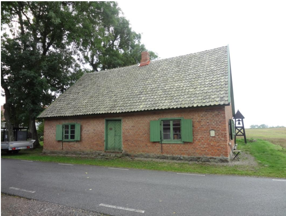
Norra takfallet efter åtgärd
