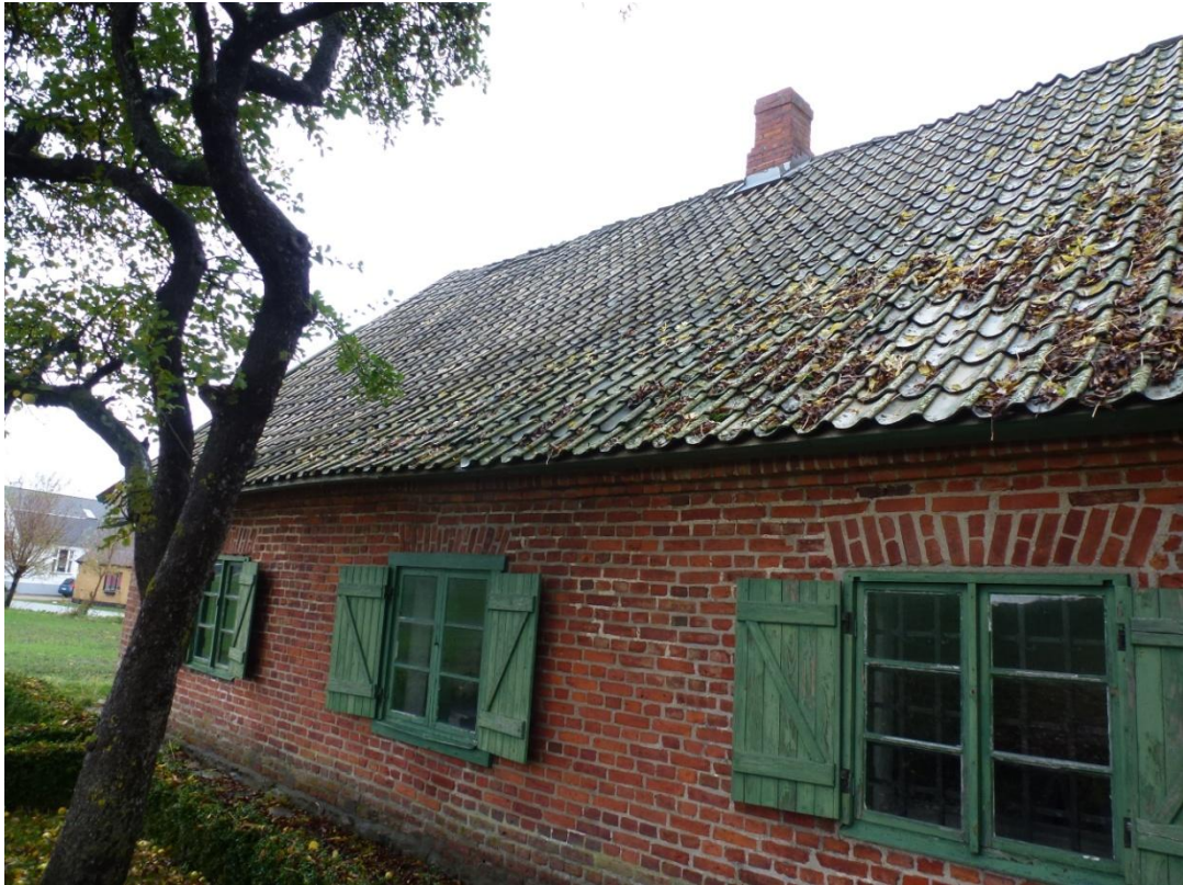
Från syd före åtgärd
