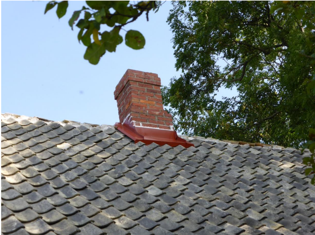
Skorsten med ny plåtning, teglet återlagt ochnocken murad
