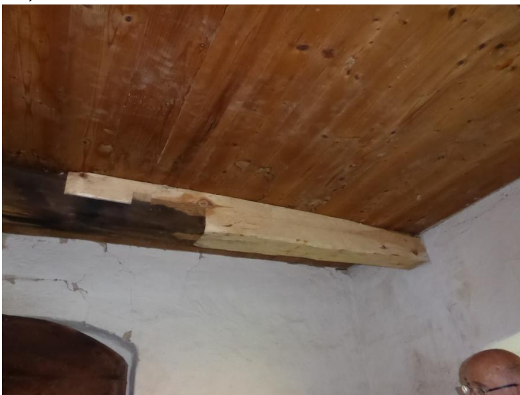
Takbjälke med skarvad del, takbrädor återlagda, puts lagad och kalkad
