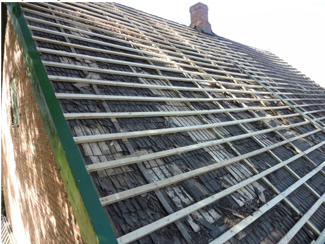
Norra takfallet efter lagning av spån och byte av läkt
