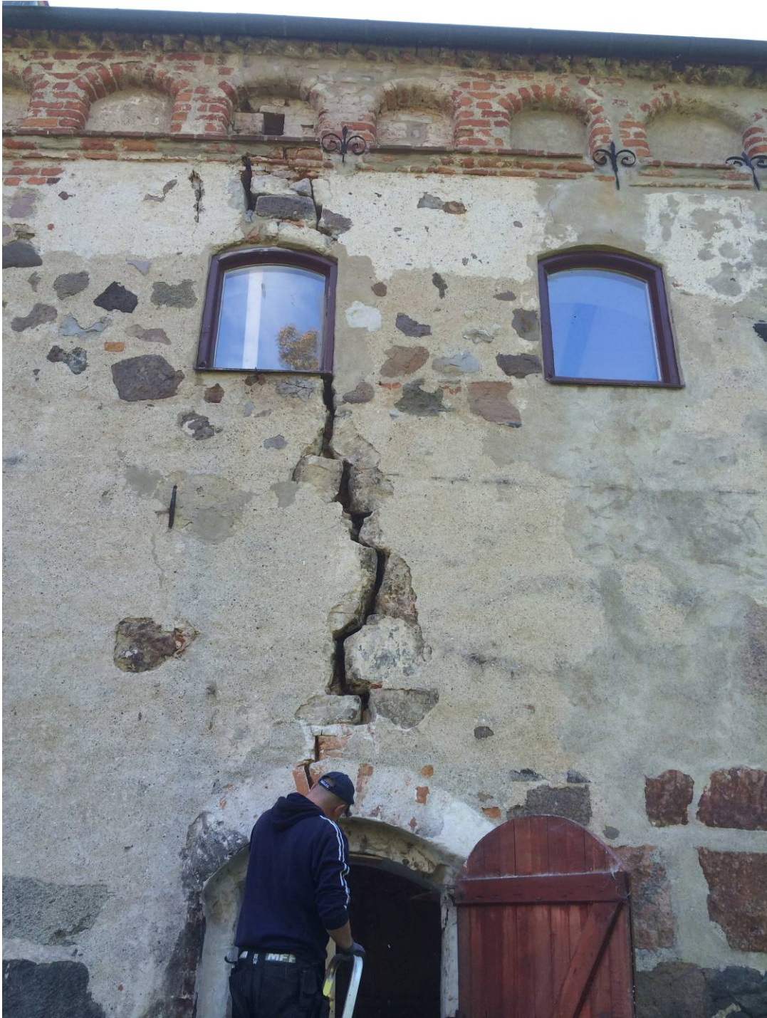
Under arbete. Sprickan ovan dörren har rengjorts inför omfogning.
