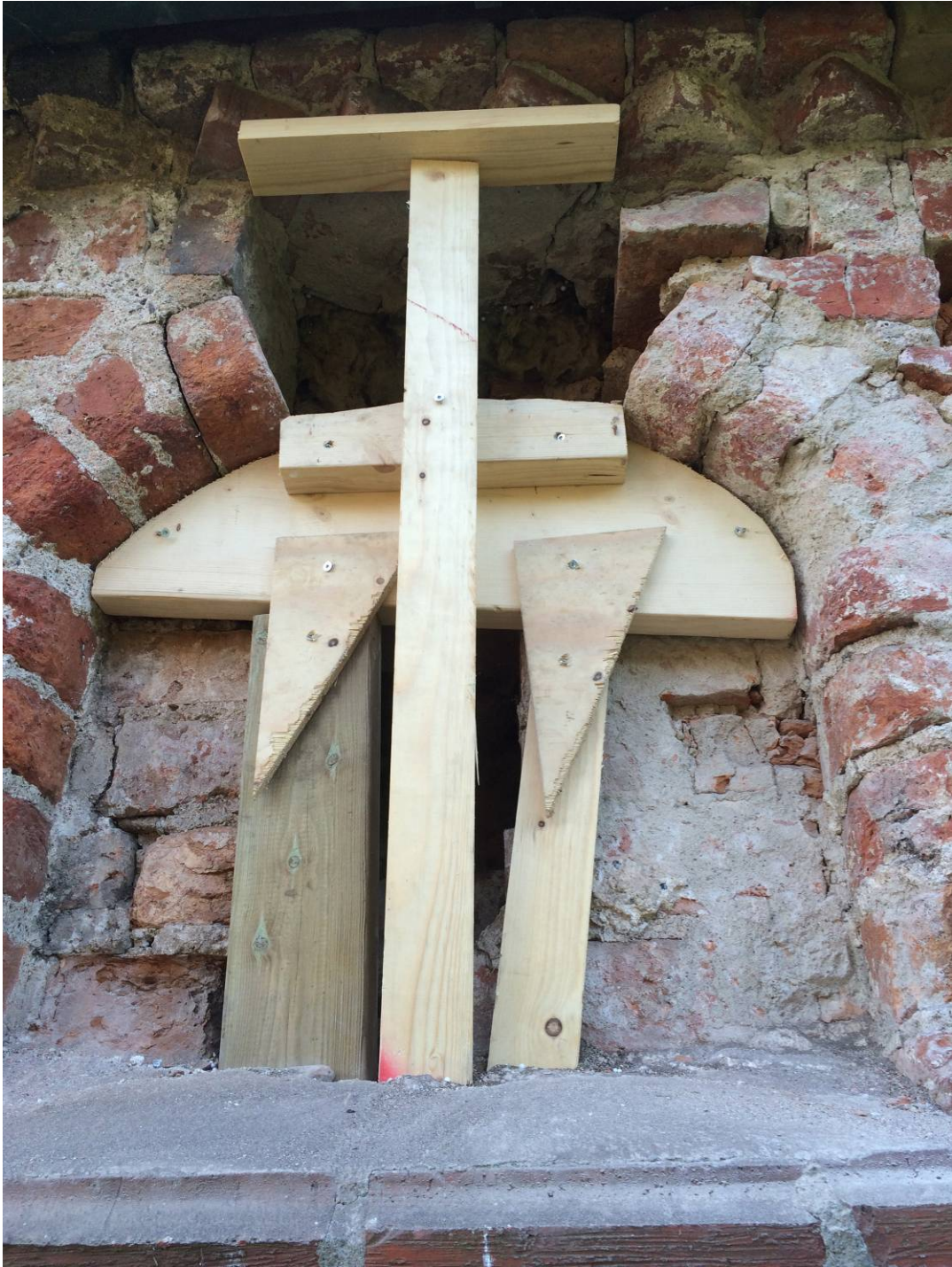
Valv vid blinding under arbete.
