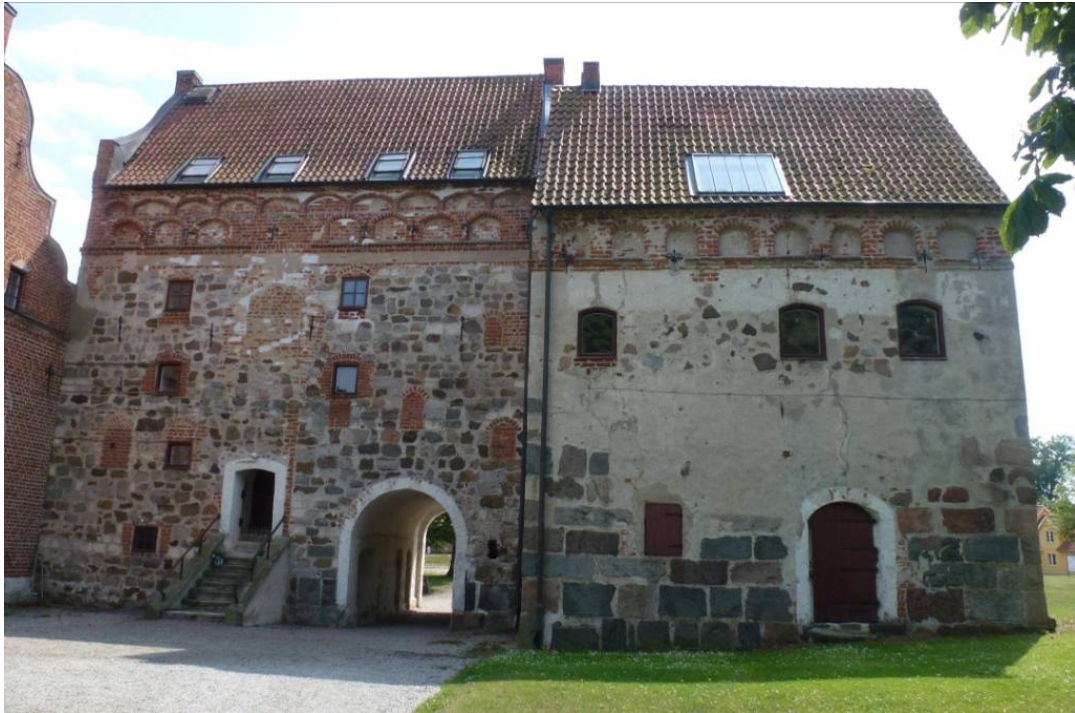
Figur 3. Före åtgärder. Norra fasaderna.
