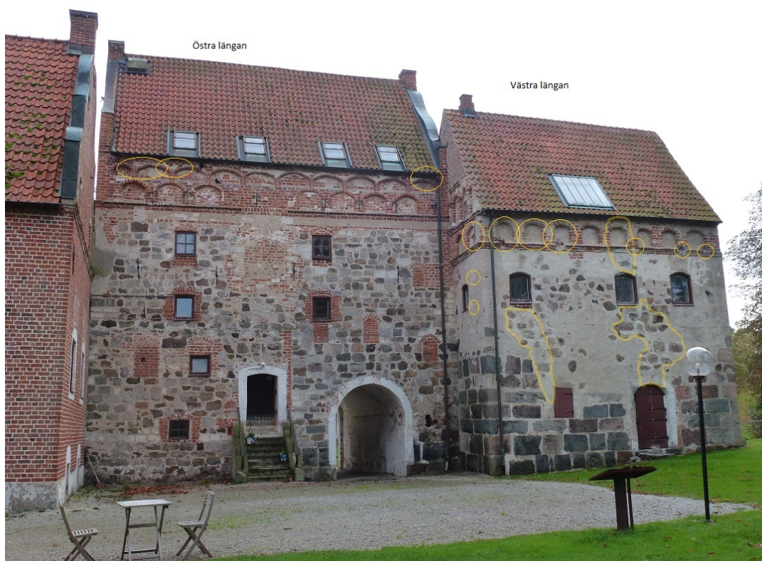
Figur1. Norra fasaden. Ungefärlig omfattning av utförda arbeten markerade.
