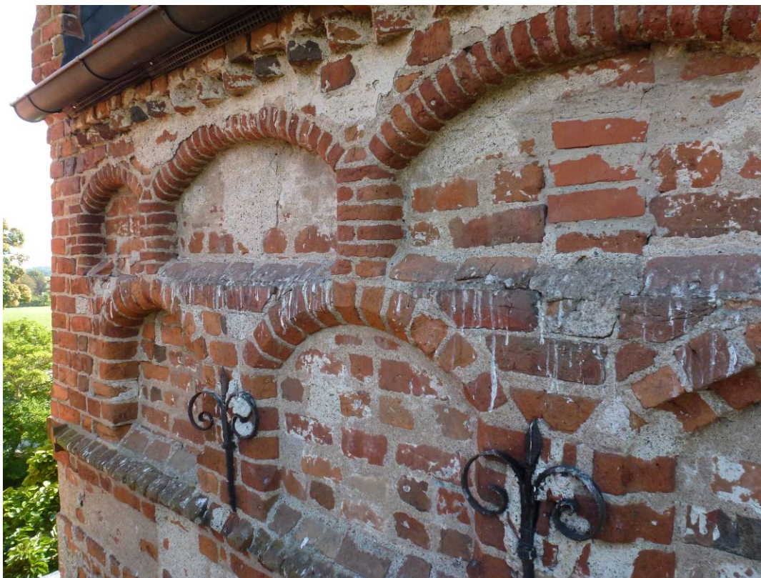
Östra längan. Under arbete. Nordöstra hörnet. Nät har monterats under hänggrännan, skruvarna ströks efteråt med färg så att de inte lyser. Fickor i fog och puts ska tätas.
