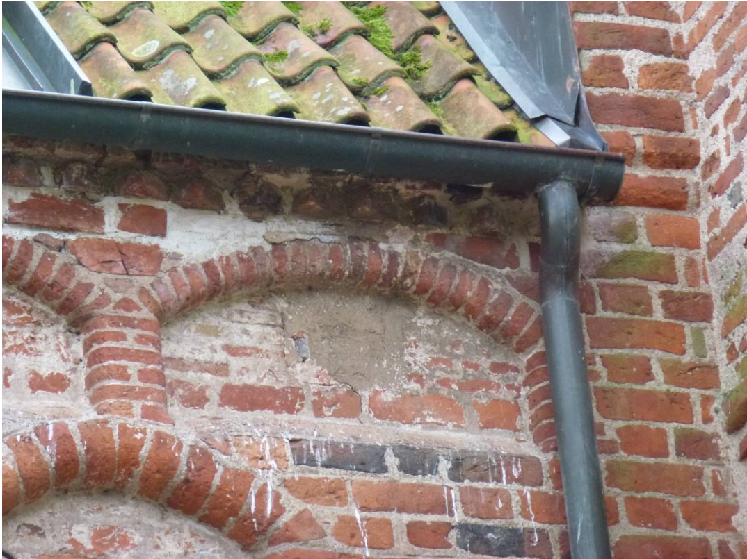
Östra längan. Västra hörnet efter åtgärder. Utrymmet har murats igen med liknande tegelstenar som fanns bevarade vid slottet.
