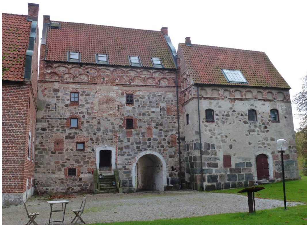
Efter åtgärder. Norra fasaden.
