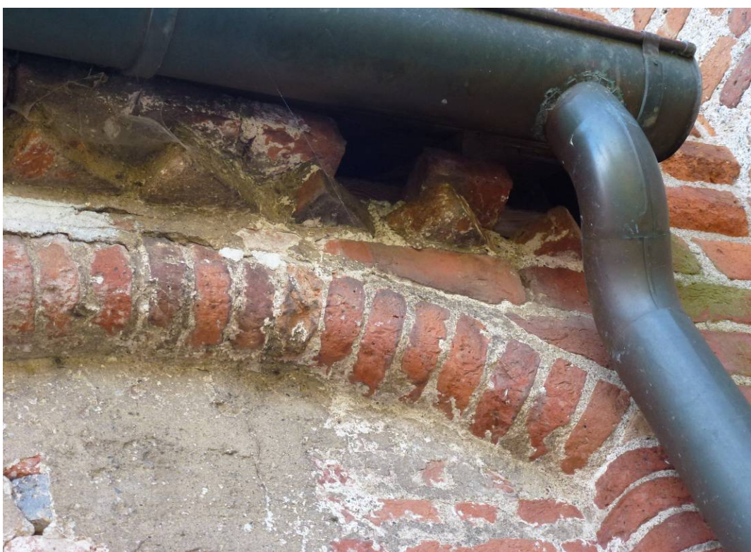
Östra längan. Västra hörnet före åtgärder. Tegelstenar saknades varför fåglar kunde flyga in i stommen. Utrymmet har murats igen med liknande tegelstenar som fanns bevarade vid slottet.
