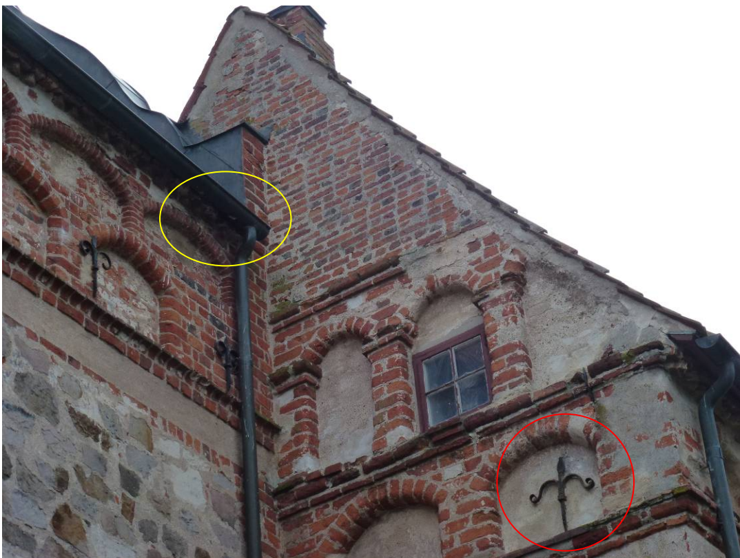
Efter åtgärd. Lagningar med bruk vid markering. Vid gul cirkel har ett par tegelstenar murats i takfoten där stenar saknades.
