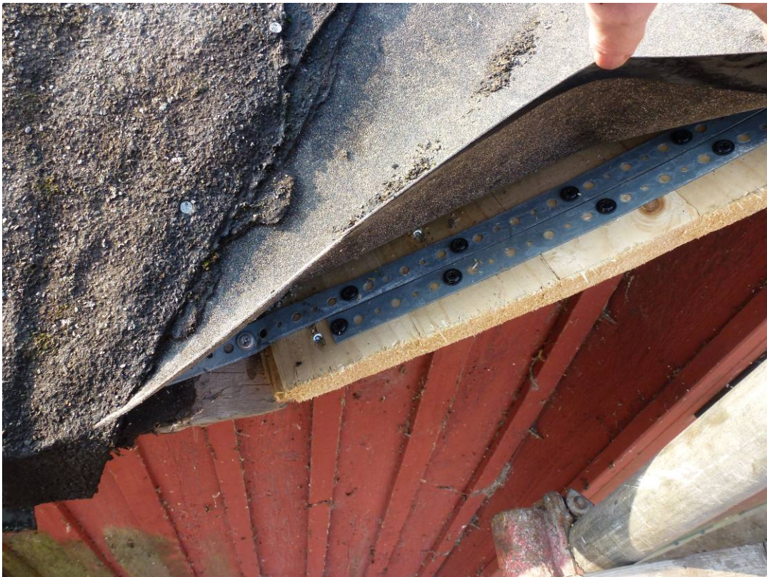
Figur 6. Homejans nya uppbyggnad är förstärkt med spikband.
