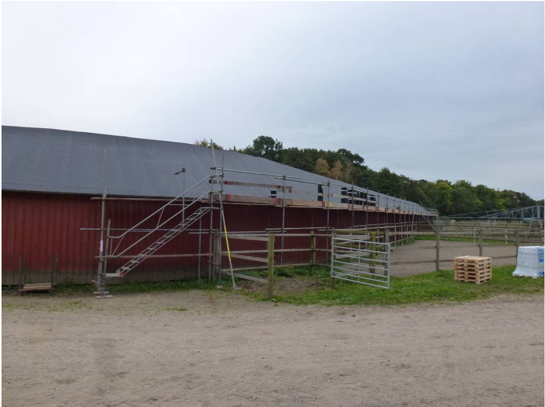
Figur 21. Efter åtgärder. Västra långsidan.
