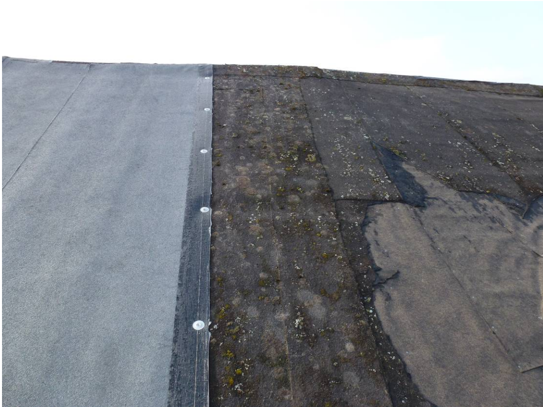
Figur 13. Under arbete. Ny papp är lagd omlott med en 12 cm från skiffer frilagd kant skruvad i råsponten. Följande våd täcker den skruvade kanten. Den gamla pappen är helklistrad medan den nya endast är fäst i kanterna.
