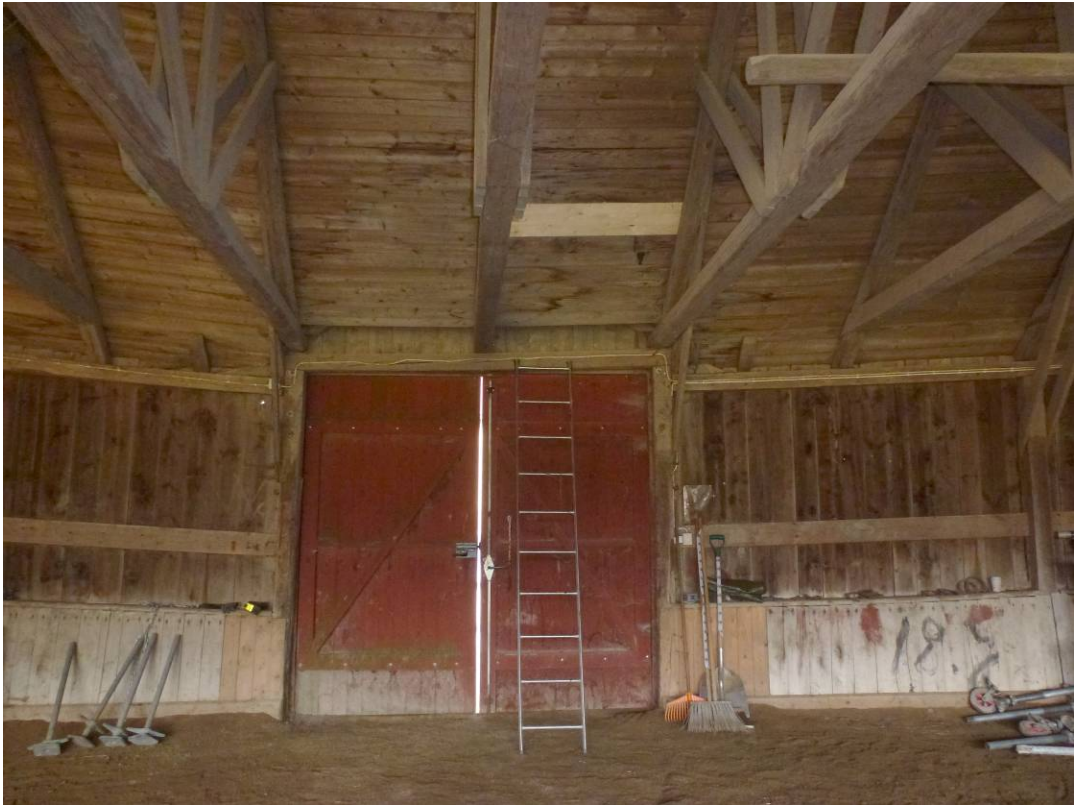
Figur 7. Råspont ersatt i anslutning till entrén, de nya brädorna är ljusare.
