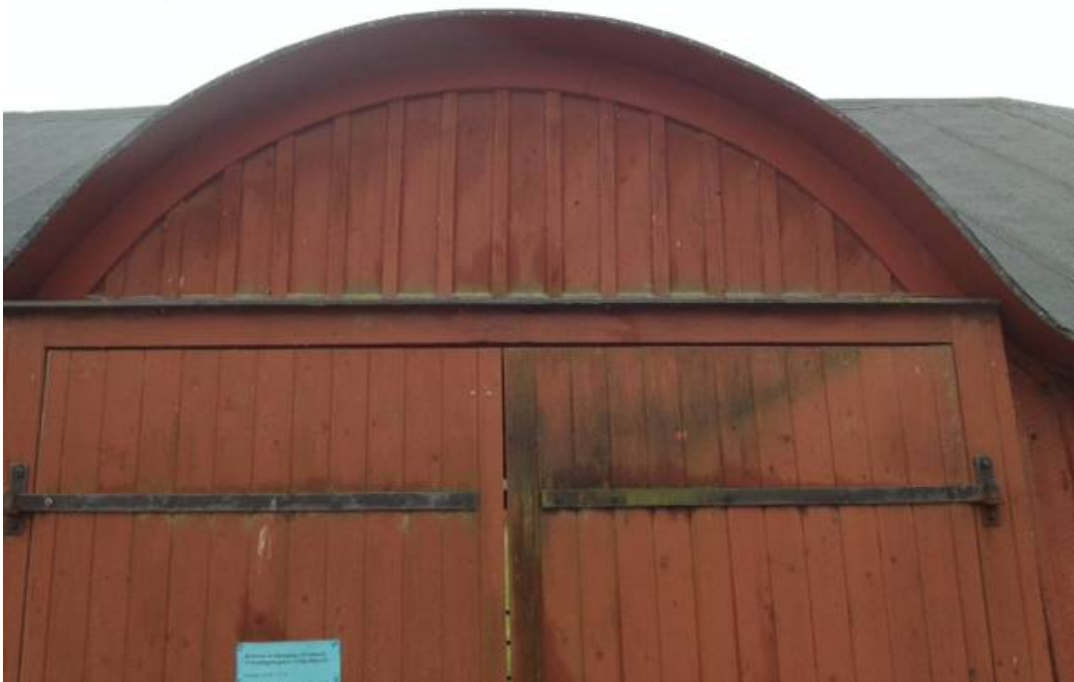
Figur 20. Efter åtgärder. Homejan med målad råspont.
