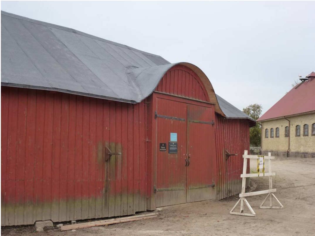
Figur 19. Efter åtgärder. Homejan har täckts med en separat våd i rännalden för bästa avrinning. Den nya råsponten är ännu inte målad.
