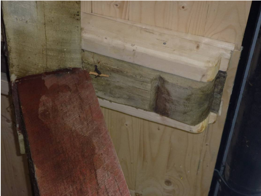
Figur 9. De förstärkta taksparrarna har utformats liknande de gamla taktassarna.
