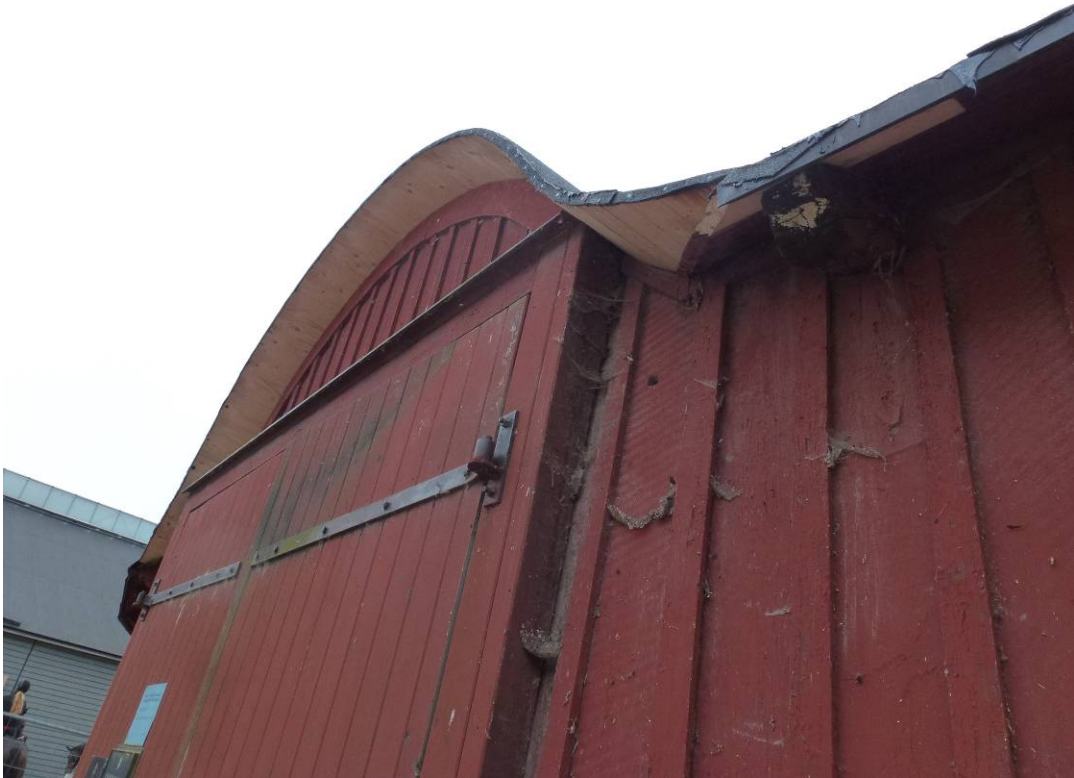
Figur 18. Efter åtgärd. Ny råspont i uppbyggnad av homejan samt ovan taksparren. Plåten är korri- gerad för bättre täckning över taktassen. Den nya råsponten är ännu inte målad.
