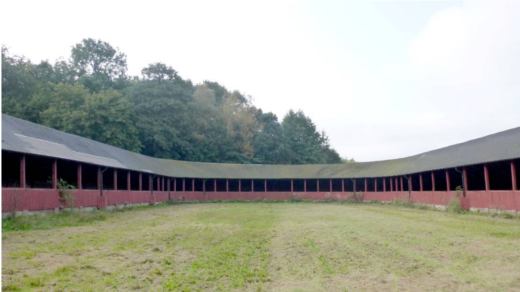
Figur 4. Före åtgärder. Täckta rastbanan insidan, vy mot söder från entrén.
