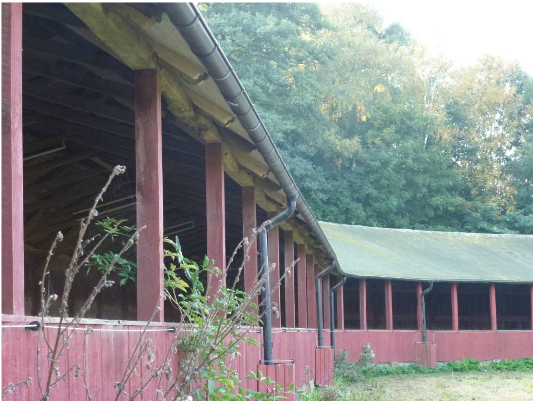
Figur 10. De förstärkta taksparrarna sett från gräsplan i mitten. Pappen på takfallet till höger i bild är ännu inte ersatt.
