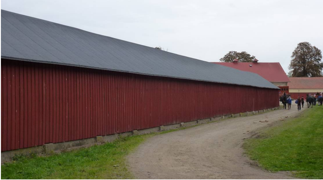
Figur 17. Efter åtgärder. Östra sidan.
