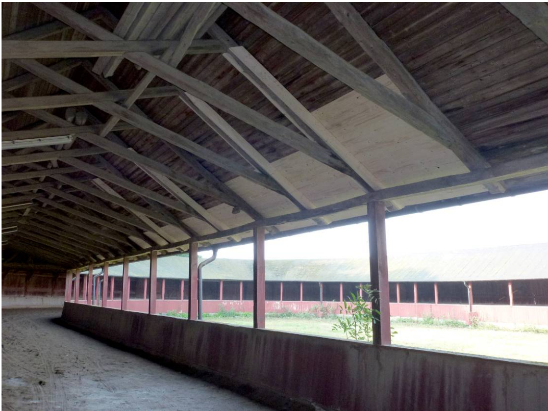
Figur 8. Ersatt råspont och fyra förstärkta taksparrar på den östra långsidan.
