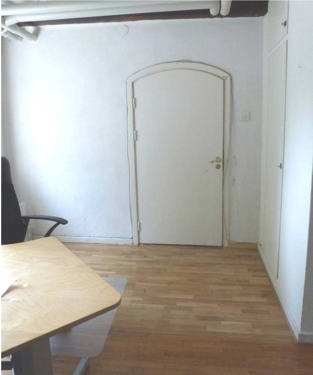
Efter åtgärder. Kontoret. Väggen har säckskurats och avfärgats. Golvet har kompletterats med ny parkett.
