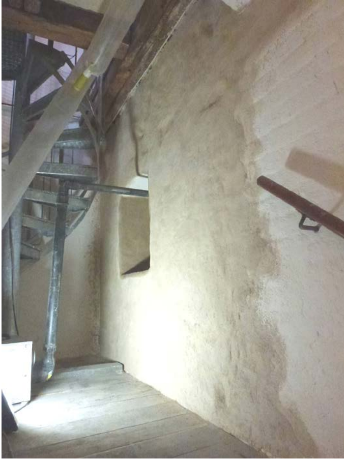
Under arbete. Västra väggen. Tegelväggen har putslagats.
