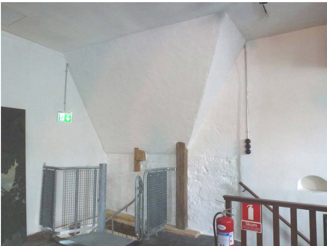
Efter åtgärder. Taket har putsats och avfärgats. Väggen har avfärgats. Den högra vertikala stolpen är ny och stöttar takstolen. Golvplankan är ny och förstärker golvbjälken. I samband med aktuella åtgärder har el dragits om till nya jordade uttag på samma plats som tidigare och ny godkänd utrymningsskylt har monterats.
