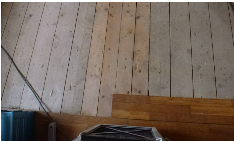
Under arbete. Kontoret. Befintligt parkettgolv från troligen 1970-talet och underliggande golvbrädor.
