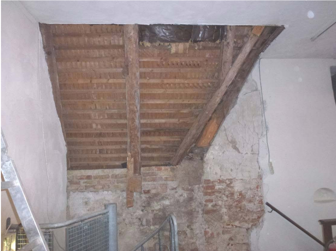
Under arbete. Takstolen längst till höger i bild har skarvats i nedre delen. Fyra till fem tegelvarv har murats på på muren för att ge stadga åt övriga takstolar.
