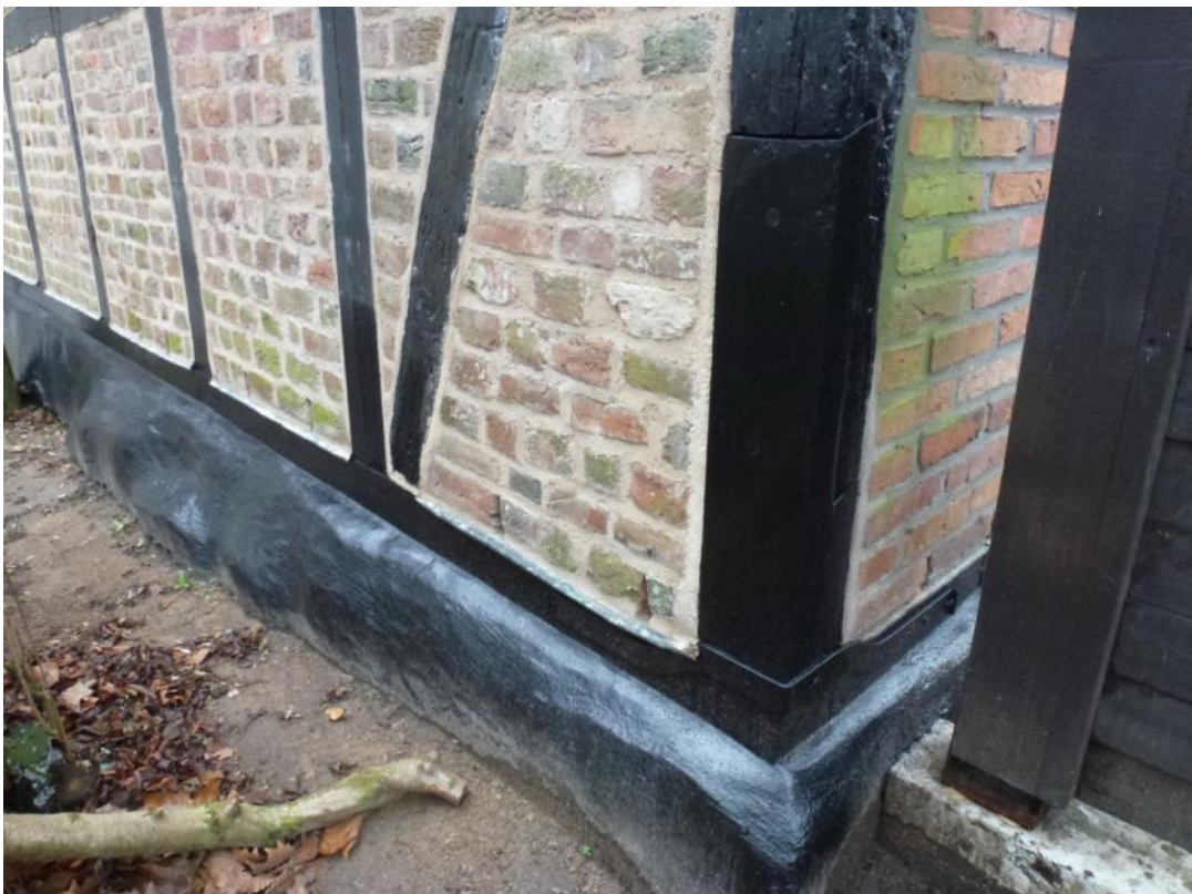
Efter åtgärder. Nordöstra hörnet. Hörnstolpen är skarvad halvt i halvt och fäst med två dymlingar samt med tapp i syllen. Syllen är ersatt även kring hörnet till höger i bild.
