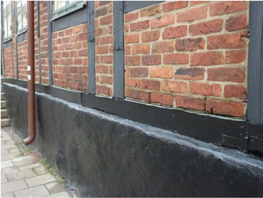
Efter åtgärder. Södra fasaden. Grunden är avfasad, lagad och avfärgad kring hela huset.
