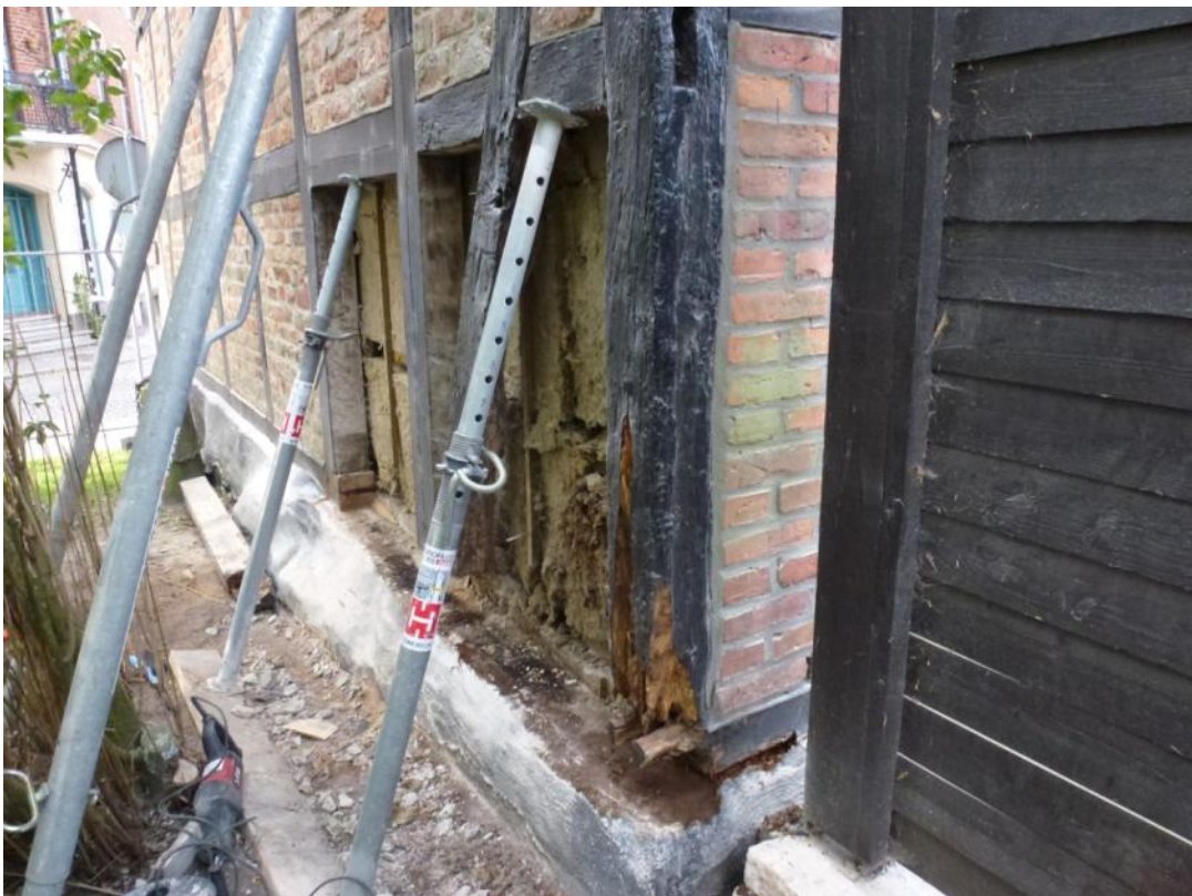
Under arbete. Nordöstra hörnet. Syllen är borttagen.
