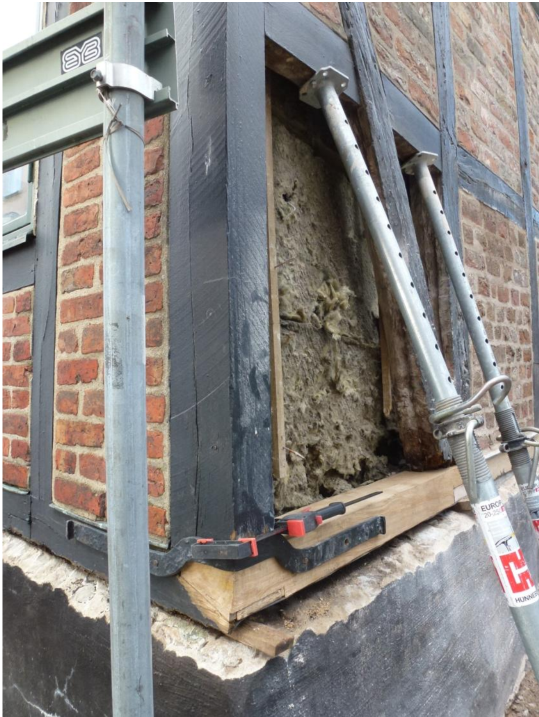
Under arbete. Sydöstra hörnet. Det nya virket är något klenare än befintligt för att ge plats åt det avjämnande bruket på grunden. Det nya virket har handbilad utsida.
