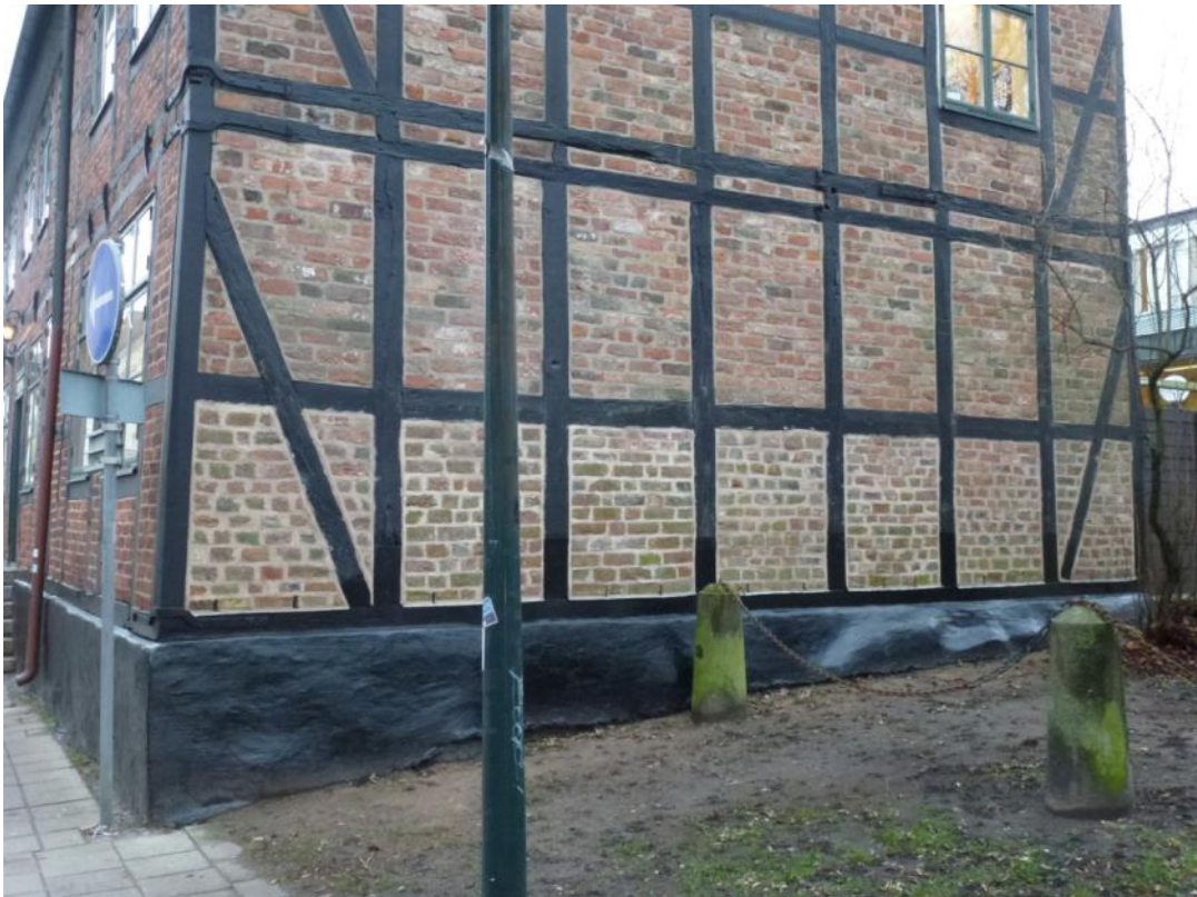
Efter åtgärder. Sydöstra hörnet och östra fasaden.
