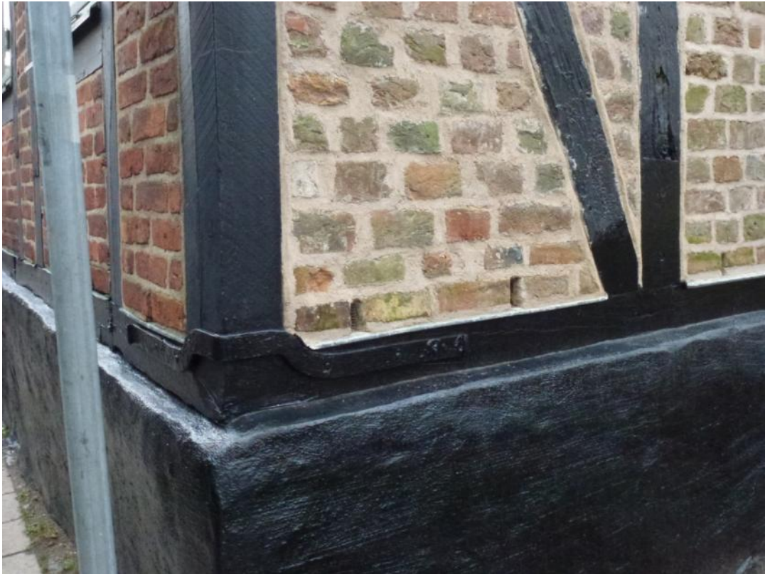
Efter åtgärder. Sydöstra hörnet. Syllen och nedre delen av stolparna till höger i bild är ersatta och strukna med linoljefärg.
