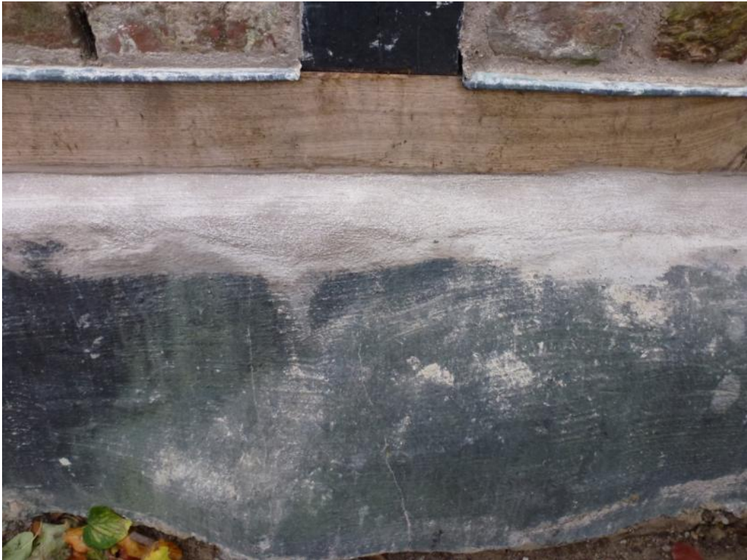
Under arbete. Ersatt syll och återuppmurad fyllning med kopparbleck, diffusionsöppning samt avjämnad grund.
