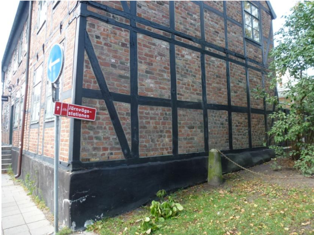
Före åtgärder. Sydöstra hörnet och östra fasaden.
