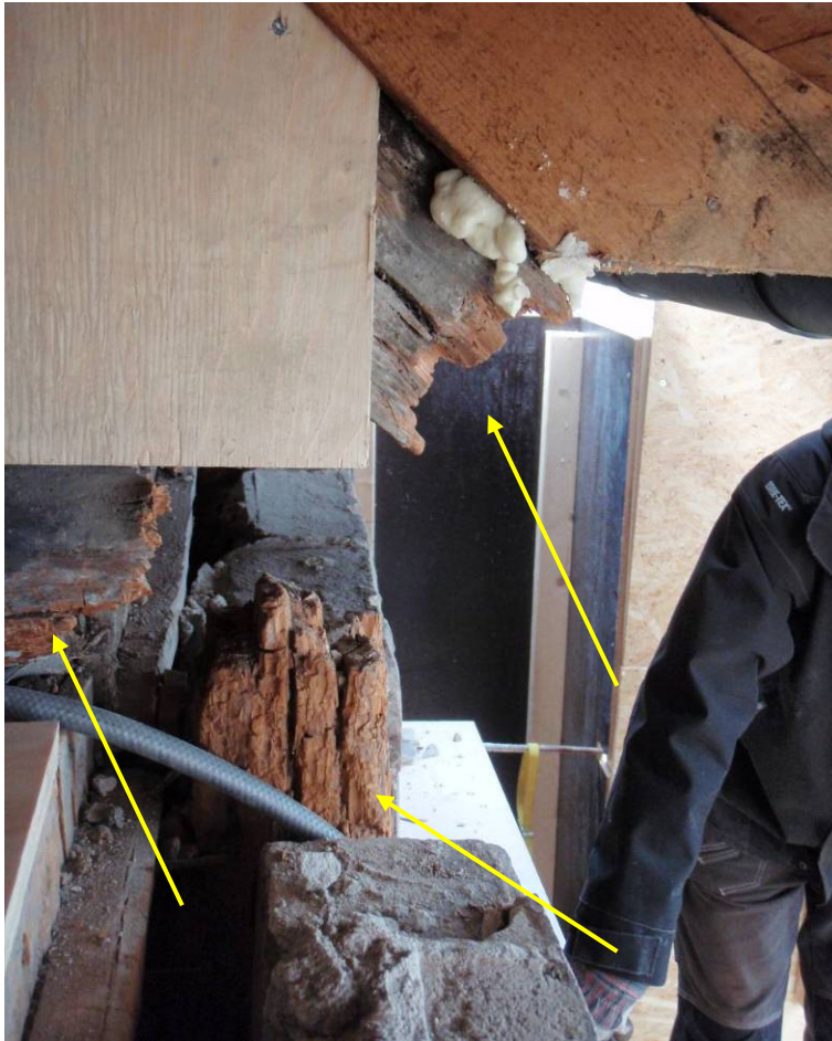
Under arbete. Pilarna visar från vänster på golvbjälke, korsvirkesstolpe och gamla takstolens högben. Foto mot väster med byggställningen till höger i bild, vinkeln i bilden är något förvrängd.
