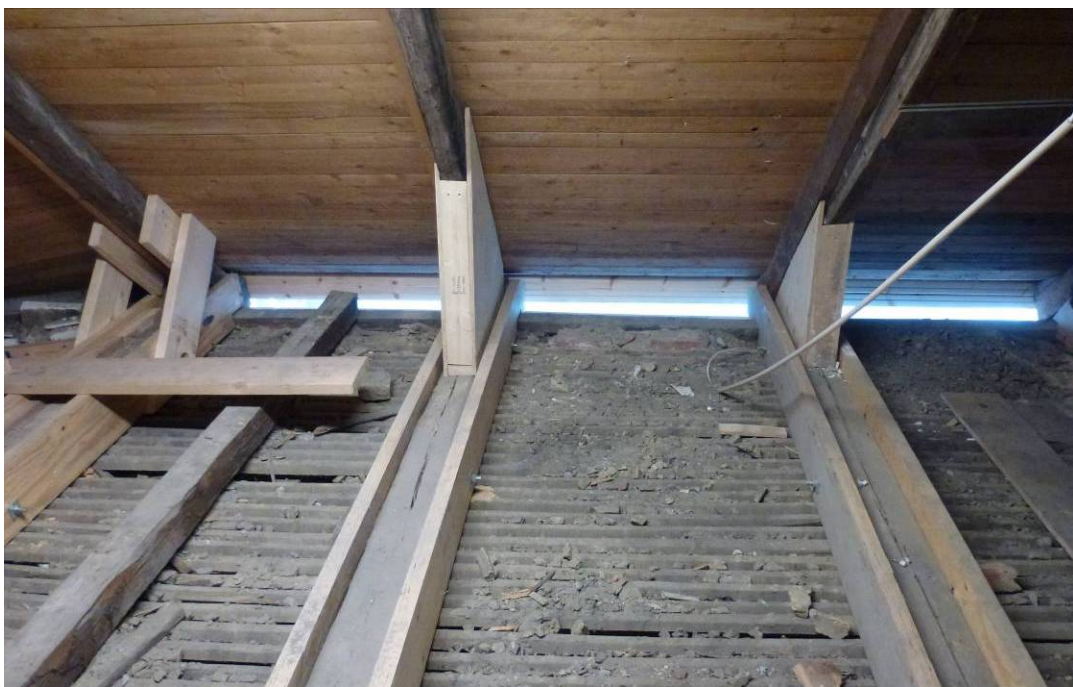
Under arbete. Förstärkta golvbjälkar. Bjälken längst till vänster i bild har försetts med de nya stödbenen. Här ser man också ribborna som är spikade under golvbjälkarna. Isoleringen var knapp och har här städats från lös lera medan den lera som finns mellan ribborna lämnades kvar. Vy mot gården i söder.
