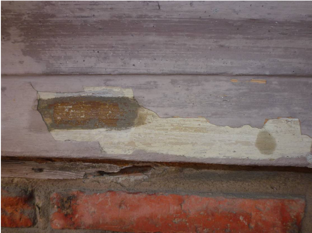
Färglager på den gamla befintliga gesimsen mot öster. Under gesimsen skymtar även den gula fasadfärgen från när huset var putsat.
