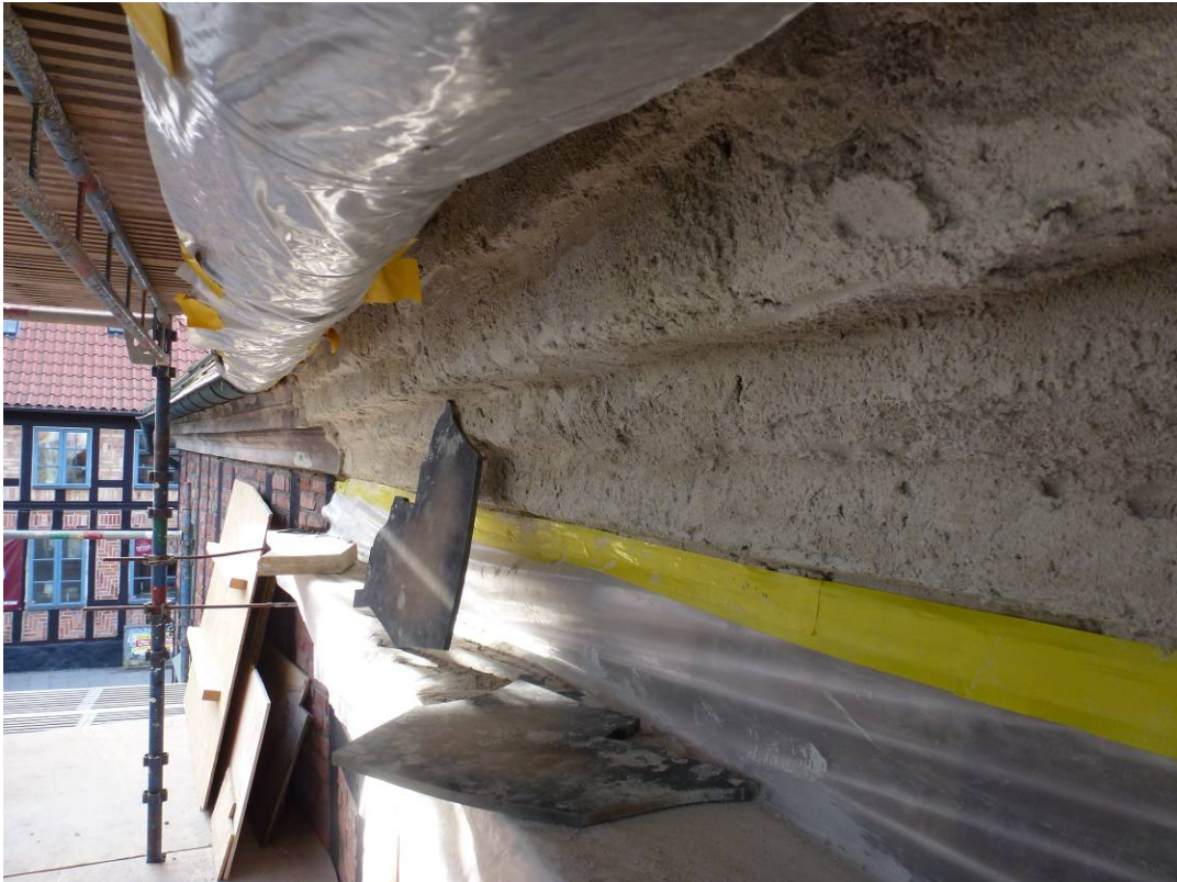
Under arbetet. Grundningen till gesimsen är utförd och profilmallen tillverkad.
