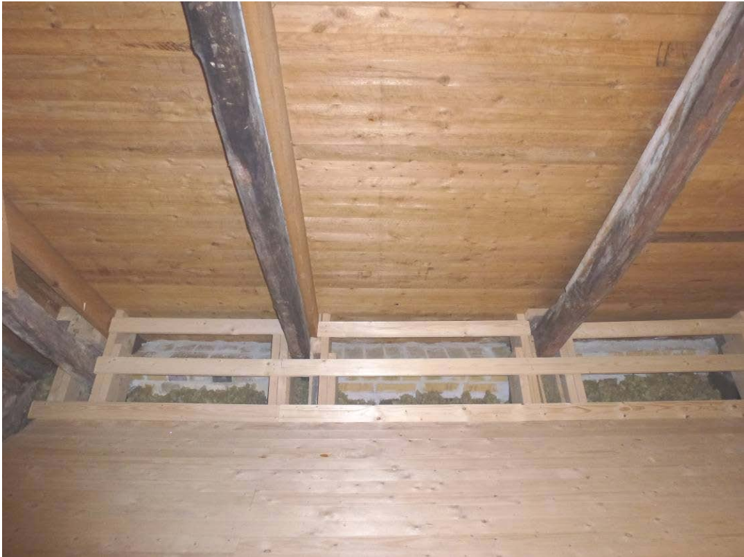
Efter åtgärder. Mot norr. Nytt golv, stödbenen mot takstolarna, nyuppmurad gesims.
