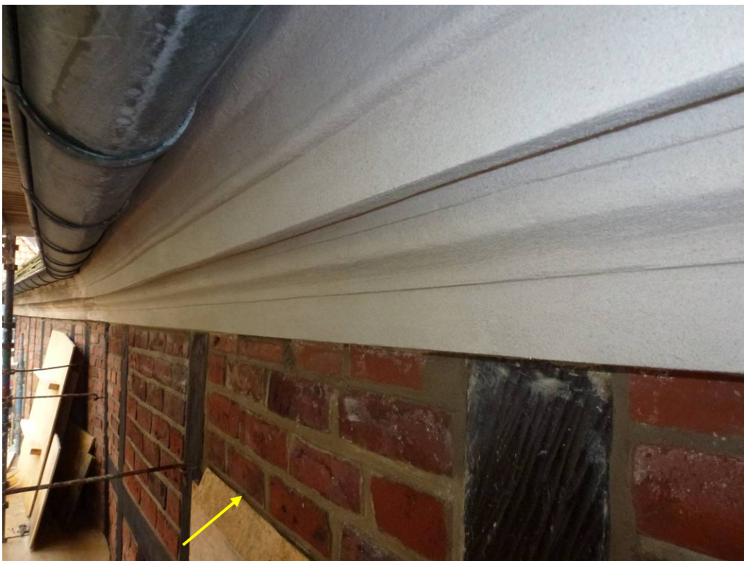
Efter åtgärder. Den nya gesimsen och det nyuppmurade tegelfacket (markerat med pil). Korsvirkestolpen som ersatts och täckts med ny täckbräda längst till höger i bild.
