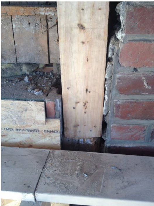
Vänster: Den skarvade stolpen sett utifrån. Till vänster i bild är tegelfacket nerplockat. Höger: Den skarvade stolpen av två plankor sett från sidan, skarvad halvt i halvt med befintlig korsvirkesstolpe.
