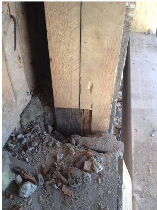
Vänster: Den skarvade stolpen sett utifrån. Till vänster i bild är tegelfacket nerplockat. Höger: Den skarvade stolpen av två plankor sett från sidan, skarvad halvt i halvt med befintlig korsvirkesstolpe.
