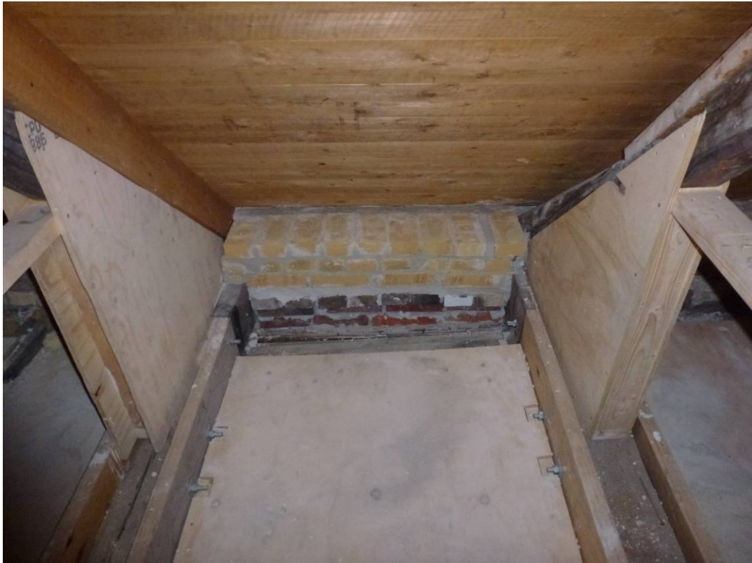
Under arbete. Förstärkta golvbjälkar (plywoodskivorna är tillfälliga) och nyuppmurad takfotsgesims mot norr.
