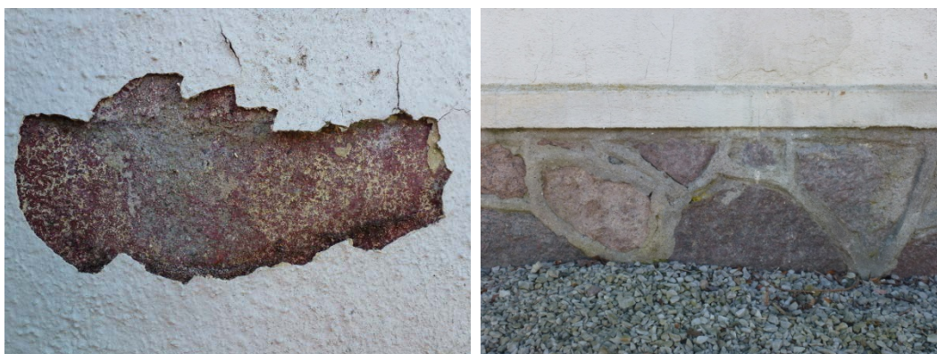
Figur 13. Vänster: Under dagens ljusgula fasadfärg finns spår av mörkare gul kalkfärg och underst röd kalkfärg. Höger: Naturstenssockel under bostadshuset är tidstypiskt för 1800-talets mitt.
