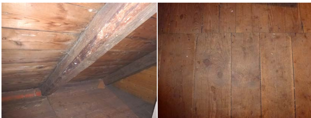
Figur 28. Vänster: Vind 206. Takstolsparrar och i takvinkeln syns den murade takfoten. Höger: Olika bredder på golvplankorna indikerar på tidigare trappuppgång och de breda brädorna är nötta.
