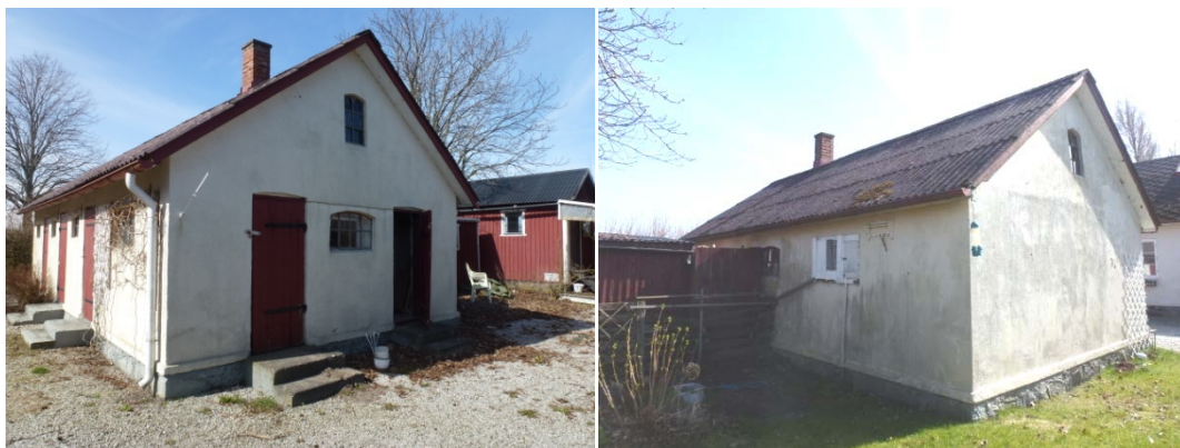
Figur 30. Vänster: Ekonomibyggnadens södra och östra gavelfasaden. Höger: Norra och västra gavelfasaden.
