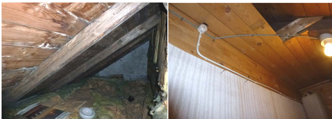
Figur 19. Vänster: Vindsutrymme med sågade takstolar. Höger: Tapet på brädvägg samt el i vindsutrymme.
