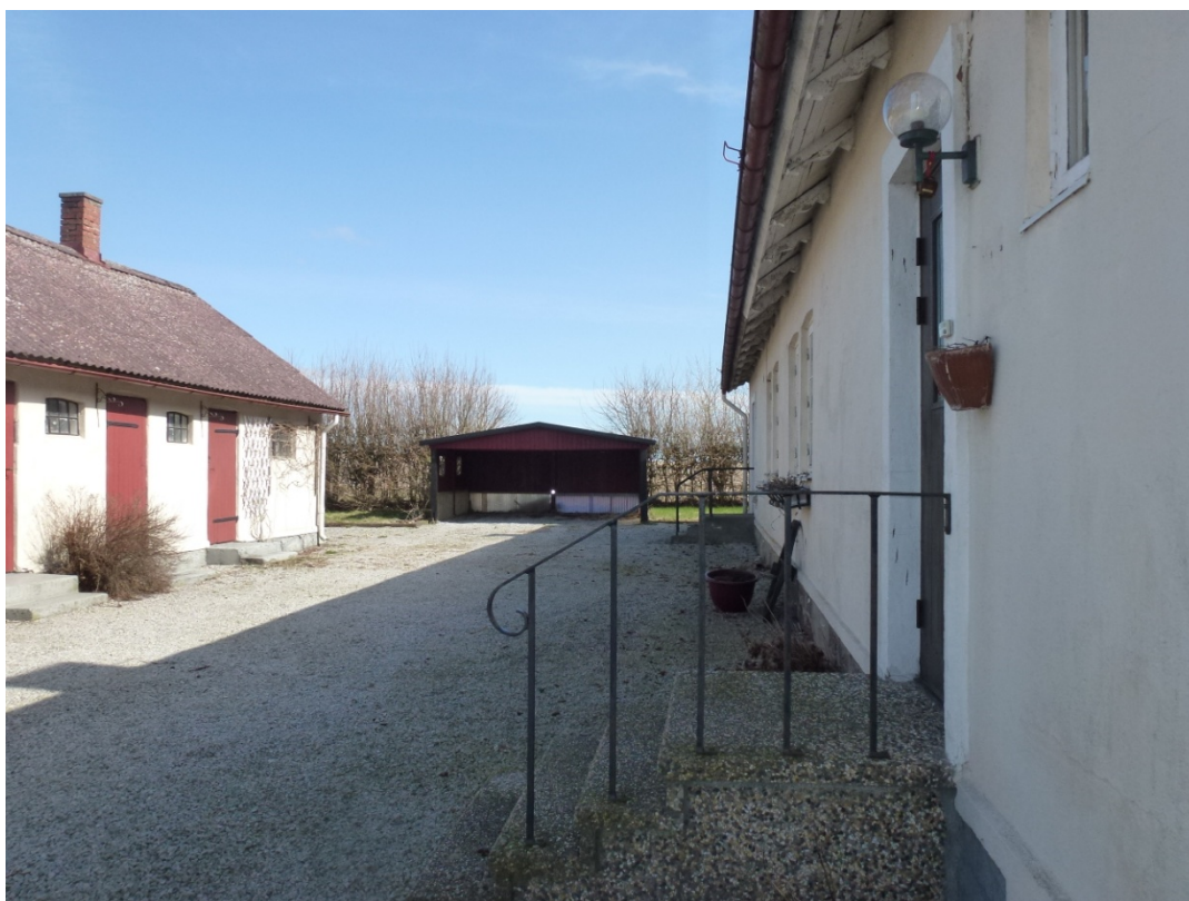
Figur 5. Bostadshuset till höger i bild hade ursprungligen en dörr från varje lägenhet ut mot gårdsplan och ekonomibyggnaden till vänster i bild. Vy mot nordost.
