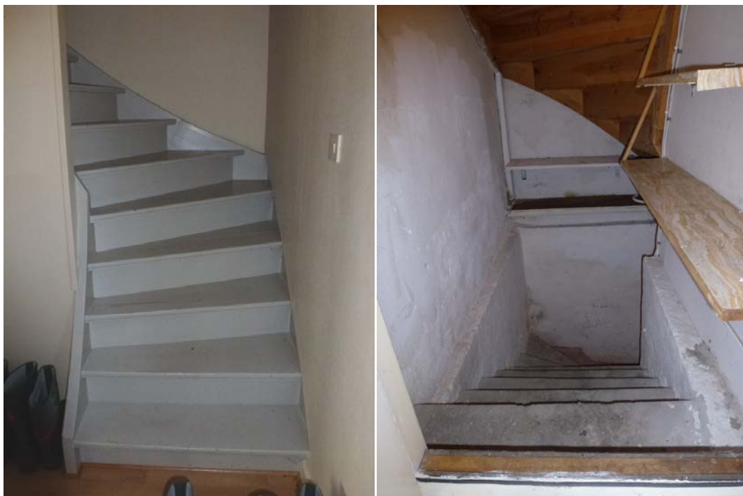
Figur 23. Vänster: Vindstrappan. Höger: Gjuten trappa till källaren, i taket ser man undersidan av vindstrappan.
