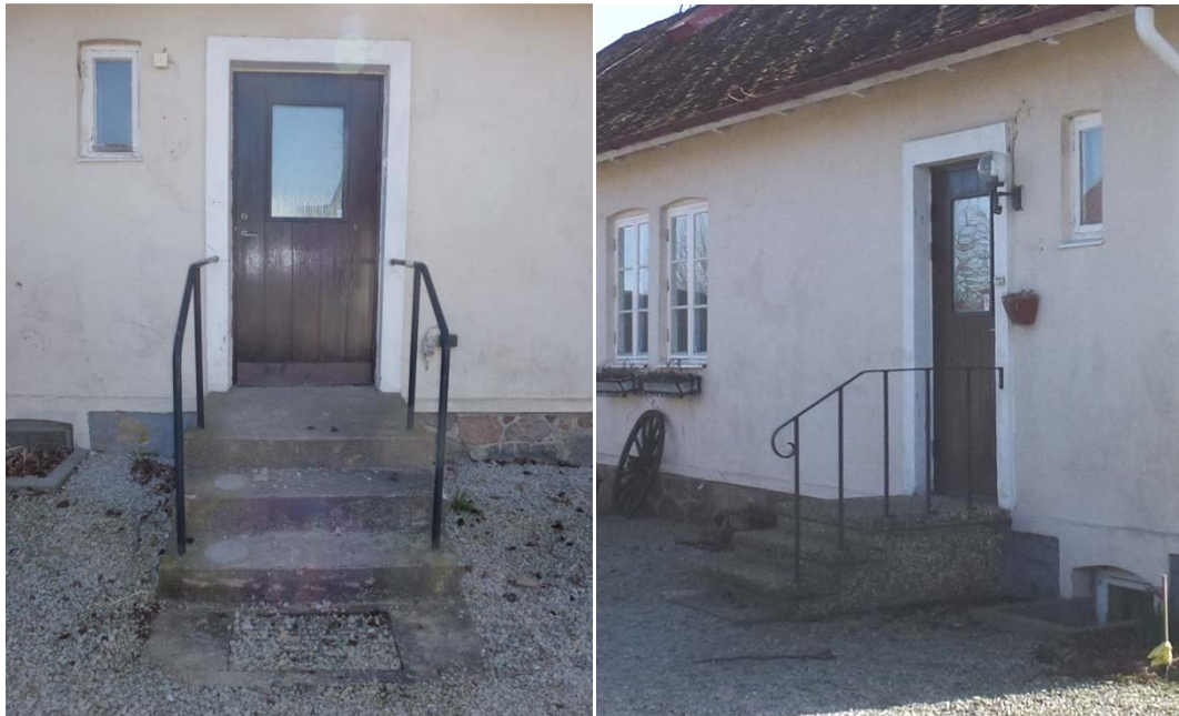
Figur 15. Vänster: Den nordöstra trappan, troligen platsgjuten vid 1900-talets mitt. Trappan är gjuten med nedsänkt galler i markplan och ett enkelt svartmålat järnräcke. Se även källarfönstret till vänster i bild där marken är urgrävd med gjuten kant samt det lilla enluftsfontret till badrummet. Sockeln är målad mot hörnen på norra fasaden och i övrigt omålad natursten, se de olika utförandena på var sida om trappan. Höger: den nordvästra entrén. Trappan är ersatt under senare delen av 1900-talet med en prefabricerad gjuten trappa med synlig ballast. Svart smidesräcke på en sida.
