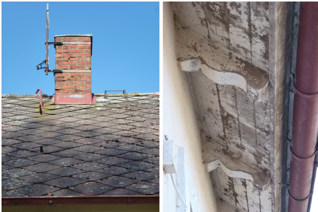
Figur 14. Vänster: Södra takfallet med skorsten och äldre luftningsrör. Höger: kontursågade taktassar i takfoten tidstypiskt för nationalromantiken vid mitten av 1800-talet men även för arkitekturstilar kring sekelskiftet 1900.
