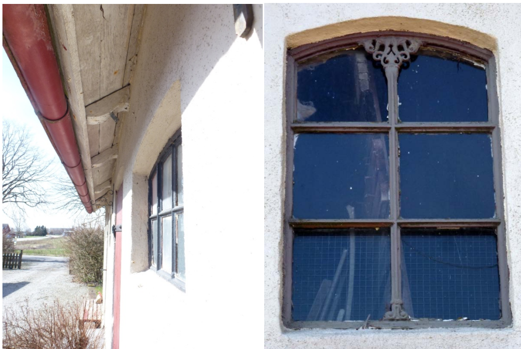
Figur 31. Vänster: Takfot med kontursågade taktassar. Vy mot väster. Höger. Gjutjärnsfönster i östra gaveln, dekorativ mittpost, en detalj i nationalromantisk stil.
