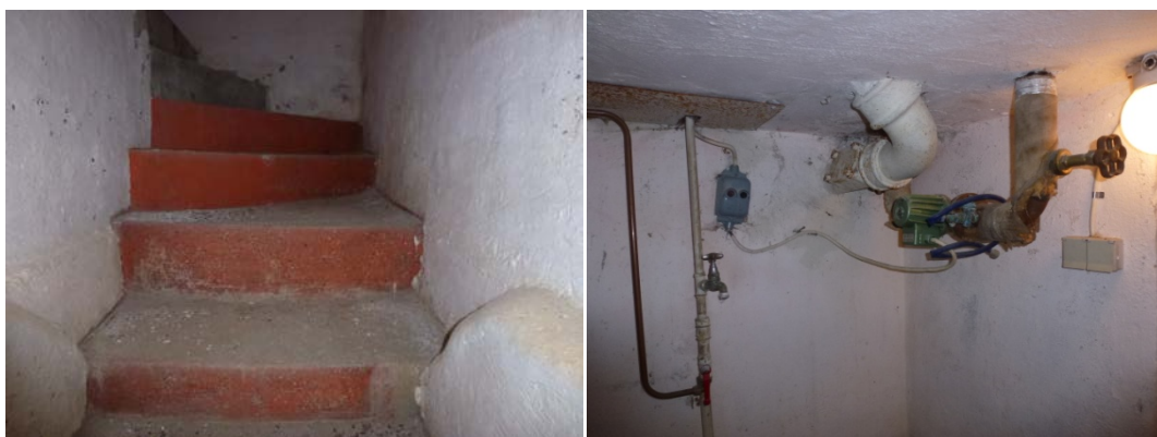
Figur 24. Vänster: Källartrappans nedersta trappsteg är stänkmålade på orange botten. Ett enkelt sätt att dekorera vardagsmiljön. Höger: I källaren finns äldre avlopps- och vattenrör.
