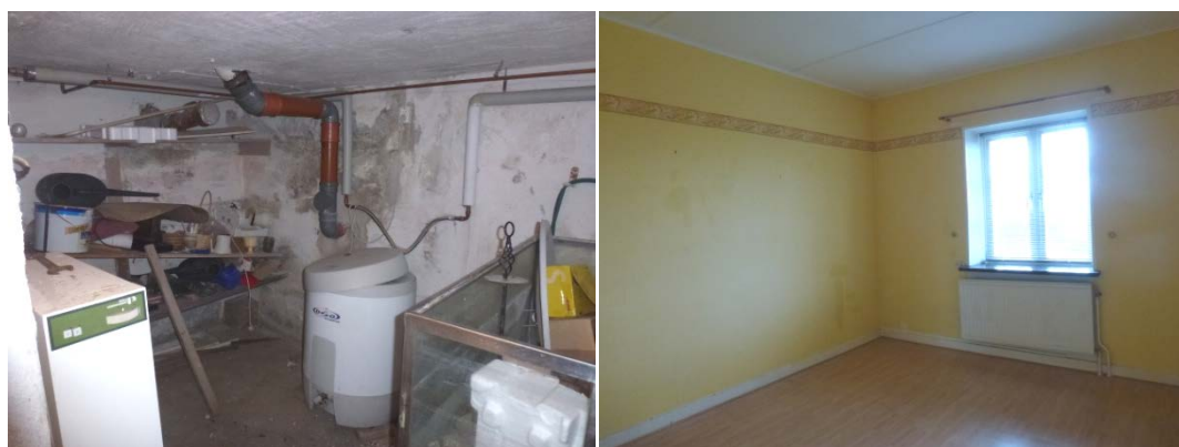
Figur 17. Vänster: Källare 001. Höger: Rum 103 sovrum.
