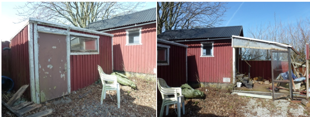
Figur 34. Vänster: Ett litet gårdshus i enkelt utförande klätt med röd locklistpanel. I bakgrunden skymtar förrådet. Höger: Förrådet i röd locklistpanel tak av korrugerad plåt.
