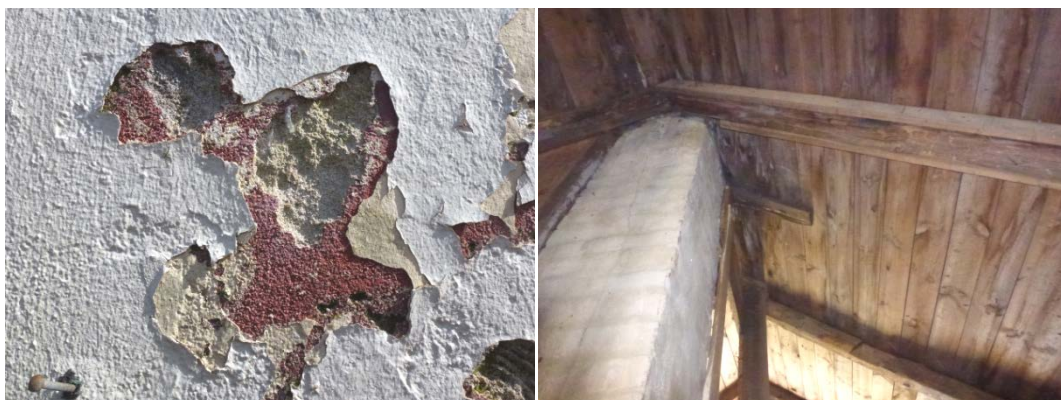
Figur 32. Vänster: Färglager på fasaden. Höger: takstolsparrar, underlagsbrädor och murstock på vinden.
