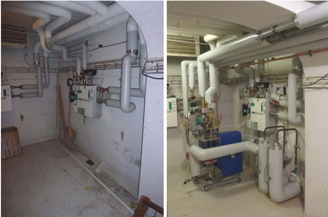
Foto före och efter åtgärder interiör. Nordöstra hörnet.
