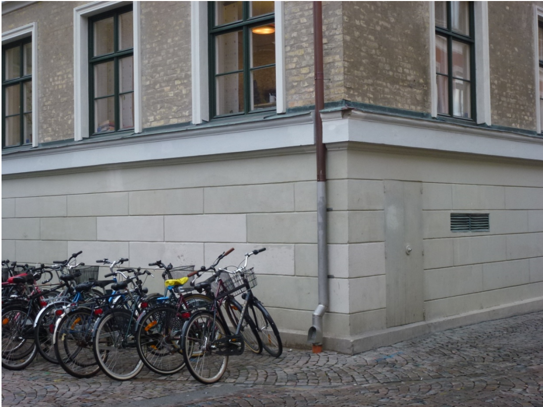
Efter utfört arbete, nordöstra hörnet.
