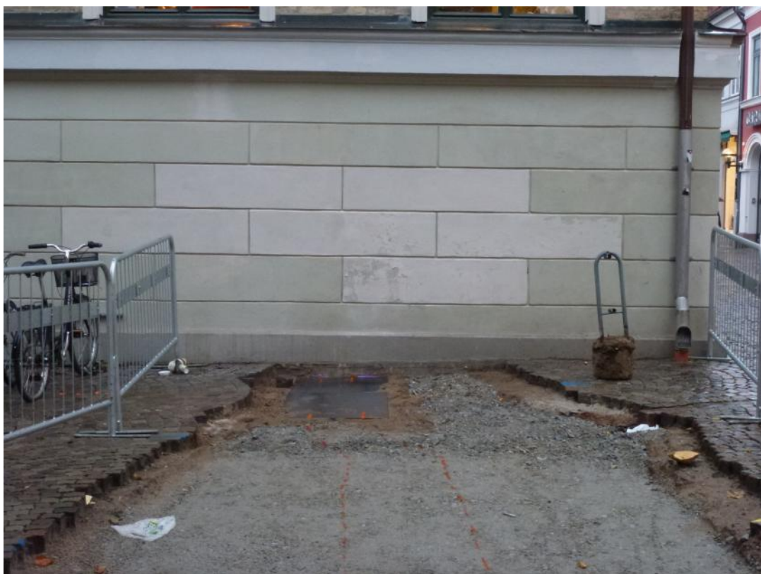
Efter håltagningen och indragningen av kulvert, marken har börjat att återställas.
