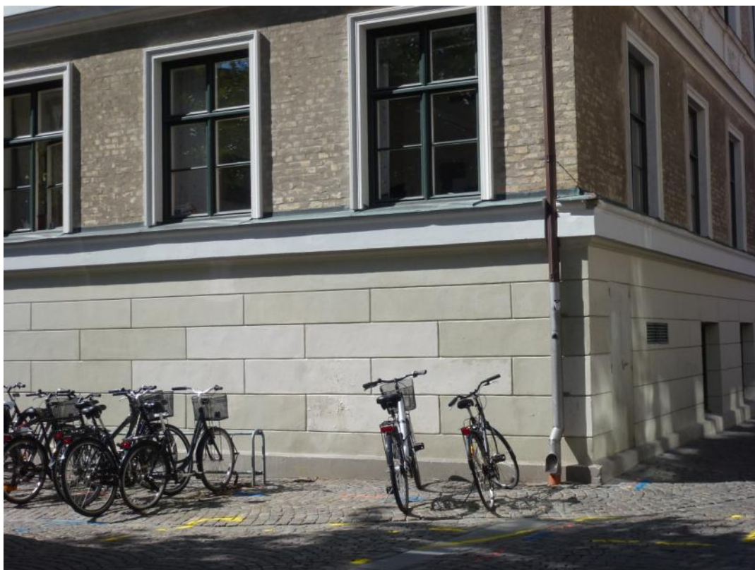
Foto före åtgärder. Nordöstra hörnet.
