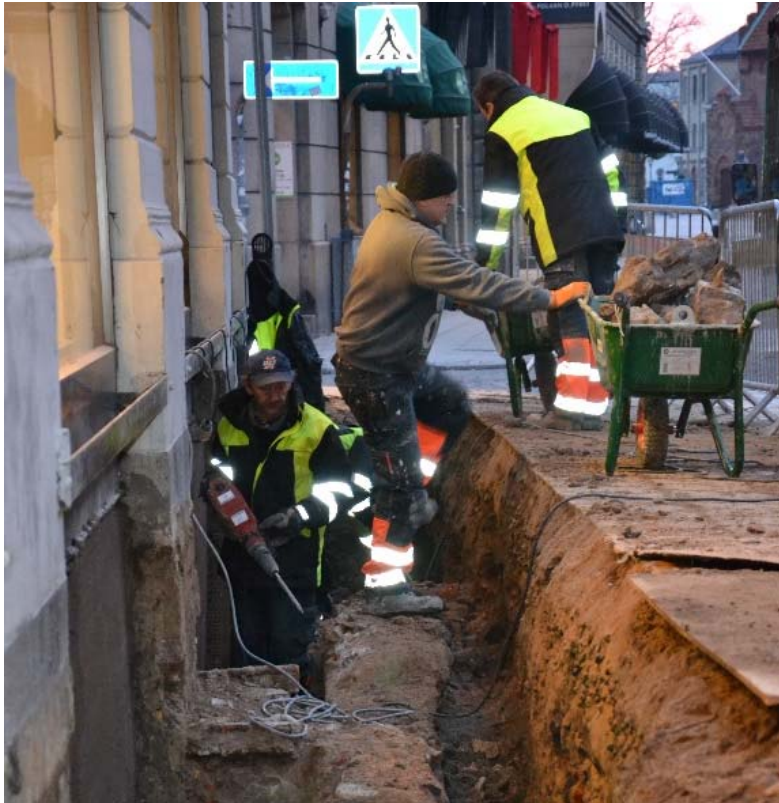
Figur 3. Schakten handgrävdes, delvis med hjälp av bilningsmaskiner då befintliga murar eller kompakta raseringslager framkom.
