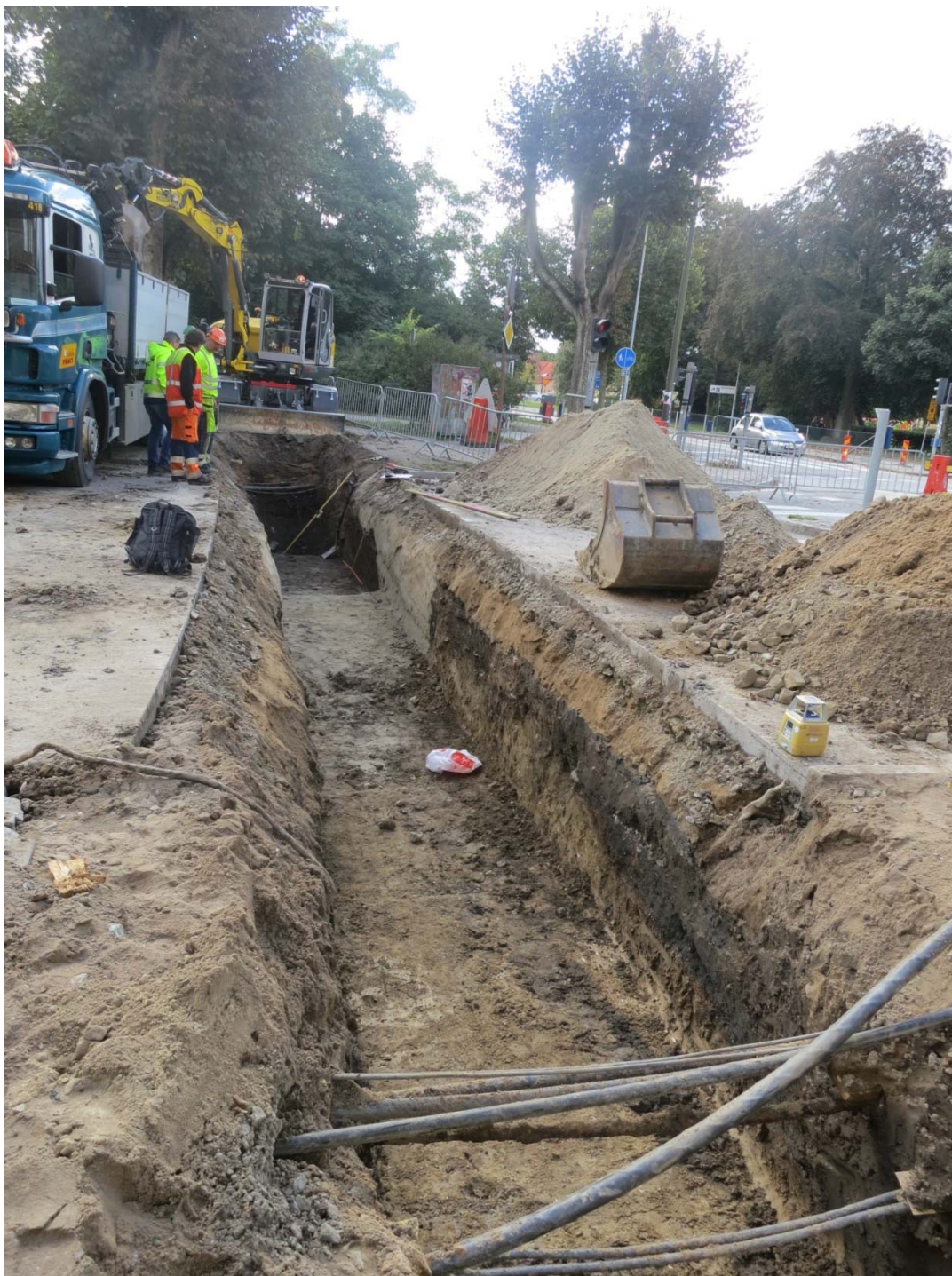
Figur 32. Schaktet tvärs över Södra Esplanaden där bland annat den igenfyllda vallgraven påträffades. Fotografi från norr.
