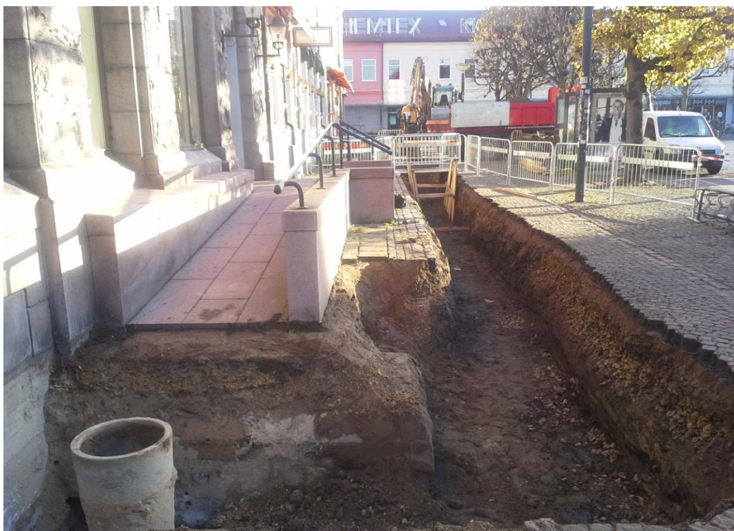
Figur 16. Västra delen av schaktet på Mårtenstorget 5. Fotografiet taget från väster.
