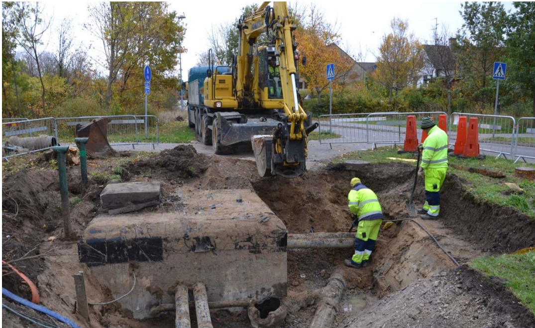
Figur 38. Området för schaktning i samband med fjärrvärmearbeten vid Östratornsvägen 38, Lund. Fotografiet taget från väster.
