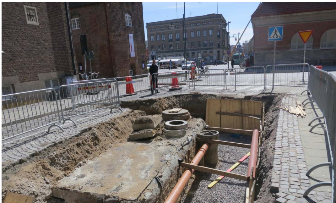
Figur 23. Fjärrvärmeschakt på Svartbrödersgatan år 2013. Fotografiet taget från norr.
