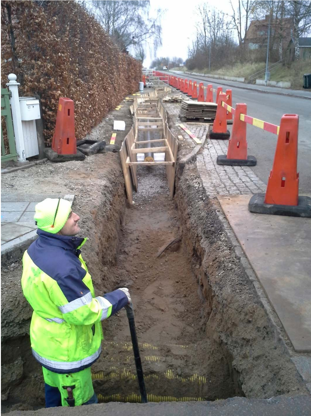
Figur 42. Fotografi över arbetet, taget från väster vid sydvästra hörnet av fastigheten 17:9 med Trollebergsvägen till höger. Fotografiet taget från söder.
