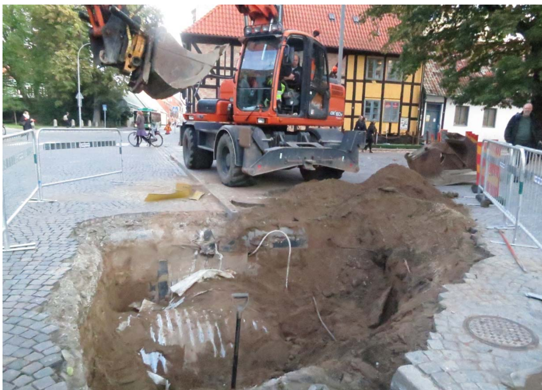
Figur 34. Södra delen av fjärrvärmeschaktet i Kyrkogatan framtaget. Fotografi taget från söder.
