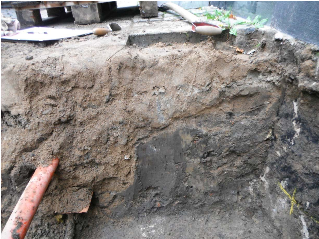
Figur 27. Västra sektion, Stora Fiskaregatan 10 i samband med schaktningsarbete för fjärrvärme år 2012.
