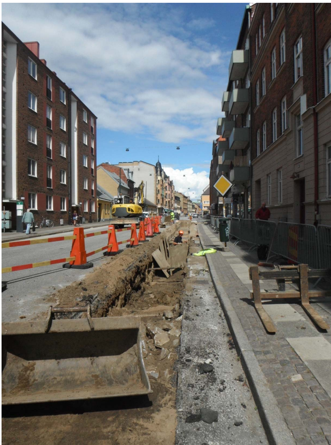
Figur 31. Vy över arbetsområdet längs med Stora Södergatan 61-67. Fotografi taget från söder.
