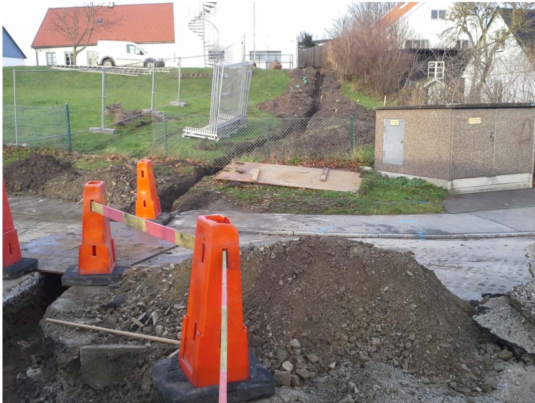
Figur 43. Schaktet i den norra delen av undersökningsområdet, från Bäckerännen till skolan.
