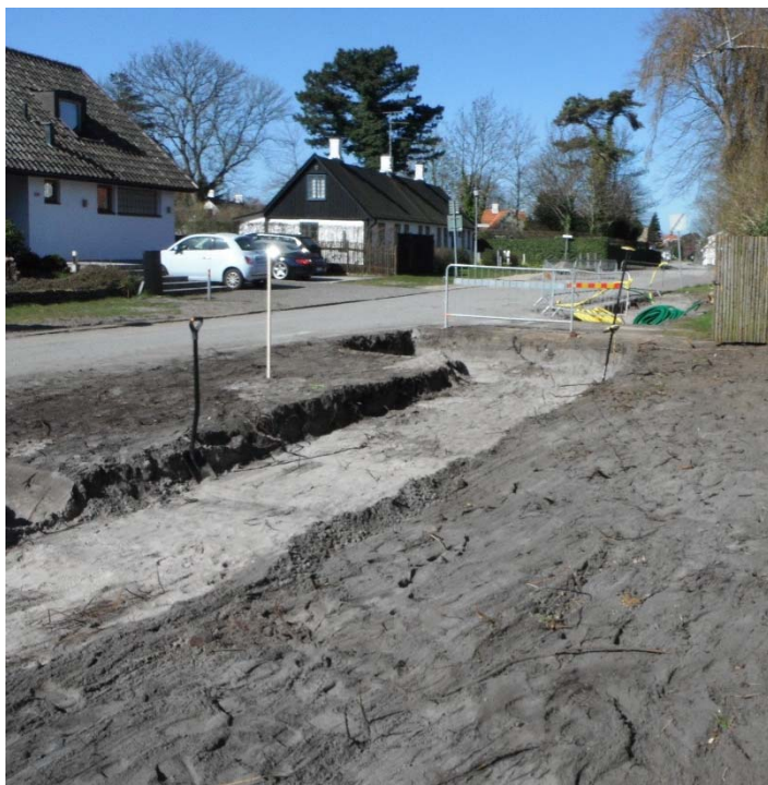
Figur 4. Inledande schaktning för gång- och cykelbana längs Kyrkogatans norra sida.
