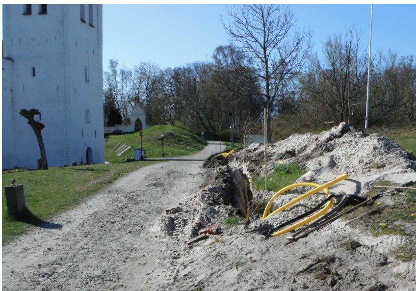
Figur 6. Kabelschakt grävdes i flygsandsdynans kant.
