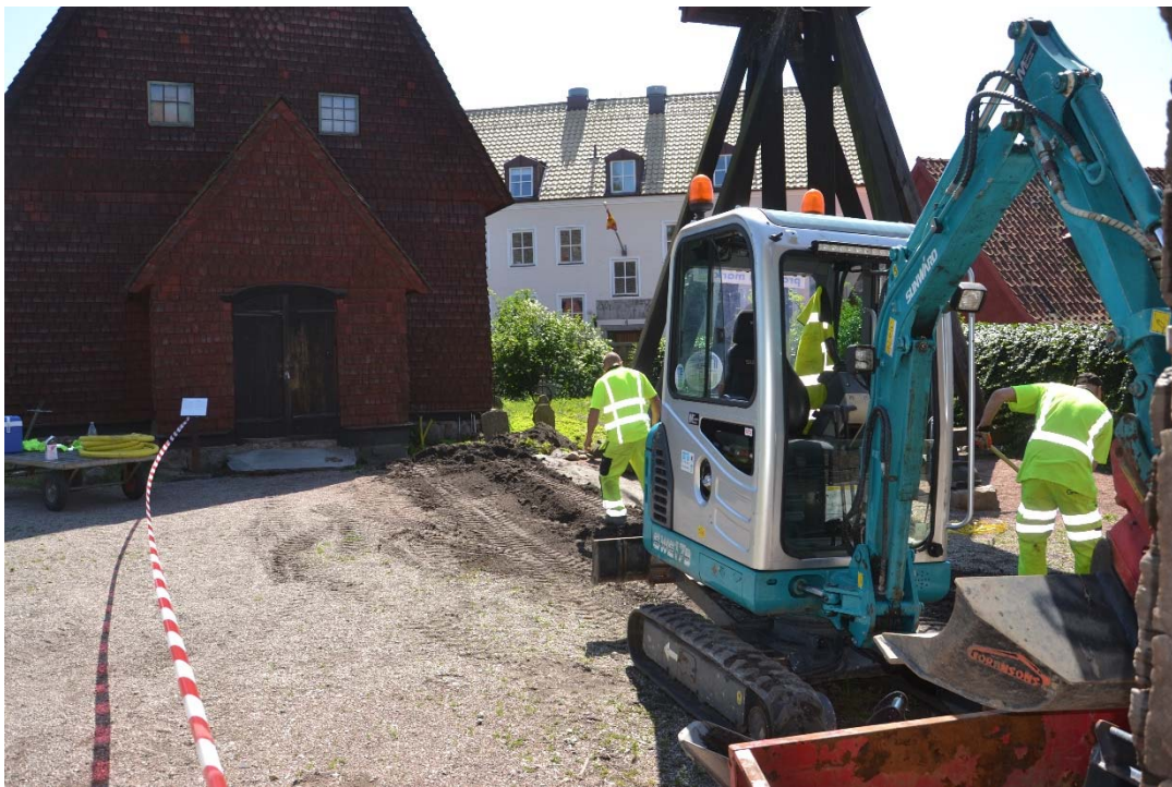
Figur 6. Elkabelschakt mellan Uranäsboden och Bosebo kyrka. Fotografiet taget från nordväst.
