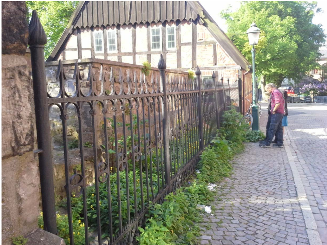
Figur 4. Staket med fundament innan renovering. Fotografiet taget från norr.
