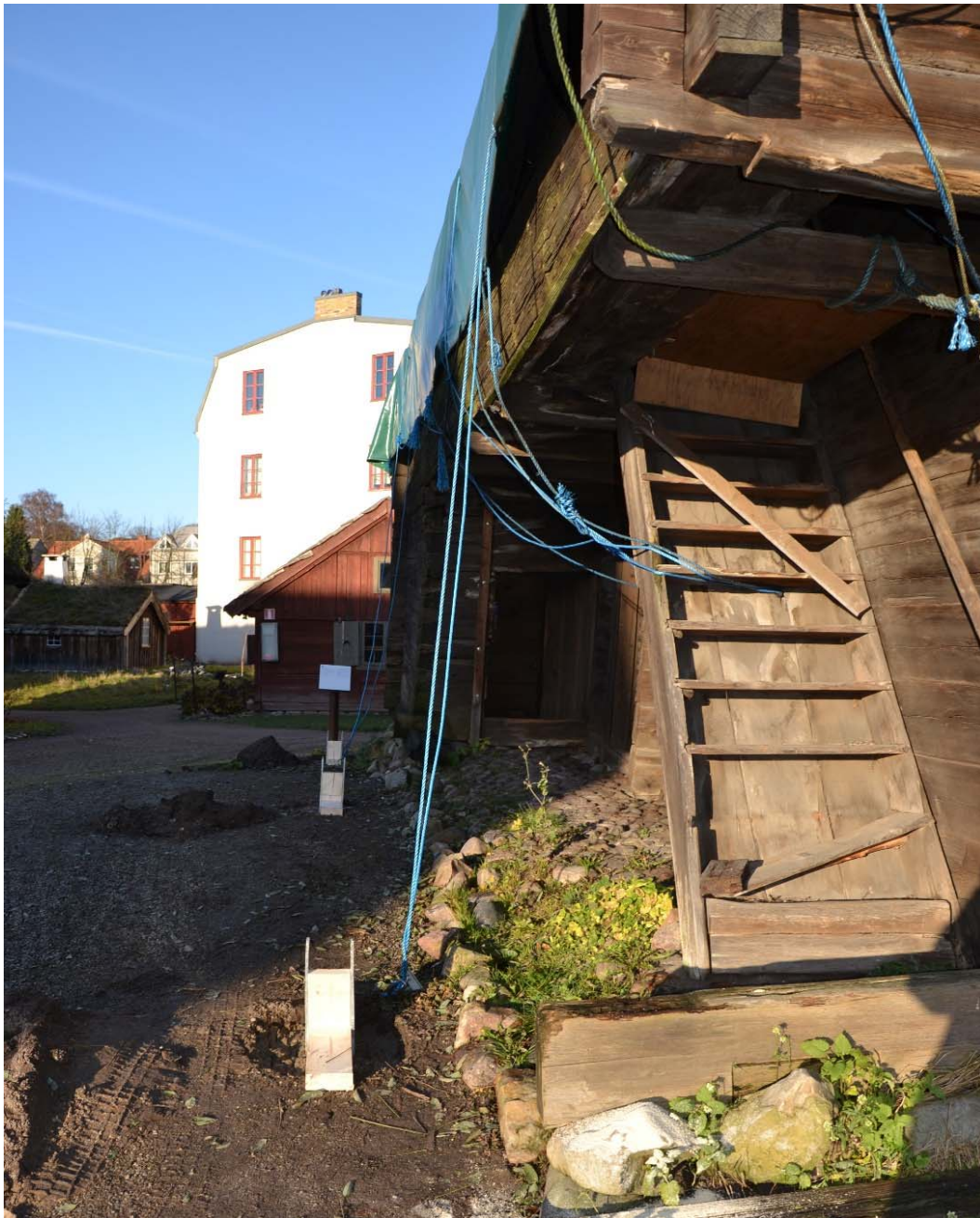
Figur 8. Plintgropar väster om Måketorp för ett provisoriskt tak. Fotografi taget från söder.
