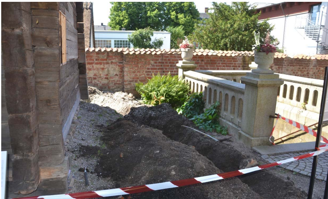
Figur 7. Vattenledningschakt mellan Uranäsboden och brunn öster om Herrehuset. Fotografiet taget från norr.
