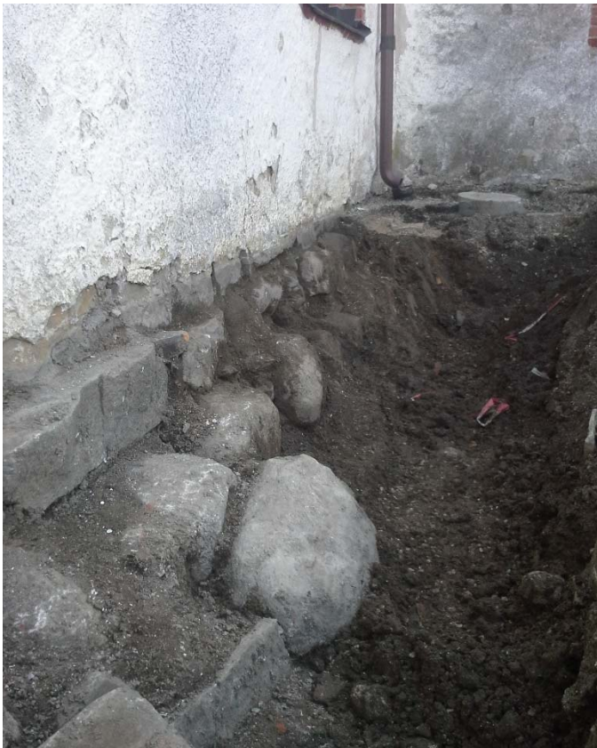
Figur 9. Längst ner i bild syns den högkantade stenkistan intill södra långhusets sida. Märkbart är även att grundmurstenen till vapenhuset klingar av tydligt österut. Fotografiet taget från sydväst.
