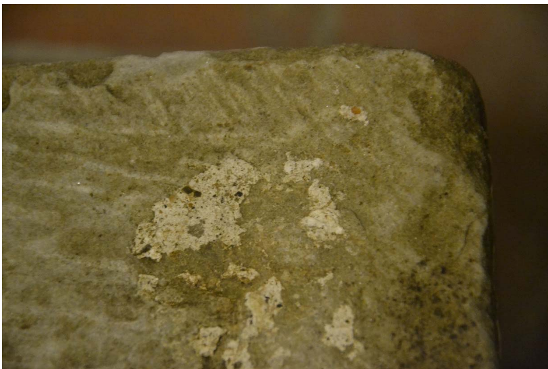
Kvadersten, huggspår av spetsmejsel, kalkbruk som tyder på återanvändning. Längst ut i kanten en svag kant utmejslad.
