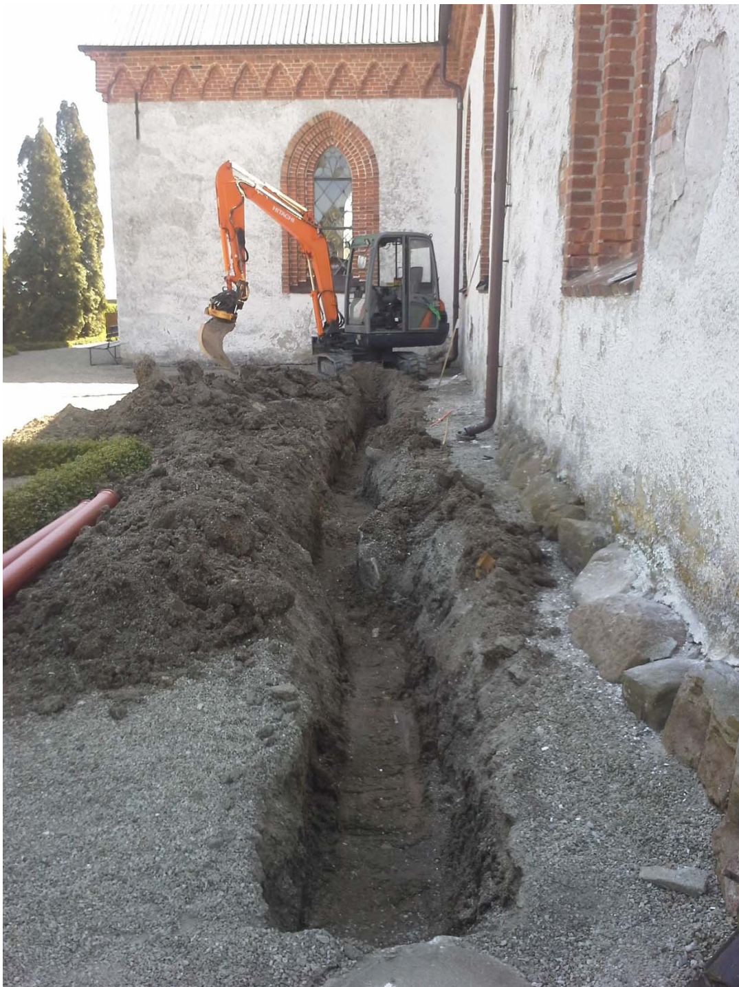
Figur 10. Schaktningsarbeten norr om långhuset. Ungefär från första stupröret och österut fanns det välbevarade medeltida kulturlager, bland annat en mur i norra sektionen och ett marklager av mycket humös karaktär samt ett skalltak som indikerar en grav. Fotografiet taget från väster.
