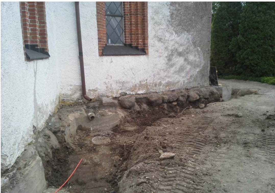
Figur 13. Absiden åt öster. Grundstenarna var uppenbart sämre stabiliserade med torr och poröst grus mellan stenarna. Fotografiet taget från söder.
