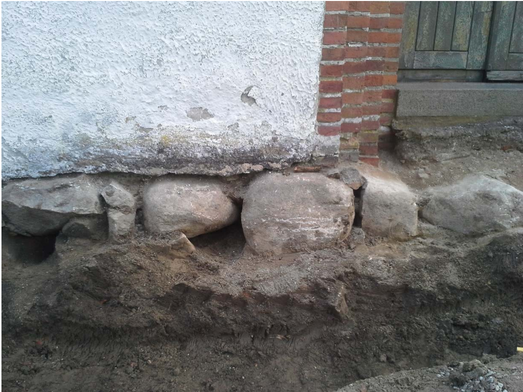
Figur 13. Norra gaveln på norra korsarmen. Grundstenarna var uppenbart sämre stabiliserade längs med korsarmarna samt koret. Endast torr och poröst grus mellan stenarna. Fotografiet taget från norr.
