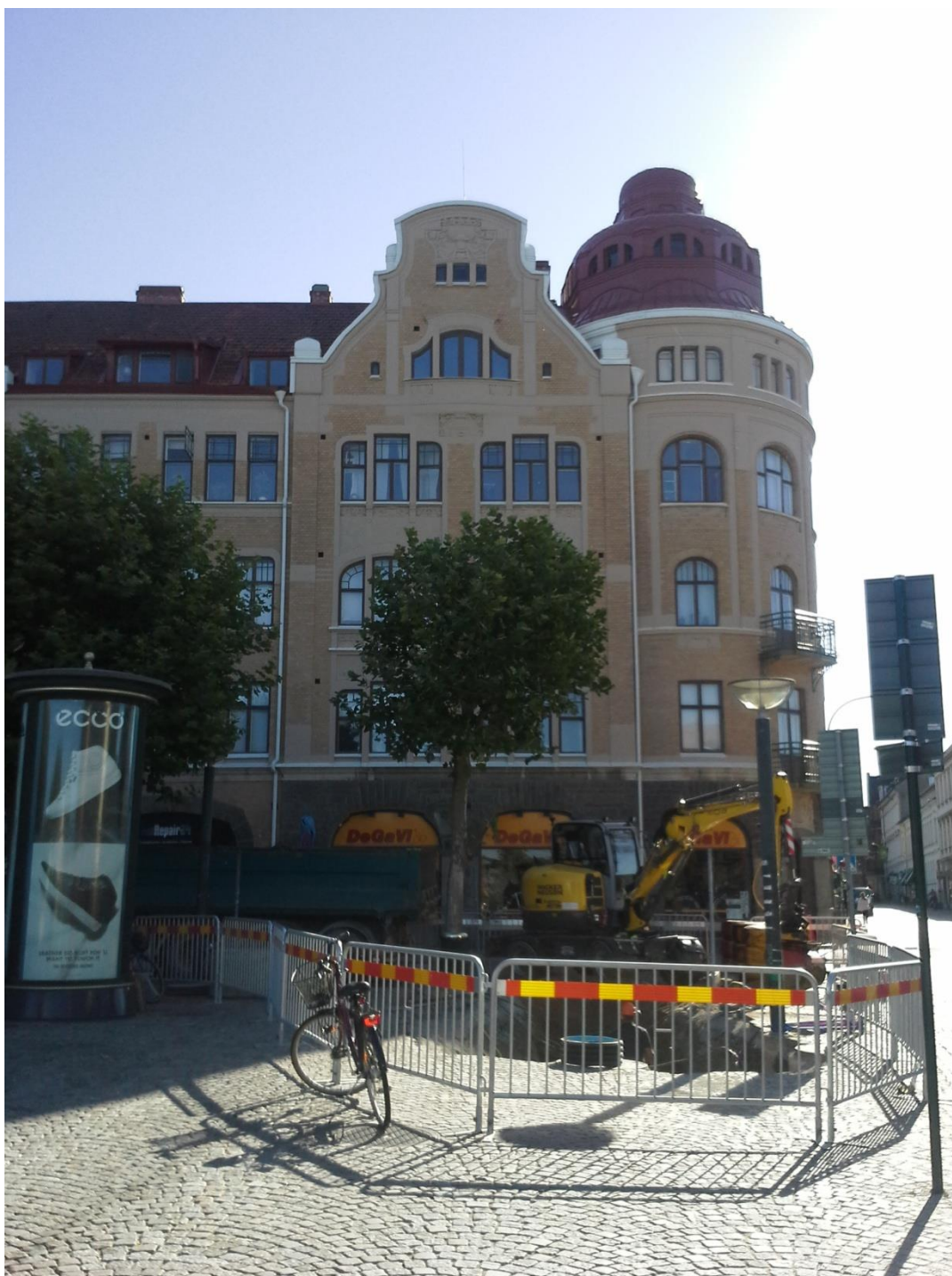
Figur 12. Inledningen på schaktningsarbetena var på Clemenstorgets sydöstra hörn, delområde 1, där ett flertal fjärrvärmerör och andra rör påträffades. Trots detta kunde flera sektioner med bevarade medeltida kulturlager dokumenteras. Fotografiet är taget från väster.
