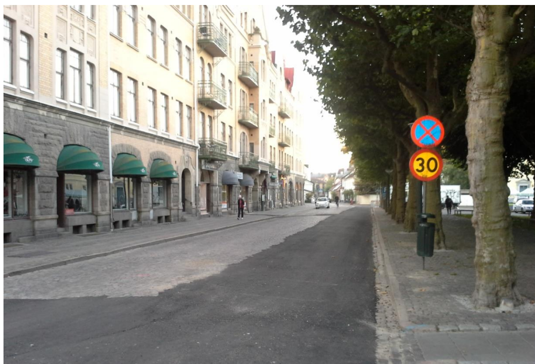
Figur 10. Gatan öster om Clemenstorget där den mörka asfalten visar var fjärrvärmeschaktet var. Fotografiet taget från norr.
