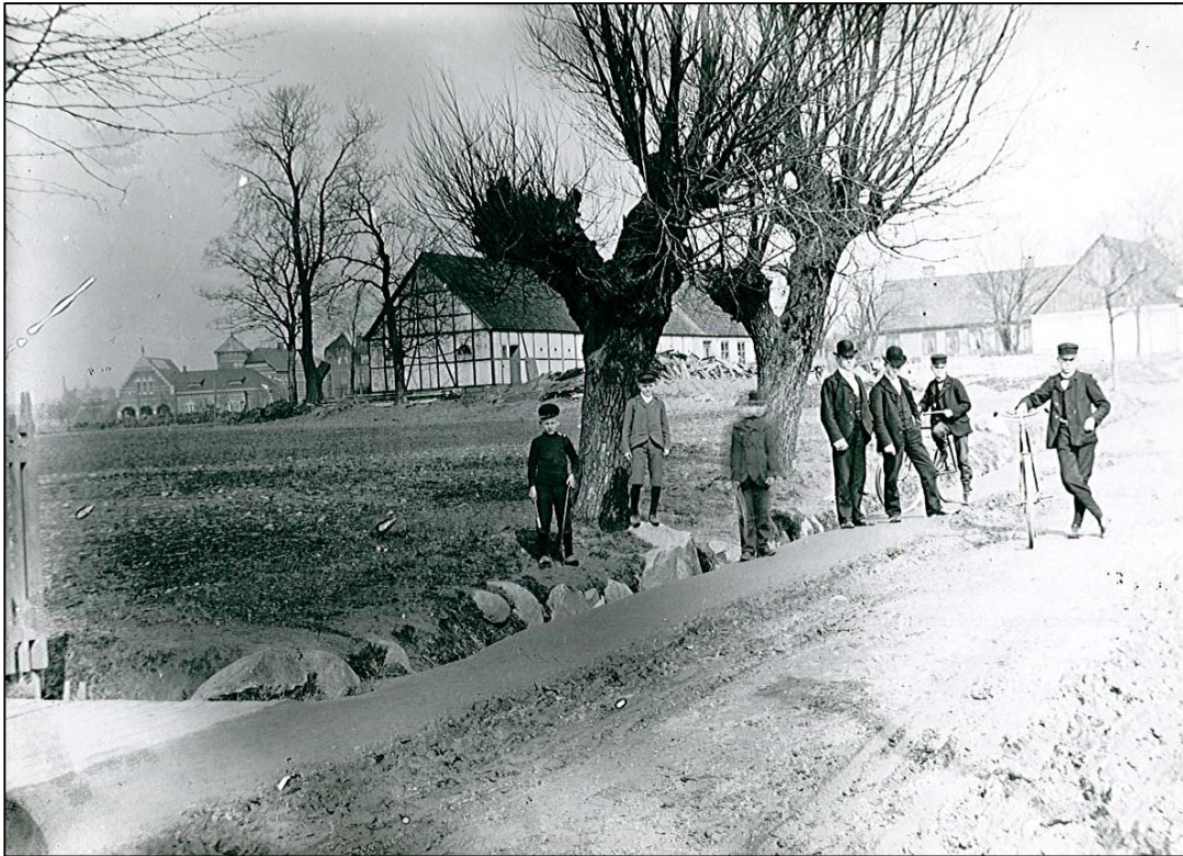
Figur 2. Lilla Råby 9 från Arkivgatan, ca år 1901. Församlingshemmet Ugglan syns i bakgrunden till vänster. Aktuell undersökning utfördes i området sydväst om församlingshemmet. Fotografiet från söder. På fotografiet syns ingen bebyggelse på den plats där de arkeologiska undersökningarna har utförts. Foto i Kulturens arkiv.
