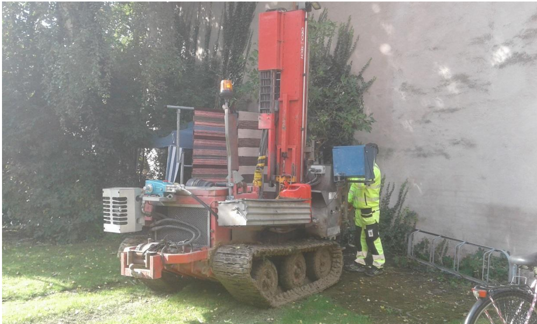
Figur 4. Den geotekniska undersökningen stötte på motstånd på BP3 intill brandväggen i väster. Troligen rör det sig om raseringslager från en tidigare byggnad. Fotografiet taget från norr.
