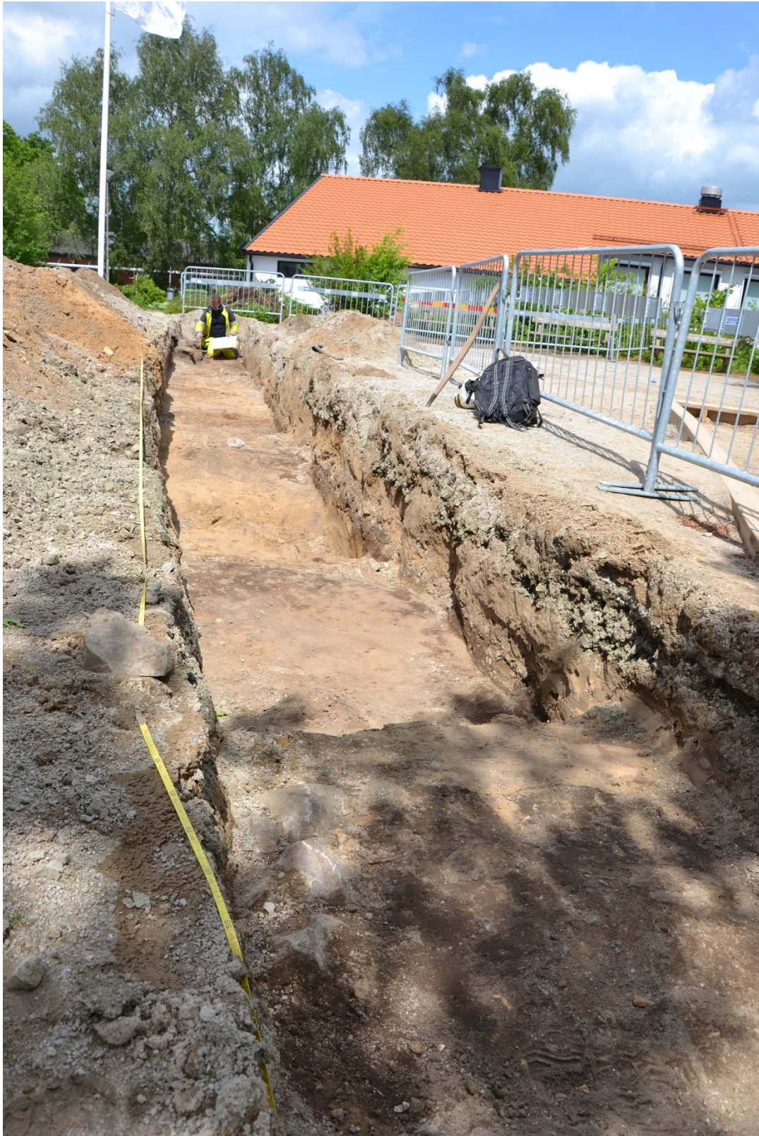
Figur 5. Schakt 2 sett från söder. Johan dokumenterar syllstensgrunden till Gård 22 längst i norr. Närmast i bild skimtar en stensättning från innergården till Gård 22.
