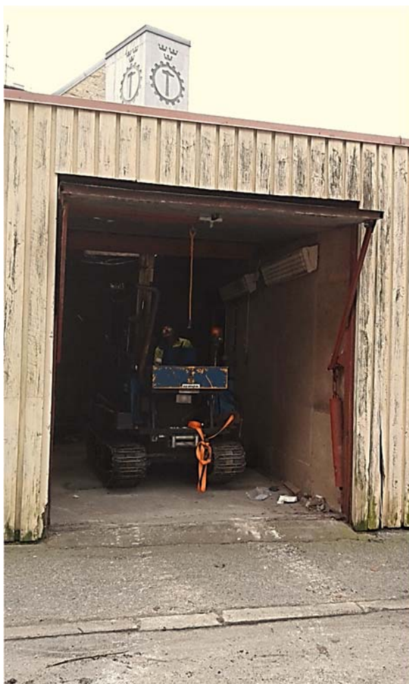
Figur 7. Borrpunkt 3 inne i garaget. Fotografiet taget från norr.
