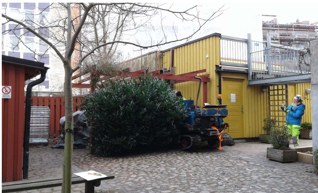
Figur 6. Borrprov 1 bakom lagerhäggen intill garagebyggnadens västra gavel. Fotografiet taget från söder.
